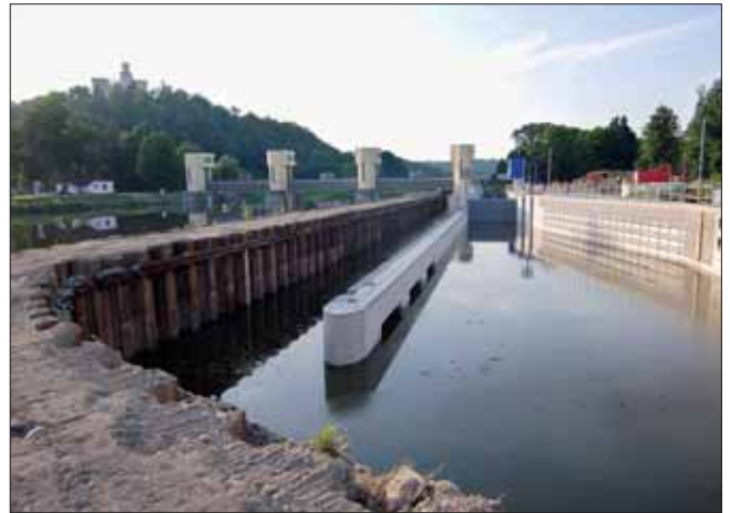
Horní rejsa před demontáží štětové jímky
