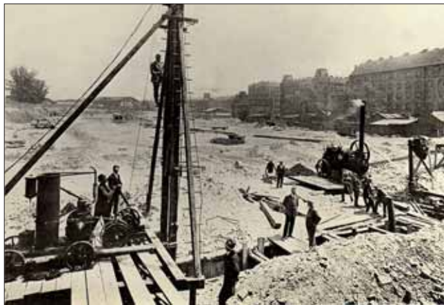
Před zahájením stavby budovy Ředitelství železnic vrtala firma Belada ve 20. letech sondy na Petřském nábřeží v Praze. (Vlevo vltavské nábřeží, vzadu skladiště tehdejšího Denisova nádraží na Těšnově.)
