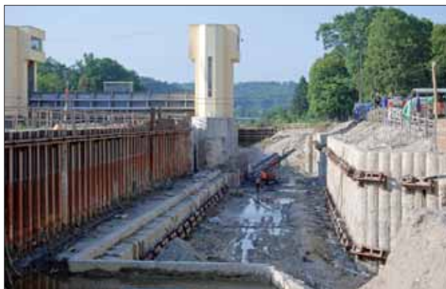
Částečný výkop pro plavební komoru
