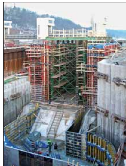
Příprava na betonáž přední části plavební komory do pažení z pilotových stěn
