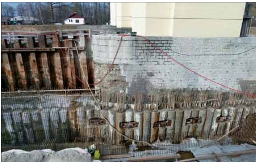
Zajištění stavební jámy u jezového pilíře
