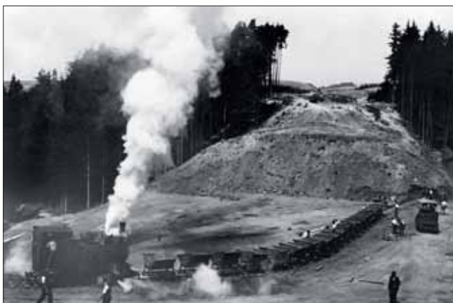
Na jaře roku 1938 budovala brněnská firma Šamánek jihlavskou státní silnici v km 46,25–47,9 u „Vysokého mostu“. (foto Novotný)
