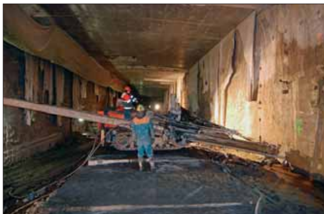
Hloubení vrtů pro vnitřní „zámkové“ sloupce TI
