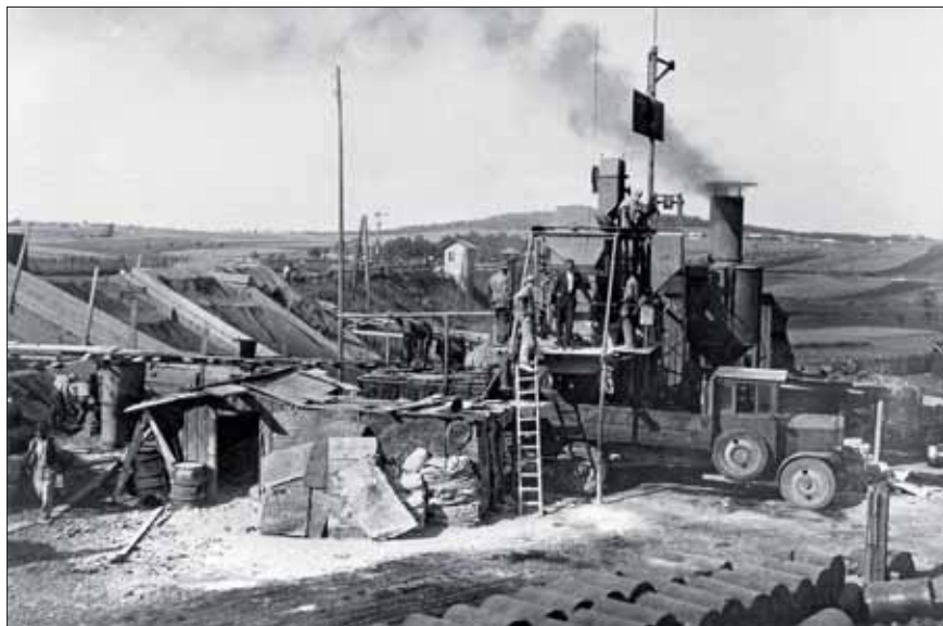
Podnikatelé Nejedlý a Řehák si jako jedni z prvních obstarali vlastní Ammannův mísič živice směsi pro úpravu silnic.
