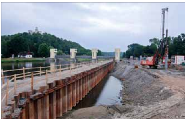
Těsnící dvojitá štětová jímka horní rejdy a plavební komory
