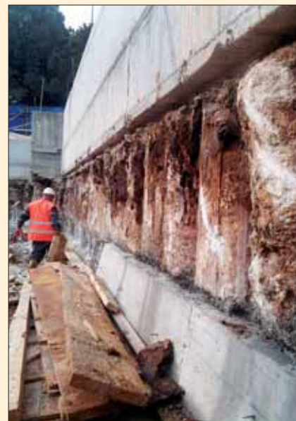
Detail převrtávané pilotové stěny s kotevní převázkou
