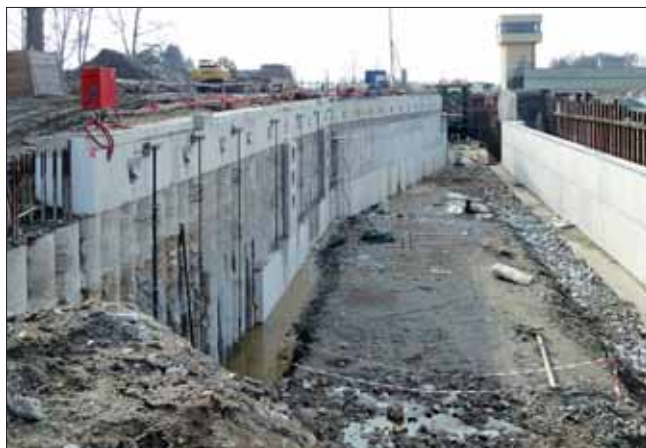
Stavební jáma dolní rejdy a dělicí stěny
