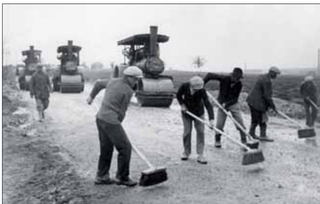
Běžný obrázek na stavbě silnice ve 30. letech, v tomto případě u Českého Brodu; tzv. kalení vozovky s pomocí trojice parních válců Škoda prováděla Konstruktiva.
