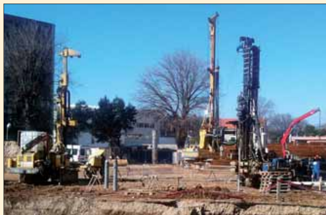
Souběžné provádění injektáže a pilot
