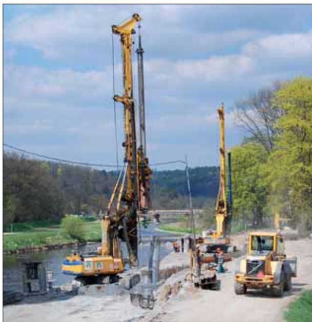
Hloubení vrtů pro piloty dolní rejdy
