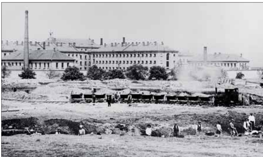
Stavitel Matoušek prováděl na jaře roku 1926 před pankráckou věžnicí se svou jedinou lokomotivkou výkop pro tramvajovou vozovnu.
