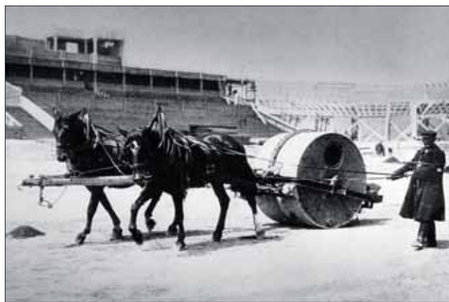
Na stavbě strahovského sletového stadionu se v roce 1926 kromě moderní stavební techniky uplatnili i koně, například při válcování budoucí cvičební plochy.
