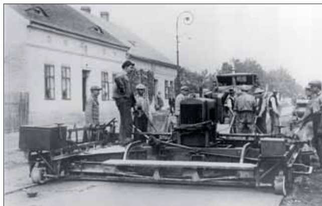
Jeden z prvních finišerů Krauss-Maffei u nás, který si pořídila společnost Konstruktiva ve 30. letech. Při práci v Teplicích k němu dovážel směs parní automobil Škoda-Sentinel.
