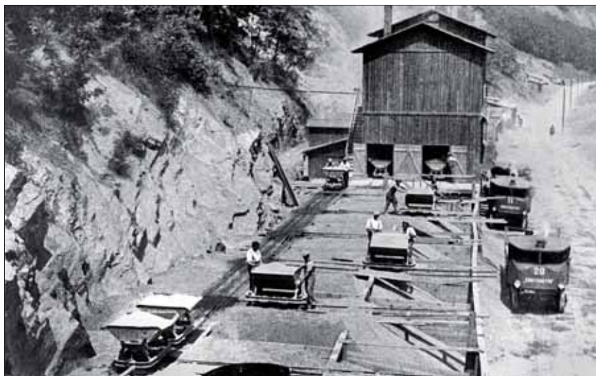
Kamenolom u Zbraslavi dostala do vlnky společnost Konstruktiva hned na začátku 30. let. Odvoz upraveného a roztříděného kamene zajišťovala vlastními parními automobily Škoda-Sentinel.
