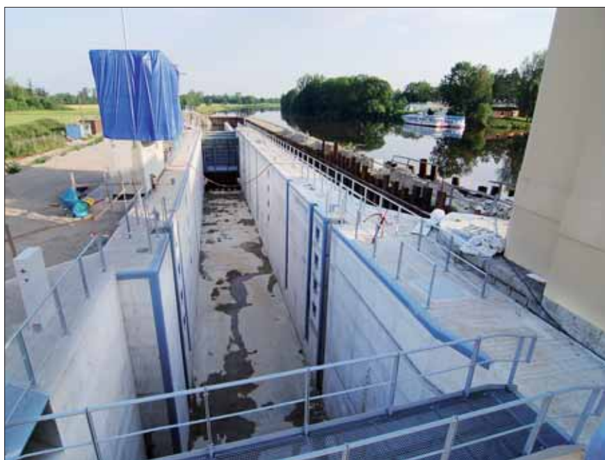
Plavební komora před dokončením
