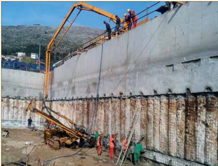
Kotvení převrtávané pilotové stěny
