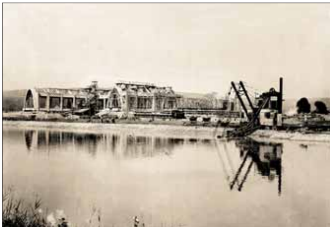
Pro betonování obchodně-průmyslového pavilonu na vznikajícím výstavišti v Brně v roce 1927 bagrovala firma Bratři Redlichové potřebný štěrkopisek hned vedle stavby.
