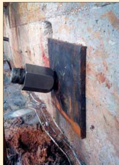
Detail hlavy tyčové kotvy
