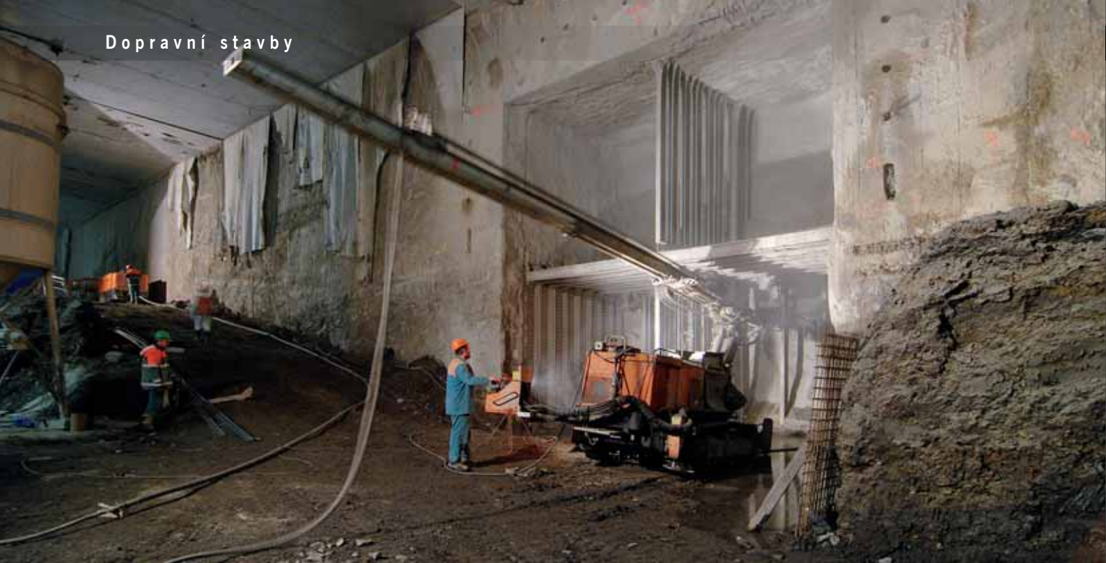
Vrtné práce na čele výrubu ve výklenku severní tunelové trouby (STT)
