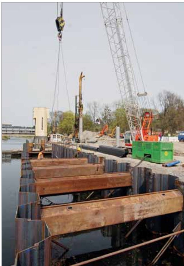
Instalace dvojité štětové jímký
