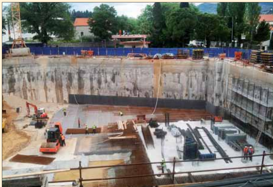
Betonáž základové desky v dokončené stavební jámě
