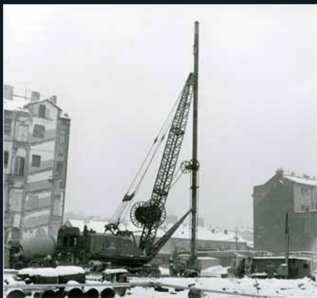
Těžba podzemních stěn Kelly drapákem, zajištění stavební jámy tehdejšího vydavatelství Rudého práva, rok 1984
