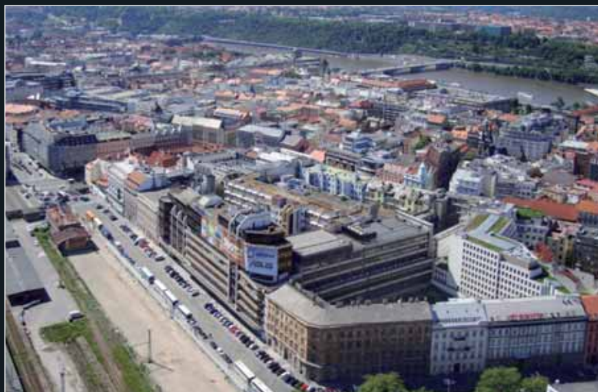
Letecký pohled na původní zástavbu
