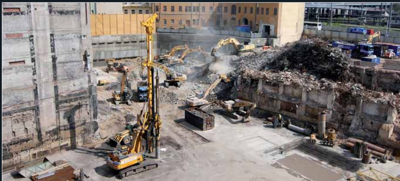
Současné provádění pilotového založení a demolic
