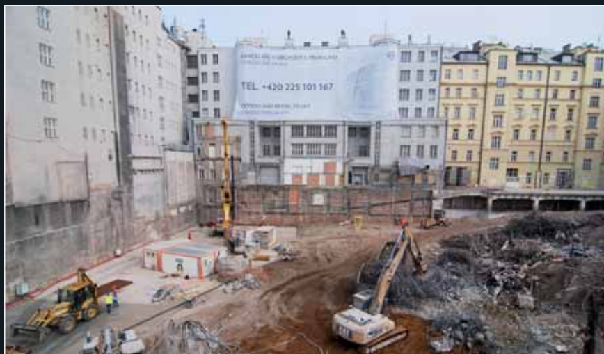
Zahájení pilotážních prací u severní strany stavební jámy
