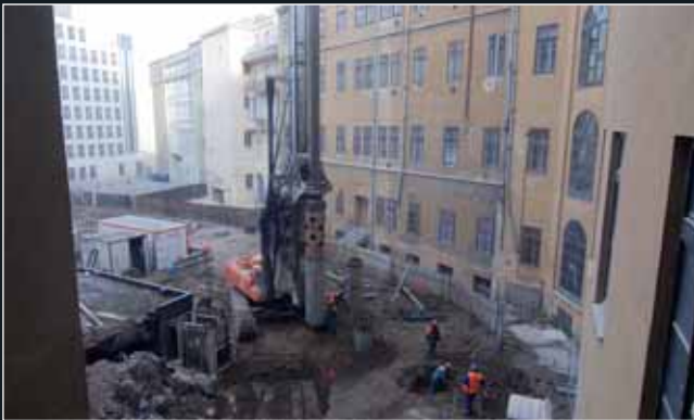
Provádění pilotové stěny v blízkosti paláce Desfours
