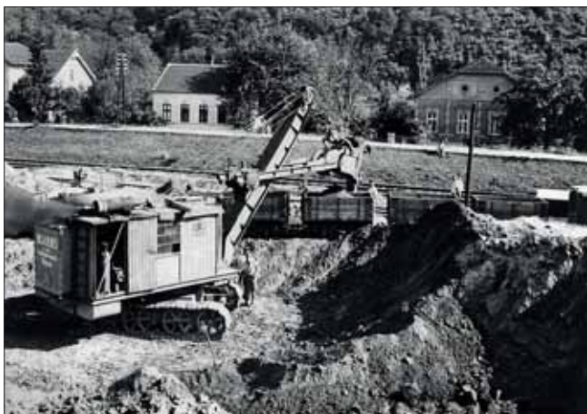
Staveniště nové trati Brno–Tišnov u Maloměřic provádělo podnikatelství Ing. Beneše z Přerova
