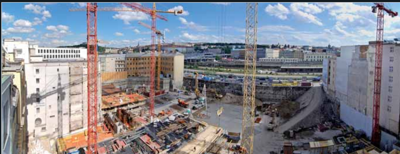
Staveniště s paralelně probíhajícími stavebními činnostmi
