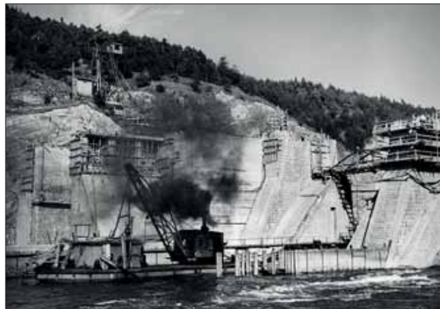
Štěchovická přehrada se bu dovala nejen v roce 1941, ze kdy je obrázek bagru Škoda z majetku firmy Hlava, ale po celou válku.
