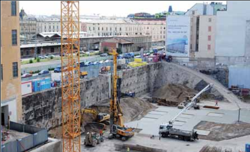
Nově překotvená původní mikrozáporová stěna podél ulice Na Florenci
