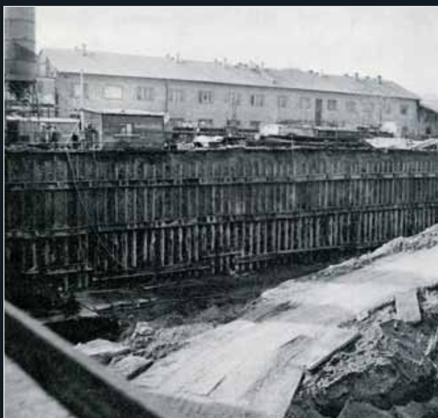
Kotevná mikrozáporová stěna zajišťující stavební jámu podél ulice Na Florenci, rok 1984
