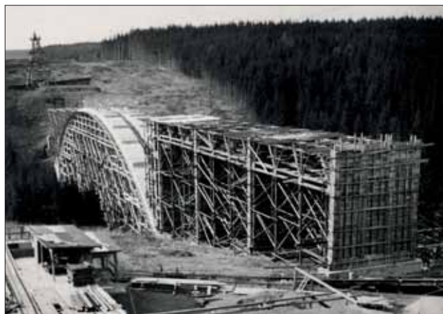
Firma stavitele Domanského budovala na dálnici Praha–Brno most přes údolí Sedlického potoka u Borovska.
