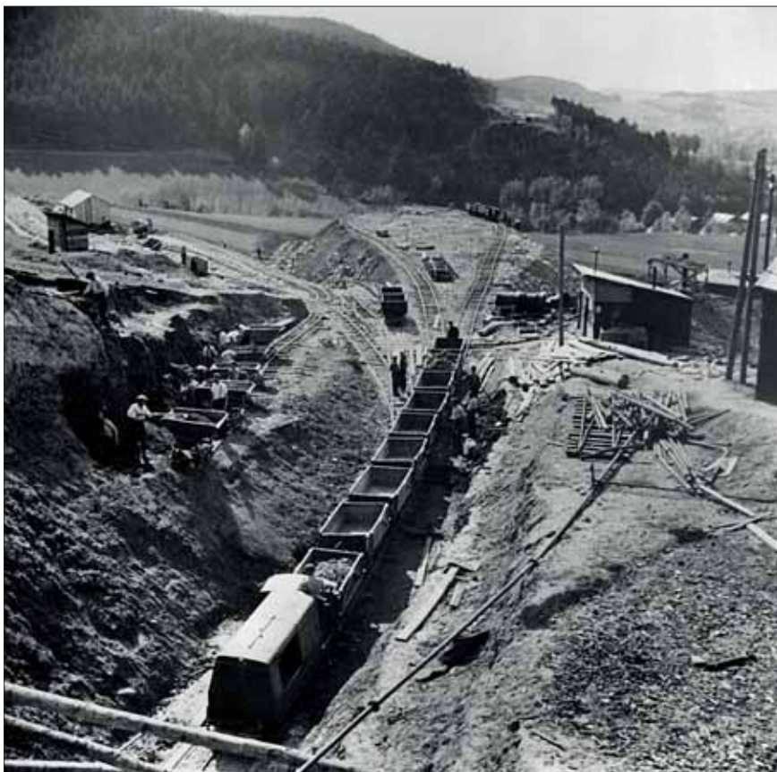
Na dráze Tišnov–Křížanov stavěla firma Kruliš část od Tišnova včetně viaduktu u Dolních Louček. Na počátku 40. let se materiálem z tunelů navážel násep na předmostí tohoto mostu, který zamíří přes údolí k výseku lesa v pozadí obrázku. Tunely se v závěru války staly leteckou továrnou Diana.
