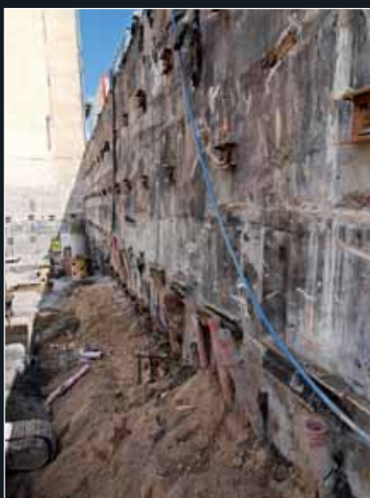
Pata původní MZ stěny podchycená novými MP
