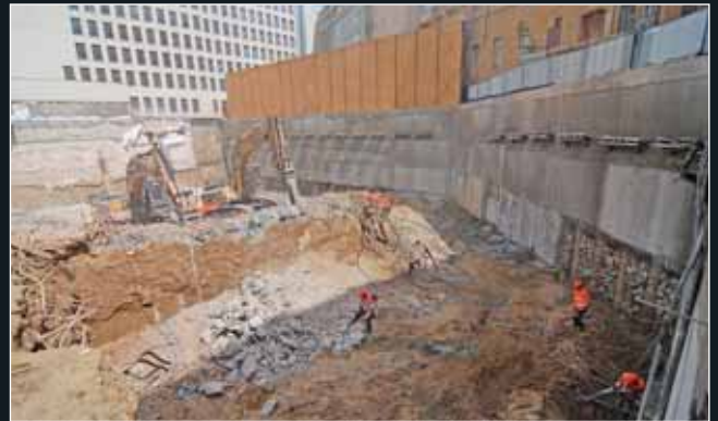
Částečně odkopaná kotvená pilotová stěna s osazovanou protihlukovou stěnou
