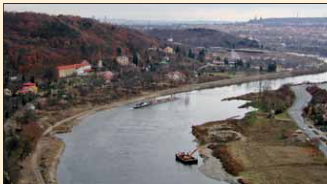
Objekt bývalých Kafkových octáren je nepřehlédnutelnou dominantou pravého břehu Vltavy, kde řeka opouští Prahu.
