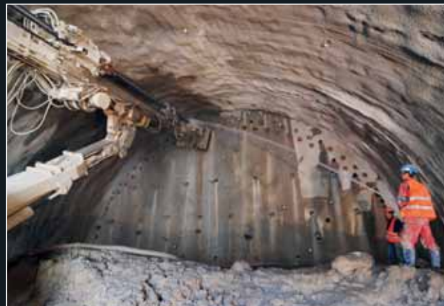
Vrtání ochranné obálky TI z prostoru tunelu pro zajištění 3. etapy ražby
