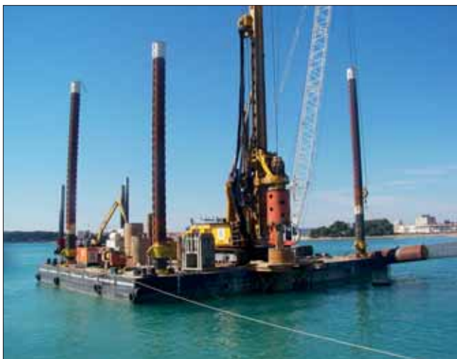
Ponton MPS s vrtnou soupravou Bauer BG 36H
