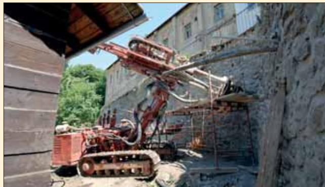
Hloubení vrtů pro kotvy žlb. žeber ve 2. fázi opravy
