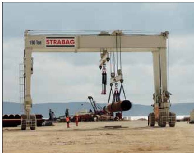
Portálový jeřáb při nakládání výpažnice
