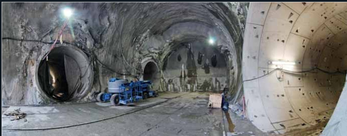
Vyražený spojovací tunel s viditelným zaústěním traťových tunelů po průjezdu obou razičích štítů Tonda a Adéla
