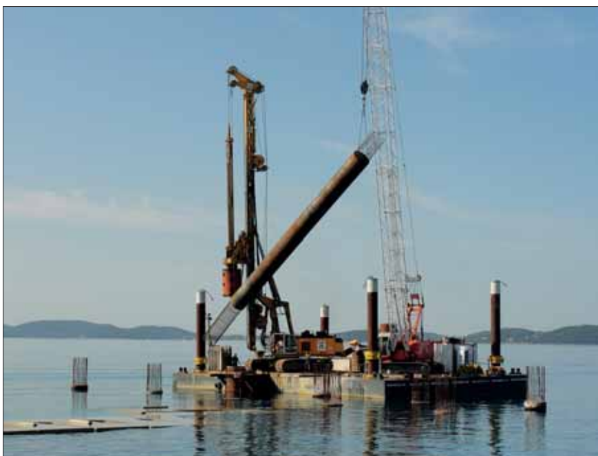
Spolupráce vrtné soupravy a jeřábu při osazování výpažnice s armokošem
