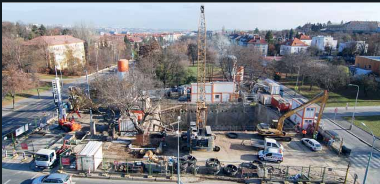
Staveniště „Kanadská“ mezi ulicemi Evropská a Velvarská, pohled směrem k Vítěznému náměstí
