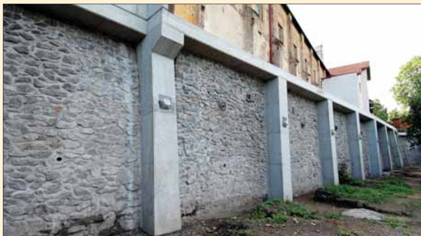
Opěrná zeď po dokončení oprav
