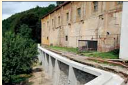
Provádějí nové žlbočky římsy nad sanovanou zdí
