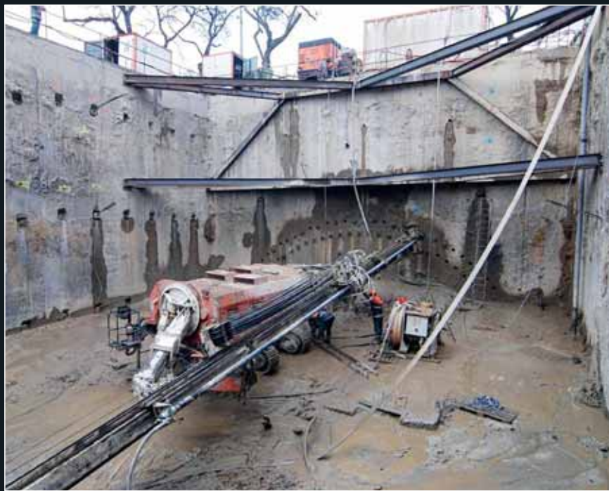
Vrtná souprava Casagrande PG 115 s prodlouženou lafetou při realizaci ochranné obálky ze sloupů tryskové injektáže z prostoru stavební jámy přes portálovou podzemní stěnu
