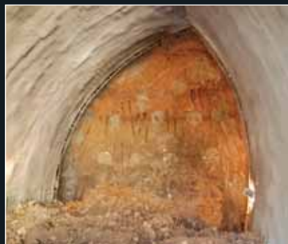
Detailní pohled na čelbu v levé části kaloty stabilizovanou pomocí „zámkových“ vrtů TI a laminátových kotev
