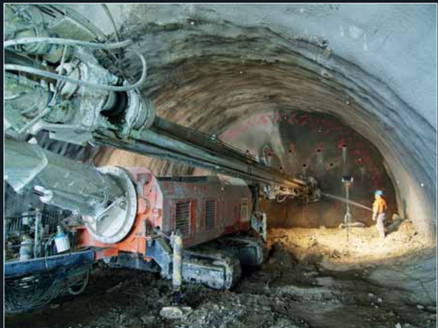
Zajišťování čelby pomocí „zámkových“ sloupě TI a laminátových kotev
