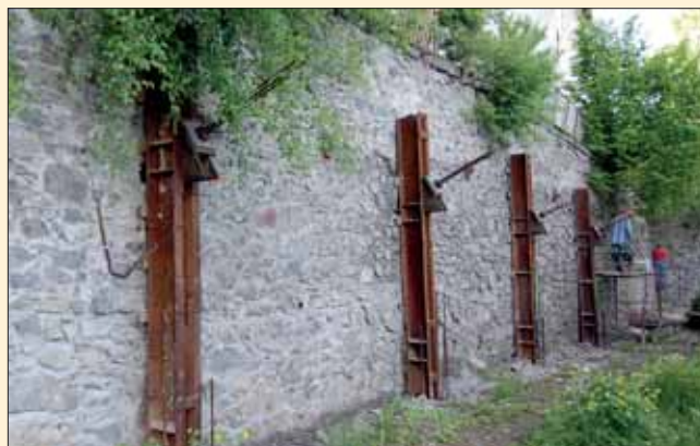
Provizorní zajištění opěrné zdi kotvenými převázkami
