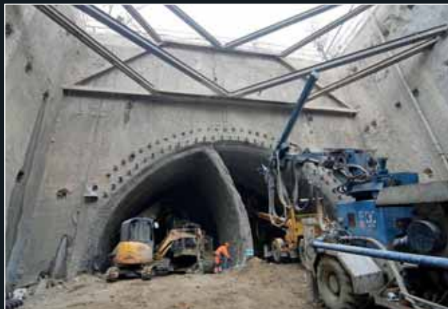
Pohled na dokončenou I. etapu ražby s horizontálně členěnou kalotou
