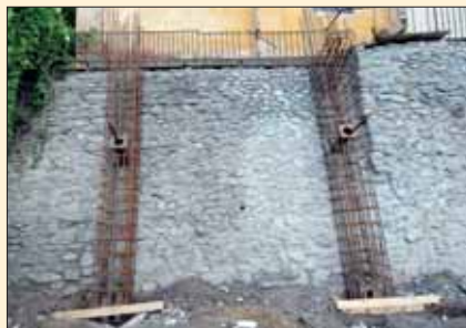
Žebra před betonáží, 2. etapa
