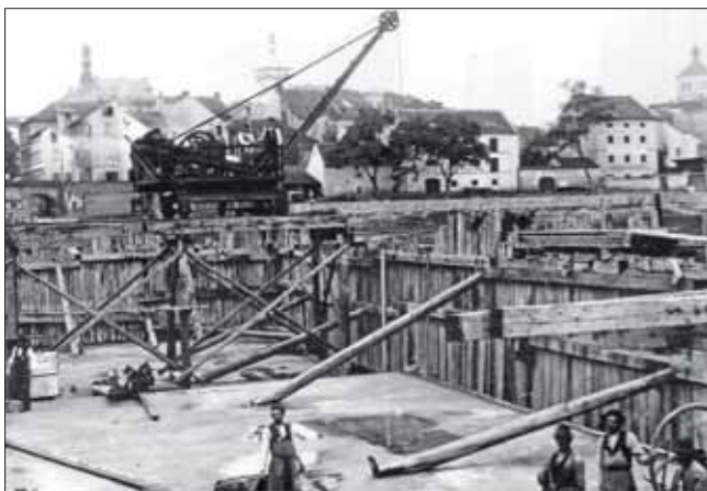
Jímka III. etapy s vybetonovaným podjezím, v pozadí město Roudnice n. L.
