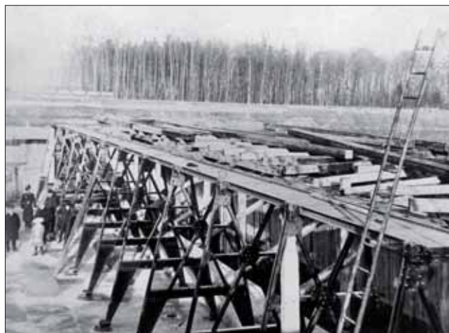
Montáž ocelové konstrukce slupic v jímce IV. etapy
