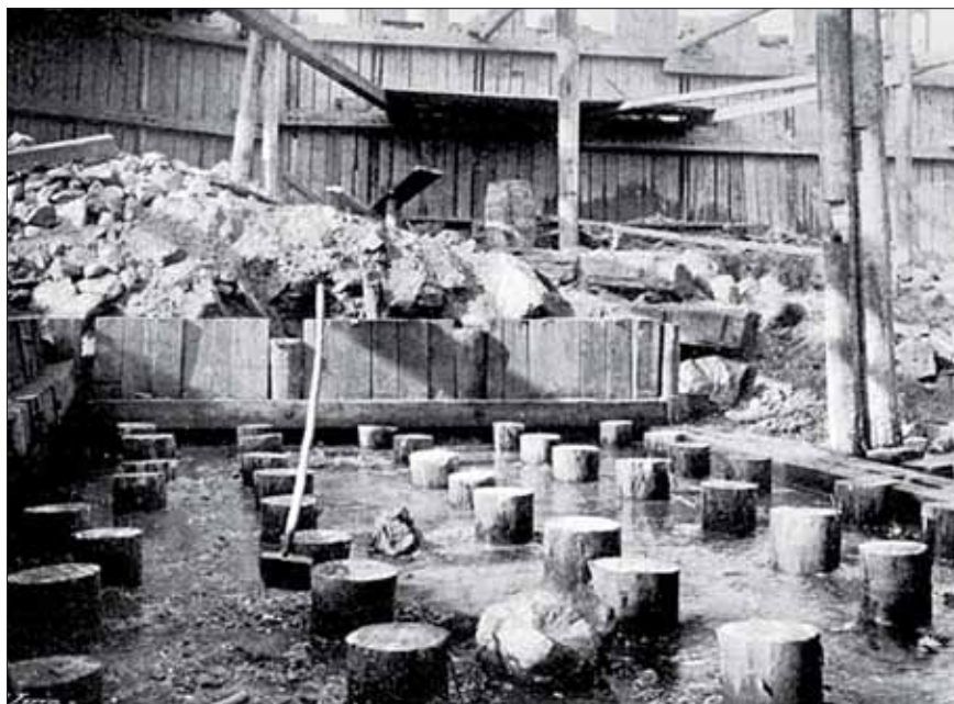
Pohled na pilotové založení mostního pilíře č. 4
