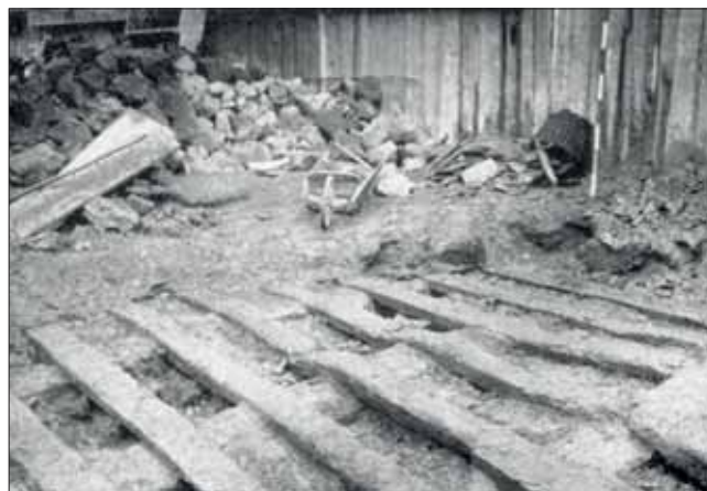
Roudnice nad Labem, gotický most. Dokumentace zbytků mostu nalezených v roce 1906, základový trámový rošt s příčnými trámy nalezený v jímce. Převzato z B. Tolman – V. Chaloupecký, Starý kamenný most přes Labe v Roudnici, Praha, 1909.
