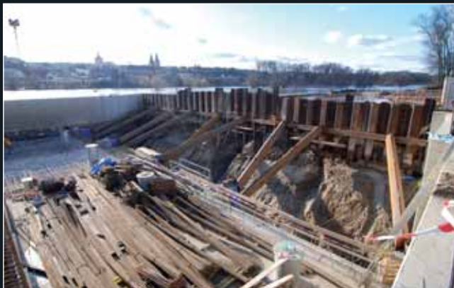
Štětové stěny na výtoku jsou přerozpřeny do konstrukce elektrárny, stabilizační lavice je postupně odtěžována
