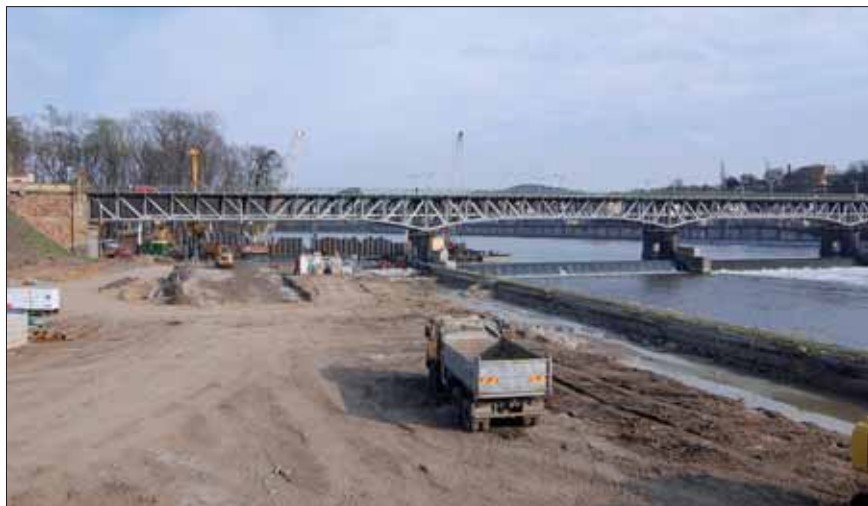
Staveniště po zahájení prací na zapažení stavební jámy
