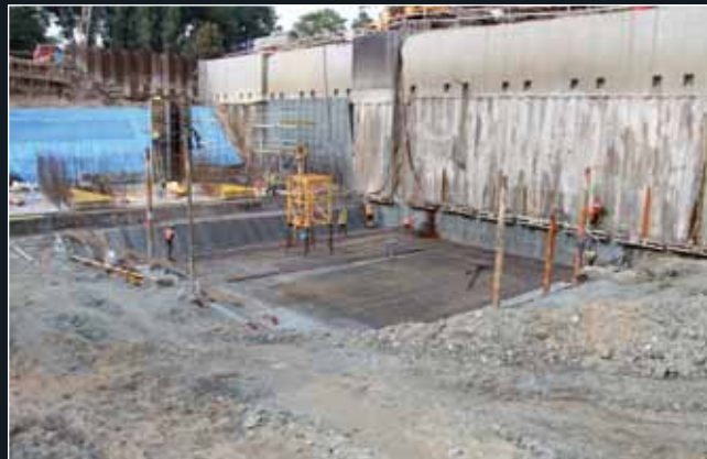
Armování základové desky stavební jámy v nejnižším místě v oblasti budoucí strojovny
