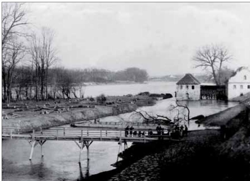
Mlýnský náhon v Roudnici nad Labem, příprava na stavební práce, rok 1906
