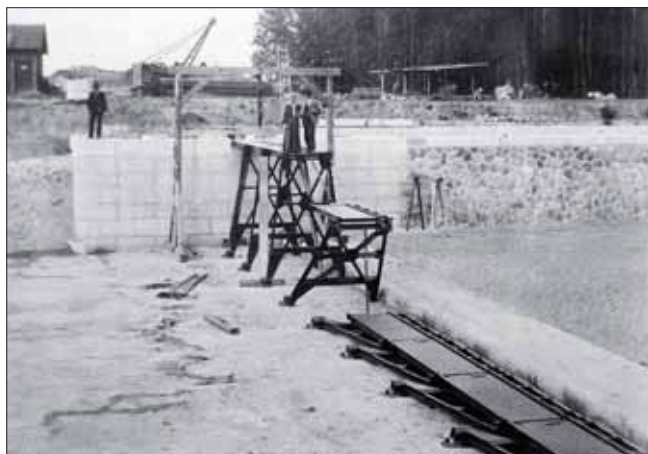
Pohled na 3. jezové pole a nedokončený pravobřežní jezový pilíř (mostní pilíř č. 7) s částečně sklopenými slupicemi za zvýšeným prahem
