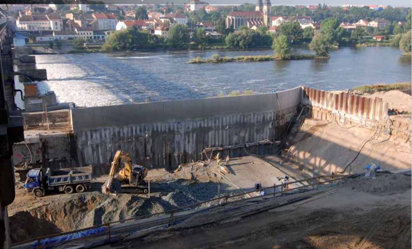
Stavební jáma během dokončování těžby na základovou spáru
