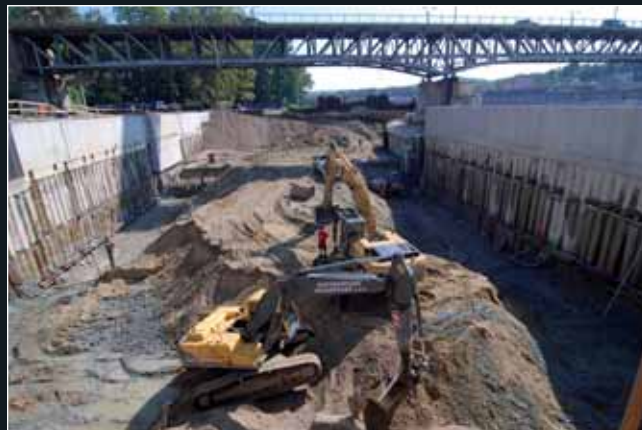
Zemní práce ve stavební jámě před dokončením poslední kotvené úrovně
