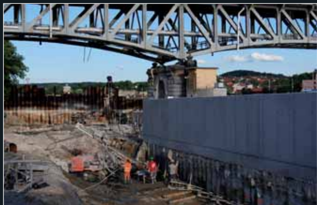
Kotvení návodní strany stěny stavební jámy na 2. kotvené úrovni
