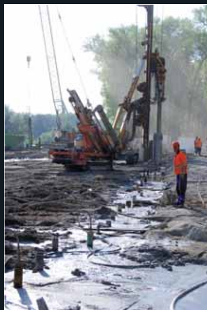
Provádění obvodové těsnící clony
