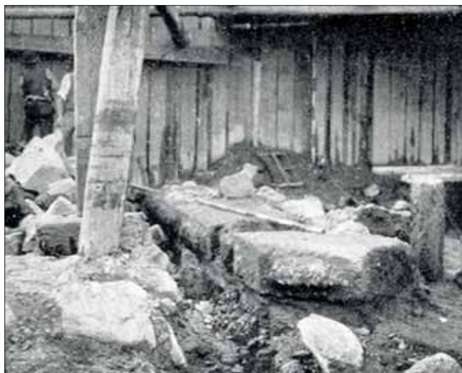
Roudnice nad Labem, gotický most. Dokumentace zbytků mostu nalezených v roce 1906, bosované kvádry pilíře nalezené v jímcě. Převzato z B. Tolman – V. Chaloupecký, Starý kamenný most přes Labe v Roudnici, Praha, 1909.
