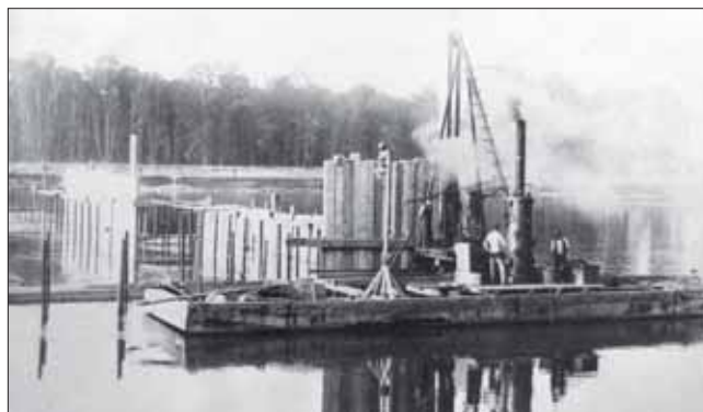
Beranění dvojité jímky II. etapy parním beranidlem z lodě, na obrázku jsou zřetelně vidět vodící piloty a dřevěné kleštiny, do kterých jsou osazovány a postupně beraněny dřevěné štětovnice jímky.
