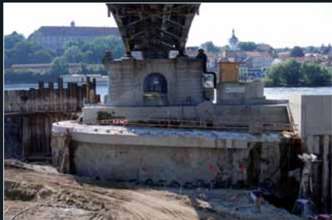
Podchycení mostního a jezového pilíře zemním blokem zpěvněným pomocí tryskové injektáže, výkop pro kotvení
