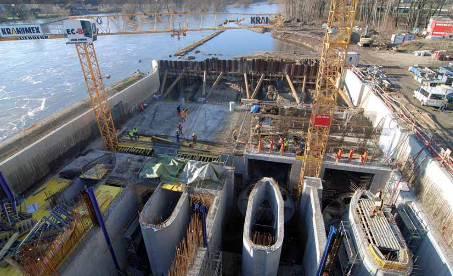
Výstavba elektrárny ve stavební jámě před osazením technologie
