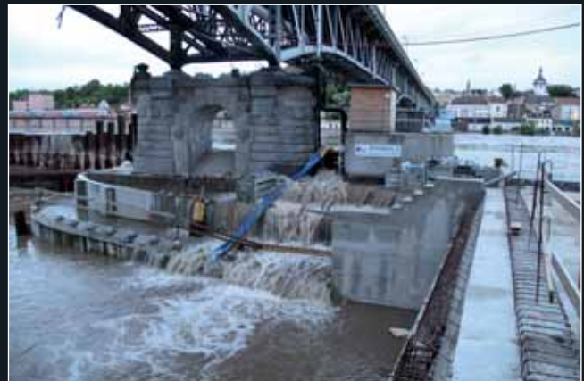
Řízené zaplavování stavební jámy při povodni přes jezový pilíř
