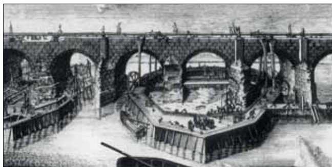
Detail z vyobrazení opravy Karlova mostu po povodni v roce 1784 velmi věrně zachycující dobové řešení jímek a strojů pro beranění štětovic, čerpání vody a dopravu materiálu (K. Saltzer, Oprava Karlova mostu po povodni 1784, mědiryt ). Převzato z O. Ševců ed., Karlův most, Praha, 2007 , s. 289.
