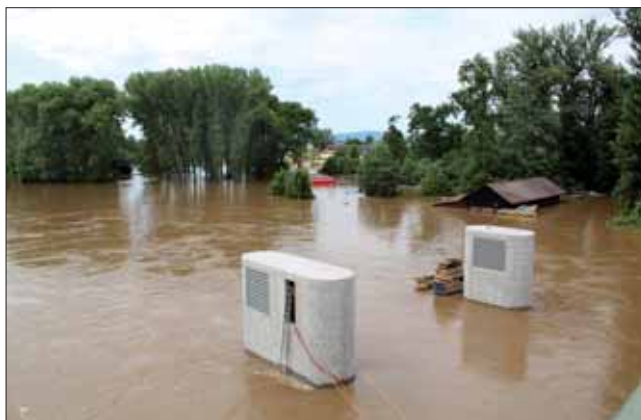
Kulminace povodně na Q_{50} po řízeném zaplavení stavební jámy s elektrárnou
