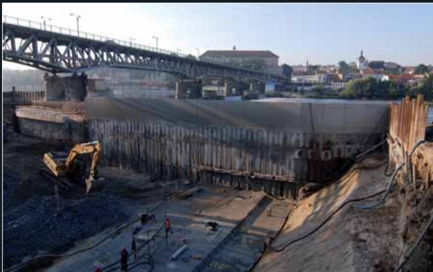
Zapažená stavební jáma s ponechanou stabilizační zemní lavicí na výtoku
