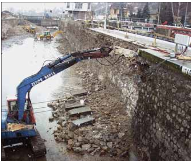
Bourací práce na stěnách komory
