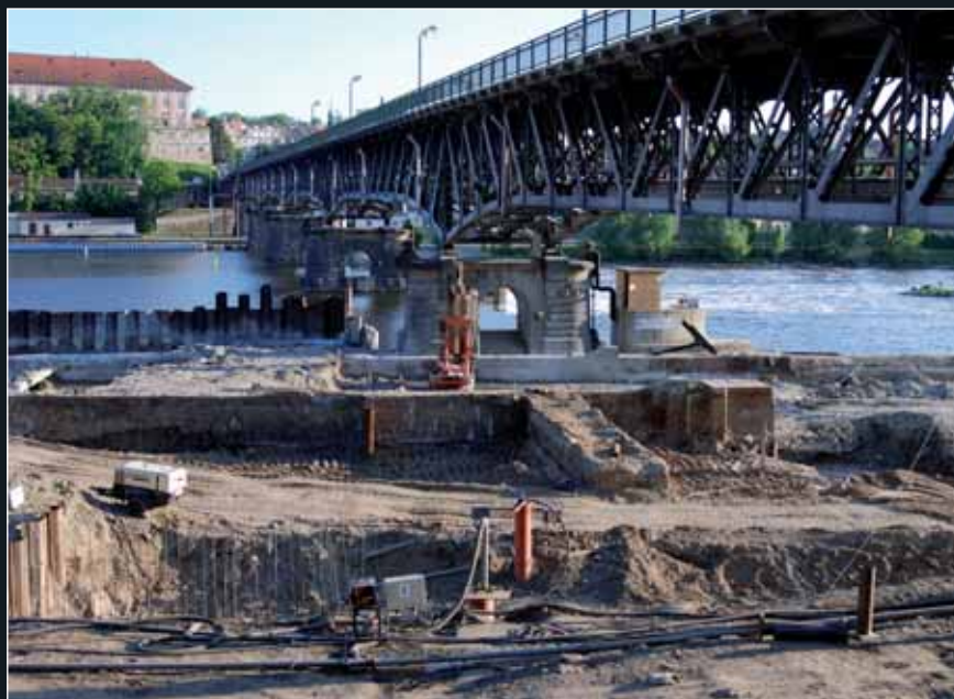
V oblasti pod mostem bylo pažení jámy provedeno mohutným kotveným blokem ze sloupů tryskové injektáže
