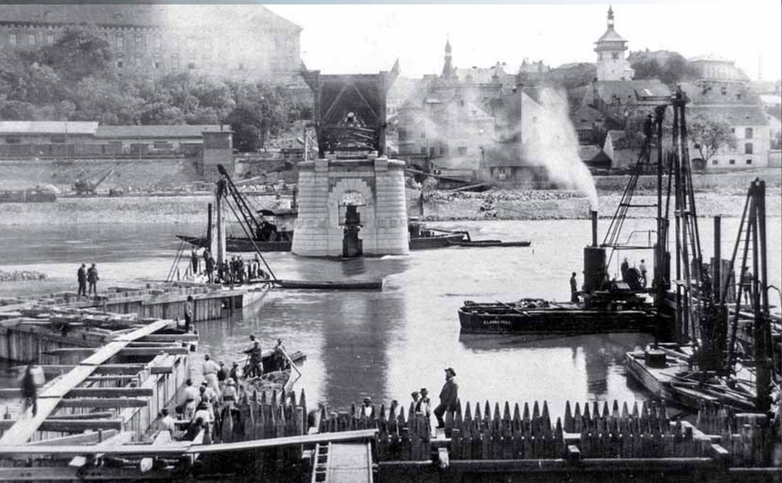
Beranění jímky IV. etapy, v pozadí dokončený mostní pilíř č. 5 s již nasunutou mostní konstrukcí nad levým jezovým polem, plavba je již převedena do levého jezového pole
