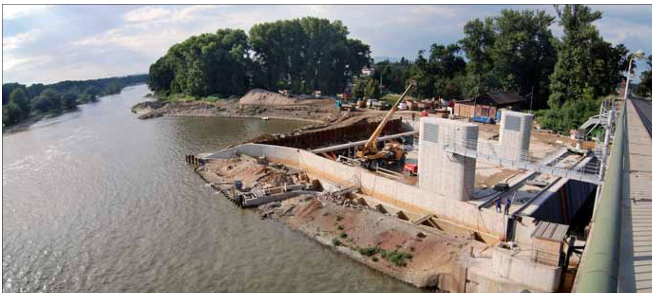
Elektrárna po dokončení stropních konstrukcí
