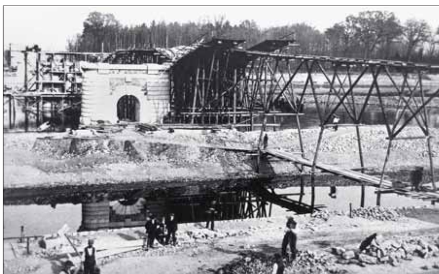
Pohled na dokončený mostní pilíř č. 4 s předsunutým lešením, na kterém byla smontována krakorcová mostní konstrukce nad levobřežním jezovým polem a po dokončení zasunuta nad pilíře, v popředí dláždění břehů plavebního kanálu.
