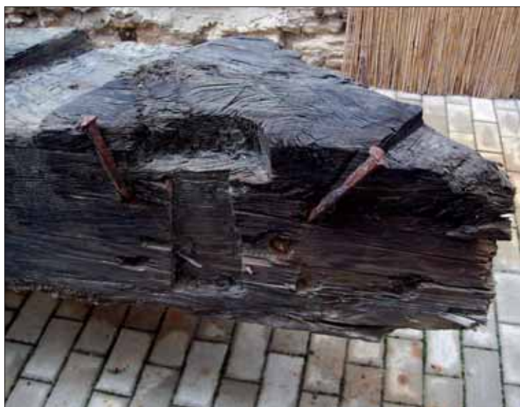
Jeden z trámů základového roštu gotického mostu objevených v roce 2004, pohled z vnější strany na sešikmené zhlaví, které bylo původně lípnuto k osovému trámu. Je vidět jeden oboustranně rybinovitý zapuštěný dlab na boční straně, jednoduchý dlab na horní straně a ohnuté hřeby, kterými byl trám přibit k osovému, Podřípské muzeum v Roudnici nad Labem (Foto M. Panáček 2006).
