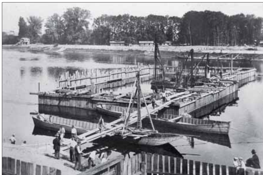
Práce na dokončení jímky II. etapy pro levobřežní jezové pole a mostní pilíř č. 4, zásyp návodních dvojíých štětových stěn těsnícím materiálem
