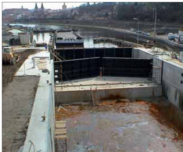
Dokončené horní ohlavi a vzpěrná vrata
