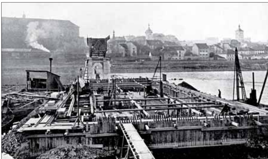
Dokončená jímka IV. etapy s betony podjezí, v jímce je vidět zdění mostního pilíře č. 6 z kamenných kvádrů, které jsou dopravovány po jímce
