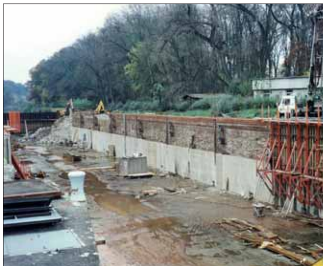
Stěny velké plavební komory při betonáži s osazeným vystrojením
