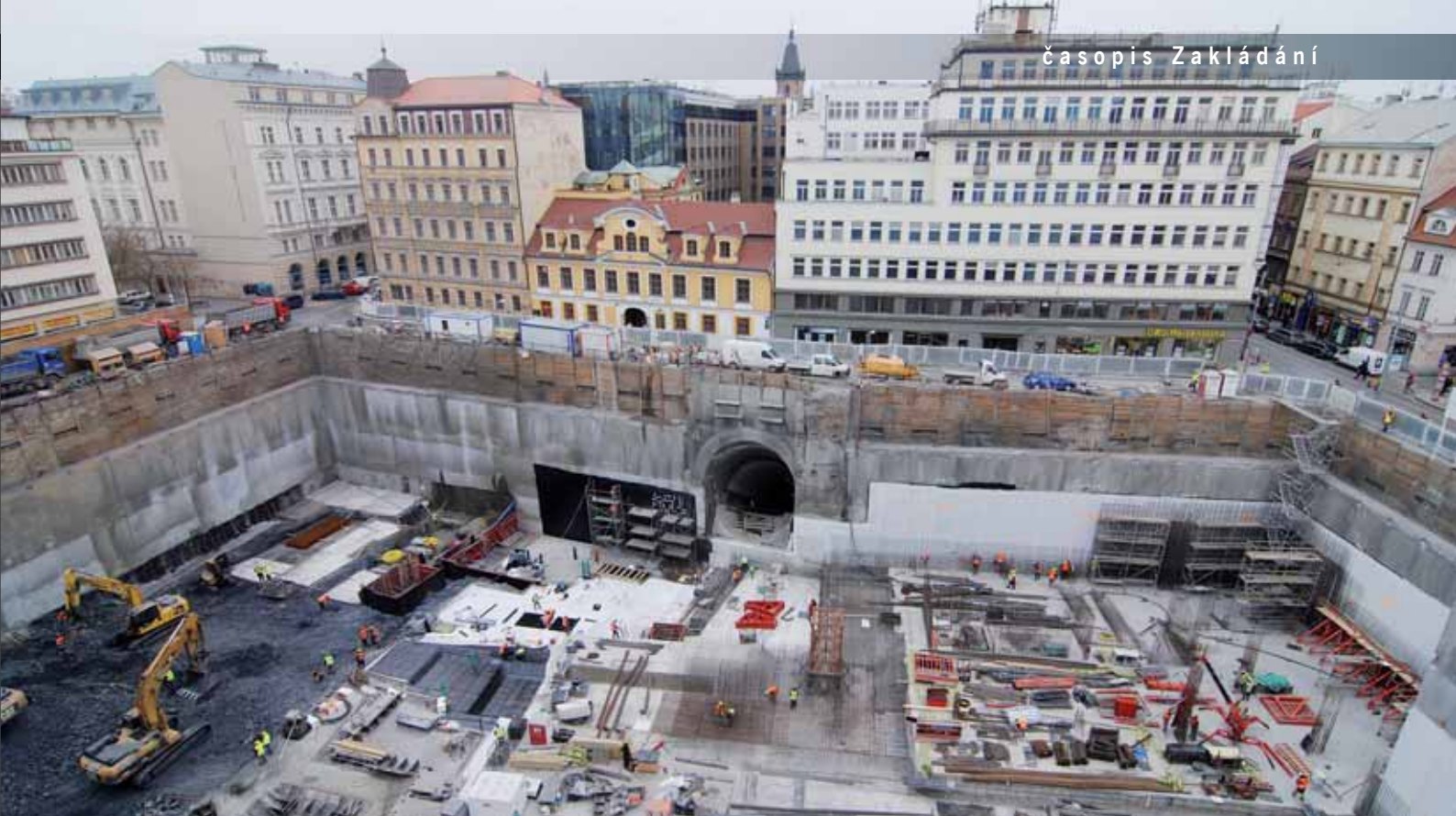
Pohled do stavební jámy před dotěžením na základovou spáru
