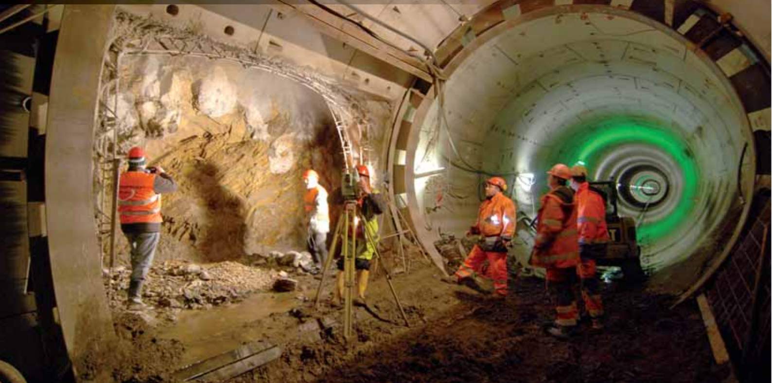
Zahájení ražby propojky 2.5 z levého traťového tunelu po odstranění ostění
