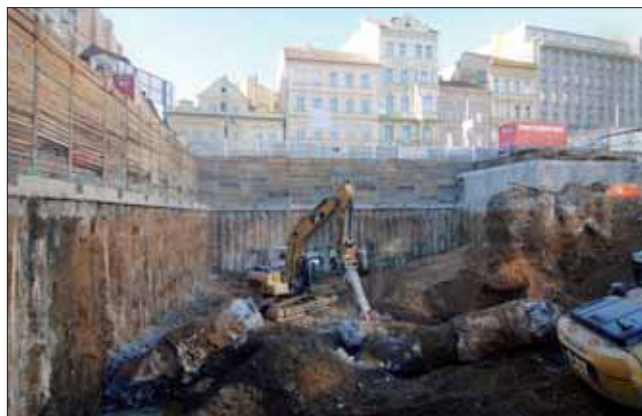
Bourací práce původních základových konstrukcí vestibulu metra
