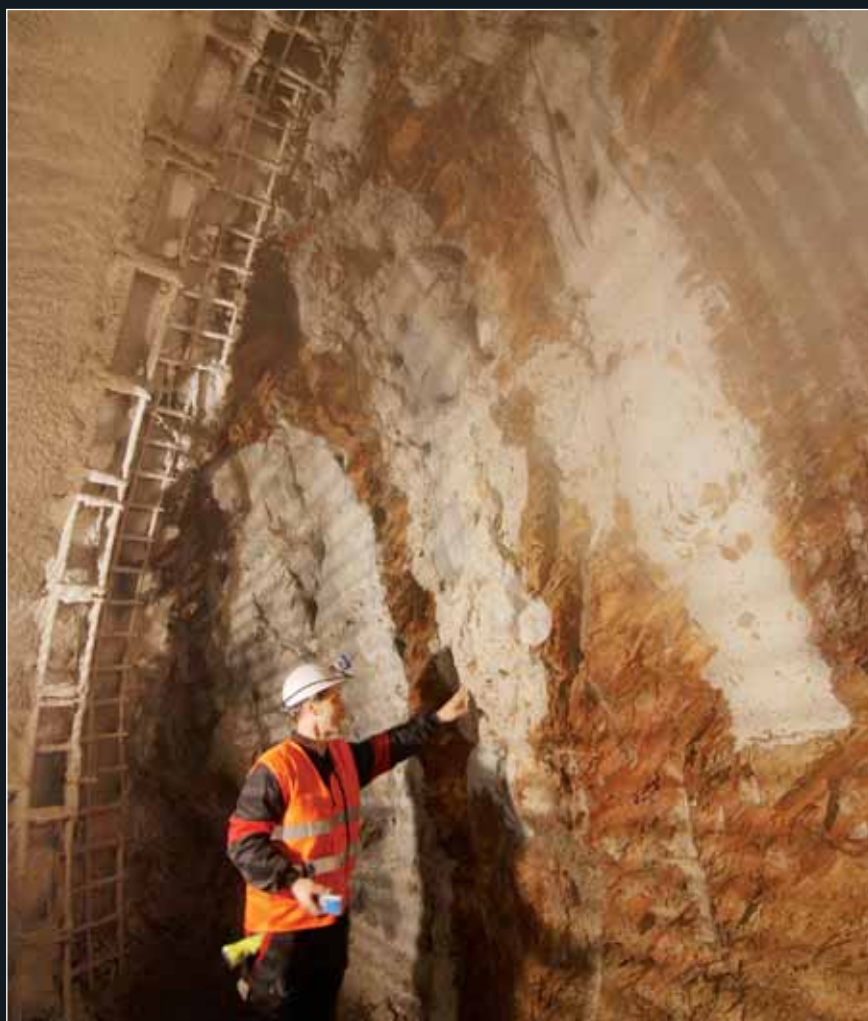
Pohled na čelbu se zámkovými sloupy tryskové injektáže, zajišťujícími její stabilitu
