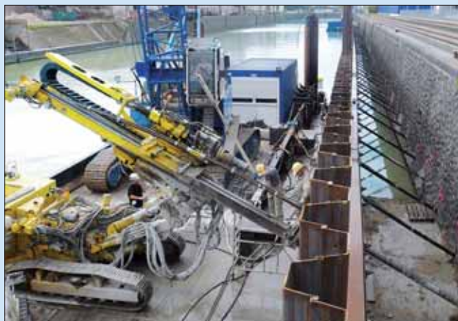
Obr. 6: Nový systém vrtaných injektovaných mikropilot TK-ASF firmy ThyssenKrupp Bautechnik
