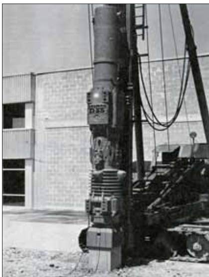
Obr. 4: Dlouhodobě nejpoužívanější typ těžkého dieslberanu – Delmag D55 (foto z knihy Haal op die Hei)
