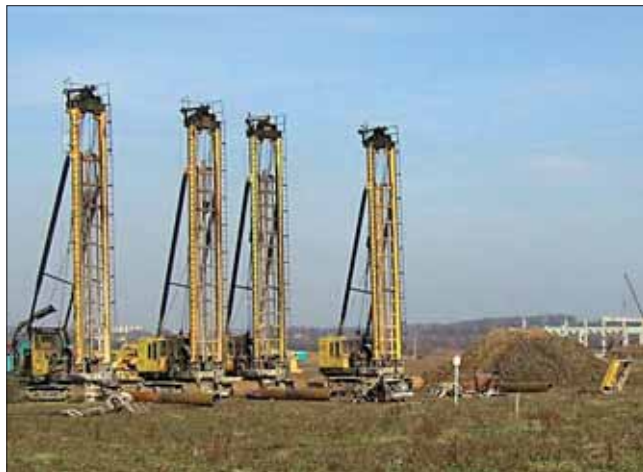
Obr. 8: Pilotážní soupravy Franki používané ještě dnes v ČR (Spezialbau)
