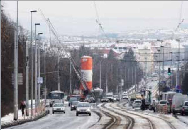
Realizace sloupů tryskové injektáže z povrchu v částečném záboru Evropské třídy
