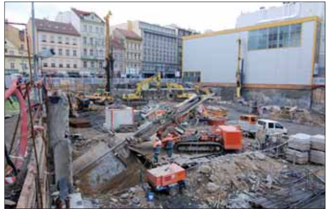
Zajišťování eskalátorového tunelu mikropilotovým dešťníkem
