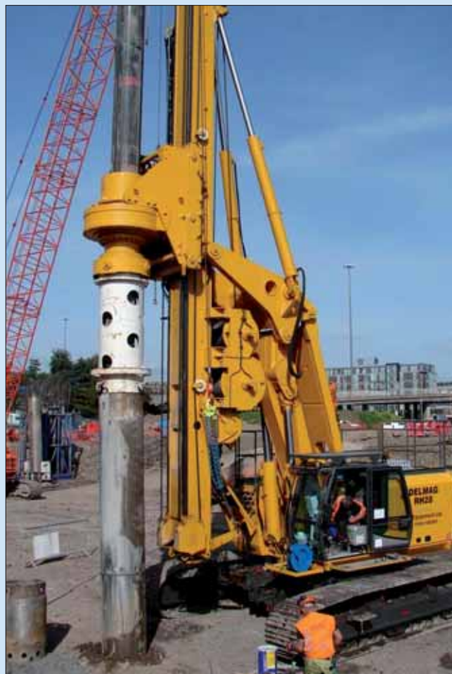
Obr. 2: Vrtná souprava Delmag RH28
