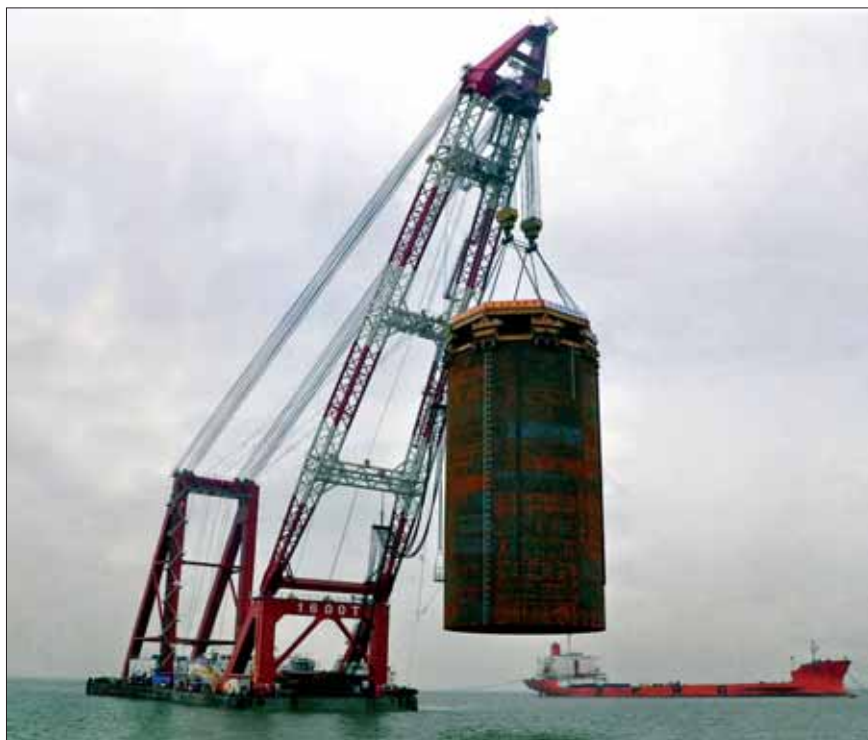
Obr. 7: Rekordní beranění pažnice pro jímku základů mostu Hong Kong–Zuhai–Macau v Čínském moři v roce 2012. Čínský generální dodavatel použil vibrační 8dílné beranidlo firmy American Piledriving Equipment pro pažnice o průměru 22 m a délky 39,6 m.
