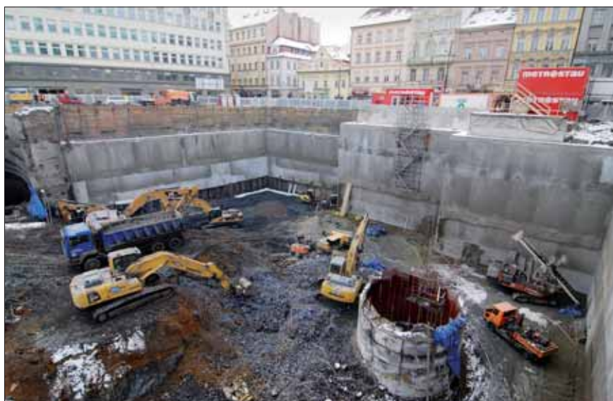
Původní VZT štola před demolicí
