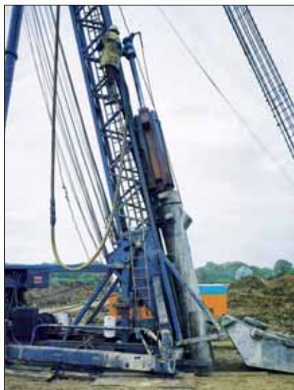
Obr. 9: Souprava pro výrobu pilot typu Vibropile, umístěná na pevném rámu, britská firma PCL, rok 1982
