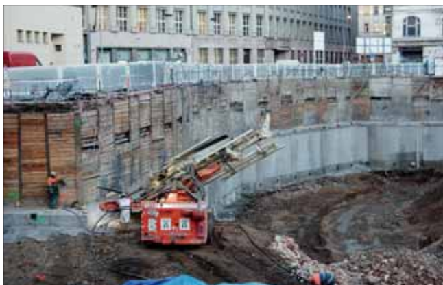
Kotvení hlavového trámu pilotové stěny
