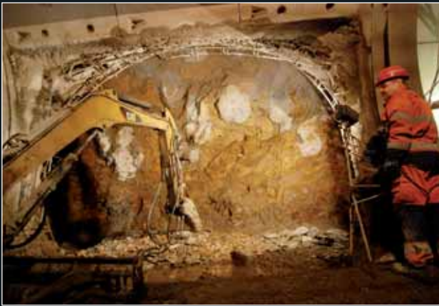
Fáze ražby propojky č. 2.7, zajištěné pomocí sanační a těsnící horninové injektáže
