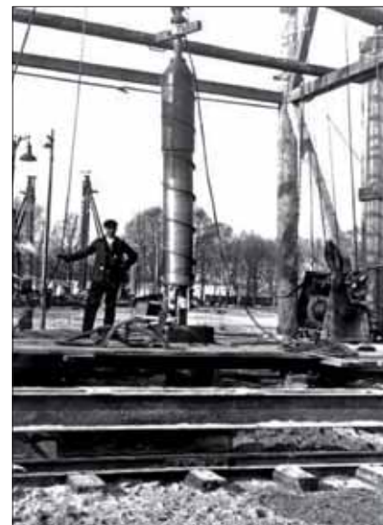
Obr. 11: První ponorný vibrátor z roku 1937 na stavbě (Betterground)
