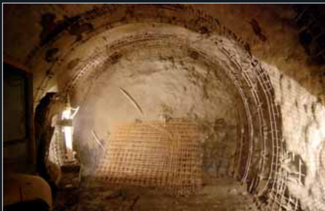
Pohled do propojky zajištěné ostěním před prorážkou do sousedního traťového tunelu
