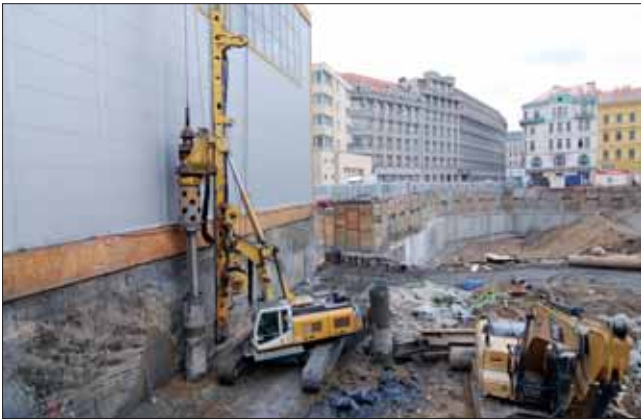
Provádění stěny z převrtávaných pilot podél OD MY
