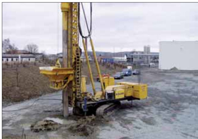
Obr. 12: Nasazení soupravy Vibrocat firmy Keller s ponorným vibrátorem a vrchním dávkovacím štěrku na hrot pomocí skipu
