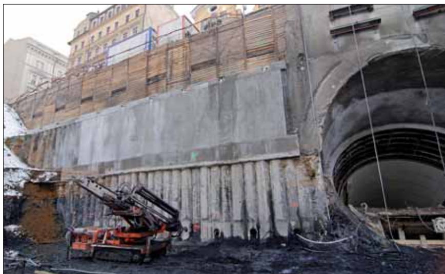
Kotvení pilotové stěny na 3. kotevní úrovni
