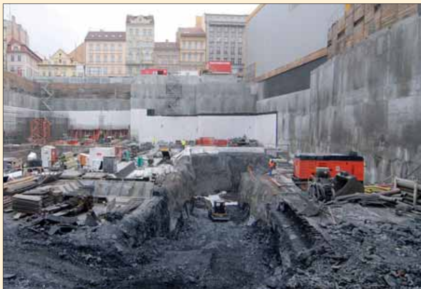
Hloubený a zajišťovaný VZT kanál
