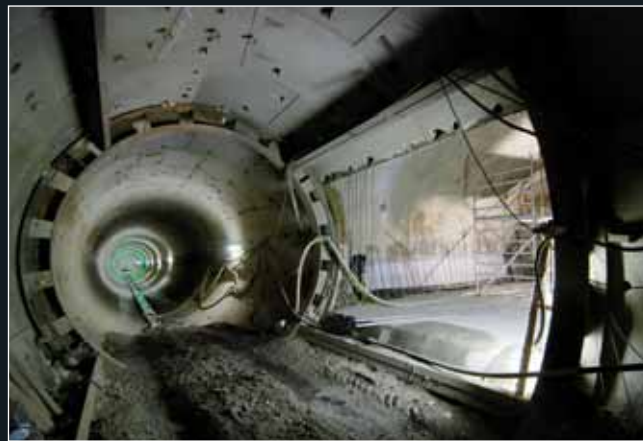
Hotová propojka mezi traťovými tunely
