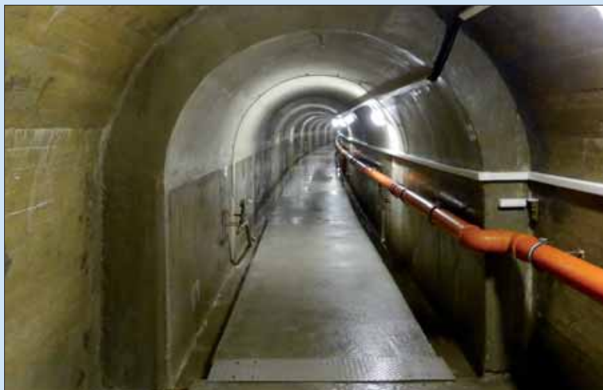
Pohled na dokončenou injekční štolu II. etapy od odbočky přístupové štoly
