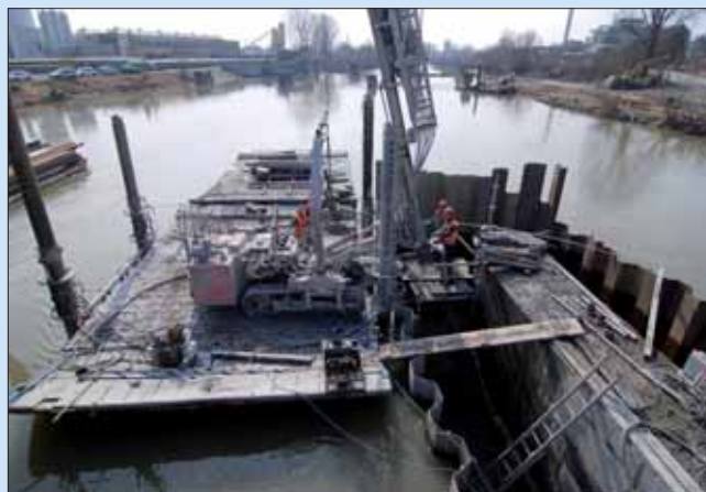
Sanace pilíře P2 pomocí mikropilotů pod ochranou štětové jímky
