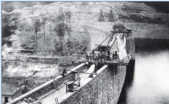
Dodatečné utěšňovací práce v období 1914–1915, vrtná souprava na koruně hráze
