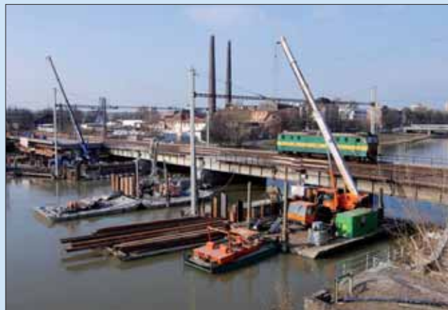
Současné provádění prací na všech říčních pilířích, zleva P1, P2, P3
