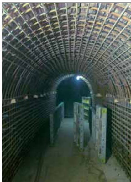
Šikmá část injekční štoly – armování stěn definitivní obezdívky
