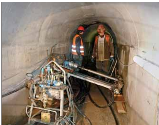
Hloubení drenážních vrtů vrtnou soupravou Lumesa SIG Mounty 2000/91 H
