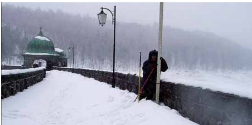
Měření svislých posunů metodou velmi přesné nivelace bylo prováděno i v obtížných zimních podmínkách
