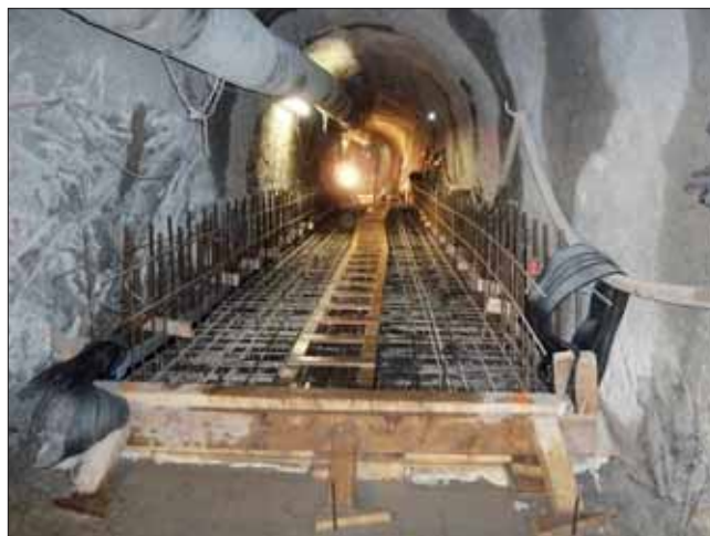
Betonáž počvy injekční štoly
