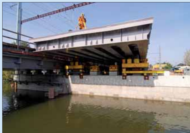
Výsuv nosné konstrukce, vlevo je již nová konstrukce v provozu
