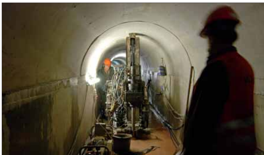
Hloubení injekčního vrtu v rovné části injekční štoly, vrtná souprava MSV 741/20
