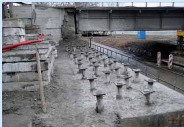
HLAVY MIKROPILOT NA OPĚŘE O2
