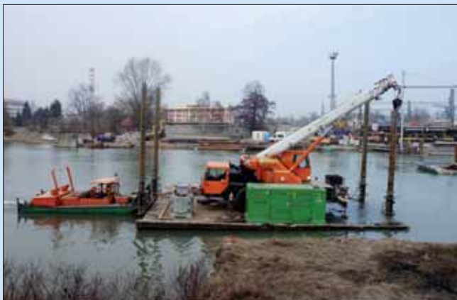
Sestava pontonů s hydraulickými nohami je tlačným člunem přesouvána na místo stavby.
