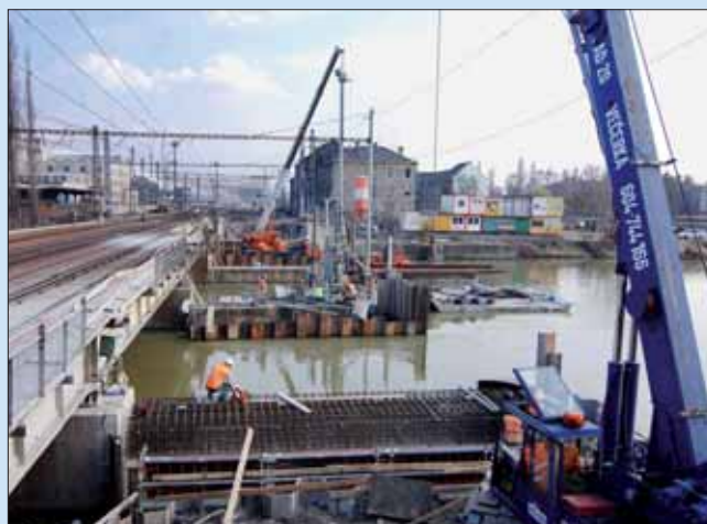
SOUCASNÉ PROVÁDĚNÍ PRACÍ NA VŠECH ŘÍČNÍCH PÍLÍŘÍCH, V POPŘEDÍ PÍLÍŘ P3
