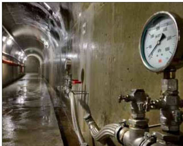
Injekční štola II. etapy po dokončení prací s osazenými vztlakoměrnými vrty
