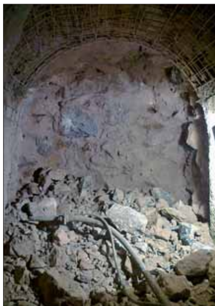
Čelba po odpalu
