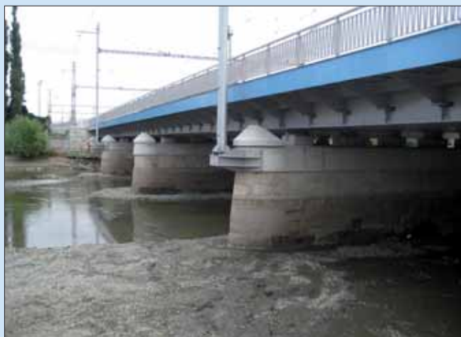
Pohled na dokončený most při snížené hladině řeky Bečvy
