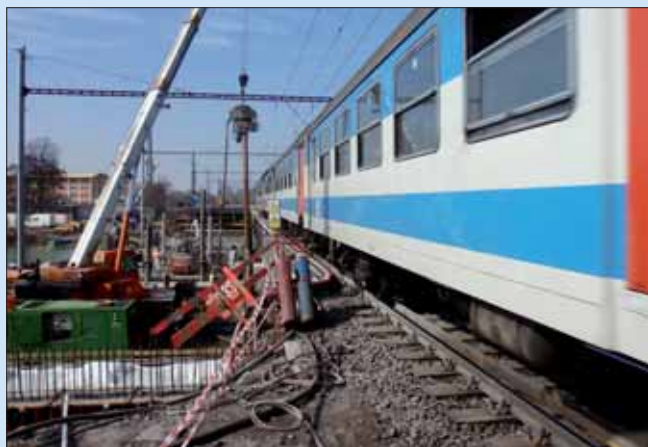
Beranění jímků kolem pilířů probíhalo často v těsné blízkosti provozovaných kolejí
