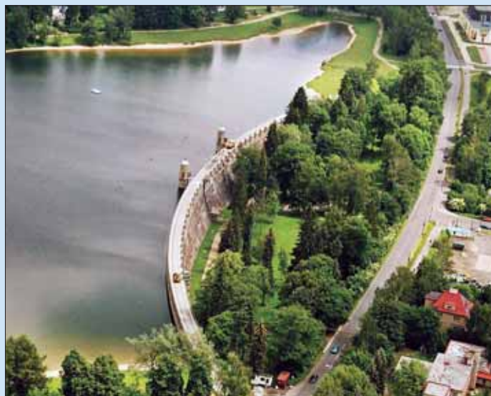
Letecký pohled na VD Mšeno u Jablonce nad Nisou po dokončení sanačních prací (1998–2000), foto: Povodí Labe, s. p.
