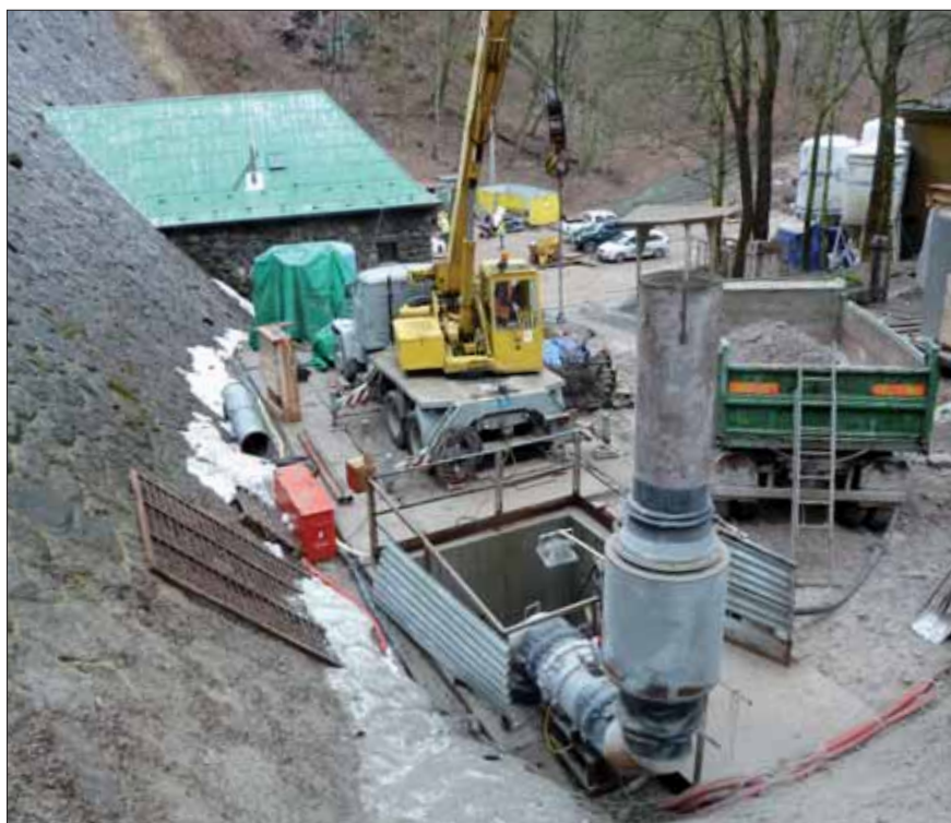
Pohled na vstupní šachtu a zařízení staveniště
