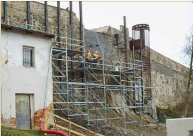
Z těžkého lešení jsou prováděny vrtné práce pro osazení tyčových trvalých kotvě pro uchycení svislých žebér, (2/2016)
