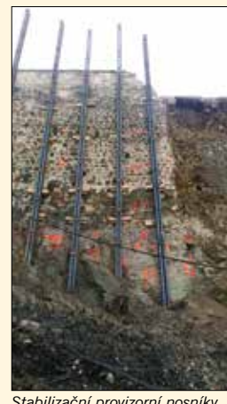
Stabilizační provizorní nosníky osazené na záběru č. 1, (1/2016)
