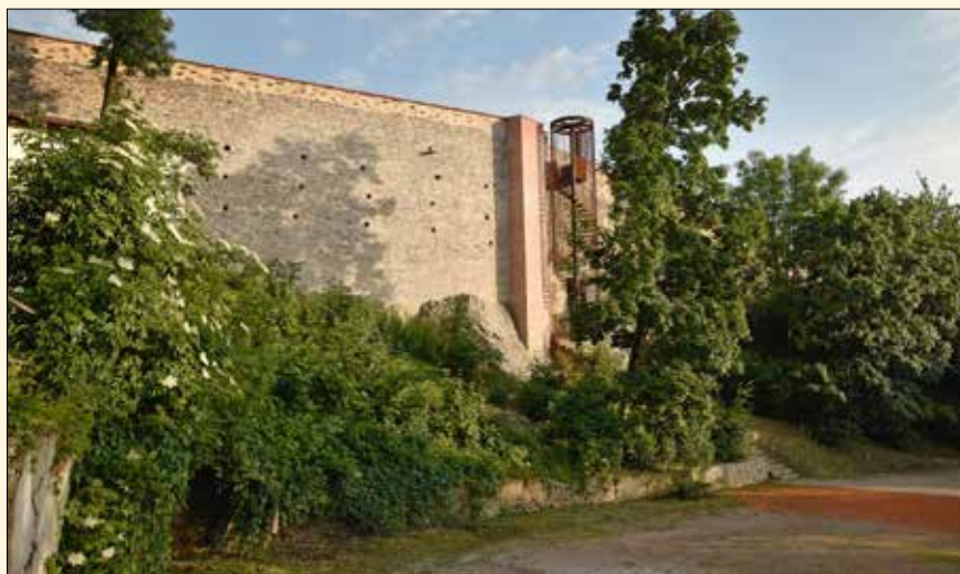
Nejvyšší část severní stěny s točivým schodištěm po opravě, (5/2017)
