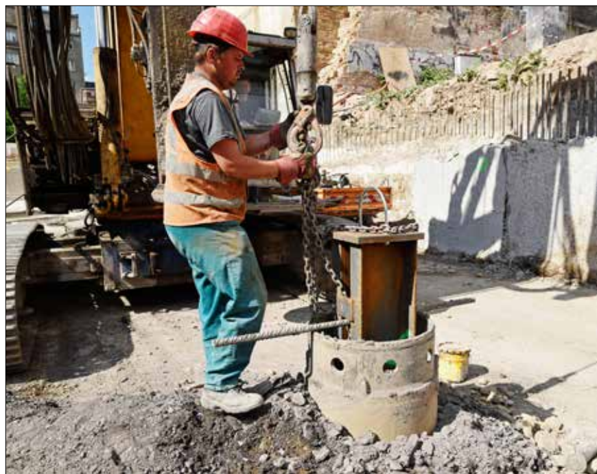
HLAVA OCELOVÉHO SLOUPU PO OSAZENÍ DO VRTU
