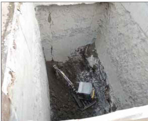
Hloubení studny č. 4
