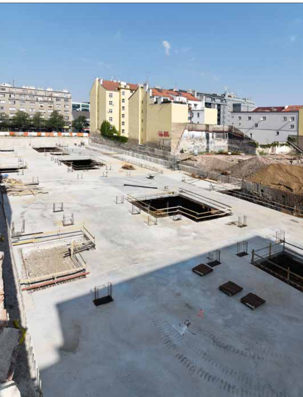
Pohled na dokončenou stropní desku nad 2. PP
