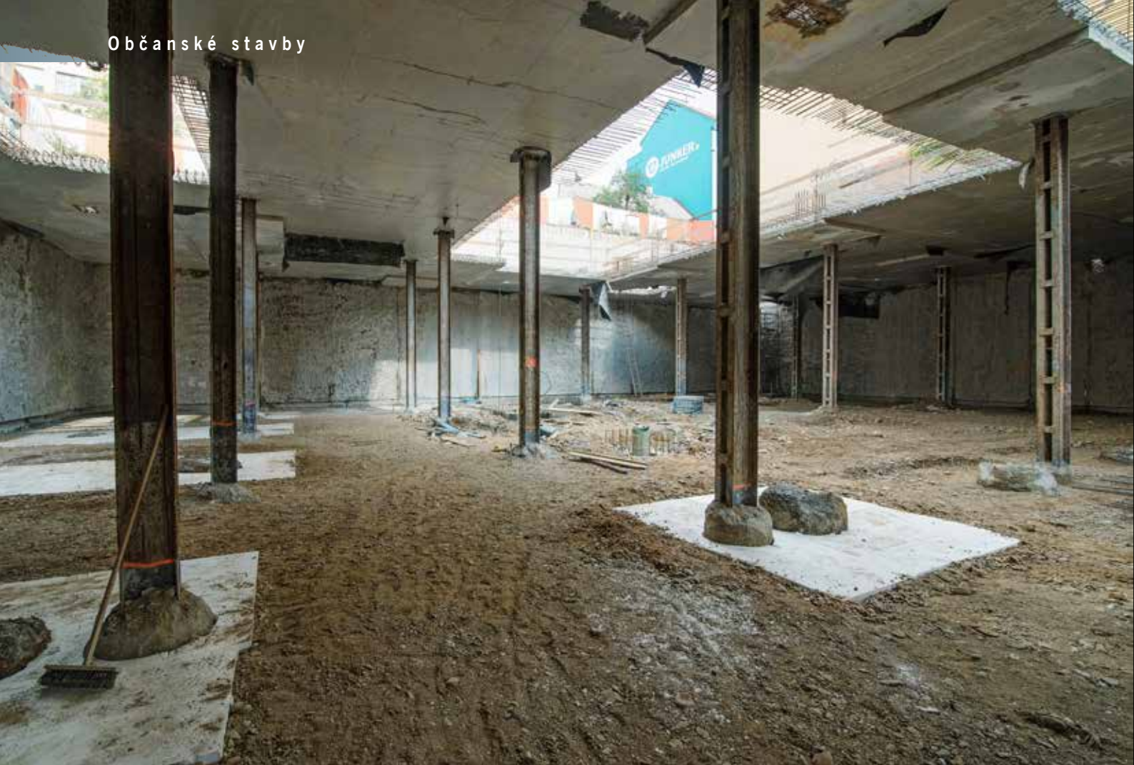
Stavební jáma objektu Karolina Plaza vytěžená na definitivní úroveň; pažení tvoří konstrukční podzemní stěna.
