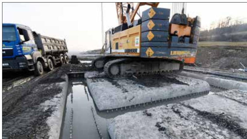
Statický prvek po betonáži
