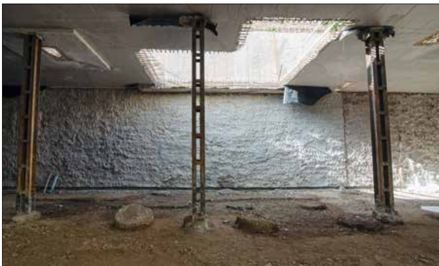
Konstrukční podzemní stěny v úrovni 3. a 2. PP s ořezovaným povrchem
