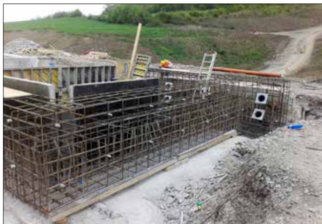
Vyarmovaný ztužující věnec
