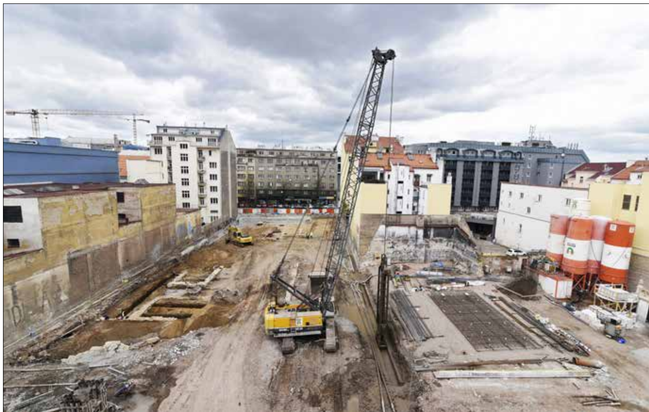
Těžba podzemních stěn pro pažení stavební jámy
