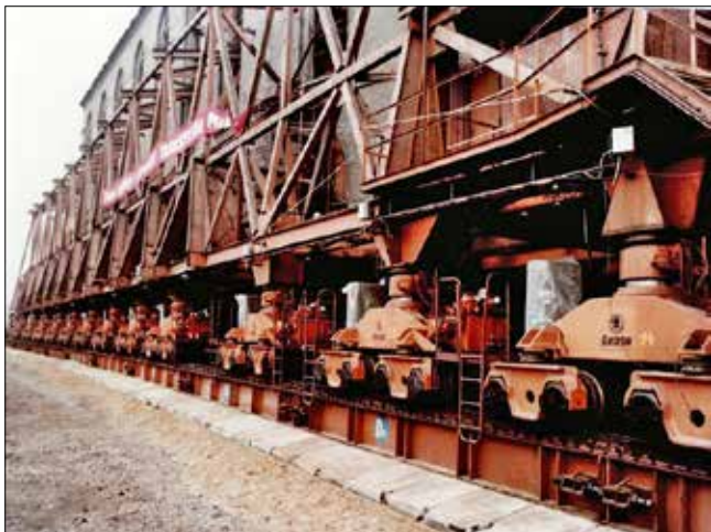
Obr. 9: Skřínky elektronicky snímané hydrostatické nivelace (zakryté folií) s okamžitým přenosem dat do centrály Hottinger na podvozcích přesunu mosteckého kostela v roce 1975 (TS Plzeň, a. s.)
