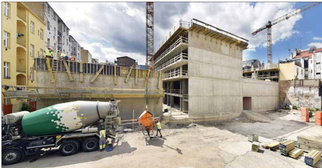
Výstavba nadzemní části objektu Karolina Plaza 1, květen 2017
