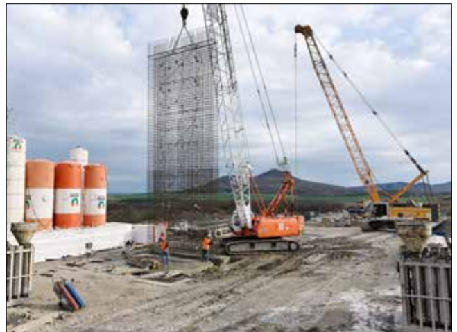
Spouštění armokoše A2 do vytěžené rýhy pažené polymerovou suspenzí
