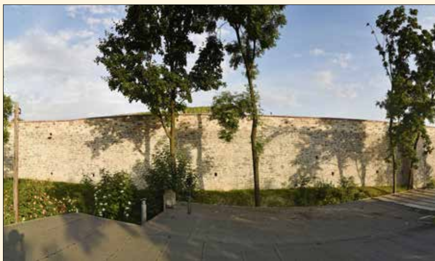
Rozvinutý pohled na větší část severní zdi po opravě, (5/2017)
