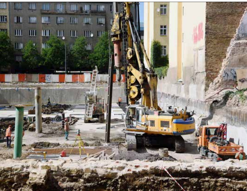
VRTNÁ SOUPRAVA PŘI OSAZOVÁNÍ PROVIZORNÍCH OCELOVÝCH SLOUPŮ DO VRTŮ
