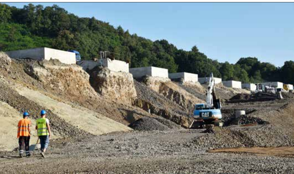
Odtěžování rýhy pro kanalizaci u realizovaného statického prvku č. 4
