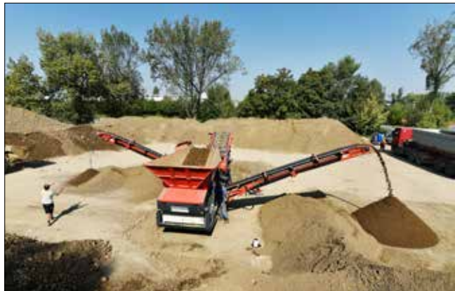
Třídění materiálu vytěženo ze stavební jámy na frakce
