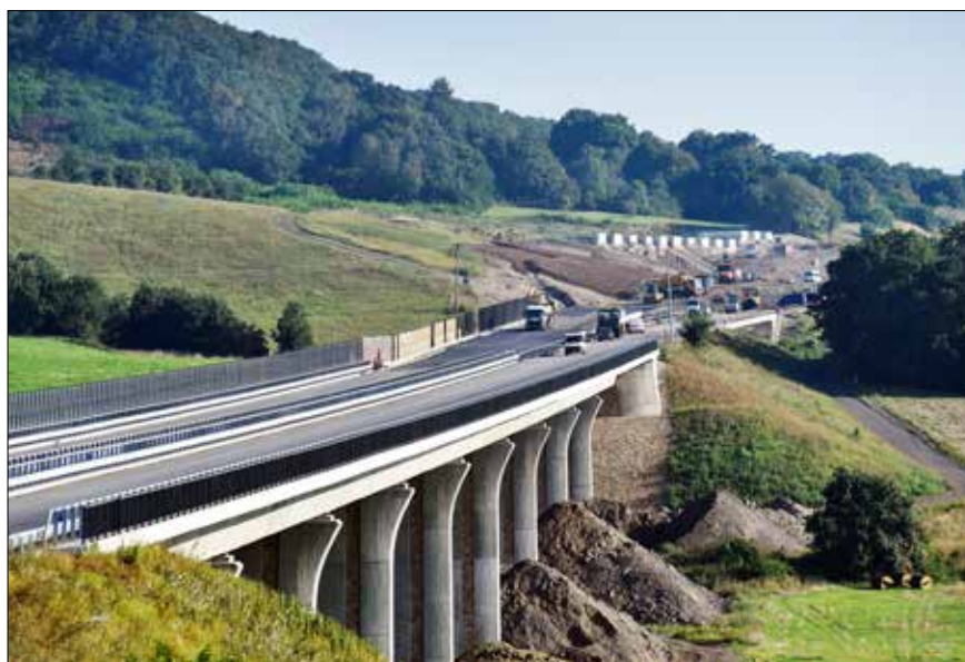
Pohled na místo provedených sanačních opatření (od jihu)
