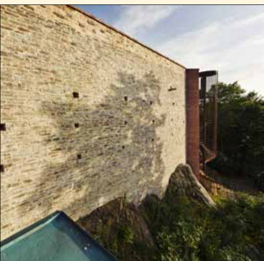
Nejvyšší část severní stěny s točivým schodištěm po opravě, (5/2017)
