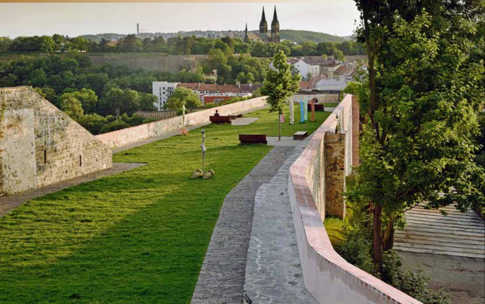
Bastion XXXI se zachycenou severní opravenou zdí vpravo, pohled z terasy restaurace přes Nuselské údolí k Vyšehradu
