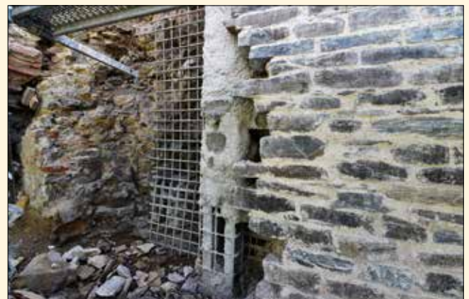
Hranice dozděného záběru, svislé žebro je podstříknuto betonem, (9/2016)
