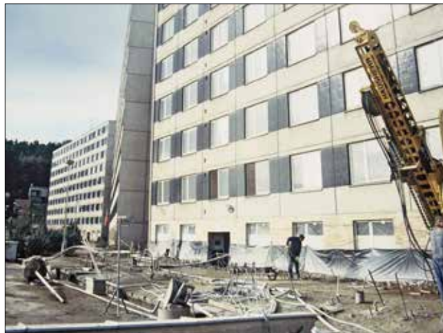
Obr. 10: Dodatečná injektážní rektifikace devítipodlažního objektu v Brně-Jundrově, archiv Zakládání staveb, a. s.
