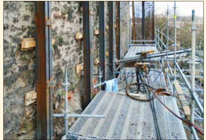
Z těžkého lešení jsou prováděny vrtné práce pro osazení tyčových trvalých kotvě pro uchycení svislých žebér, (2/2016)
