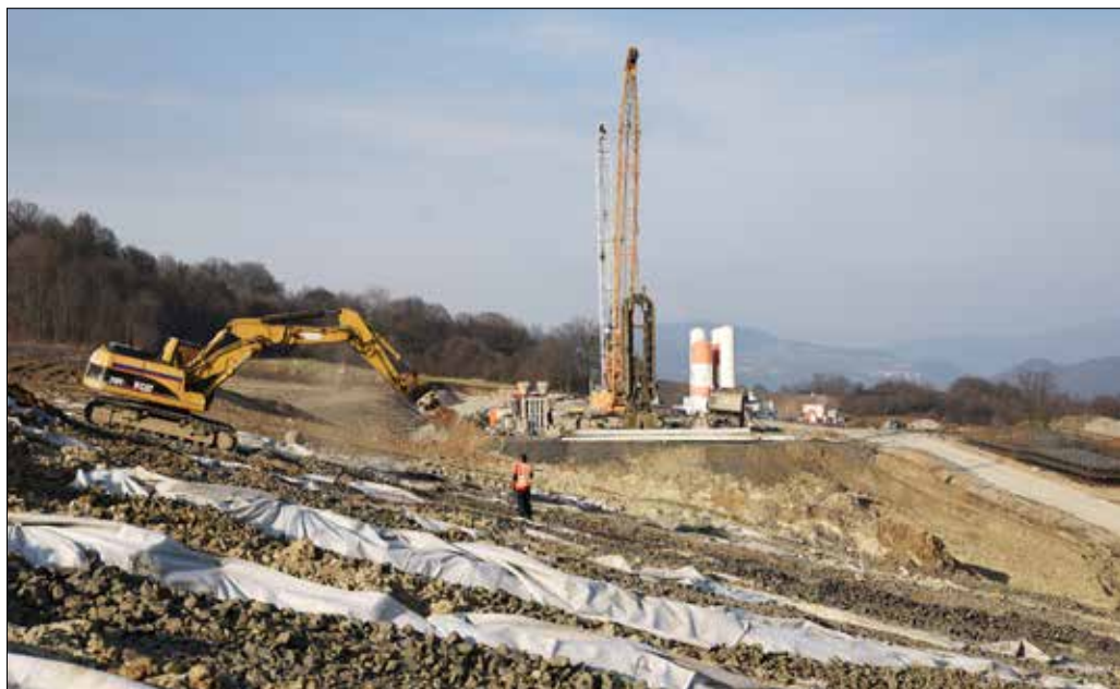
Realizace podzemních stěn, pohled ze západního okraje území v prostoru nad tělesem dálnice
