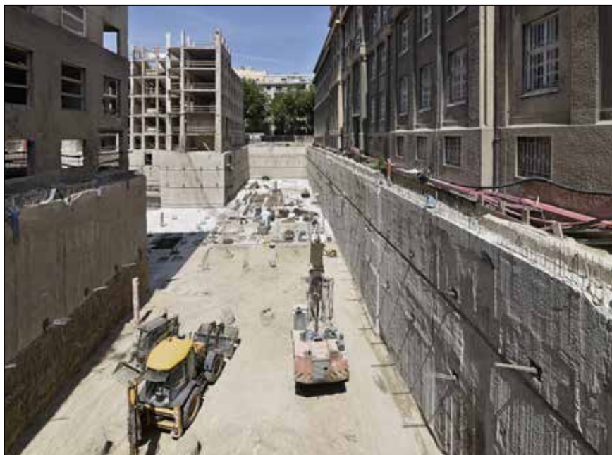
Podzemné steny s povrchom upraveným frézovaním v ulici Lomonosova
