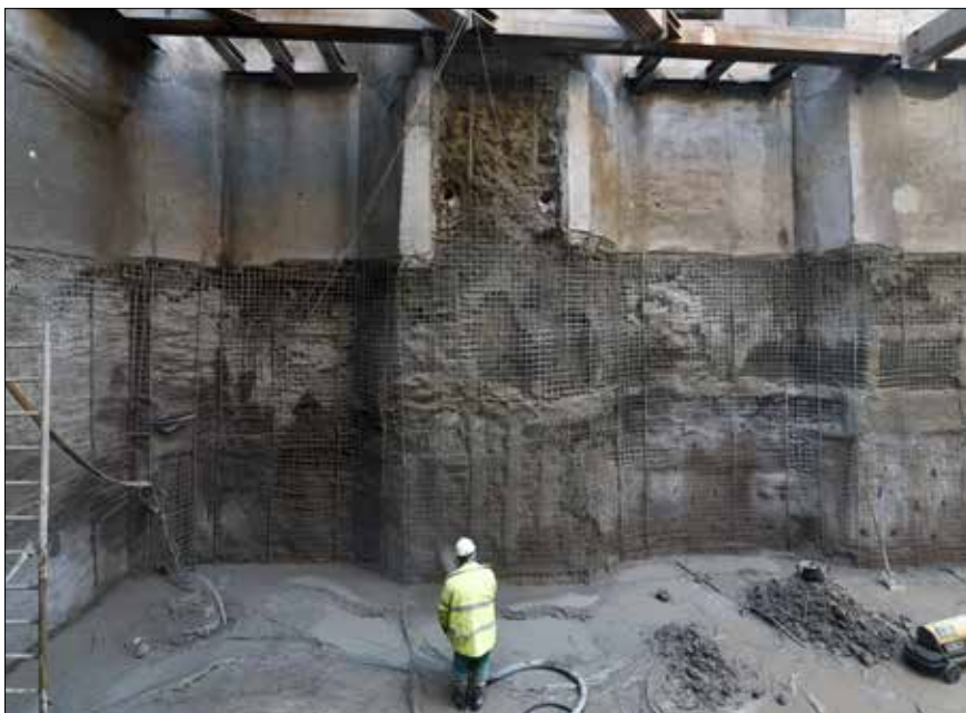
Provádění stříkaných betonů z úrovně -11,7 m (podél budoucích automobilových zakladačů)
