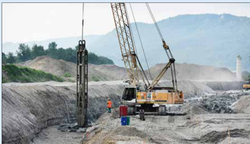
Těžba těsnicí podzemní jílocementové stěny pro vytvoření těsnění spodní části hráze
