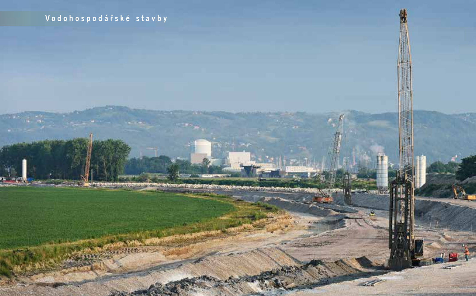
Střední úsek pravobřežní hráze pro HE Brežice s jadernou elektrárnou Krško v pozadí, práce na těsnicí podzemní stěně.
