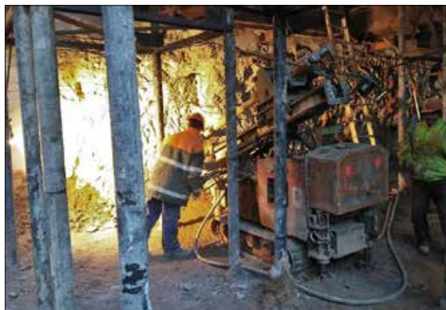
Vrtání trvalých zemních hřebíků v prostoru mikropilotových bárek
