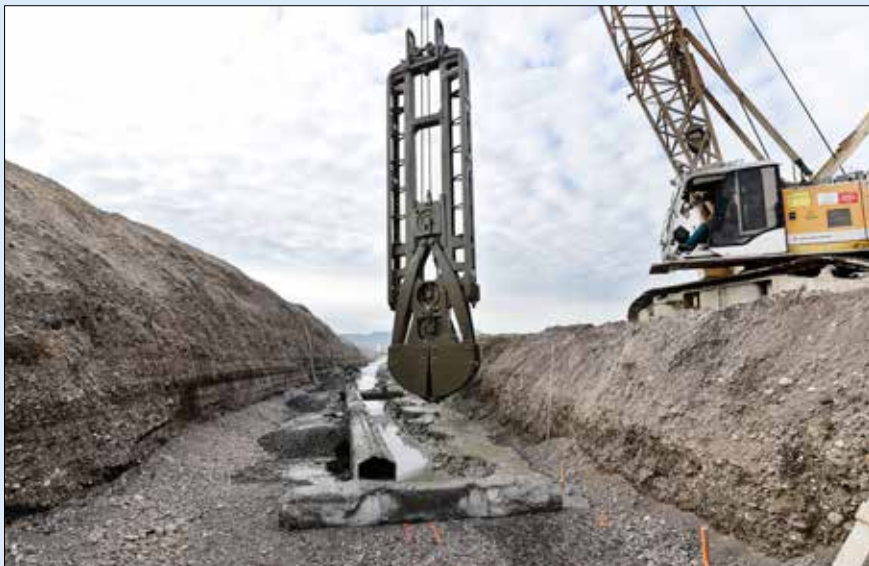
Těžba těsnicí podzemní jílocementové stěny za pomoci vodící šablony
