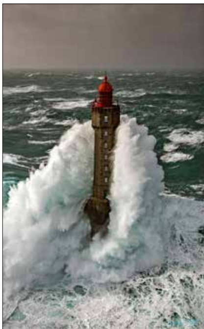
Obr. 8: Bretaňský maják La Jument v bouřlivé mořské oblasti, dodatečně přikotvený roku 1930 do žulového podloží (internet)
