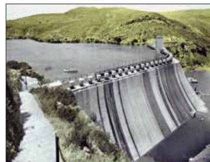
Obr. 9: Přehrada Cheurfas v Alžíru byla v roce 1934 přikotvena 37 kabelovými kotvami (forgalus.free.fr)
