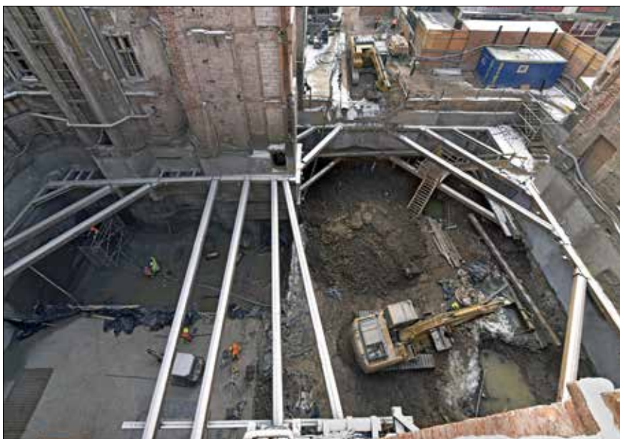
Stavební práce postupují směrem k jedinému přístupu na stavenišť z ulice Smolna
