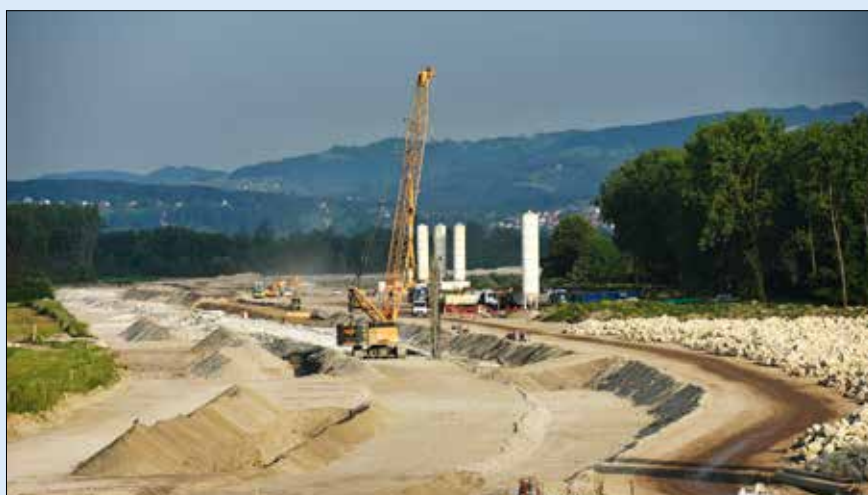
Provádění těsnicí podzemní jílocementové stěny na středním úseku pravobřežní hráze
