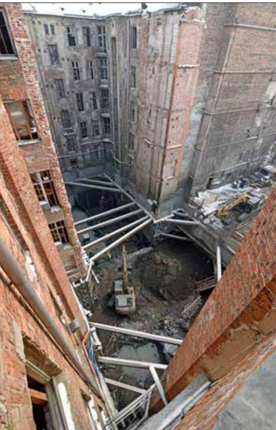
Stavební jáma v pohledu ze 4. nadzemního podlaží objektu Foksal 15
