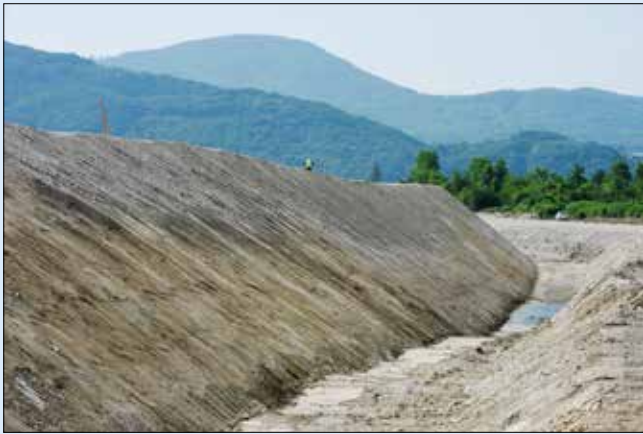
Pohled na dokončenou korunu těsnicí clony části pravobřežní hráze
