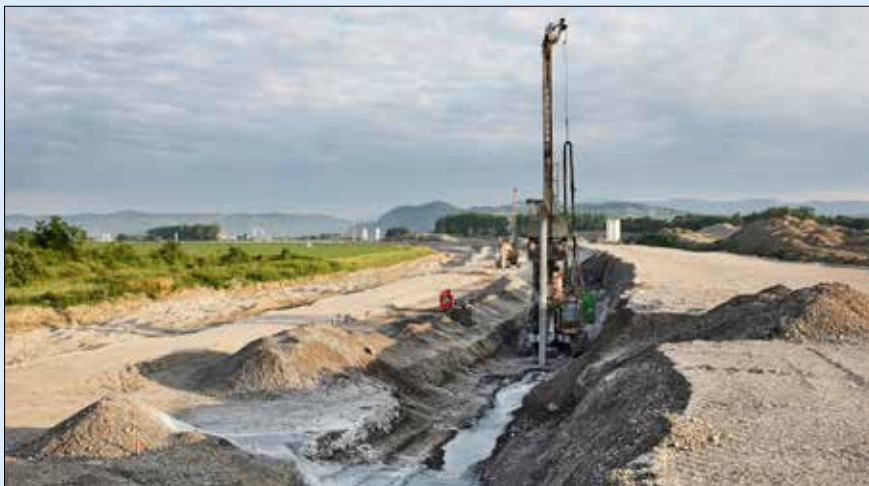
Realizace tenké těsnicí podzemní stěny
