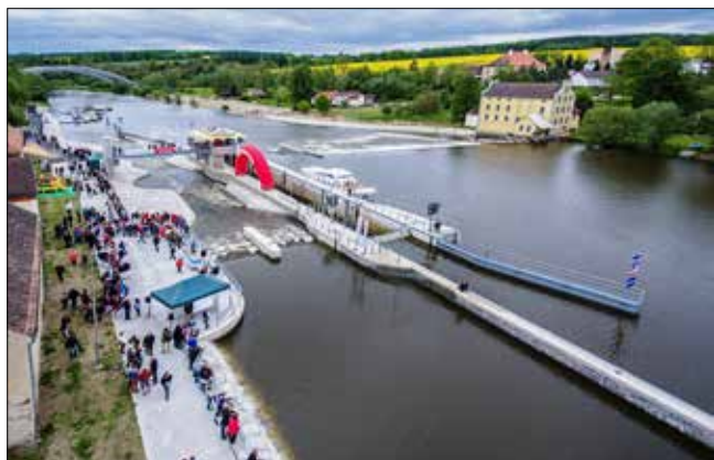
Pohled na nově otevřenou plavební komoru s rybím přechodem v Hněvkovicích
