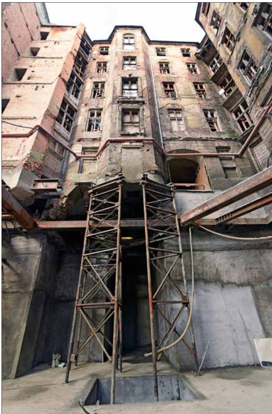
Schodiště objektu Foksal 13 vynesené na mikropilotových bárkách
