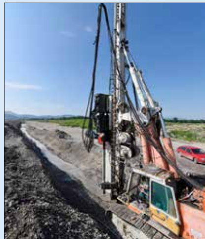
Detail I-profilu s injektáží při provádění tenké těsnicí podzemní stěny
