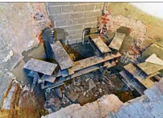
Detail roznášecího roštu mikropilotových bárek v prostoru schodiště objektu Foksal 13; zejména v těchto místech byl prostor pro vrtání mikropilot extrémně stísněný.
