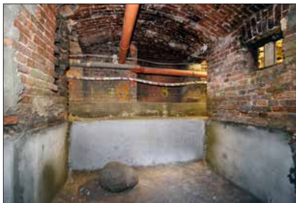
Betonový trám na hranici se sousedním objektem Foksal 17, podlahy ve sklepích byly prohloubeny o cca 1 m.
