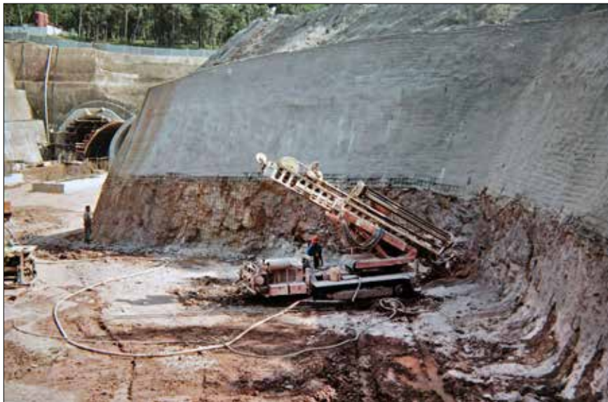
Obr. 13: Zajištění portálu a předportálových stěn tunelu Panenská na D8 hřebíkováním, rok 2005 (archiv Zakládání staveb, a. s.)
