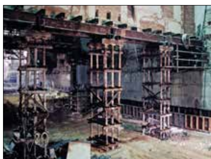
Obr. 4: Nosné bárky z příčně vyztužených injektovaných mikropilot 108/12 mm při přestavbě suterénu Stavovského divadla v roce 1987 (archiv Zakládání staveb, a. s.)
