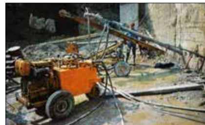
Obr. 10: Vrtání pro instalaci drátových kotev jádrovací hydraulickou soupravou Hagby Bruk ke kotvení podzemních stěn suterénu na stavbě obchodního domu Kotva v Praze v roce 1973 (archiv Zakládání staveb, a. s.)
