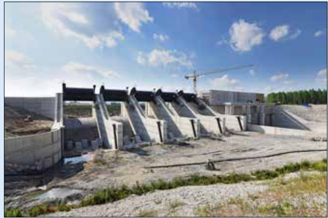
Přehrada HE Brežice s výtoky během výstavby
