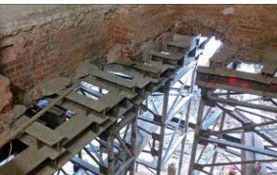
Mikropilotové bárky – v pravé horní části fotografie je patrná klenba nad původním vstupem do sklepních prostor
