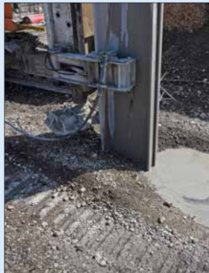
Detail I-profilu s injektáží při provádění tenké těsnicí podzemní stěny
