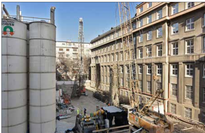
Realizácia podzemných stien v severozápadnej časti ulice Lomonosova
