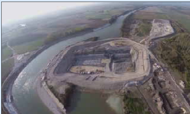
Letecký pohled na stavební jámu HE chráněnou dočasnou hrází ze směsné zeminy
