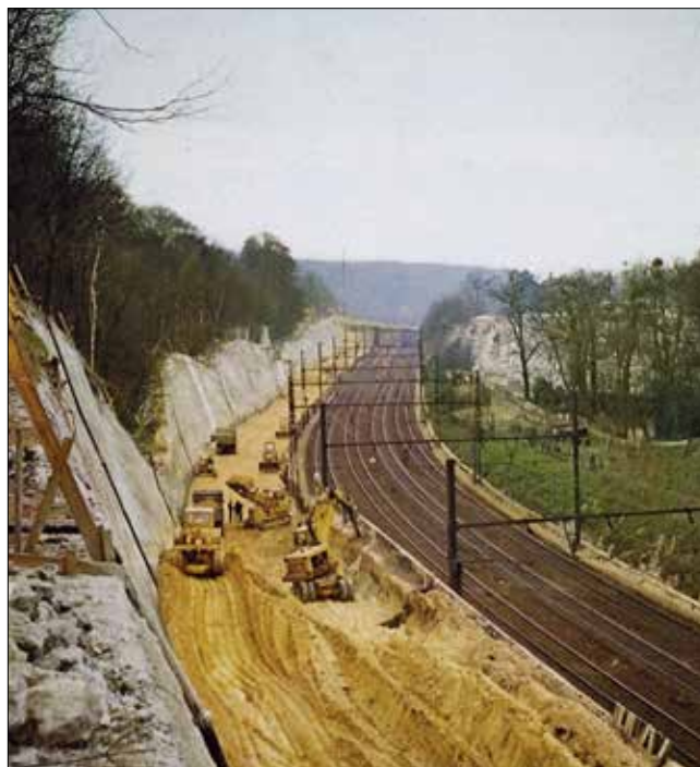
Obr. 12: Zajištění svahu v písčítých zeminách pro rozšíření železnice ve Versailles hřebíkováním v roce 1972 (Soletanche)
