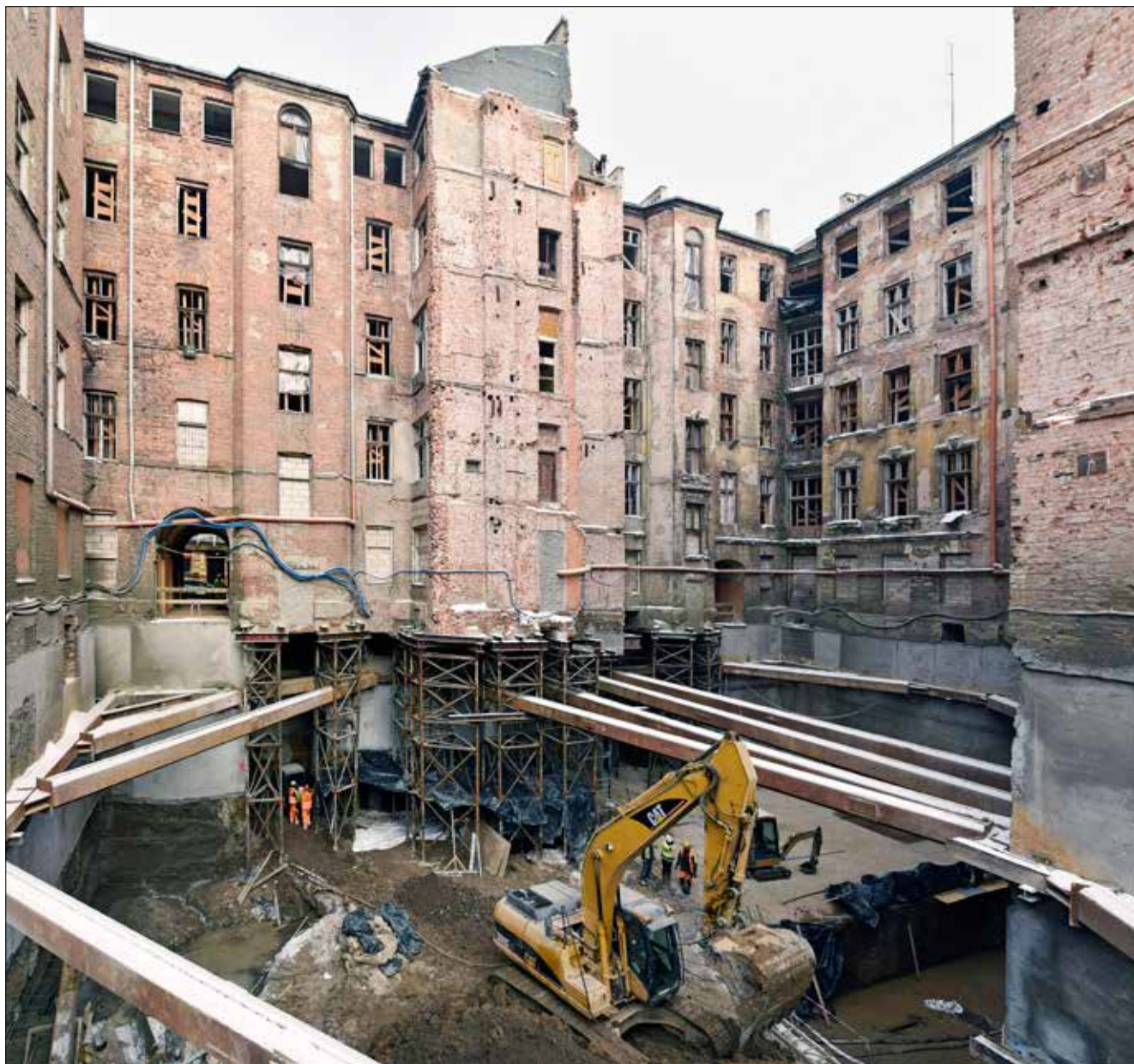
Pohled do stavební jámy před dokončením podkladních betonů
