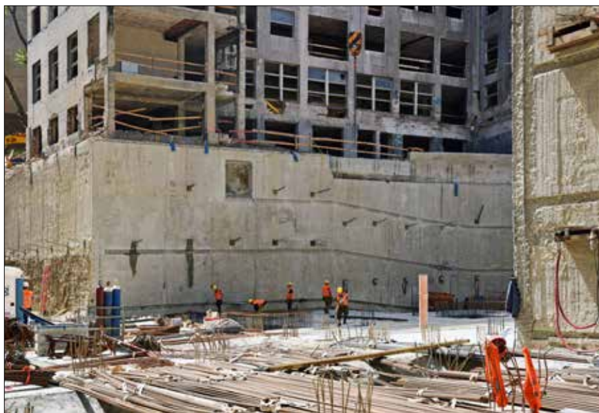
Podzemné steny pod objektom Bezručova 3 behom výstavby nového skeletu
