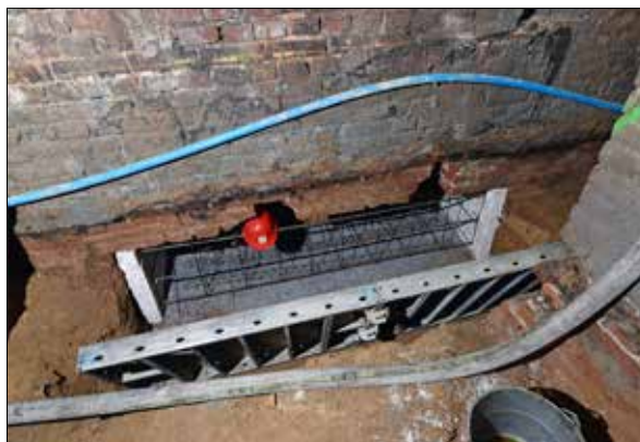
Betonový trám na hranici se sousedním objektem Foksal 11, trám byl betonován po jednotlivých elementech.
