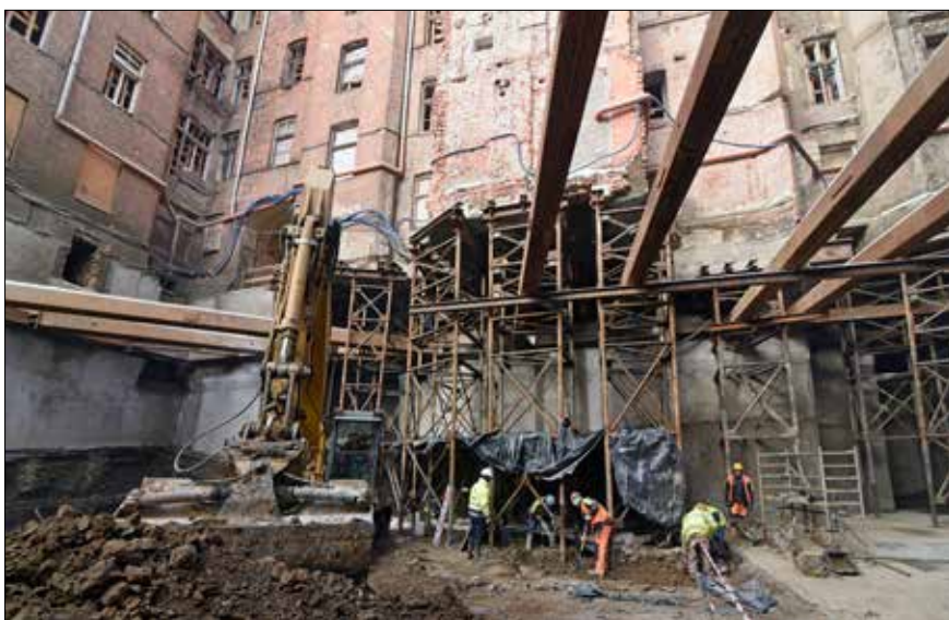
Průchod rozpěrného rámu mikropilotovými bárkami
