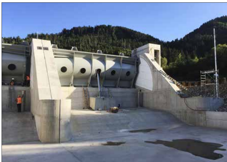
Jezová pole s dělicím pilířem a osazenou klapkou
