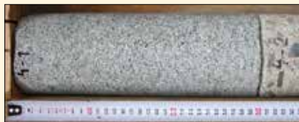
Obr. 15: Žulový obklad zachycený jádrovým vývrtem č. 4, tl. obkladu 300 mm, na kámen bezprostředně navazuje beton. Průměrná pevnost kamene v tlaku byla zjištěna a vypočtená v hodnotě 103 MPa.
