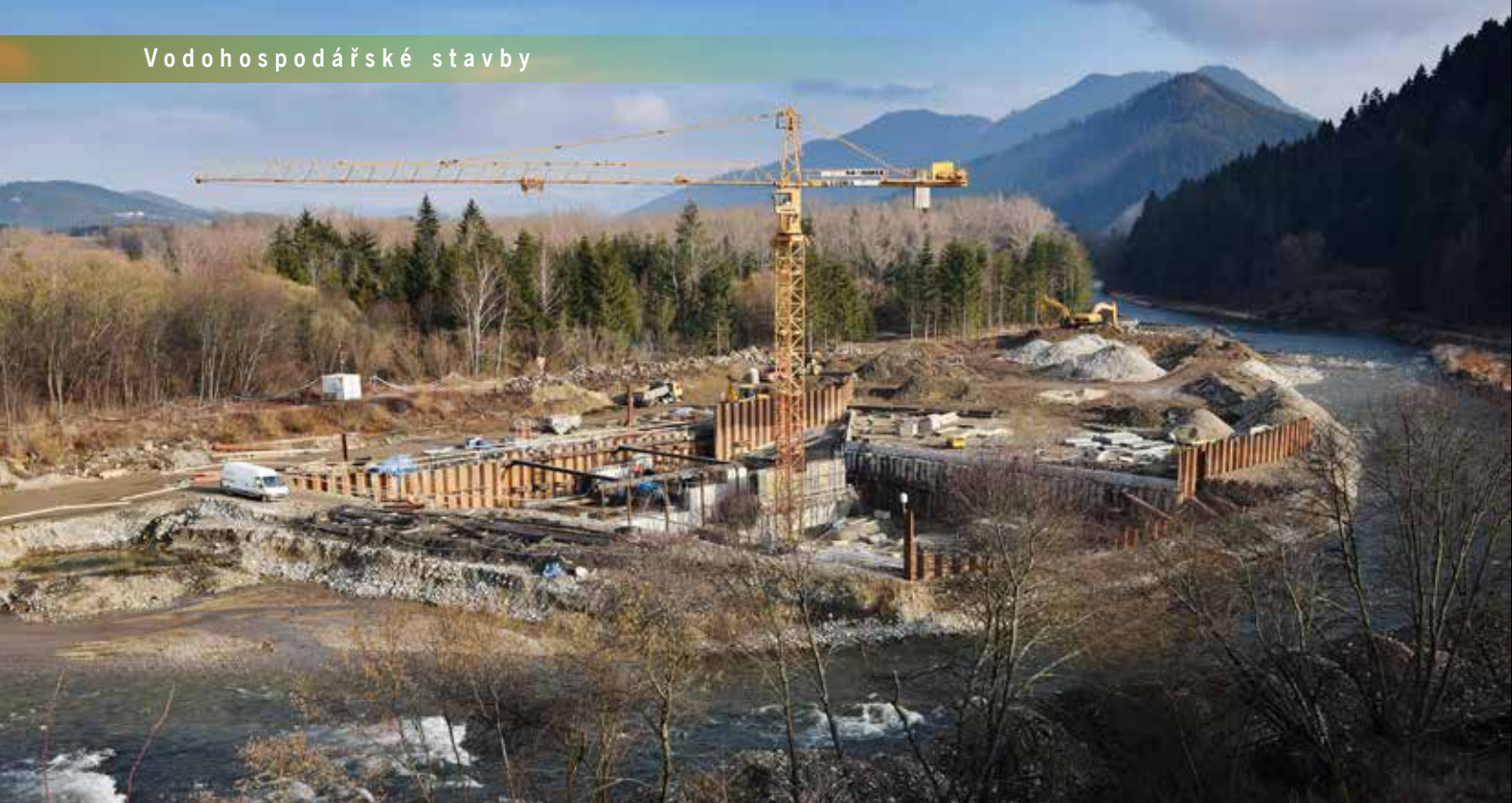
Výstavba MVE vo fáze zaistenia hlavných konštrukcií stavebnej jamy
