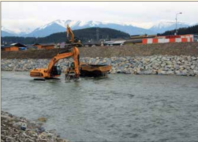
Prehrábka dna koryta pod haťou, opevnenie a zahumusovanie pravého brehu, podobne tomu sú realizované zemné práce nad haťou
