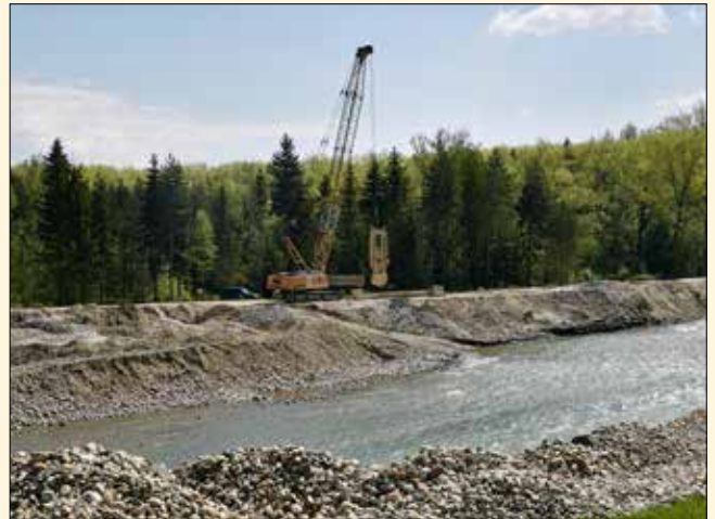
Ťažba podzemnej tesniacej steny, Liebherr 842 s drapákom STEIN 600
