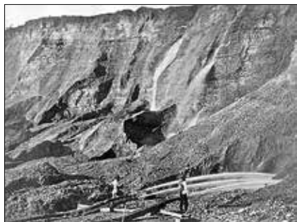
Obr. 1: Hydraulické rozpojování hornin tlakovým paprskem vody z monitorů v kalifornském dolu Dutch Flat v 60. letech 19. století (internet)
