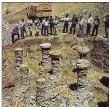
Obr. 7: Zkušební pole s odkopanými sloupy pro zavádění technologických systémů tryskové injektáže firmy Bauer v roce 1983 (Bauer)
