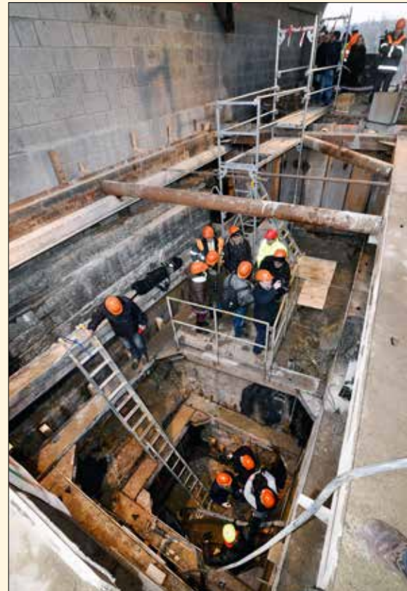
Prohlídka základů pilíře v již dokončené jímce
