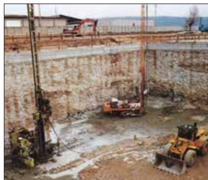
Obr. 9: Pažení stavební jámy v ideálních podmínkách šterkové základové půdy s pomocí sloupů tryskové injektáže o průměru 1,2m v Itálii v roce 1982 (Fondazioni Speciali)
