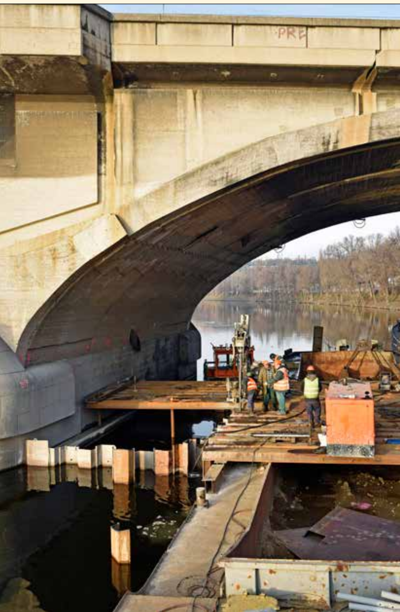
Provádění tryskové injektáže pro utěsnění pat štětovic z pracovní plošiny na lodi Hanka
