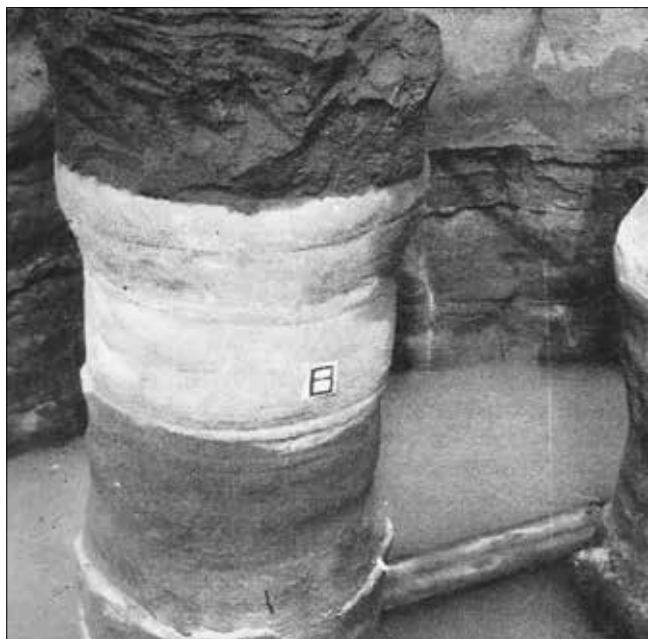
Obr. 4: Zkušební sloup tryskové injektáže o průměru 0,8m, zhotovený tlakem 10 MPa v pokusné vodní jímnice na stavbě v Pákistánu v roce 1962 (Cementation)
