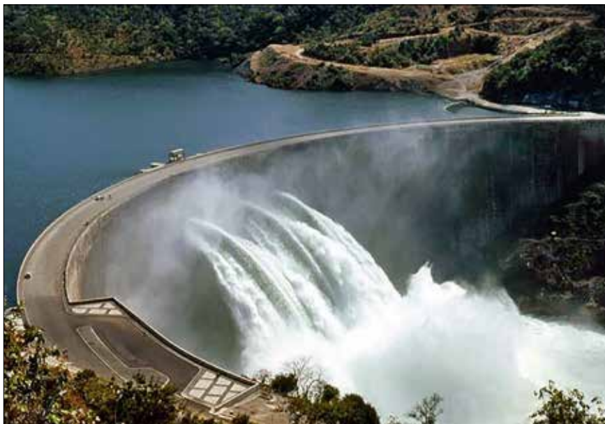
Obr. 3: Klenbová přehrada Kariba na řece Zambezi mezi Zambíí a Zimbabve s funkcí povodňových výpustí. Při provádění její clony v roce 1955 bylo rozsáhle uplatněno tryskové vyplachování horninových puklin (internet).
