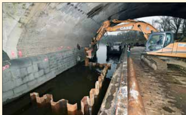
Beranění ve sníženém pohledu oblouku mostu beranidlem s bočním úchopem MOVAX SPH-80
