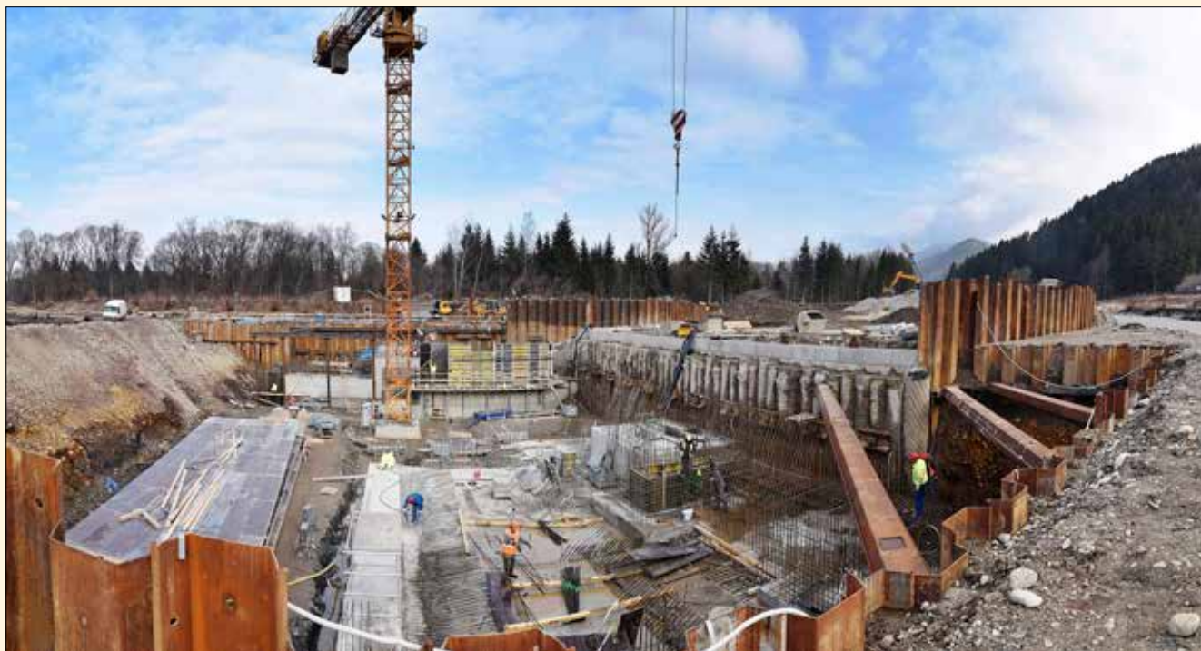
Pohľad do stavebnej jamy, vpravo prevráťavana pilotová stena a rozperný rám
