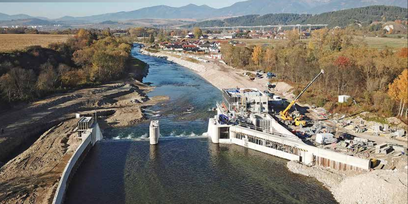
Letecký pohled na jez a elektrárnu z horní vody v průběhu dokončovacíh prací
