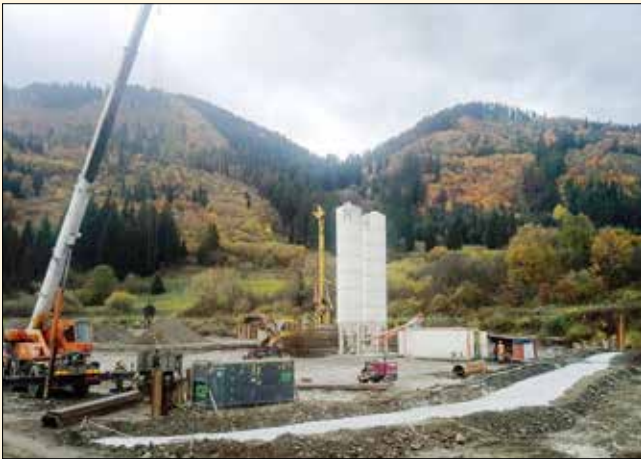
Zrealizovaná podzemná tesniaca stena na spodnej vode, baranenie štetovnic, v pozadí výrobná zmes
