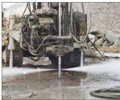
Obr. 6: Ustálený tvar vrtacího monitoru pro jednofázovou tryskovou injektáž při kontrole tryskání před zahájením prací na stavbě firmy Rodio v roce 1985 (Rodio)
