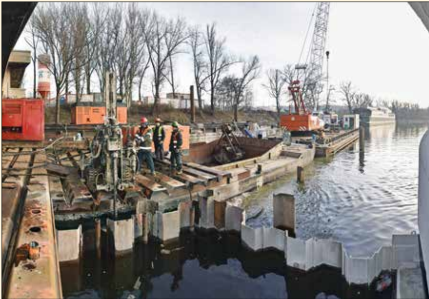
Provádění tryskové injektáže pro utěsnění pat štětovnic průzkumné jímky
