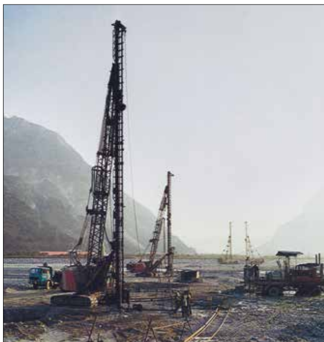
Obr. 8: Zakládání pilířů nové železniční estakády Moggio Udine probíhající údolní nivou řeky Fella, v jámkách vytvořených v kyprých náplavech s balvanů tryskovou injektáží italskou firmou Rodio v roce 1983 (Rodio)
