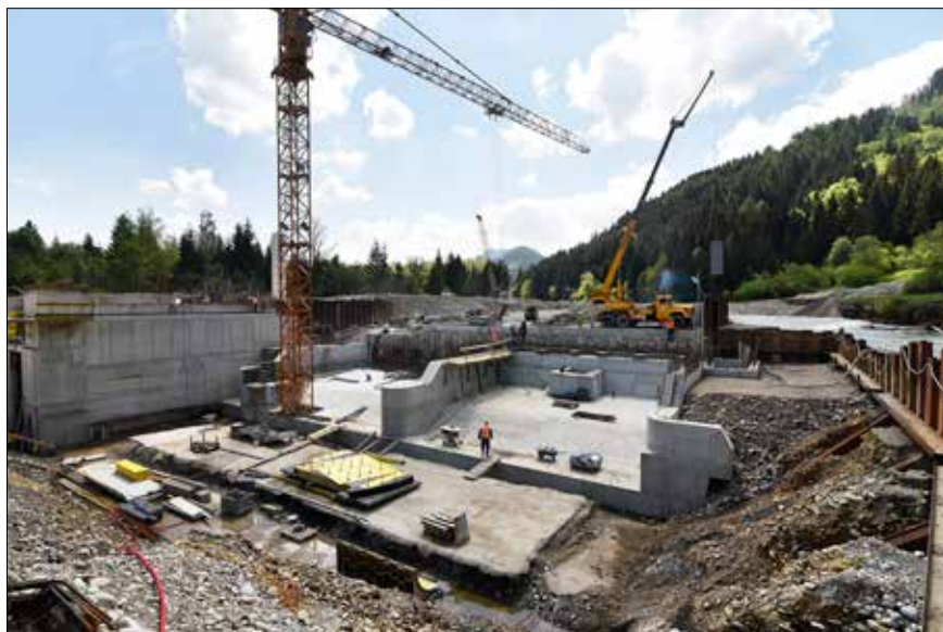
Výstavba jezových polí s vývarem
