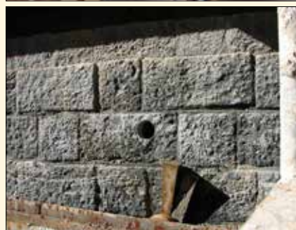
Obr. 14: Nahoře pohled na žulový obklad pilíře č. 3, dole detail v místě odběru jádrového vývrtnu č. 4 pod hladinou Vltavy
