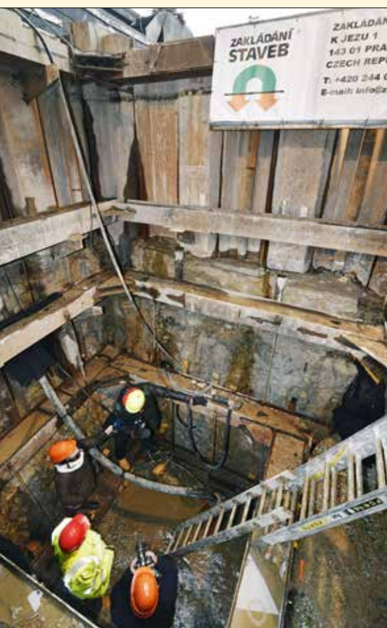
Obr. 1: Pohled na základy pilíře č. 3 z rozepržené jímky
