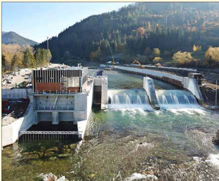
Letecký pohľad zo spodnej vody, v pozadí vpravo prebiehajúca výstavba biokoridoru
