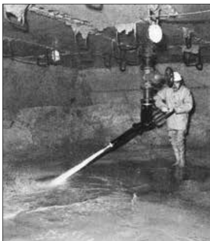
Obr. 2: Hydraulické rozpojování jemnozrnných zemin uvnitř kesonu v Nizozemsku v 50. letech 20. století (The Netherlands Commemorative Volume ICSMF 1985)
