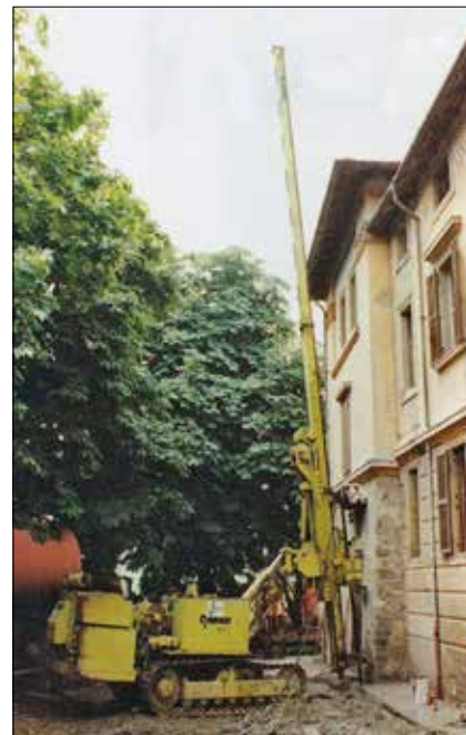
Obr. 10: Podchycování základů rekonstruované budovy subvertikální tryskovou injektáží prováděné v roce 1982 v Parmě v Itálii (Fondazioni Speciali)
