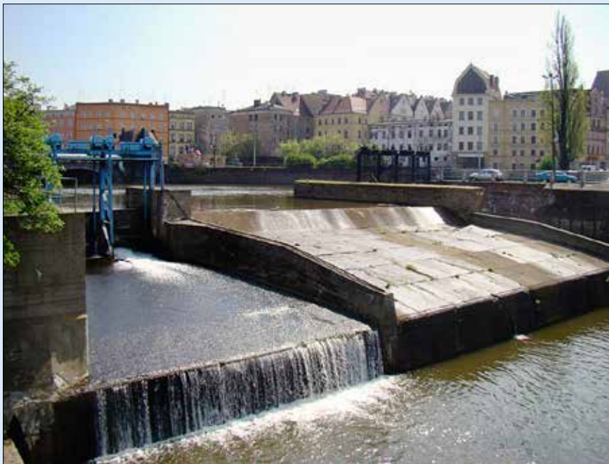
Pohled na původní jez
