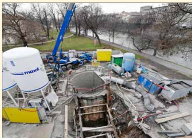
Pohled na šachtu J103 zajištěnou převrtávanými pilotami během provádění ražeb v dolní části šachty
