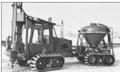
Obr. 4: Švédská samohybná jednodřívková souprava vrtačky a připojeného pneumatického zásobníku vápna do těžkého terénu Linden-Alimak LPS-3 k provádění vápenných pilířů o průměru 0,5 m a hloubky do 10 m v roce 1977 (Linden-Alimak)
