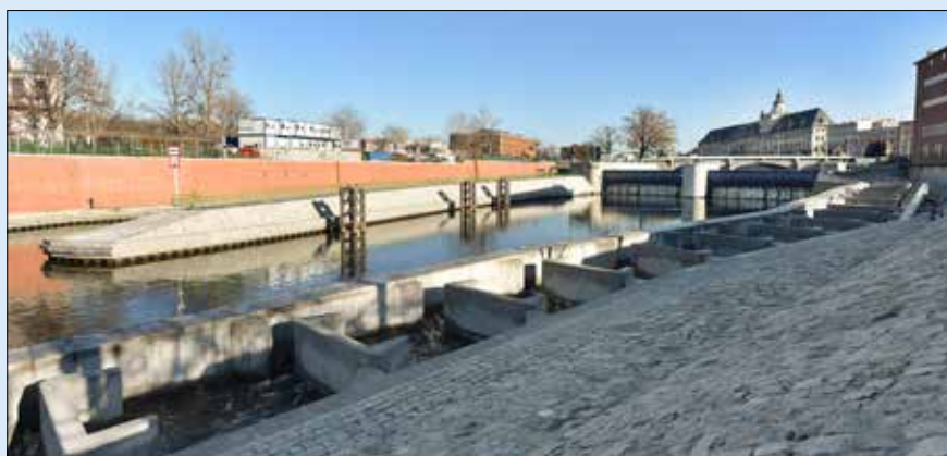
Celkový pohled na jez a rybí přechod z ostrova pod malou vodní elektrárnou
