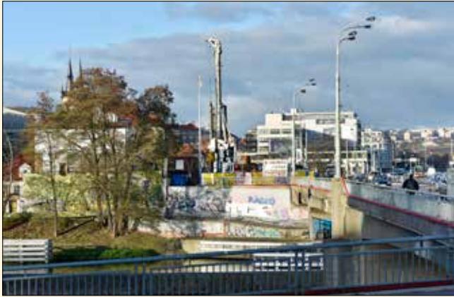
Realizace šachty z převrtávaných pilot J102 na ostrově Štvanici před bývalým zimním stadionem v těsném sousedství pražské magistrály.
