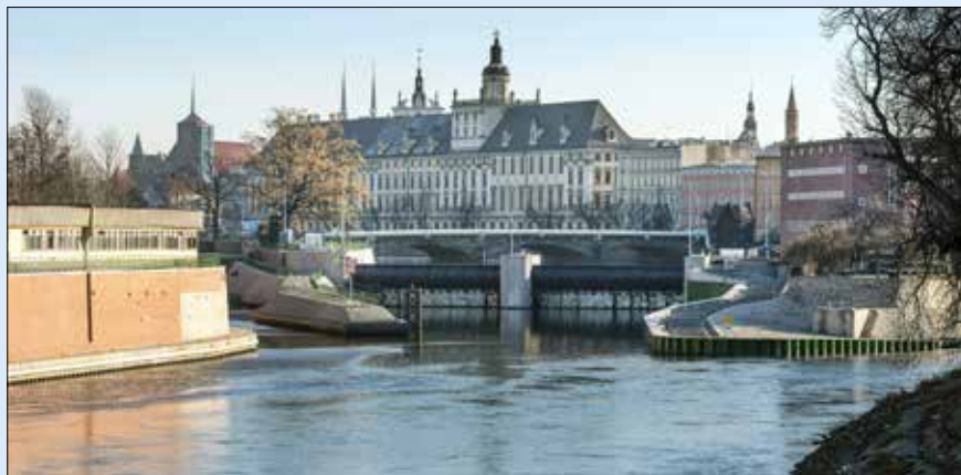
Celkový pohled na nový jez s rybím přechodem z mostu Sikorskiego
