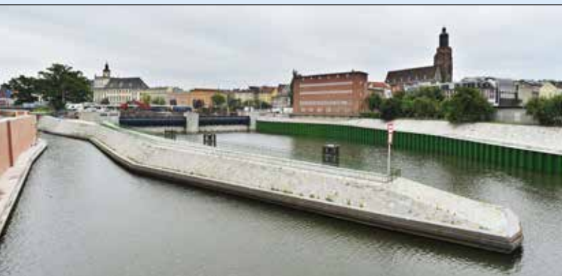
Pohled na nový jez s dělicí zdi od pravobřežní plavební komory, vpravo trvalá štětová stěna rybího přechodu
