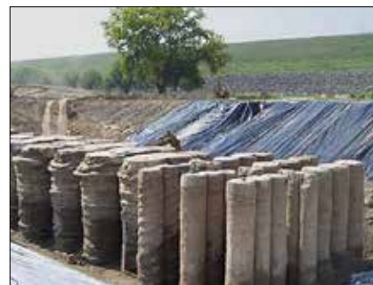
Obr. 13: Porovnání tvarů odkopaných výsledných elementů z trojfázové tryskové injektáže (vlevo) a z kombinace soil-mixingu s tryskovou injektáží systémem Trevi-Jet (vpravo) na zkušebním poli pro rekonstrukci přehrady Tuttle Creek v Kansasu v USA v roce 2007 (Treviicos)
