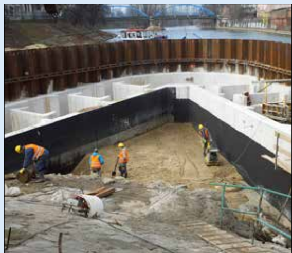
Betonáž rybího přechodu probíhala pod ochranou trvalé pažicí štětové stěny ze strany od řeky
