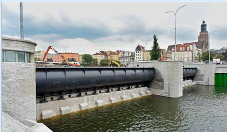
Pohledové části nového jezu byly provedeny z monolitického betonu do tvarovaných licích forem vytvořených speciálně pro tento účel
