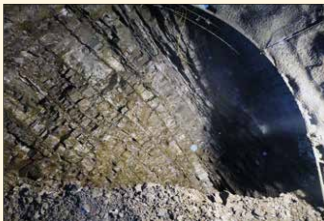
Pohled na čelbu kolektorové trasy po trhacích pracích v souvrství letenském (ordovik, beroun) tvořeném břidlicí s šedými křemennými pískovci až křemenci a polohami jílovitých slídnatých prachovců.
