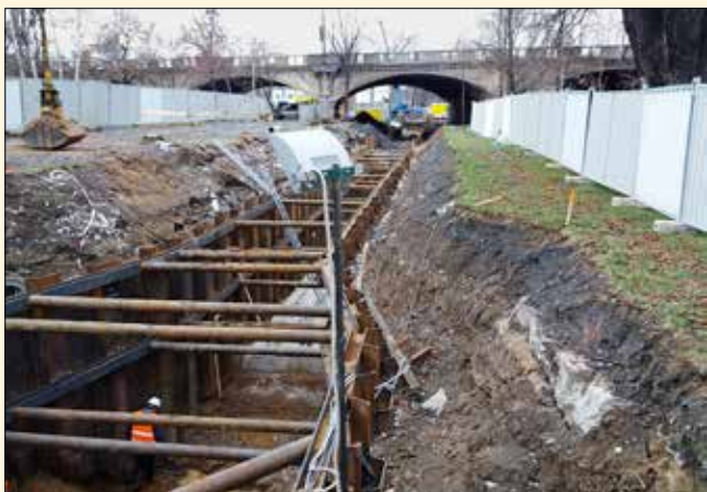
Hlubená odbočná větev kolektoru na ostrově Štvanici
