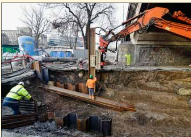
Instalace štětovnic odbočné větve kolektoru Hlávkova mostu ze šachty J103 na ostrově Štvanice pod klenbou mostu za použití beranidla s bočním úchopem MOVAX.
