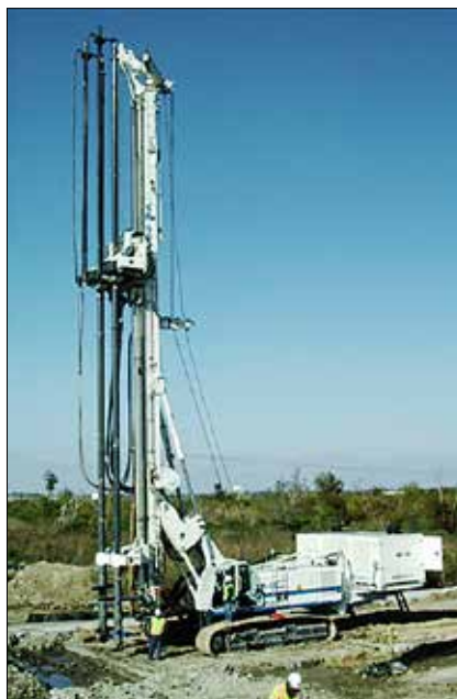
Obr. 12: Souprava Soilmec SR-90 s dvojitým vrtákem systému Trevi-Jet při práci na zpevnění protipovodňové hráze v New Orleans v USA v roce 2009. Byly prováděny elementy ze sloupů o průměru 1,6 m do hloubky 24,4 m (Treviicos).
