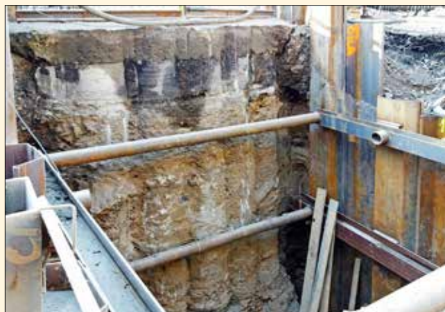
Napojení kolektorové větve na šachtu J103 zajištěnou převrtávanými pilotami
