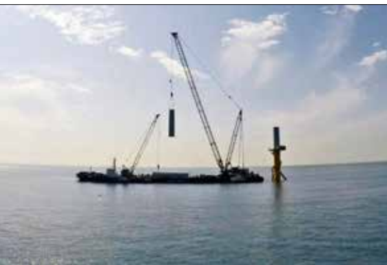
Vztyčování stožáru větrné turbíny
