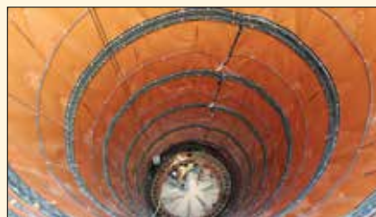
Spolupůsobení primárního a sekundárního ostění u šachet J102, J103 a J104 je zajištěno propojovacími kotevními prvky
