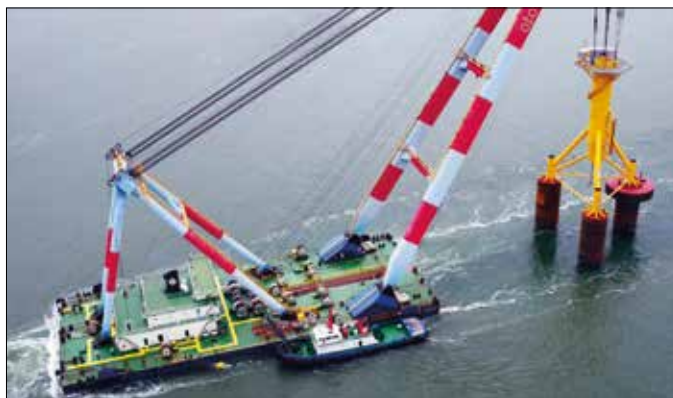
Umístování a instalace základů podtlakových kesonů
