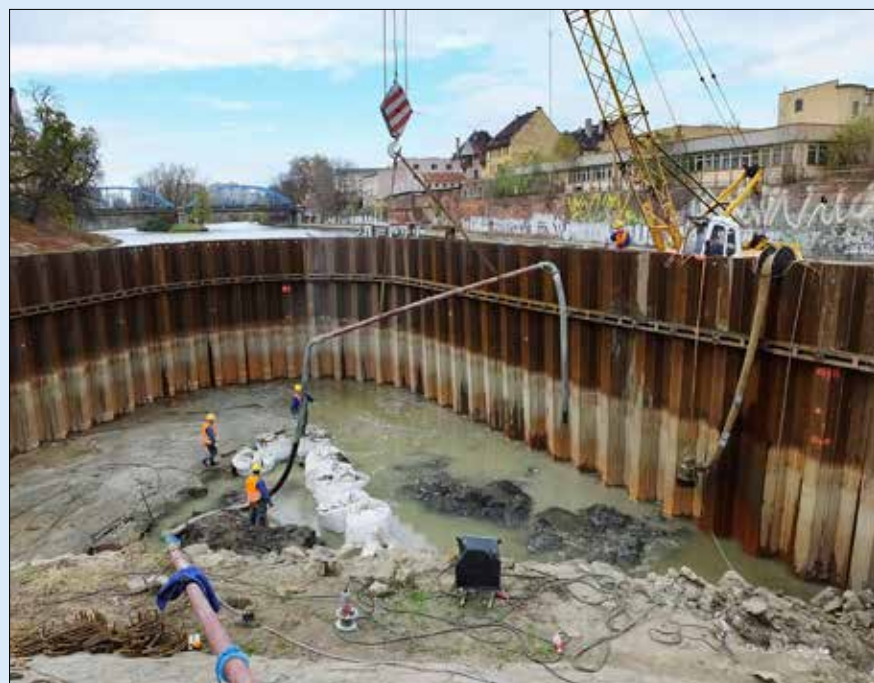
Betonáž dna ohybu dolní části rybího přechodu
