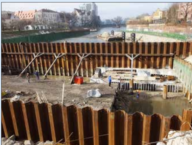
Jímka pro výstavbu nového jezu pažená částečně rozpíranými štětovými stěnami
