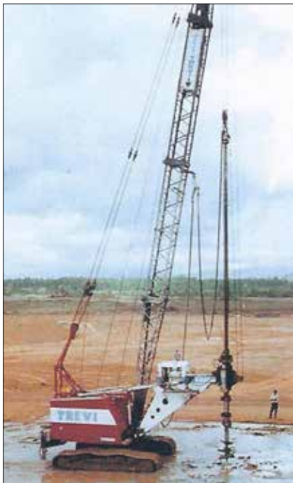
Obr. 6: Na stavbě Bang Saphan v Thajsku zvolila v roce 1992 firma Trevi pro dané podmínky písčitojilovitých náplavů „suchý“ způsob jednoduchého soil-mixingu metodou Trevi-Mix. Sloupy o průměru 100cm s hloubkami od 8 do 15,5 m prováděla upravená konvenční pilotovací souprava Soilmec RTS-3 s pevným rotačním stolem a křídlovým míchacím nástrojem (Trevi).
