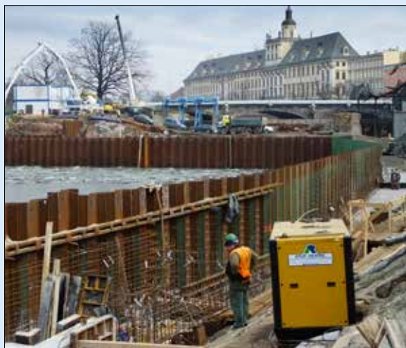
Betonáž rybího přechodu probíhala pod ochranou trvalé pažicí štětové stěny ze strany od řeky
