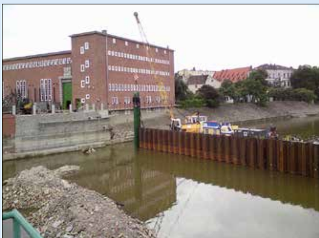
Beranění štětovnic jímky zajišťující výstavbu jezových polí, vlevo budova MVE
