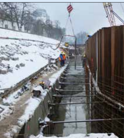
Sepnutí pažicích štětových stěn pro rybí přechod s nábrežní zdi pomocí táhel
