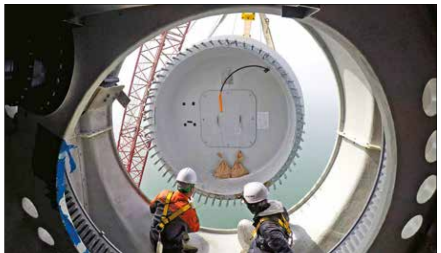
Osazení rotoru
