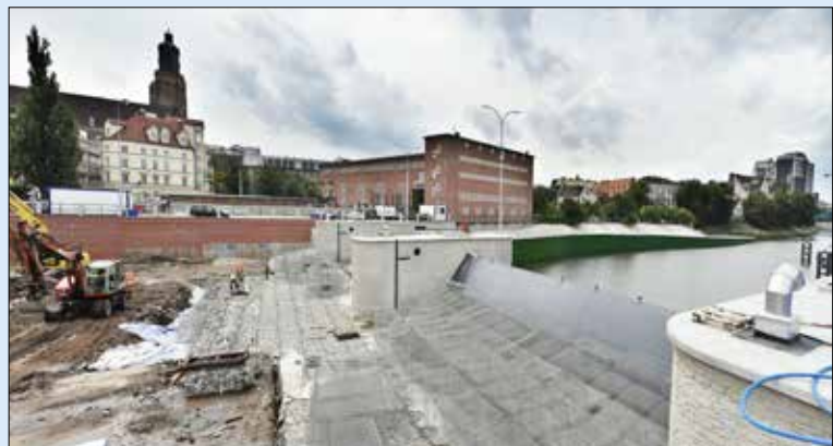
Ukládání gabiónů na dno v nadjezí
