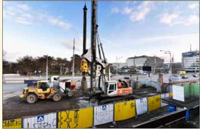
Realizace šachty z převrtávaných pilot J102 na ostrově Štvanici před bývalým zimním stadionem v těsném sousedství pražské magistrály.
