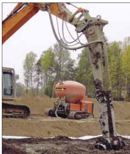
Obr. 11: Souprava finské firmy Allu s frézovou míchací hlavicí na výložníku hydraulického rypadla při provádění „suché“ metody v roce 2011
