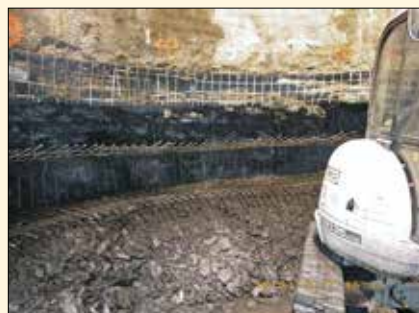
U šachty J101 je spolupůsobení primárního a definitivního ostění řešeno rozšiřujícím prstencem s vylamovací výtěží, která se následně propojí s definitivním ostěním
