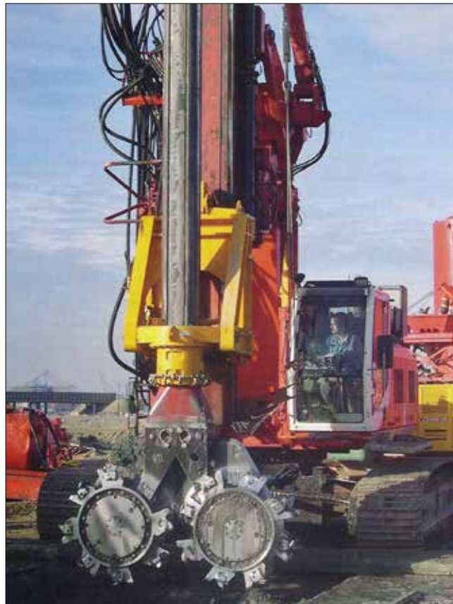
Obr. 9: Hydrofréza pro soil-mixing CMS na nosiči Bauer BG22 ve verzi s úpravami firmy Soletanche-Bachy pro elementy 2,4x0,5 m nebo 2,8x1,2 m v roce 2009 (Soletanche-Bachy)
