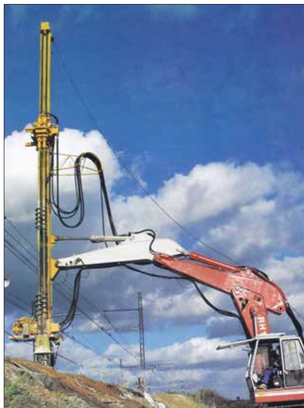
Obr. 5: Souprava systému Colmix firmy Bachy s dvěma protiběžnými spirálovými vrtáky pro soil-mixing o výsledné tloušťce tělesa podle parametrů režimu od 410 do 875 mm nasazená v roce 1987 na sanaci násypu rychlodráhy TGV ve Francii (Bachy)
