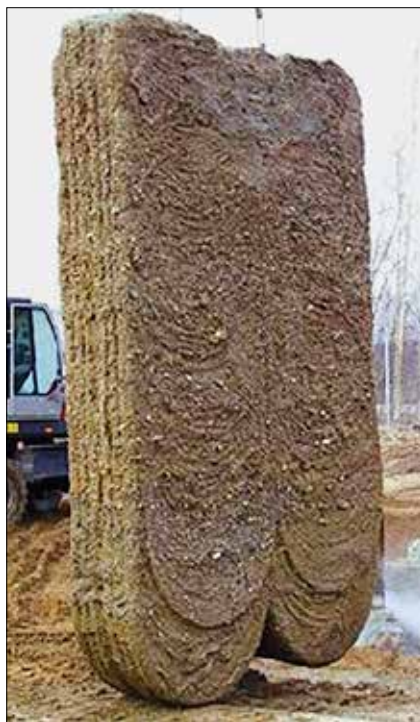
Obr. 10: Ukázka vytěženého vzorku elementu soil-mixingu zhotoveného hydrofrézou typu CSM na zkušebním poli firmy Bauer v roce 2009 (Bauer Spezialtiefbau)
