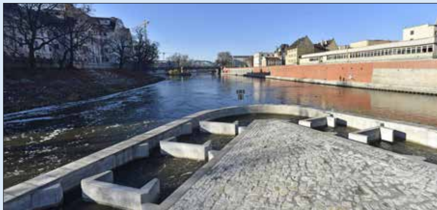
Ohyb dolní části rybího přechodu
