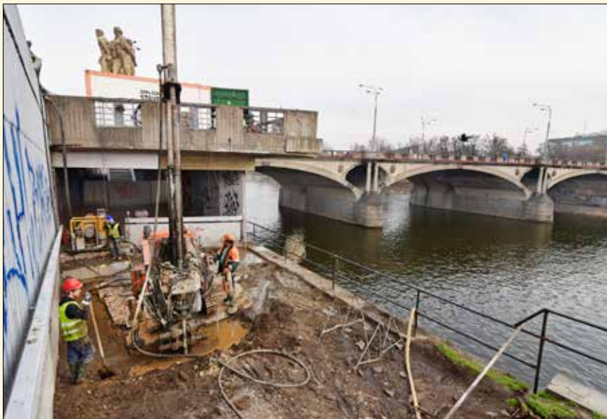
Provádění sloupů tryskové injektáže šachty J104 v nájezdu z nábřeží Kpt. Jaroše na Hlávkův most
