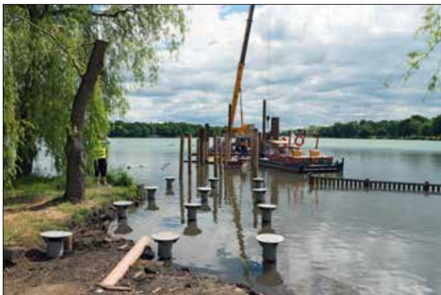
Na část zaberaněných pilot u břehu jsou již osazeny ocelové hlavice
