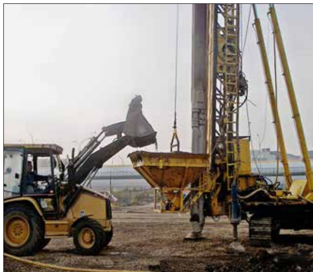
Obr. 5: Plnění skipu suchou betonovou směsí pro zhotovení betonových sloupových inkluzí technologií průchozího ponorného vibrátoru na pražské stavbě v roce 2002 (Keller)
