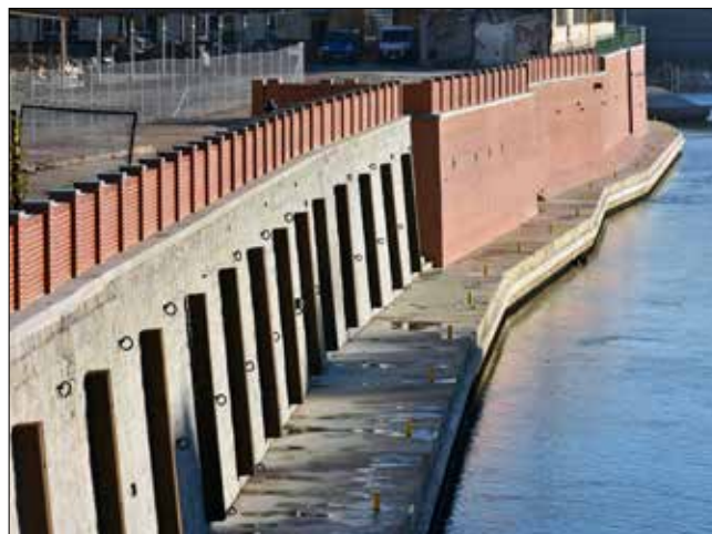
Opěrná nábrežní zeď dl. 460 m na pravém břehu u jezu Vratislav I; zde bylo kompletně vyměněno především lícové zdivo a upravena koruna zdi
