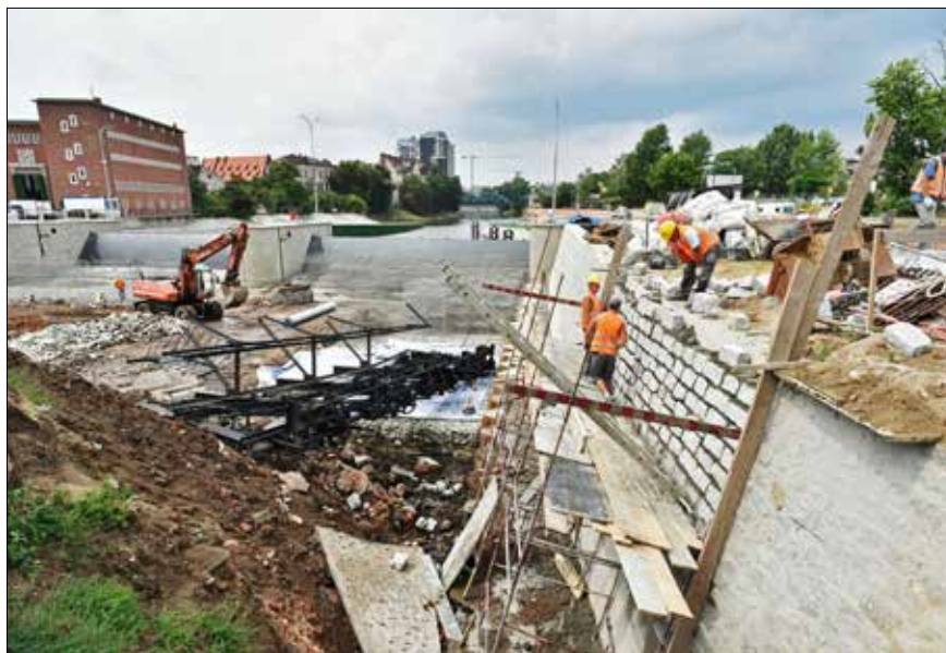
Opěrná nábrežní zeď nad jezem Vratislav I při obkládání žulovým kamenem
