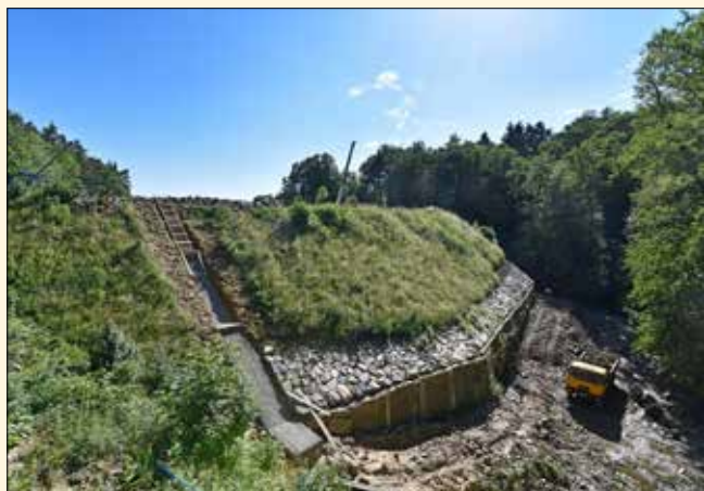
Pohled na vysokou hráz Velkého rybníka během stavebních prací
