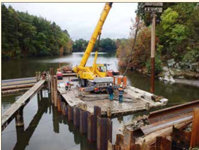
Beranění štětovnic stavební jímky
