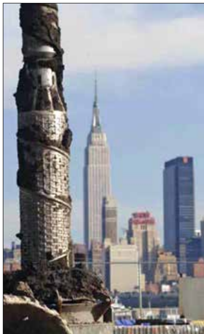
Obr. 2: Speciální roztlačovací vrták technologického systému původní metody CMC, použitý ve zvodnělých heterogenních násypech a měkkých organických jílech na stavbě rezidenčního komplexu v New Yorku (USA) v roce 2004 do hloubky 30 m (Soletanche Freyssinet/Ménard)
