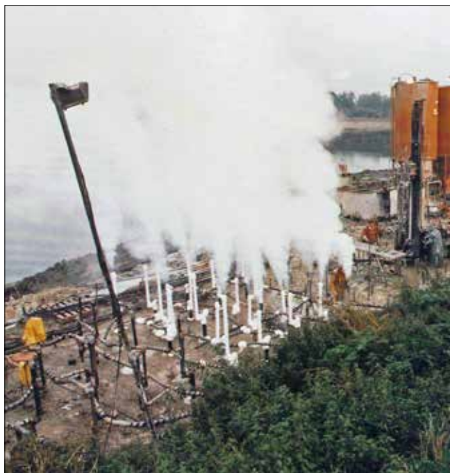
Obr. 9: Pracoviště zmrazování tekutým dusíkem do hloubky 30m na stavbě vodního tunelového přivaděče Iver o průměru 2,54m v Buckinghamshire ve Spojeném království v roce 1985. Je patrné volné odvětrávání vrtů (Stent Foundations).
