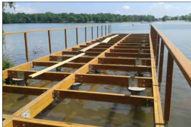
Rámová konstrukce pro pokládku paluby mola
