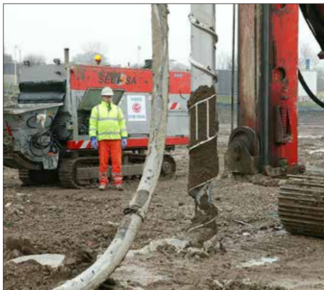
Obr. 4: Typická technologická sestava robustního zařízení k provádění sloupových inkluzí CMC z čerpané betonové malty v roce 2010 (Vibro Menard)
