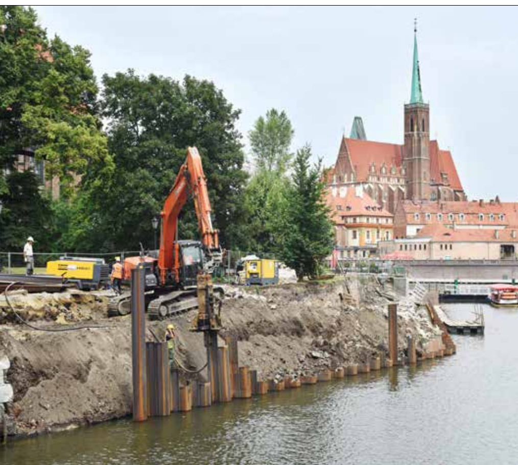
Beranění štětové jímky pro pažení stavební jámy pro výstavbu nové nábrežní zdi na ostrově Piasek
