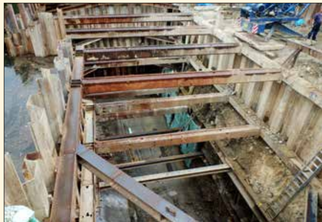
Jímka po dokončení těžby na úrovni základové spáry a položení základových betonů
