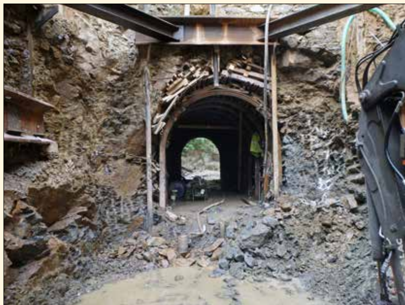
Pohled do nově vyražené štol výpustí ze zapažené jímky
