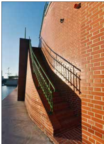
Detailní pohled na schodiště nově opravené nábřeží zdi dl. 460 m na pravém břehu u jezu Vratislav I
