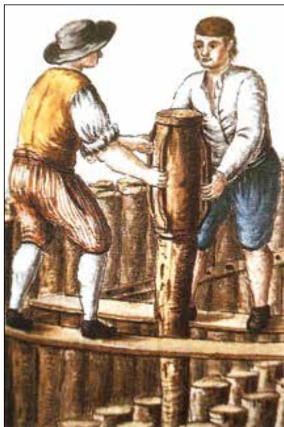
Obr. 1: Lehké ruční beranění relativně krátkých dřevěných pilot ve velmi těsných roztečích v základovém prostředí nekonsolidovaných mořských náplavů v Benátkách v 18. století (internet)
