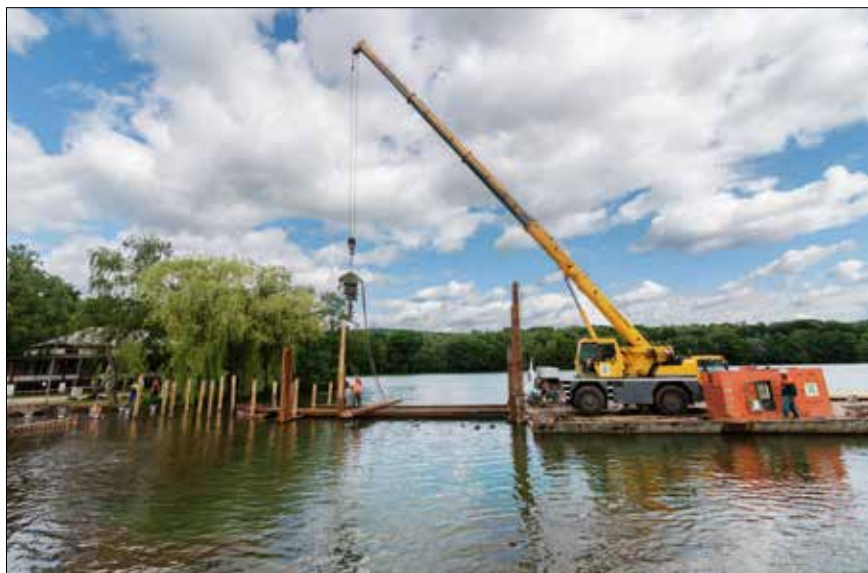
Beranění dubových pilot pevného mola z pontonového souloží
