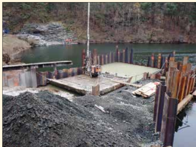
Provádění tryskové injektáže pro utěsnění pat štětovnic jímky
