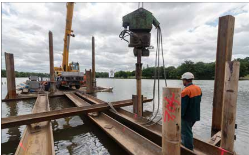
Beranění dřevěných pilot s osazenou pomocnou konstrukcí
