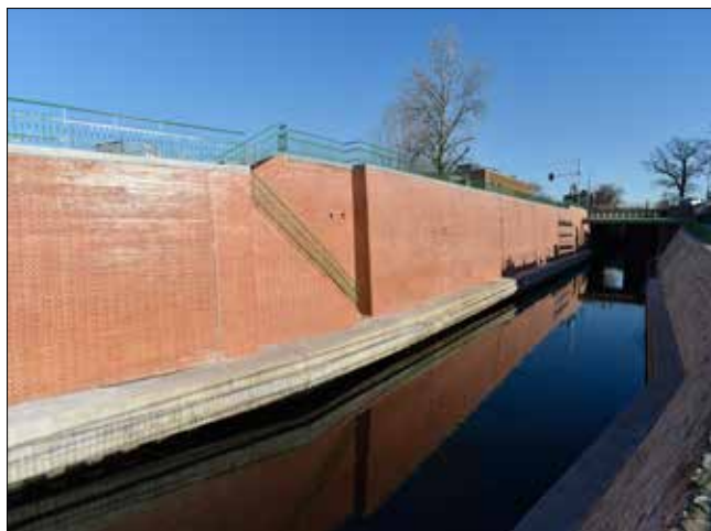
Opěrná nábrežní zeď dl. 460 m na pravém břehu u jezu Vratislav I; zde bylo kompletně vyměněno především lícové zdivo a upravena koruna zdi
