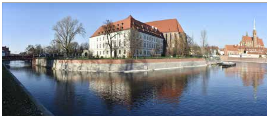
Nová nábrežní zeď s kamenným a kabřincovým obkladem skvěle zapadá do historického prostředí starého města
