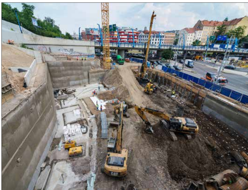
Dokončování pilotážských prací a betonáž základové desky v severní části jámy
