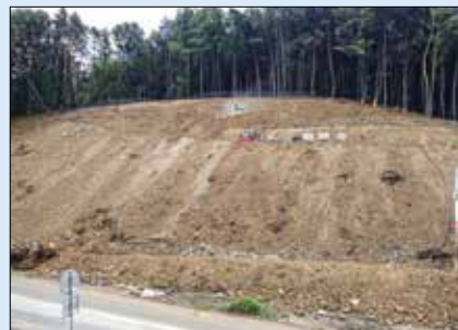
Svah pred západným portálom pred začiatkom zaistenia
