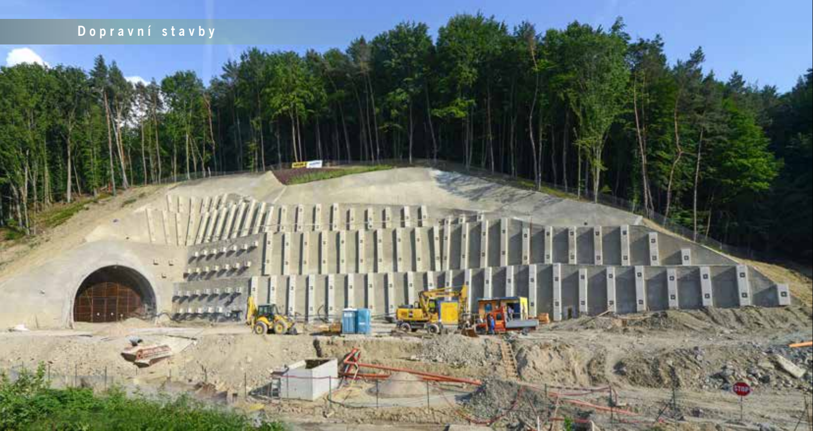
Pohľad na západný portál
