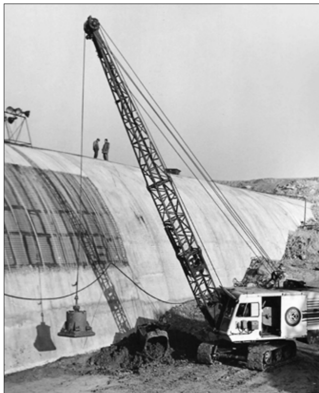
Obr. 7: Hutnění sprašovitých hlín deskou v místě křížení štol s těsnicí clonou na stavbě vodního díla Nechanice v roce 1967 (Vodní stavby)
