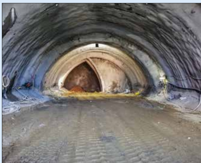
Pohled na čelbu z východního portálu v technologické třídě VI členěnou na dvě kaple
