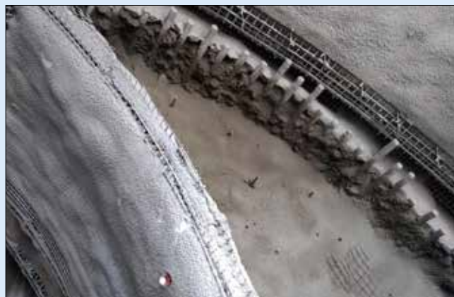
Viditeľná časť mikropilótového dáždnika zabezpečujúceho rozrážku na východnom portáli
