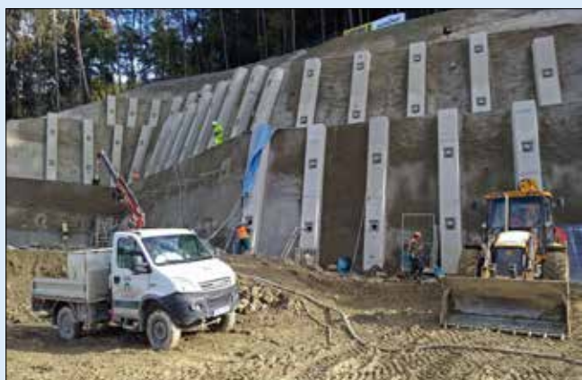
Práce na zabezpečení pravej steny západného portálového úseku a realizácia mikropilotového dáždnika na portálovej stene
