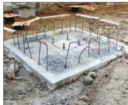
Základová patka, v pozadí PC-CIDH piloty s tahovou hlavou
