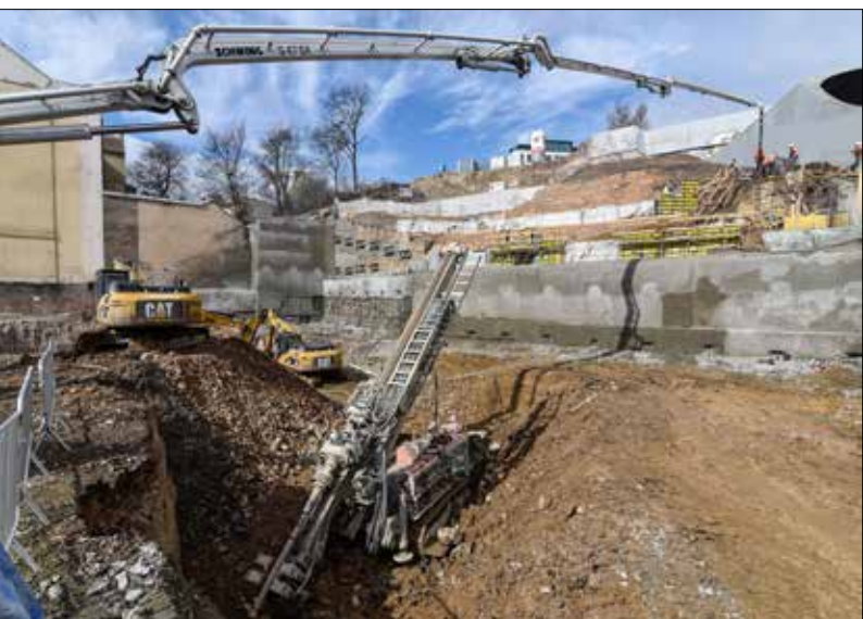
Kotvení záporového pažení jižní stěny a betonáž opěrných stěn
