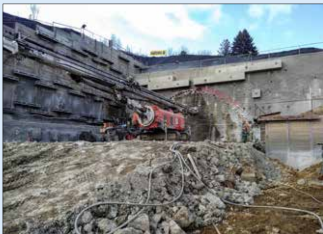
Vykonávanie tryskovej injektáže na východnom portáli vrtnou súpravou PG 185
