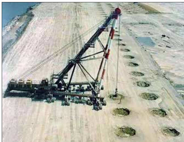
Obr. 8: Ménardova souprava pro dynamické hutnění/konsolidaci s pěchem o tíže 170 t a výšce pádu 22 m na stavbě dráhy letiště v Nice v roce 1978 (Ménard).
