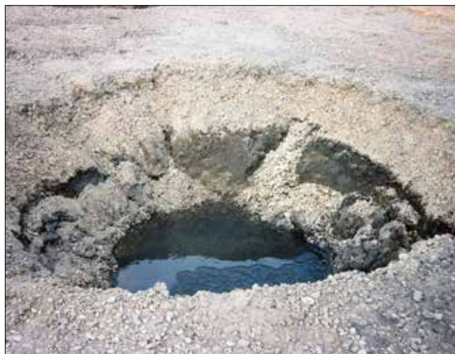
Obr. 10: Vtisk do povrchu skládky Spolany Neratovice po prvním dynamickém rázu pěchu v místě nejvíce oslabené zóny základového prostředí s kalovými odpady (Soletanche ČR)
