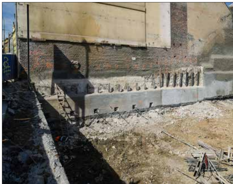
Západní strana stavební jámy s kotvenými sloupy tryskové injektáže
