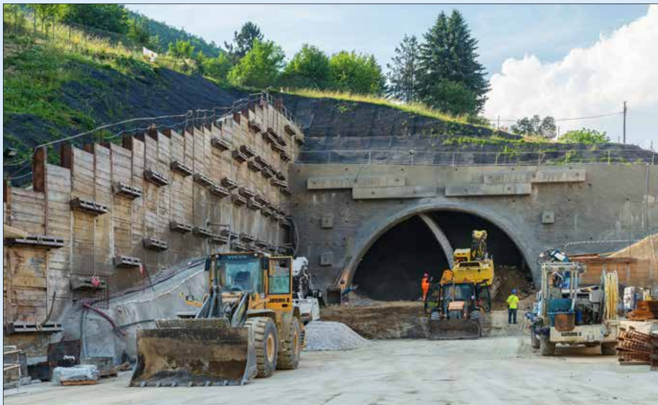
Pohľad na východný portál
