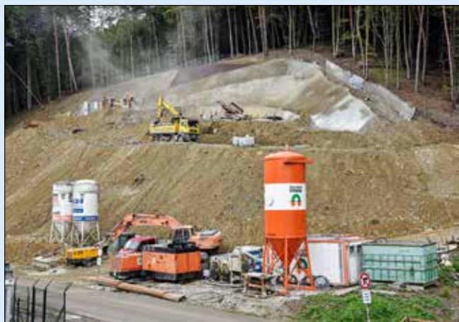
Práce na portálového úseka počas zabezpečení jeho najvyšších úrovní
