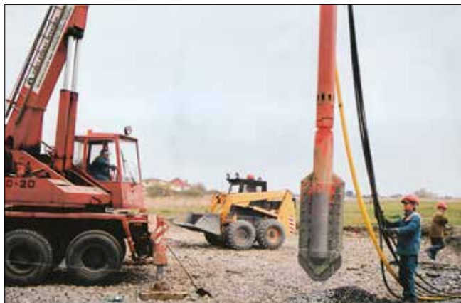
Obr. 5: Použití hydraulického ponorného vibrátoru na stavbě Nedakonice v roce 2001 (Zakládání staveb, a. s.)
