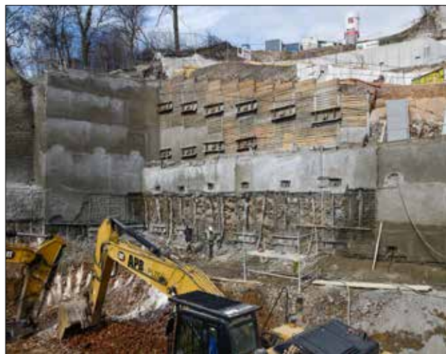
Pažení severozápadního rohu stavební jámy
