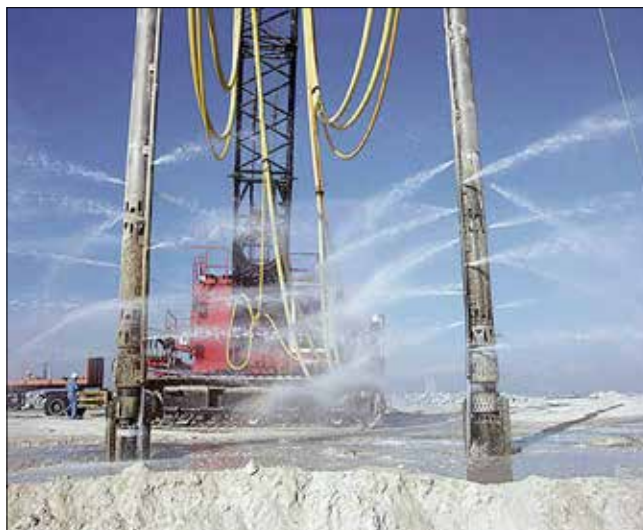
Obr. 4: Souprava dvojitých elektrických vibroflotů z flotily 16 vysoce výkonných vibroflotačních zařízení, nasazených v roce 2007 na vibrohutnění umělého poloostrova dubajského Palm Project do hloubky 15 m, při zkoušce výplachových trysek (Soletanche-Bachy/Vibroflotation Group)
