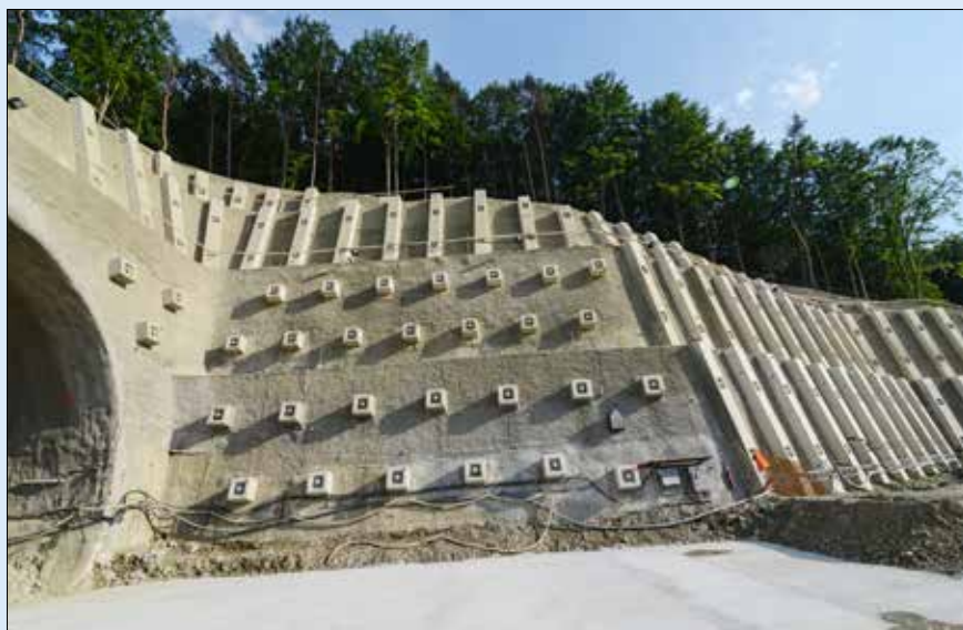
Pohľad na pravú stenu západného portálového úseku zaistenú kotvenými rebrami a pätkami
