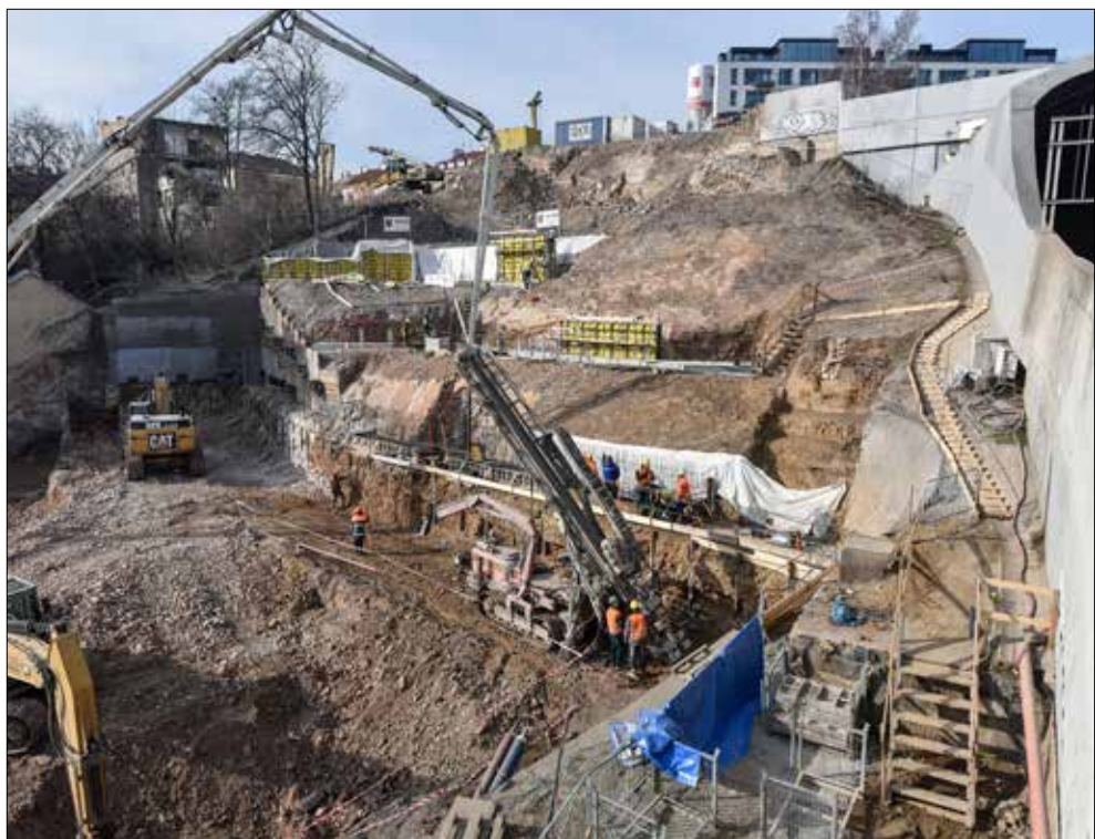
Realizace 2. k. ú. na mikrozáporovém pažení severní stěny a betonáž opěrných stěn
