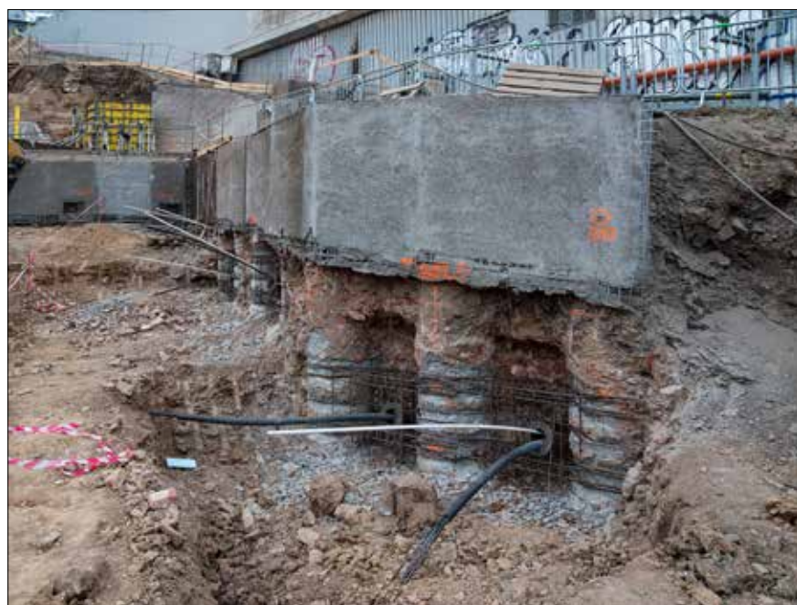
Kotvená pilotová stěna na východní straně jámy
