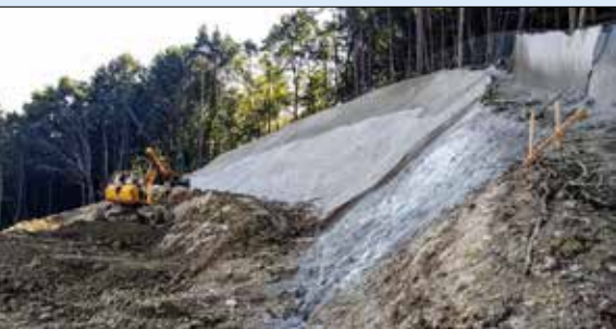
Úprava najvyššieho miesta západného portálového úseku striekaným betónom
