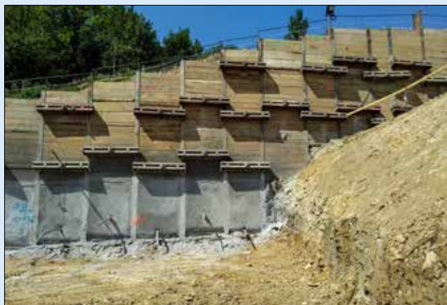
Záporové paženie na pravej stene východného portálového úseku
