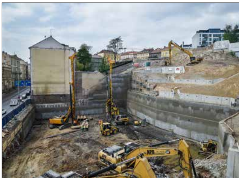
Provádění pilotového založení
