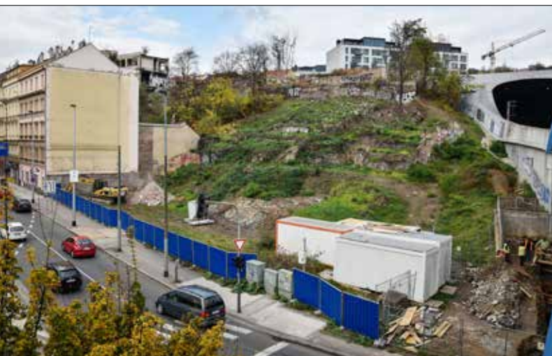
Pohled na parcelu před zahájením stavebních prací
