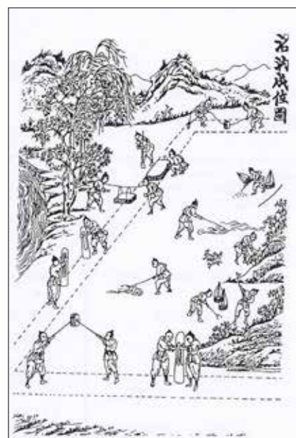
Obr. 2: Příprava staveniště s různými postupy zhutňování podkladu pro základy po předepsaných tenkých vrstvách s prolohami zrnitého materiálu, podle předpisu z doby čínské dynastie Sung v roce 1103 (J. Kérisel, ISSMFE)
