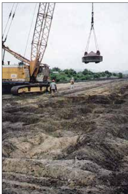
Obr. 9: Dynamické hutnění/konsolidace pro úpravu skládky Spolany Neratovice v roce 1994. Pěch o tíže 15 t a s výškou pádu 20 m působil na vrstvu různorodých odpadů o mocnosti 7,5 m. Závěrečná vyrovnávací fáze prací (Soletanche ČR).
