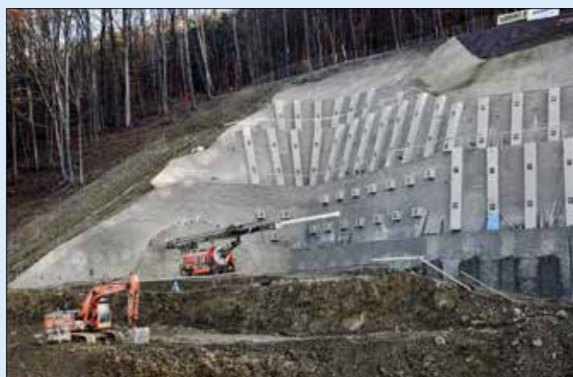
Práce na zabezpečení pravej steny západného portálového úseku a realizácia mikropilotového dáždnika na portálovej stene
