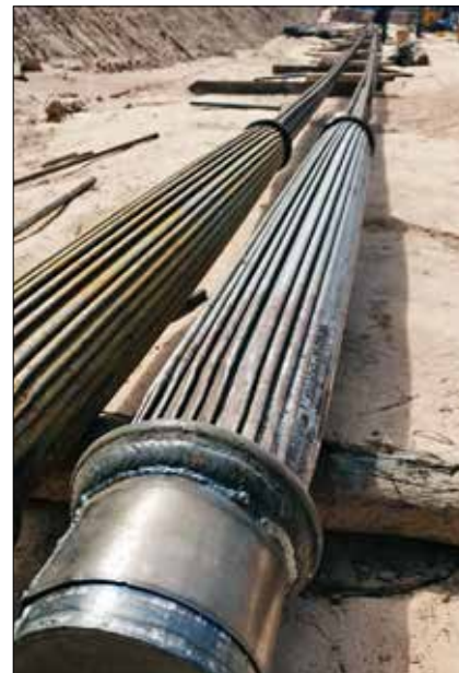
EB piloty před instalací
