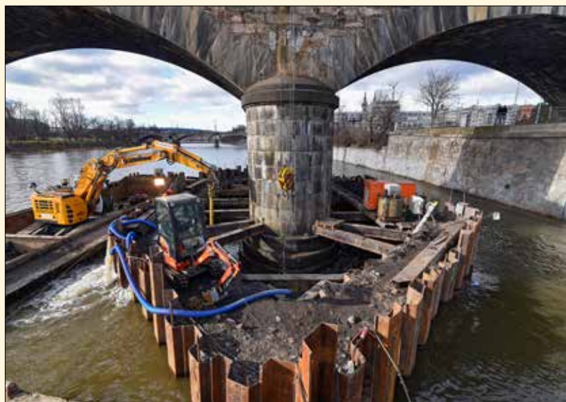
Odtěžování okolí pilíře P4 pod ochranou dvojité jímky, SO 14-14
