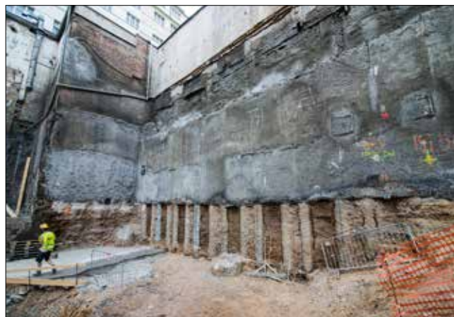
Kotvená pilotová stěna podél objektu Divadlo Palace
