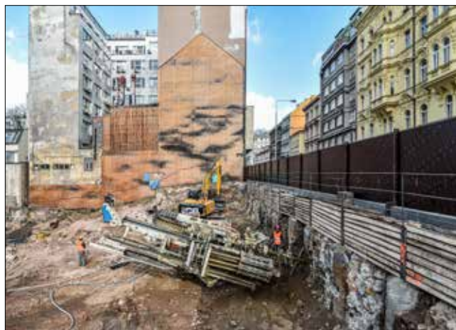
Hloubení vrtů pro kotvy podél ulice Opletalova
