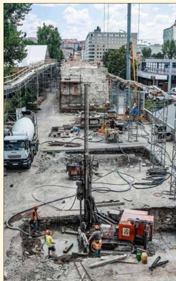
Provádění sloupů tryskové injektáže pro založení nově budovaných mostních pilířů a oblouků na ostrově Štvanice, SO 14-13
