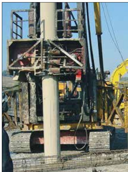
Obr. 8: Vibrační odpažovací objímka legendární světově rozšířené soupravy Fundex F12 pro piloty typu Vibrex na stavbě v Polsku v 90. letech 20. stol. ( www.enerGOPOL.pl )
