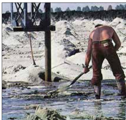
Obr. 2: Instalační vrt pro pískový dren zhotovený vplachováním v roce 1955 na stavbě komplexu námořních bariér pro ochranu vnitrozemí v Nizozemsku. Výplň pískem byla prováděna ručně z předem připravených hromad materiálu (XI. ICSMFE, 1985).
