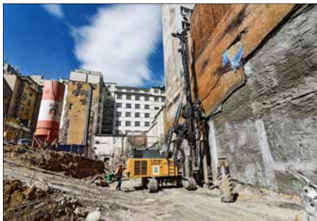
Provádění pažicí pilotové stěny podél objektu ČTK
