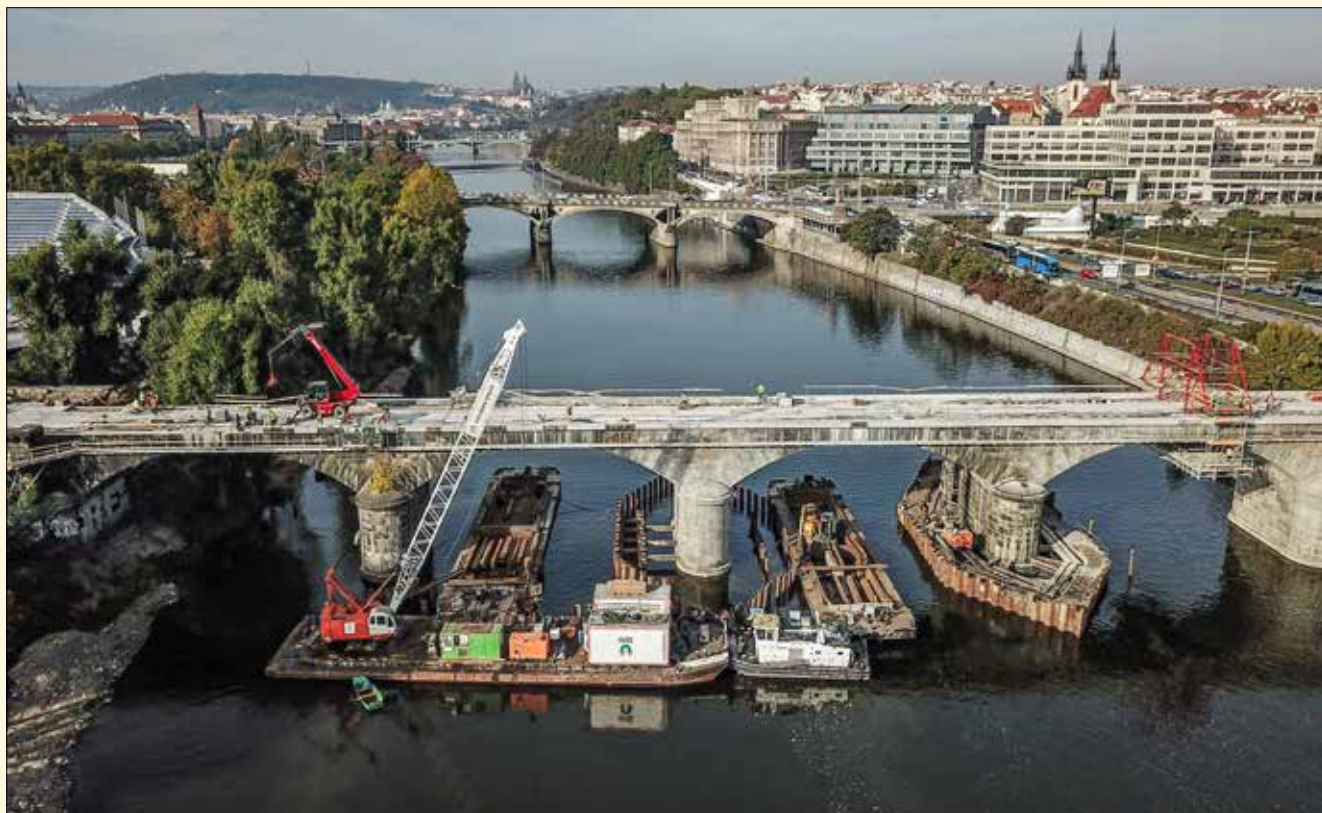
Probíhající sanační práce na pilíři P3 a rozebírání jímky na již sanovaném pilíři P2, SO 14-14
