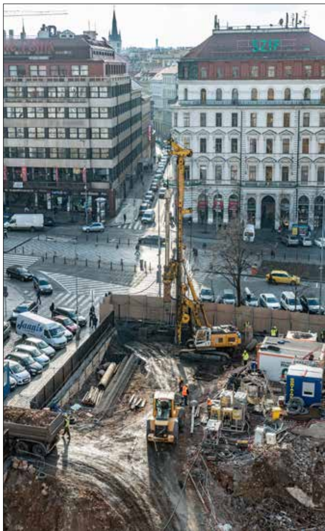
Provádění pilotové stěny podél Václavského náměstí
