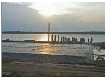
Obr. 4: Vakuová konsolidace na stavbě kontejnerového terminálu Gemalink na řece Cai Mep v jižním Vietnamu v roce 2010. Zlepšení vlastností měkkých jílu na ploše 600x60 m do hloubky 36 m prováděla firma Ménard (Ménard Group).
