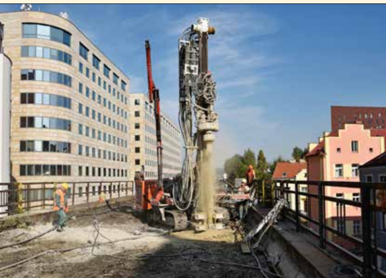
Hloubení vrtů pro nízkotlakou injektáž dřívků pilířů, SO 14-10
