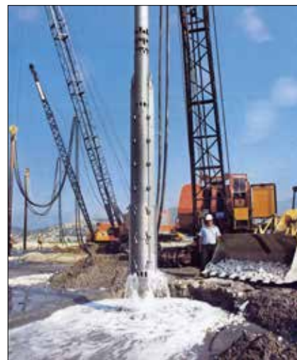
Obr. 10: Mokrá způsob zřizování štěrkových pilířů ponorným vibrátorem na stavbě rozsáhlého bytového komplexu Al Khobar v Saudské Arábii koncem 70. let. Tuto úpravu vyžadovalo písčité souvrství podzákladí o hloubce 4 až 8 m, které obsahovalo nezhutnitelné čočky siltů (Keller).
