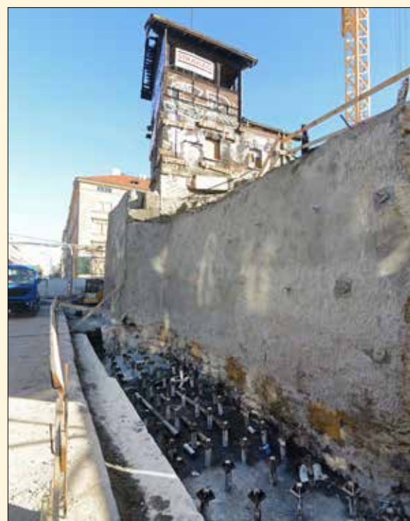
Mikropilotové založení nové opěry mostu přes Křížkovu ulici, SO 07
