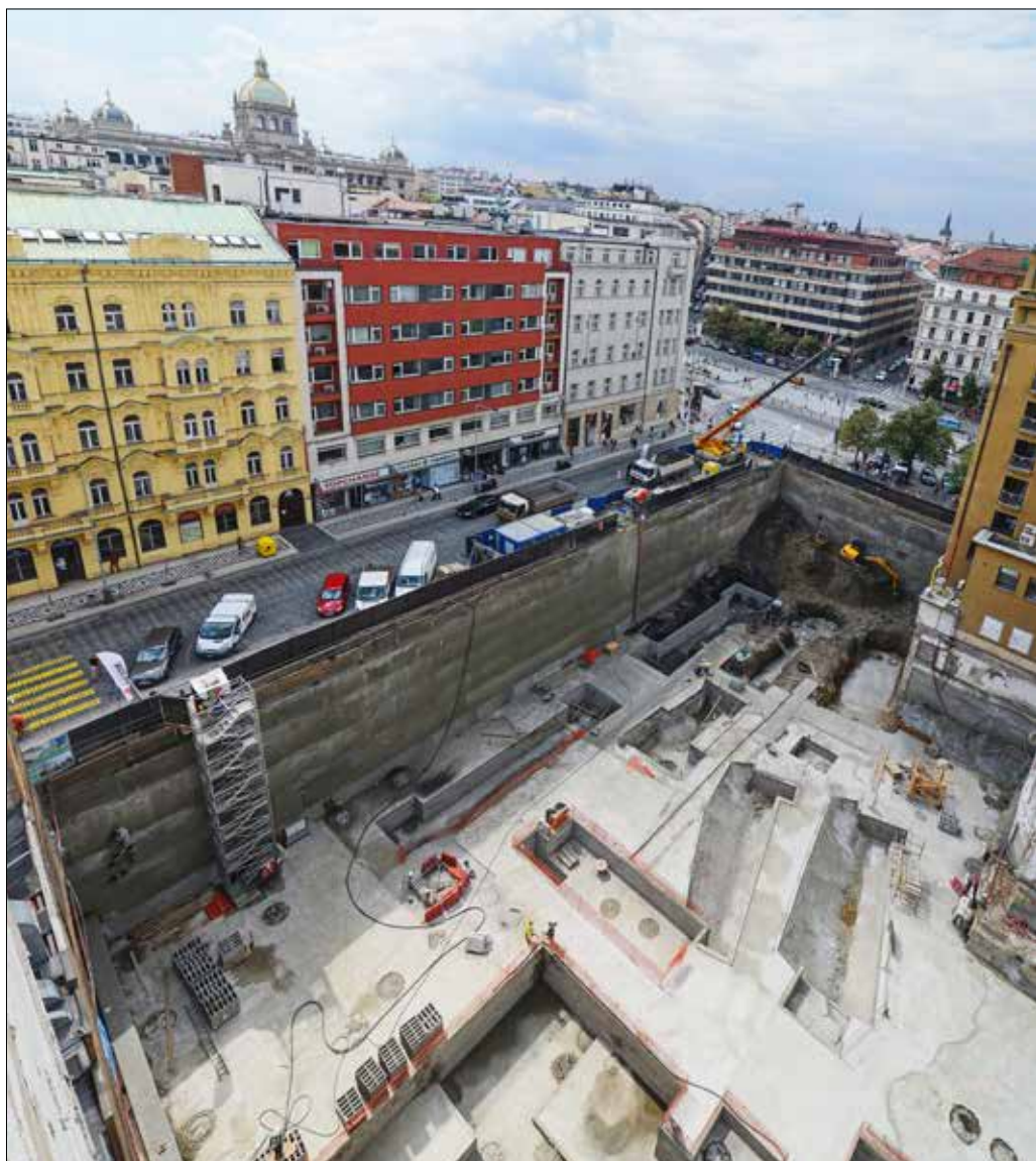
Pohled na zajištěnou stavební jámu i s dokončeným pilotovým založením, pohled z budovy ČTK směrem k horní části Václavského náměstí přes Opletalovu ulici
