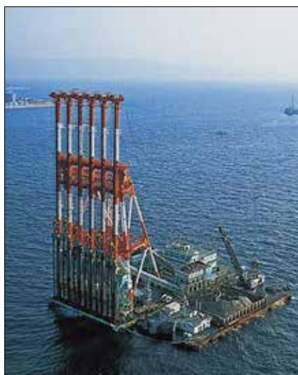
Obr. 1: Jedna z flotily několika obřích plovoucích souprav s baterií vibračně zaražených ocelových výpažnic se ztracenou botkou, použitých koncem 80. let 20. stol. na projektu letiště Kansai u japonské Ósaky. Pískové drény o průměru 40 cm byly zřizovány do hloubky 20 m pod mořské dno při hloubce vody 30 m. (Wakachiki)
