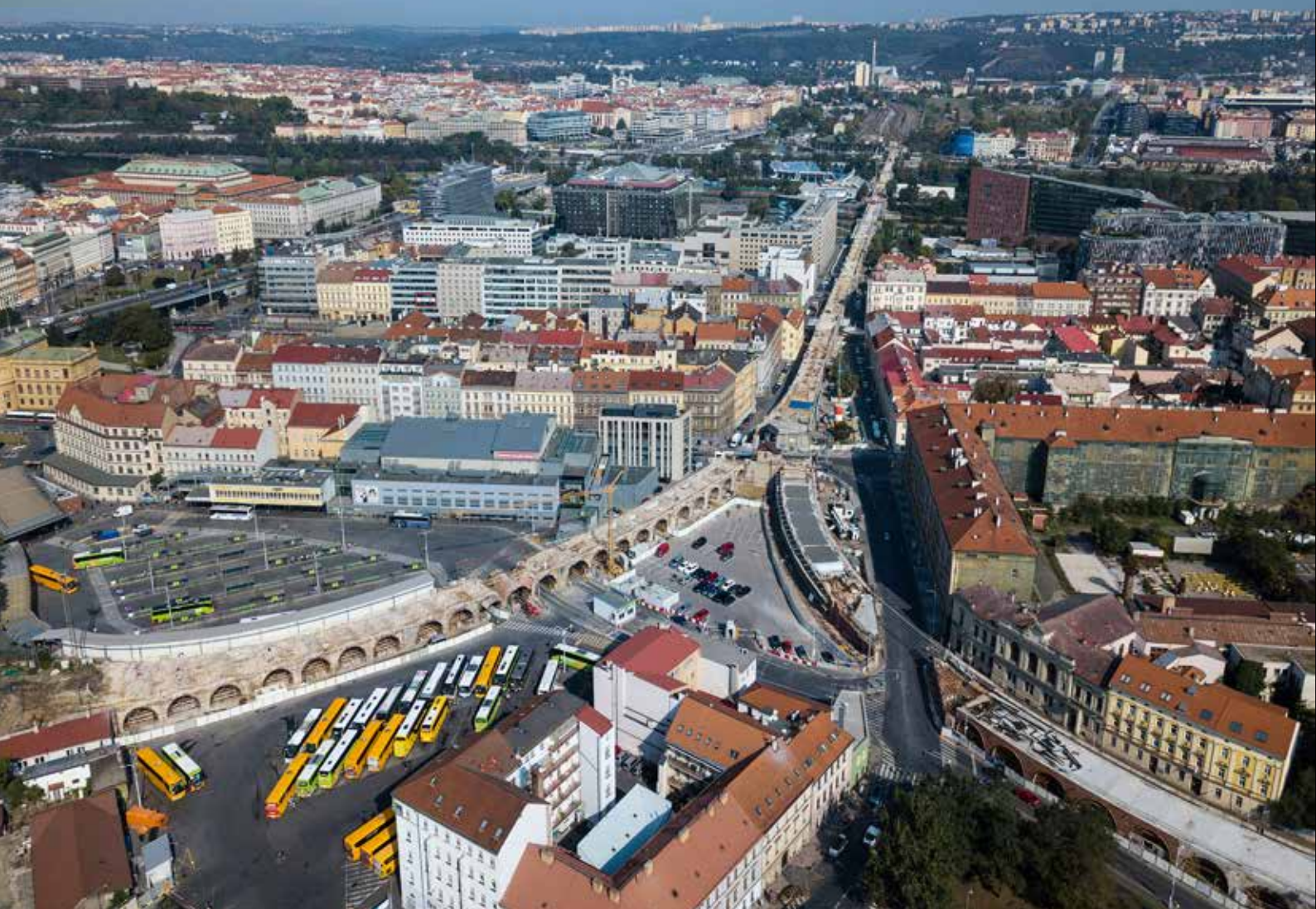
Negrelliho viadukt během rekonstrukce, pohled k severozápadu
