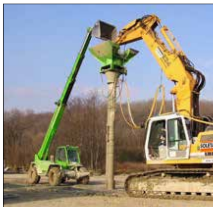
Obr. 12: Přídavný hydraulický průchozí ponorný vibrátor zvaný „stitcher“, nasazený na konvenční hydraulické rypadlo, při provádění štěrkových sloupů o hl. 4–6 m pro zlepšení jílovitého podzákladí pod násypem opěry mostu na stavbě dálnice D8 v roce 2004 (Soletanche ČR)
