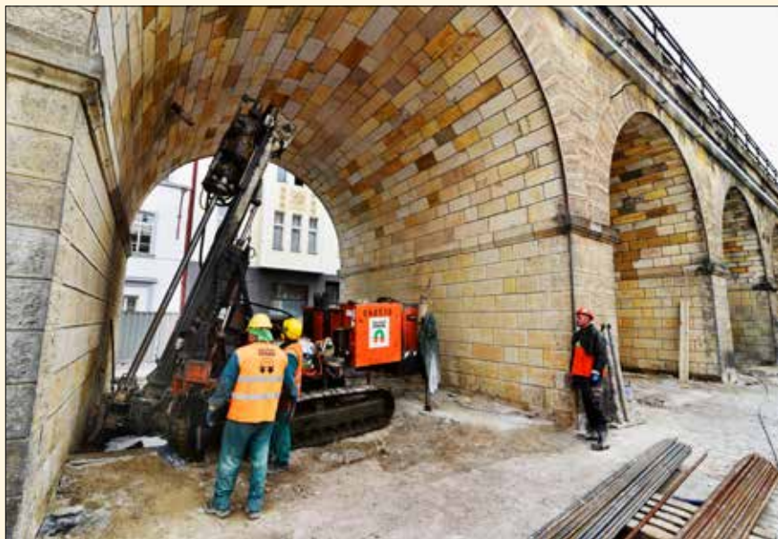
Realizace sloupů tryskové injektáže v podzákladí pilířů, SO 14-08
