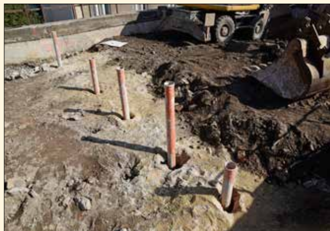
Vrtů pro nízkotlakou injektáž v ose pilíře s osazenými PVC průchodkami, SO 14-10
