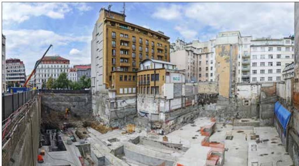
Pohledy na zajištěnou stavební jámu před kompletním dotěžením a dokončením složitě tvarovaných podkladních betonů
