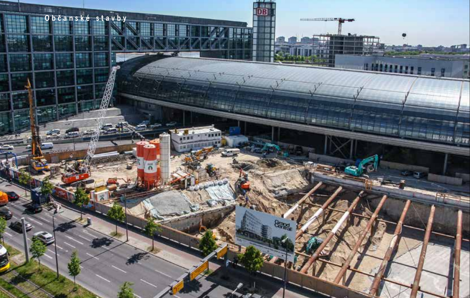
Stavební jámy pro objekty MK1 a MK2 v těsném sousedství berlínského hlavního nádraží
