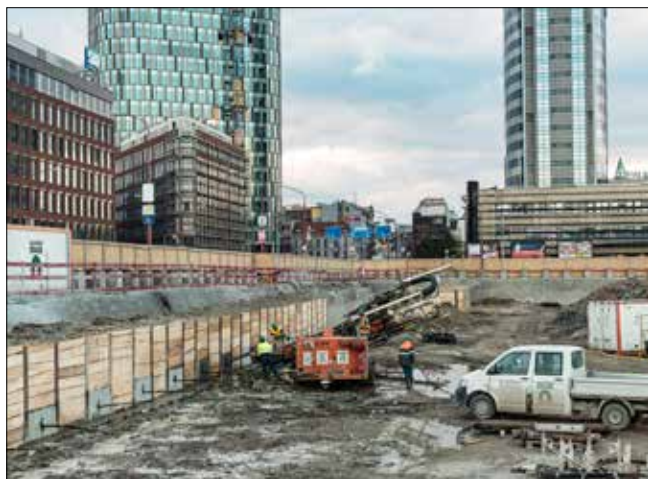
Vykonávanie dočasných kotiev na 0. kotevnej úrovni (južná strana stavebnej jamy) vrtnou súpravou Klemm 807
