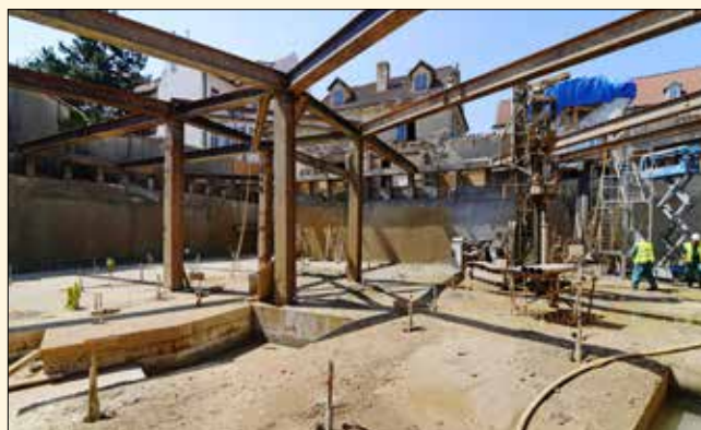
Provádění tahových mikropilot z úrovně podkladních betonů
