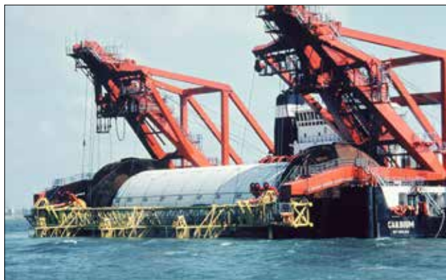
Obr. 6: Podmořské ukládání prefabrikované roznášecí a filtrační matrace do hloubky 30 m speciální lodí Cardium při výstavbě bariéry Oesterschelde v Nizozemí na počátku 80. let. (watersnoodmuseum.nl)
