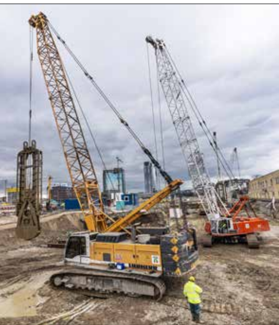
Stroje pre ťažbu podzemných stien a osadenie výstužných panelov
