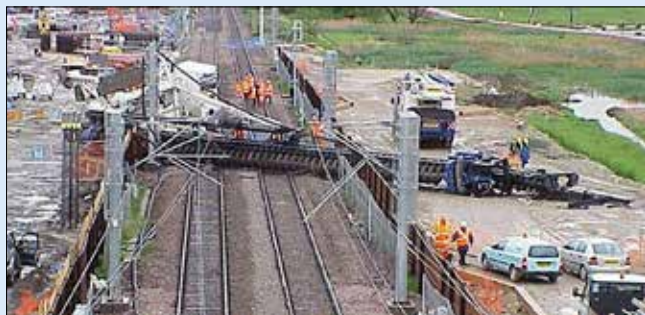
Obr. 2: Mimořádně závažná nehoda pilotovací soupravy, která se převrátila na kolejisť, kudy před pár minutami projel plně obsazený osobní rychlovlak do Londýna
