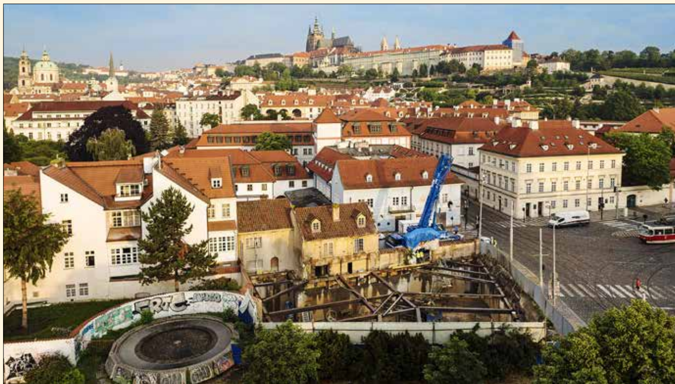
Dokončená a rozepřená stavební jáma připravená pro následnou vestavbu
