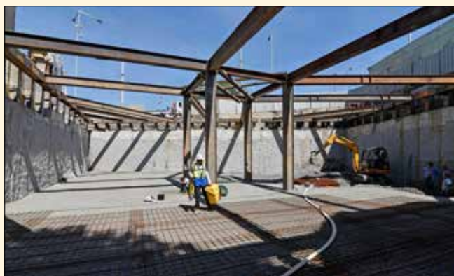
Zajištěná stavební jáma s ofrézovaným lícem podzemních stěn
