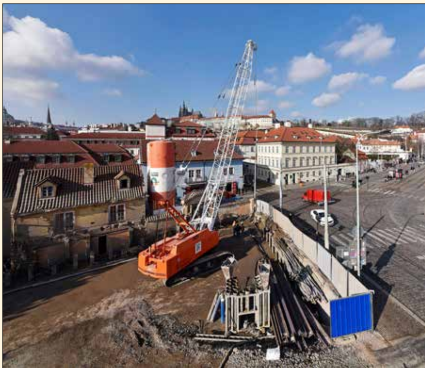
Provádění podzemních stěn
