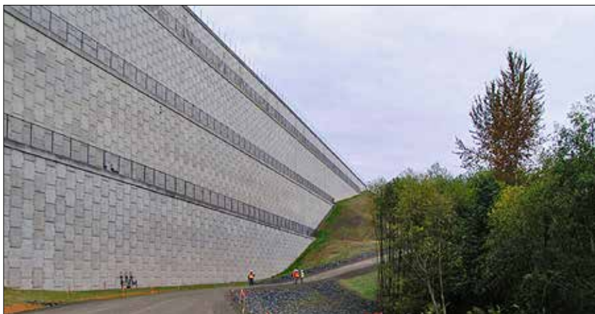
Obr. 10: Tříkrát odstupňovaná mechanicky vyztužená zemní konstrukce se svislým lícem o celkové výšce 45 m vybudovaná pro zajištění přístavací dráhy letiště Tacoma v Seattlu v roce 2005 (hartcrowser.com)
