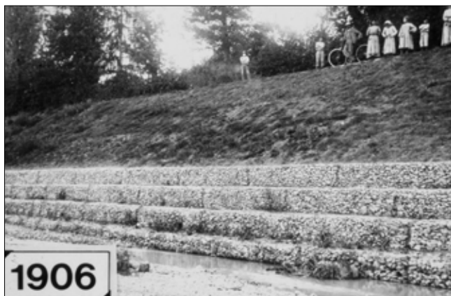
Obr. 2: Jedna z prvních aplikací drátošterkových konstrukcí pro historické opevnění z roku 1906 v Itálii (maccaferri.sk)
