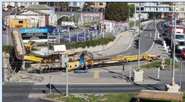
Obr. 3: Tuzemský případ nehody pilotovací soupravy
