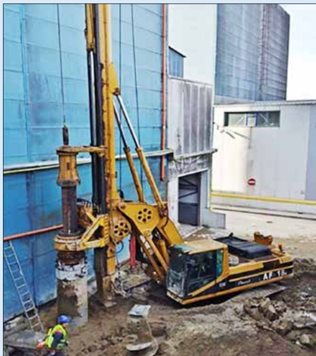
Obr. 4: Velmi častá situace na staveništi speciálního zakládání bez zajištění správných pracovních podmínek prováděcí plochy
