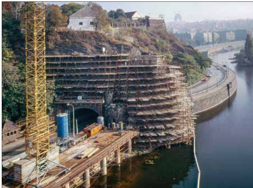
Obr. 13: Rozsáhlé zpevnění masivu vyšehradské skály lanovými kotvami a dalšími kotevními prostředky prováděné z těžkého lešení v letech 1991–1992 firmou Zakládání staveb, a. s. (archiv Zakládání staveb, a. s.)
