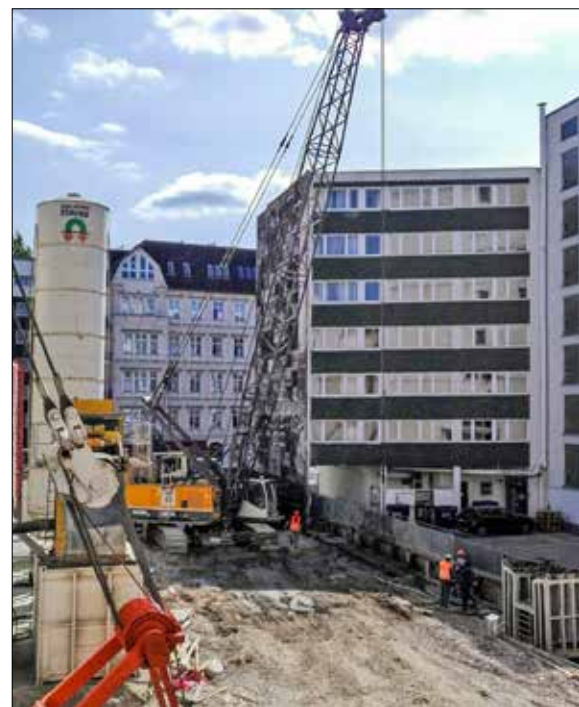
Provádění podzemních stěn pro Ku'Damm Karee
