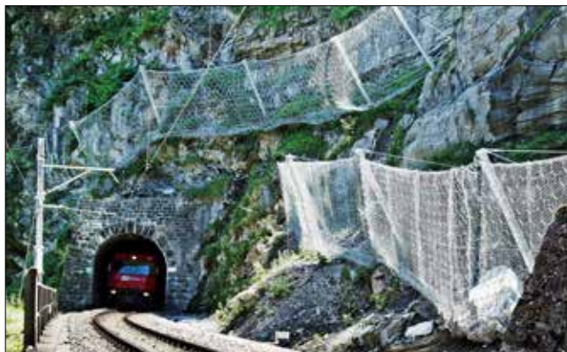
Obr. 12: Záchytný systém RXE-1000 švýcarské firmy Geobrugg vybudovaný v roce 2014 na železniční trati u Rumplanus ve Švýcarsku (geobrugg.com)
