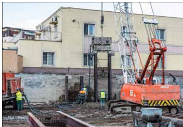
Osazovanie výstužných panelov z IPE profilov
