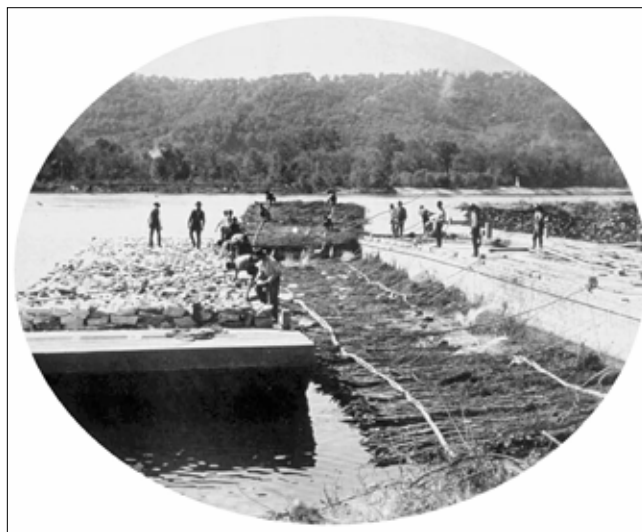
Obr. 5: Opevnění regulační hráze koryta řeky Mississippi v USA proutěnými maticemi a kamenným záhozem v roce 1890 (www.cincinnatiilibrary.org)
