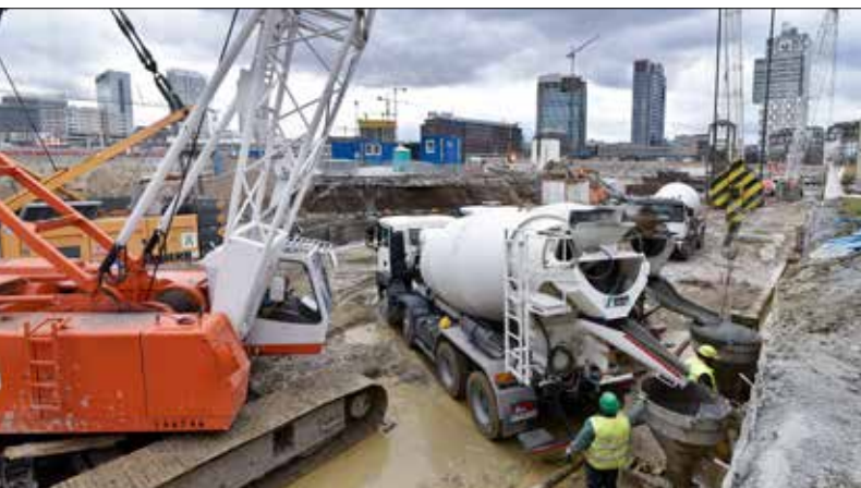
Betonáž lamiel podzemnej steny
