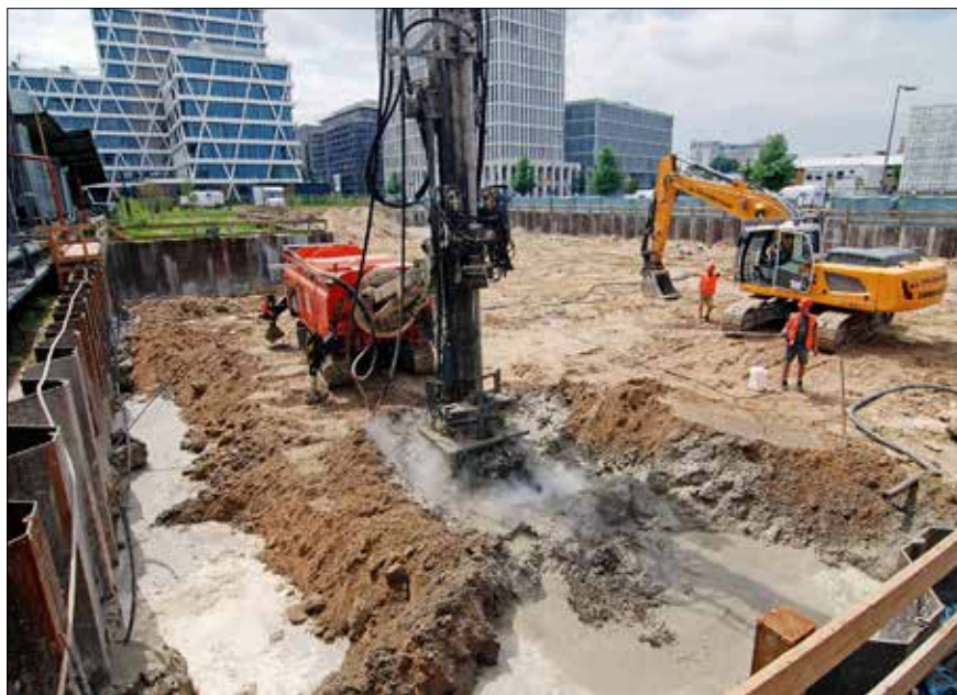
Vytváření horizontálního monobloku z tryskové injektáže pro těsnění stavební jámy administrativní budovy Rieck 1
