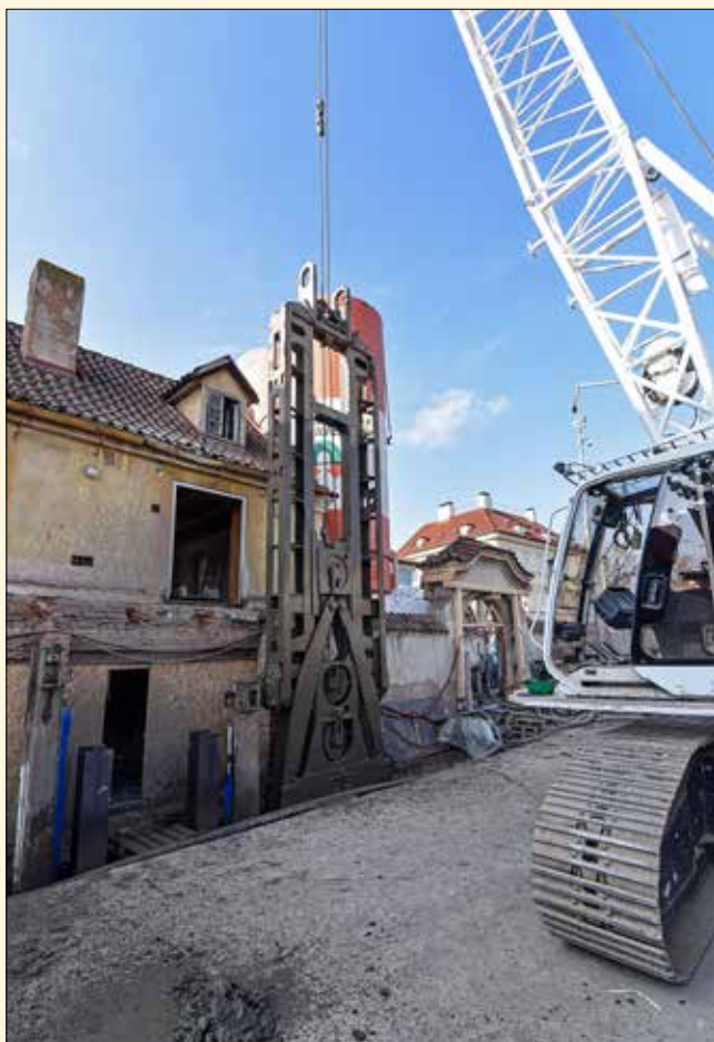
Těžba lamely podzemní stěny v těsné blízkosti domu č. p. 116
