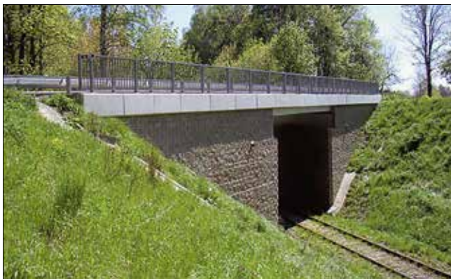
Obr.11: Mostní opěry z vyztužené zeminy pro železniční nadjezd u Královce zbudované v roce 2004 (geomat.cz)
