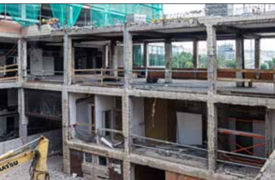
Odstrojený skelet před zahájením práce na parapetních vyzdívkách
