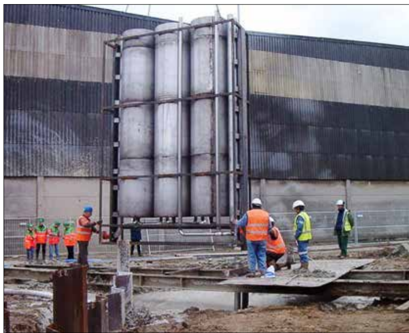
Obr. 11: Instalace prefabrikovaného třístupňového reaktoru z nerezové oceli do připravené rýhy v místě brány mezi vertikálními bariérami ze štětovnic při sanaci v belgickém Zwevegemu v roce 2002 (Soletanche-Bachy)
