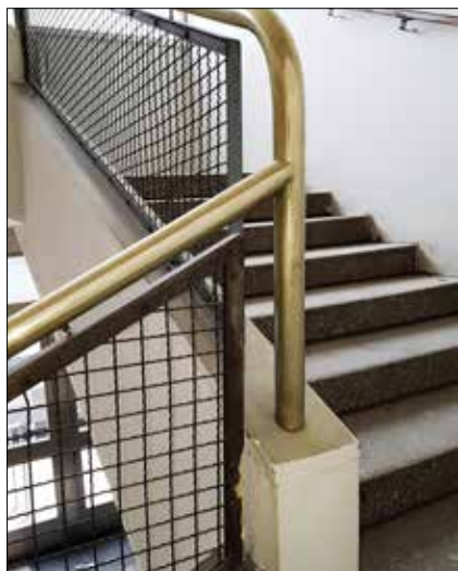
Zábradlí schodiště s průmyslovým detailem a madlem z bílé mosazi
