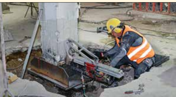
Provádění průvrtů přes dřív sloupu pro osazení svorníků
