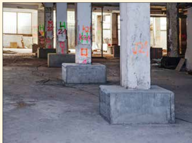
Finální podoba patek po obetonování (1. PP)
