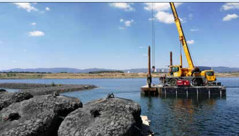
Ukotvené pontonové soulodí pro ukládku vaků
