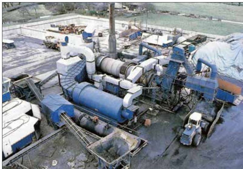
Obr. 8: Typické mobilní zařízení pro dekontaminaci vytěžené zeminy termální extrakcí do 300 °C, používané nizozemskou firmou Ecotechniek na počátku 80. let (XI. ICSMFE 1985)
