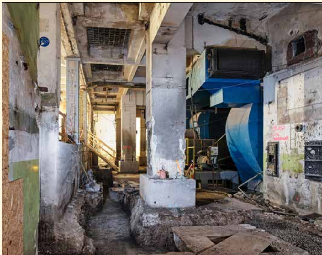
Podchycené sloupky na nejnižší úrovni 3. PP
