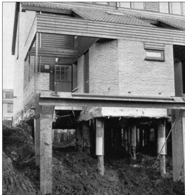
Obr. 2: Odtěžování kontaminované zeminy pod stojícími domy v sídlišti Lekkerkerk v Nizozemsku v roce 1980, následně přepravované k likvidaci ex-situ ve spalovně (XI. ICSMFE 1985)
