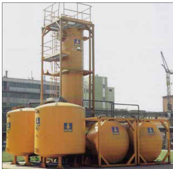
Obr. 7: Dekontaminační stanice firmy Bauer pro odstraňování chlorovaných uhlovodíků stripováním a filtrací při klasické metodě pump-and-treat v roce 1987 na pozemku farmaceutické továrny v Badensku-Württembersku (Bauer)
