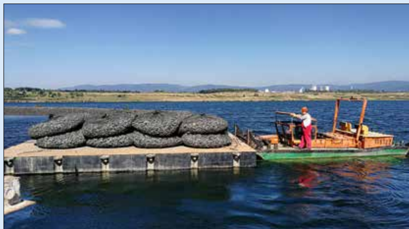
Přesun vaků na pracoviště ukládky
