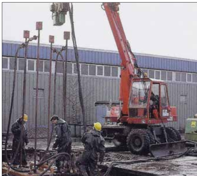
Obr. 9: Vibrationální zařízení pro metodu parního stripování polutantů, použitou prvně v roce 1984 v Nizozemsku firmou Heidemij (XI. ICSMFE 1985)
