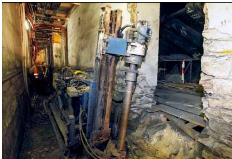
Hloubení vrtů pro osazení mikropilot určených k podchycení nosných stěn mezi jevištěm a hledištěm
