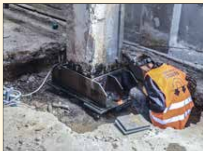
Svařování ocelové patky z jednotlivých plechů tl. 20 (16) mm
