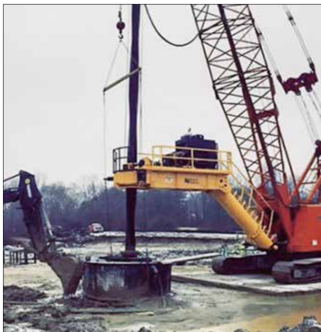
Obr. 10: Souprava pro metodu soil-mixing s chemickým ošetřením, používaná podle patentu firmy Geo-Con v USA v roce 2011 (Geo-Solutions)
