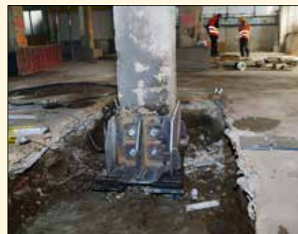
Kompletní ocelová patka po aktivaci svorníků
