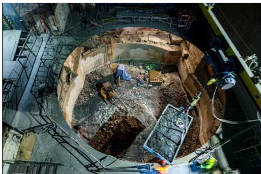
Pohled na hloubení pažené stavební jámy nové točny
