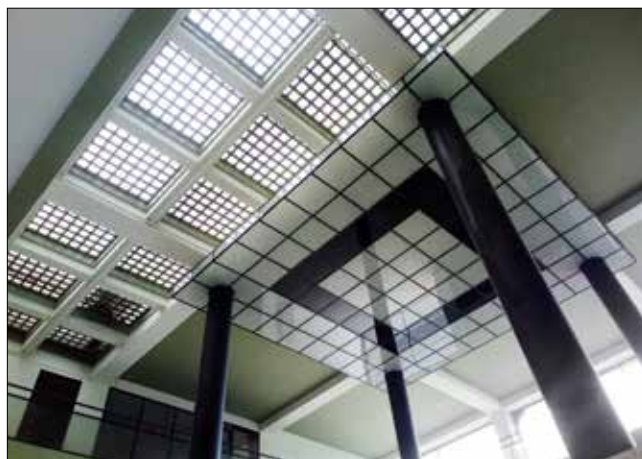
Strop jižního vstupu s charakteristickými sklobetonovými panely a vysokým řádem sloupů
