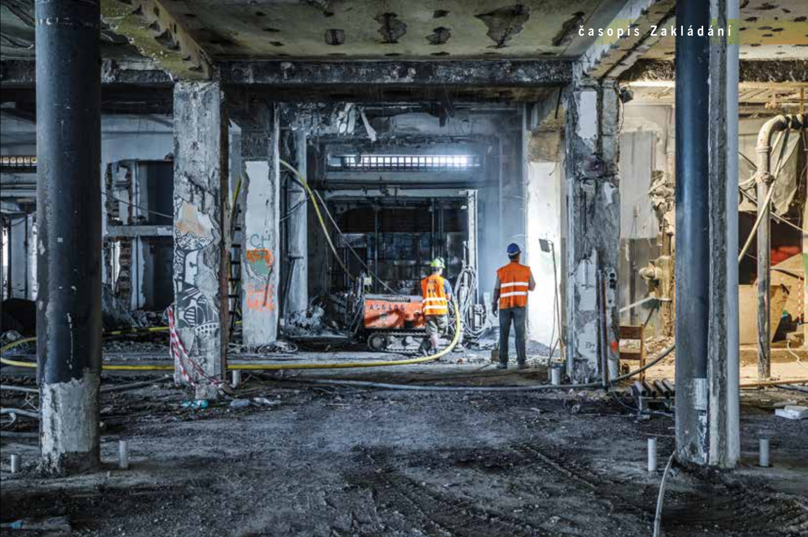
Hloubení vrtů pro mikropilotové založení na 1. PP maloprofilovou soupravou MSV 741/20
