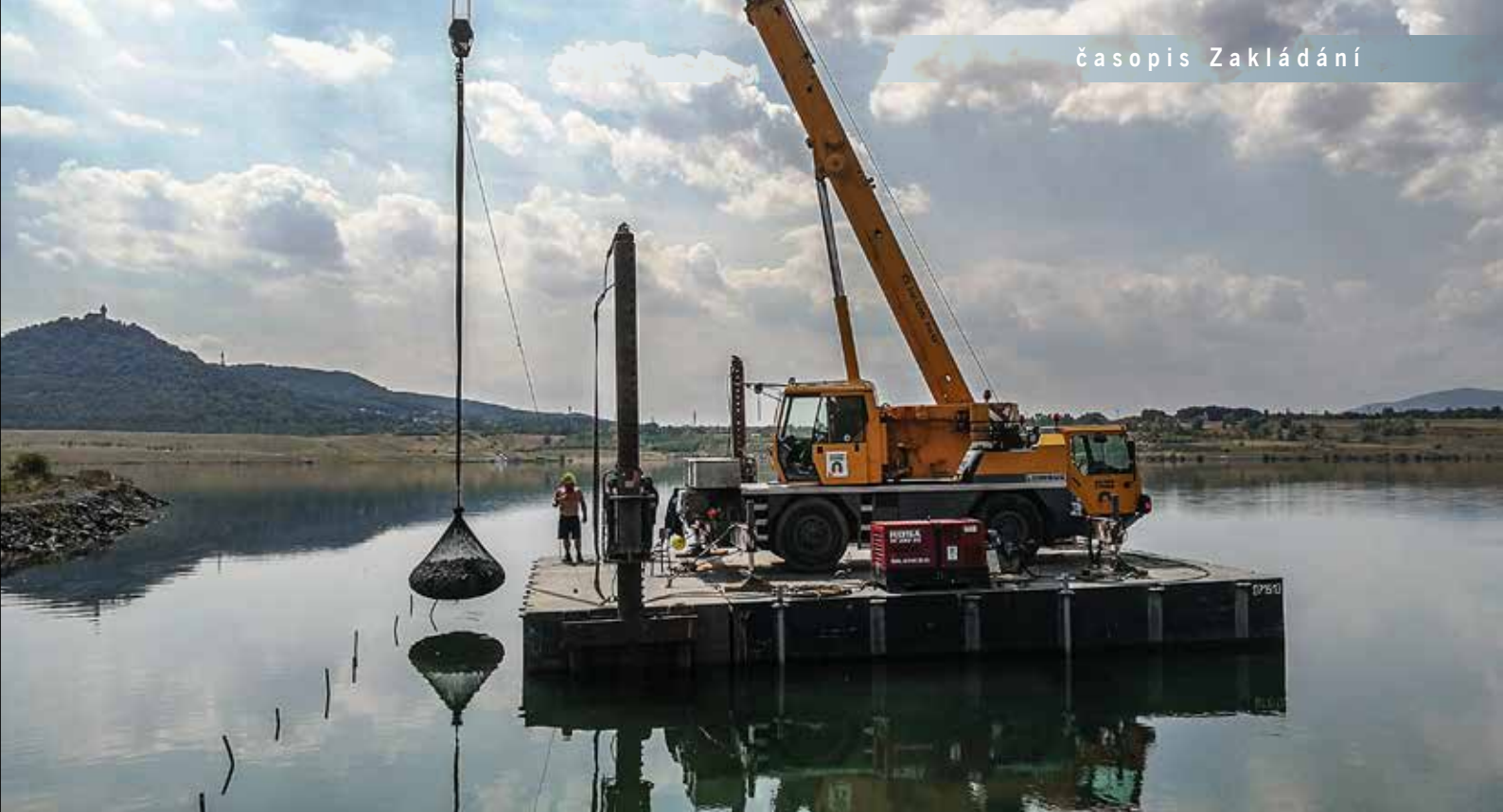
Ukládka vaků s kamenivem do vyznačených poloh
