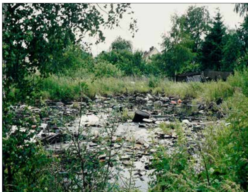
Obr. 5: Laguna směsi odpadů v dehtovém ložisku divoké skládky o celkové ploše cca 1 ha ve Skalně u Chebu v době těsně před sanačním zásahem v roce 1997 (Soletanche ČR)
