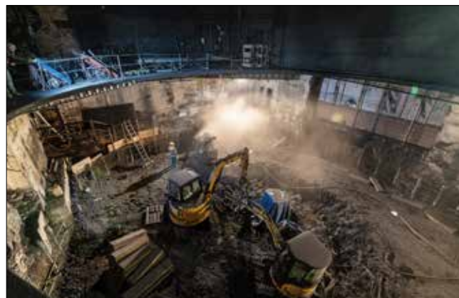
Hloubení vrtů pro dočasné kotvy pažení točny jeviště
