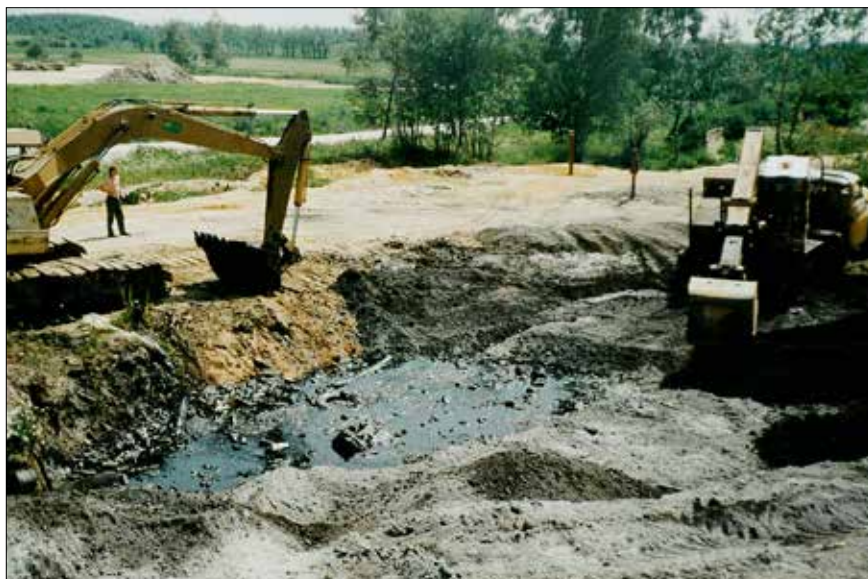
Obr. 6: Odtěžování ložiska dehtových odpadů a postupná stabilizace zbytků speciální solidifikační směsí in-situ při sanaci skládky firmy Kema Skalná v roce 1997 (Soletanche ČR)
