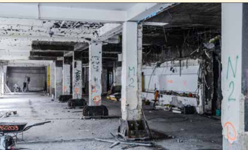
Sloupy skeletu s novými ocelovými patkami (1. PP)
