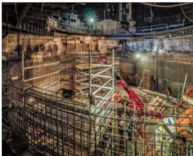
Následující fáze výstavby vnitřních konstrukcí nové točny
