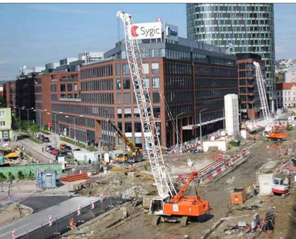
Nasadenie nosičov Liebherr HS 855 HP a HS 845 HD na realizácii konštrukčných podzemných stien v 3. etape
