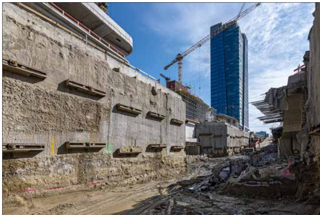
Pohľad zo stavebnej jamy 3. etapy po zjednotení (spojení) s 1. a 2. etapou po čiastočnom odbúrání deliacich podzemných stien. Z koštruktí 1. etapy a 2. etapy vyčnieva výstuž zo stropnej dosky na napojenie s treťou etapou.
