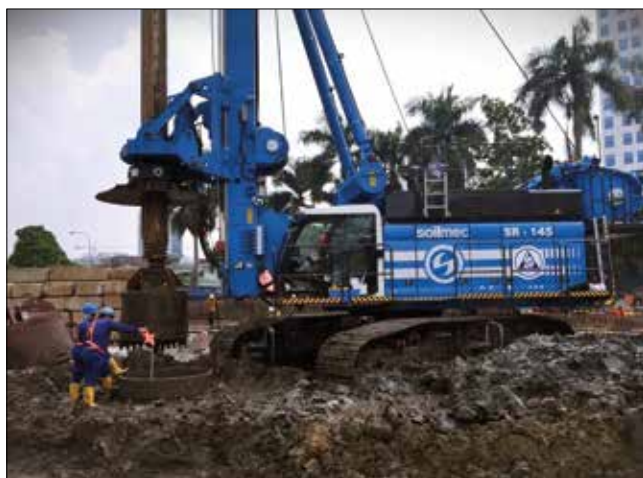
Obr. 1: Vrtání pilot o průměru 1,5 m do hloubky 87 m v jílovitosiltovitých zemích soupravou Soilmec SR 145 o váze 145 t pro založení mrakodrapu v indonéské Jakartě v roce 2017. Vrt byl vibračně zapažen ocelovou výpažnicí do 15 m a dále prováděn pod polymerovým výplachem (Soilmec/Trevi).
