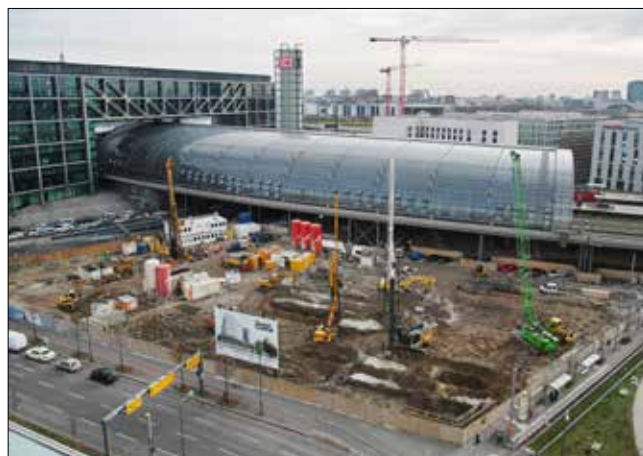
Realizace monobloku TI pomocí dvou vrtných souprav na MK1
