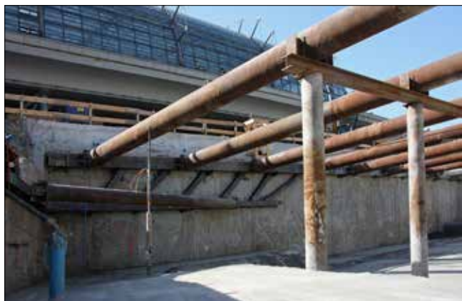
Detail dvouúrovňové rozpěrné konstrukce MK1
