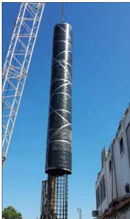
Prototyp armokoše pro redukci plášťového tření piloty
