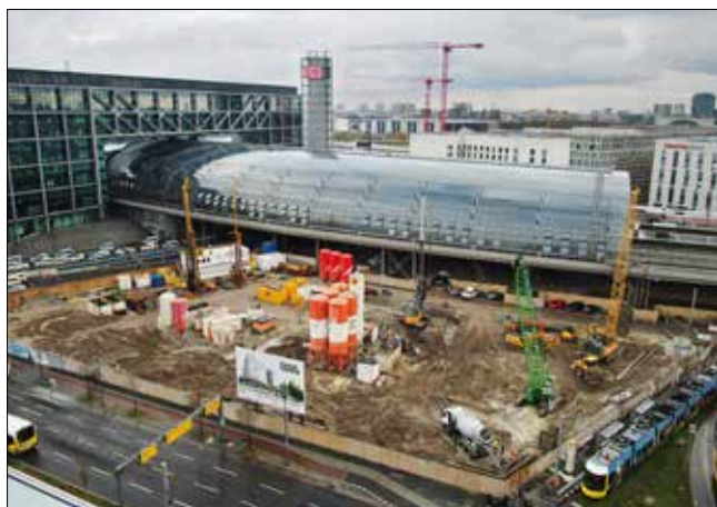
Provádění podzemních stěn na MK1, pilotového založení na MK2 a zkušebních prvků tryskové injektáže
