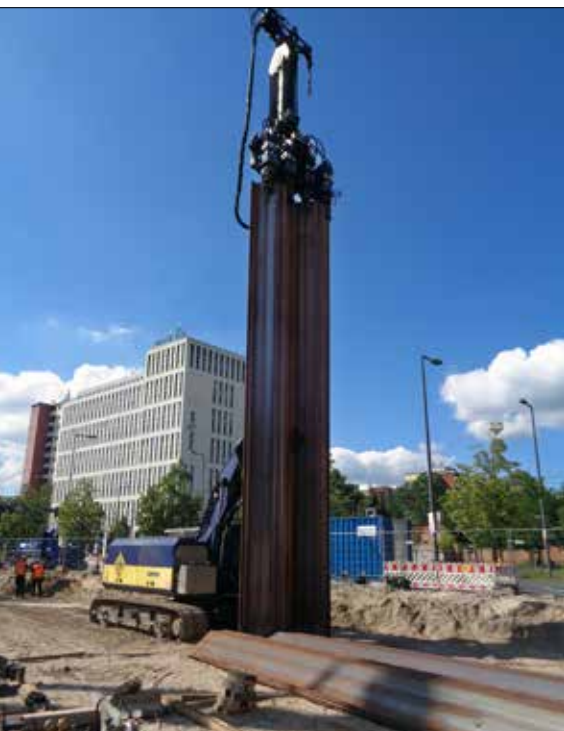
Štětové stěny na MK2 byly z důvodu omezení sedání vibrovány pouze částečně, zbytek byl vtlačován. Na obrázku je ABI-Press HPZ 500-720 (4 x 800 kN) na nosiči TM 13/16 SL se 4 ks Z štětovnic (ESZ 18-700) o délce 12,40 m.
