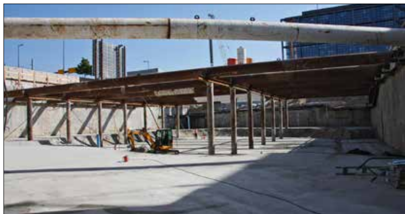
Dokončovací práce a přípravy na předání stavební jámy MK1
