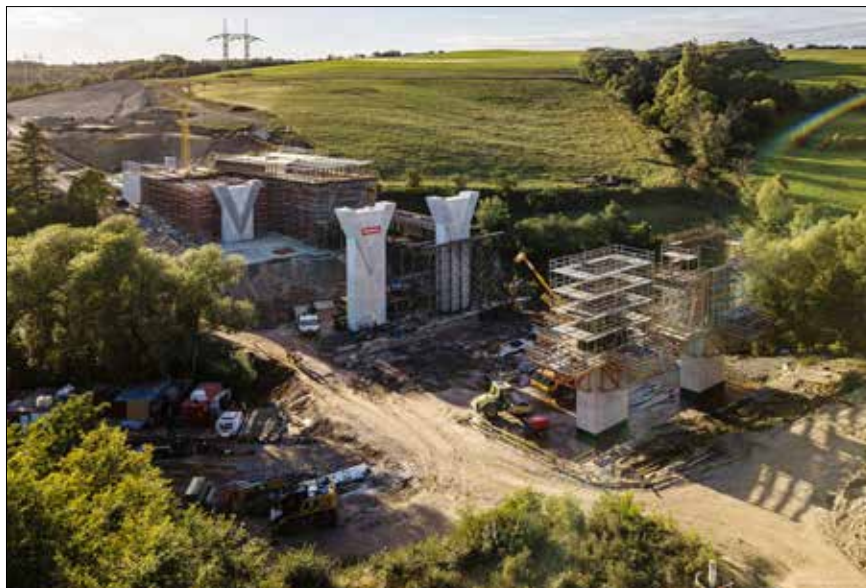
Pohled k západu na již vybudované pilíře P3, P4, P5 a opěru O6
