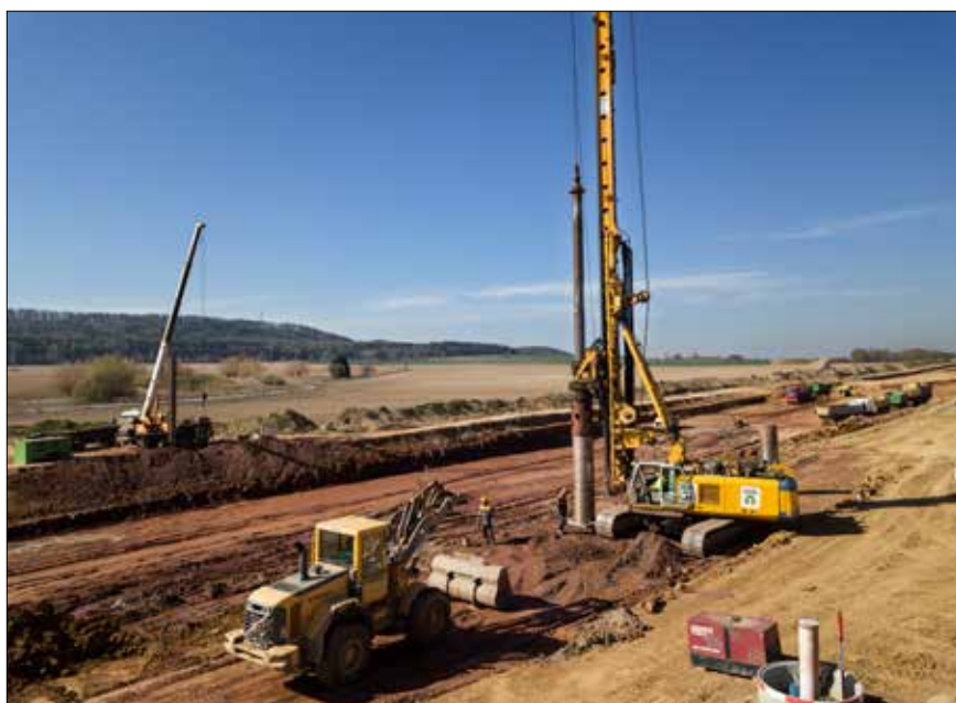
Na úseku R6 (D6) Řevničov, obchvat, bylo realizováno ještě několik dalších mostních objektů založených na velkopřůměrových pilotách. Jedním z nich byl most SO 2201 v blízkosti Řevničova.
