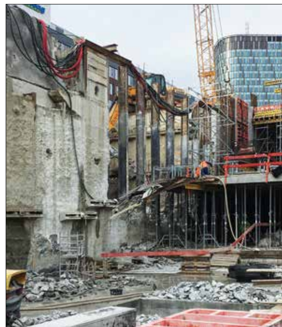
Pohľad zo stavebnej jamy Stanice Nivy na miesto napojenia s podzemnou kruhovou križovatkou v čase rozbiehania podzemnej steny – prepojenie oboch stavebných jam.
