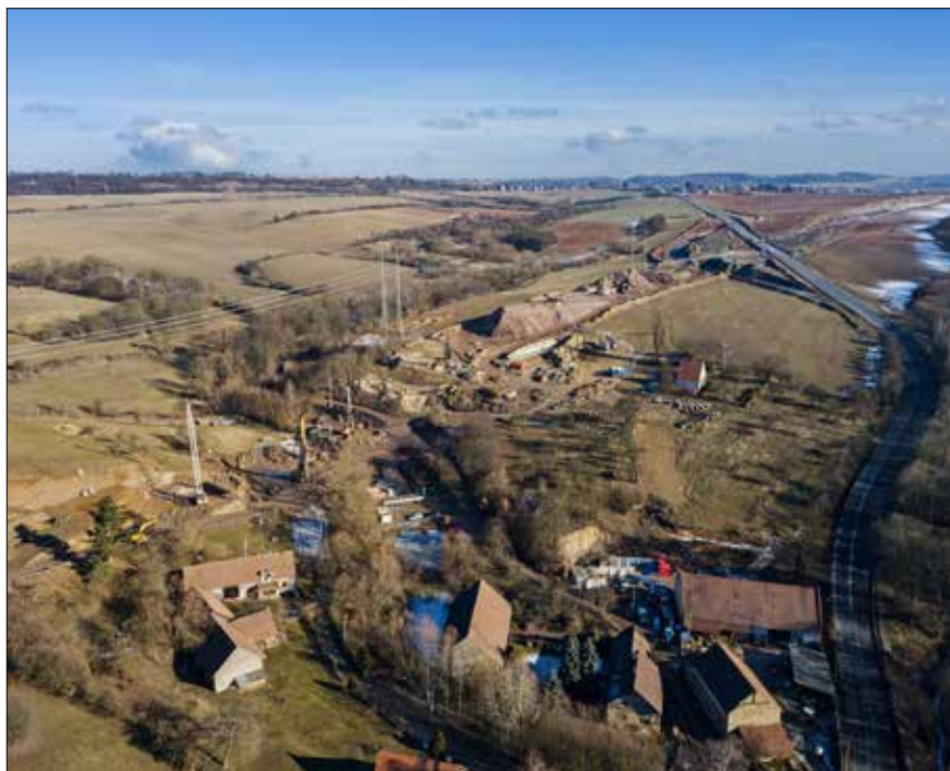
Obchvat Krušovic, zakládání mostu SO 2203, vpravo současně využívaná silnice I/6, na horizontu Řevničov, pohled k východu
