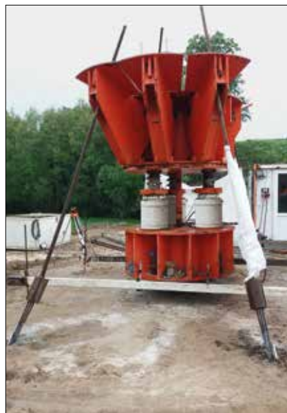
Obr. 4: Zkušební ocelový most kotvený předpjatými horninovými kótami
