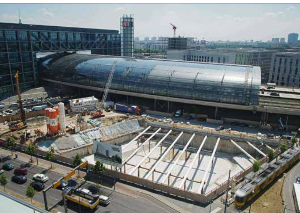
Dokončená a rozepřená stavební jáma MK1, na MK2 probíhá pilotové založení mezi tunelovými tubusy
