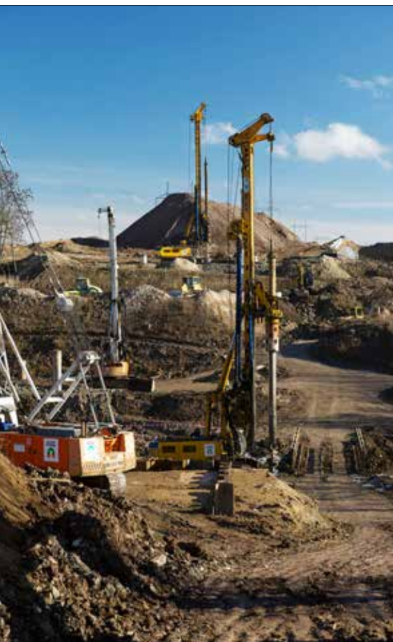
Pilotové zakládání pilířů a opěry mostu SO 2203, vlevo část beraněné jámy pro pažení základu pilíře P5
