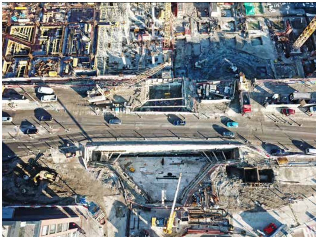
Charakteristický pohľad zhora na 1. a 2. etapu podzemnej kruhovej križovatky s nevylúčenou hromadnou dopravou, počas realizácie KPS na 2. etape. Na 1. etape boli v tom čase práce špeciálneho zakladania už ukončené.
