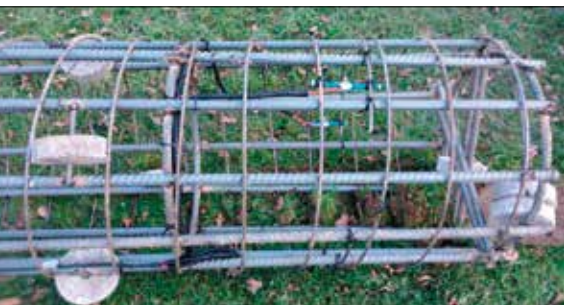
Obr. 3: Instalace strunových tenzometrů na armokoš piloty
