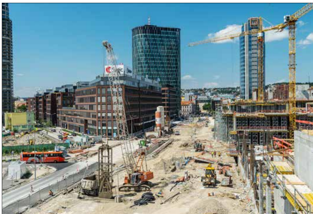
Realizácia 3. etapy podzemných stien – uzavretie čiel stavebnej jamy pomocou podzemných tesniacich stien po vylúčení dopravy a odstránení inžinierskych sietí.
