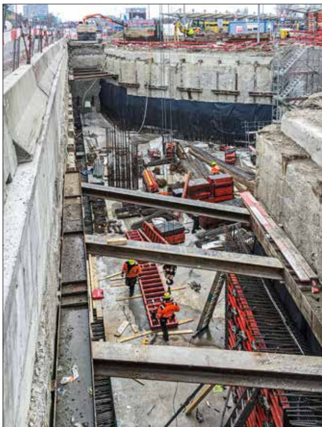
Pohľad na systém rozopretia konštrukčných podzemných stien pomocou oceľových rozpier v neprístupných miestach pre vrtnú súpravu.
