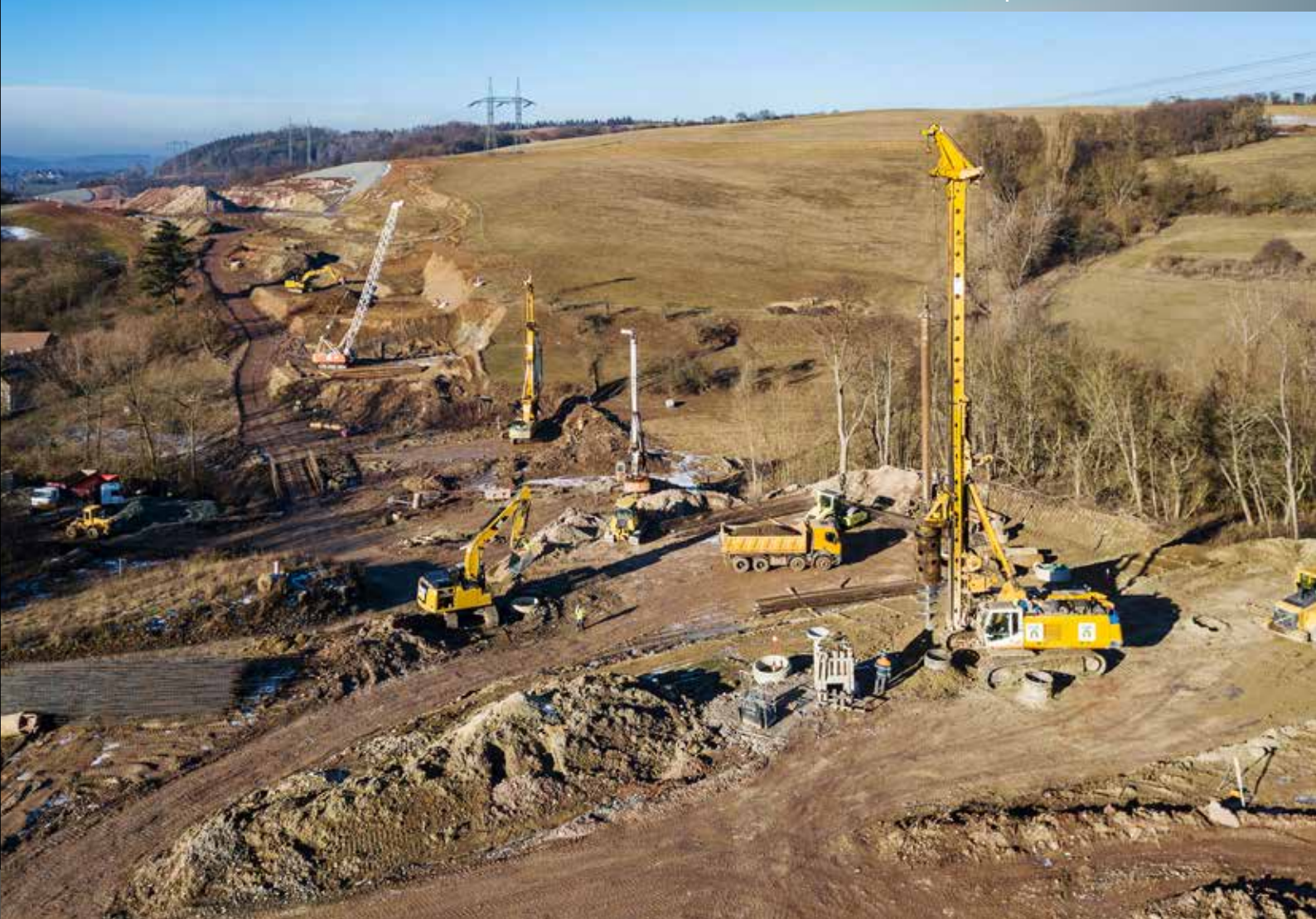
Intenzivní nasazení strojů při zakládání mostu SO 2203
