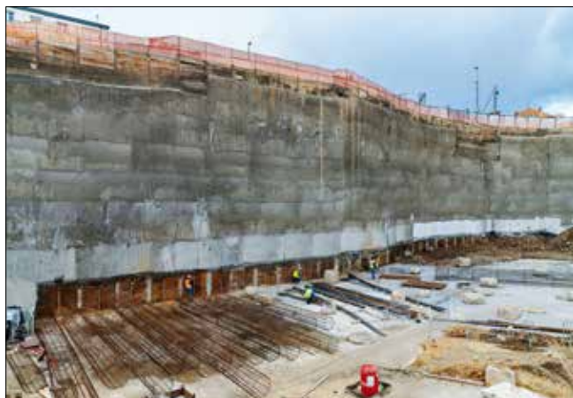
Pažení stavební jámy podél ulice Liberijské dosahovalo výšky až 20 m.
