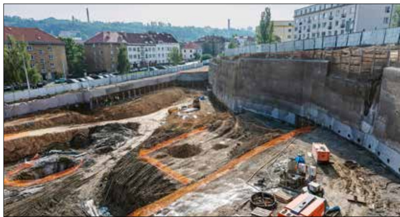
Pohled na západní část stavební jámy, vlevo záporová stěna podél Kladenské ulice, vpravo pažení podél ulice Liberijské
