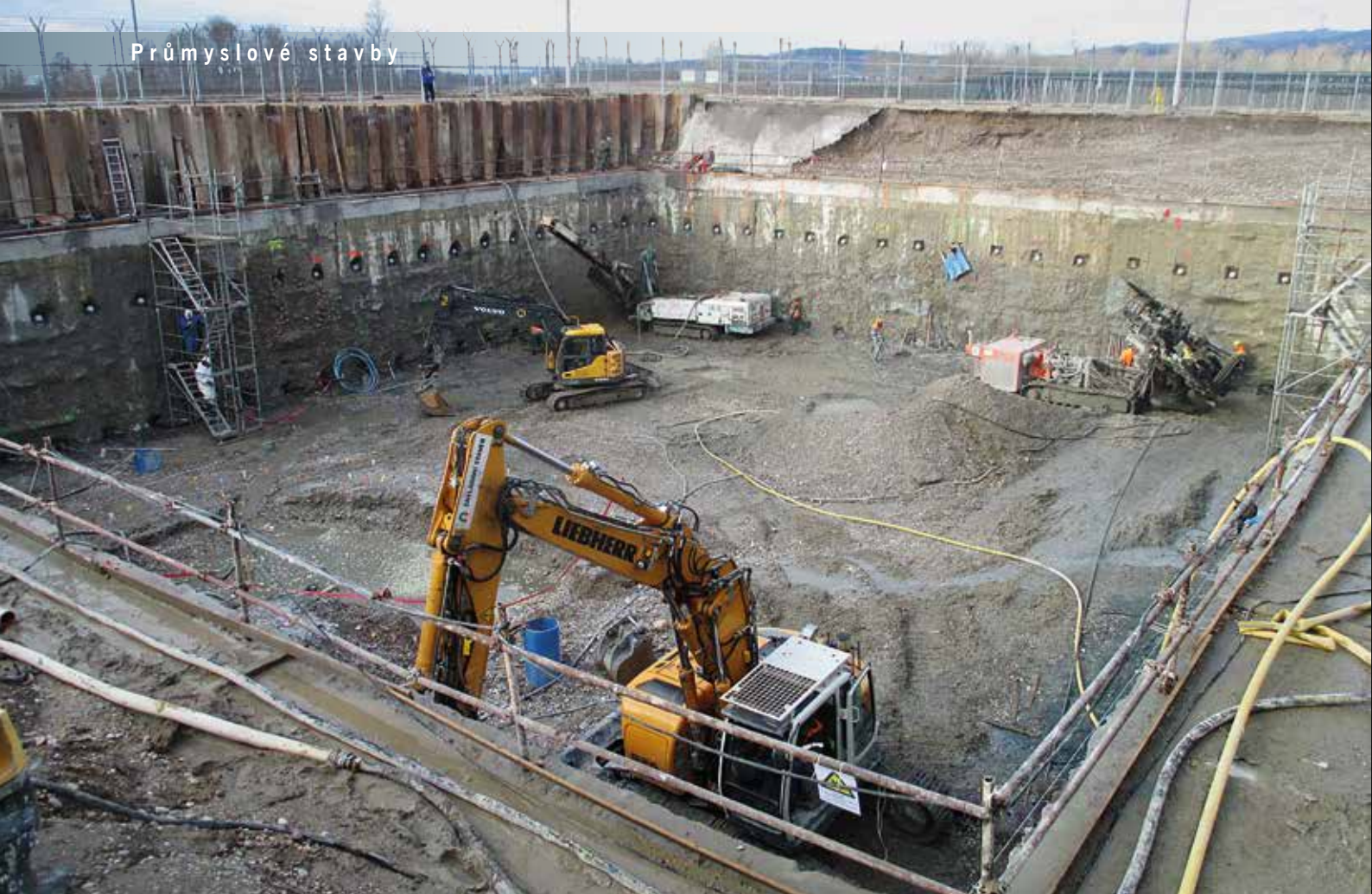
Obr. 1: Pohled do stavební jámy pro budovu BB2 – výkop na druhou kotvení úroveň
