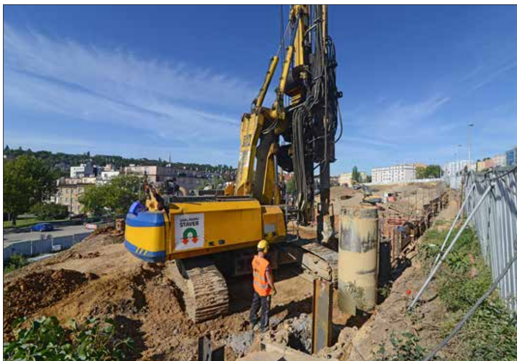
Provádění pilot v SV části stavební jámy
