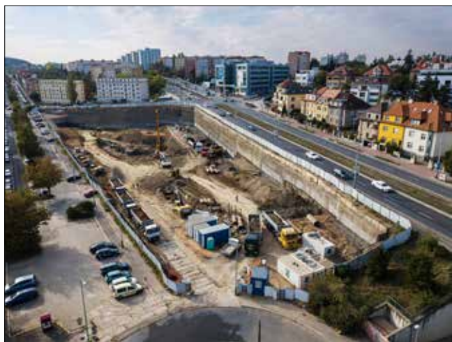
Stavební jáma v těsné blízkosti Evropské třídy, pohledy k západu a k východu
