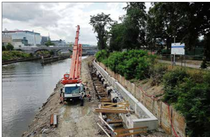
První fáze výkopových prací v dokončené štětové jímce s již osazenou první řadou rozpěr
