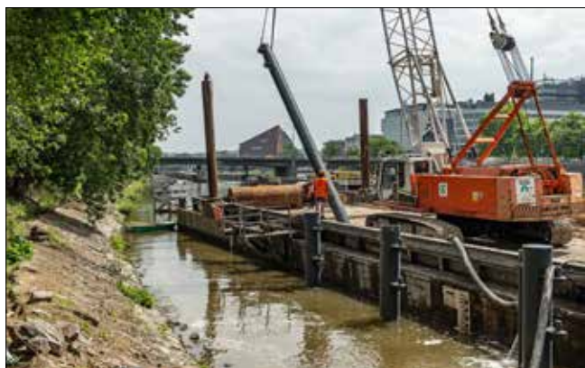
Osazování nastrojené ocelové dalby pr. 508/16 mm do vrtu pr. 900 mm
