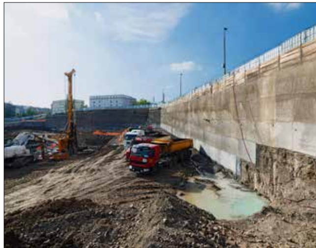
Z větší části provedené pažení stavební jámy podél Evropské třídy, pohled k západu
