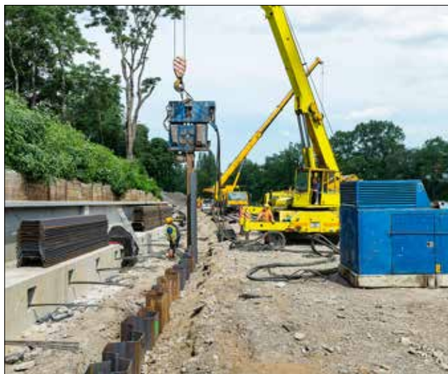
Vibrování štětové jímky ze štětovnic VL 604
