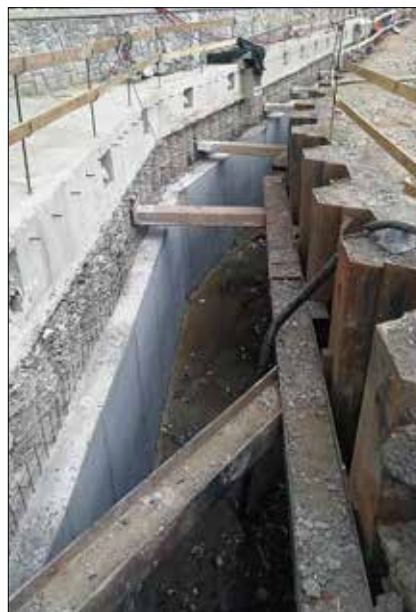
Vlevo rozepřená štětová jímka podél pilotové stěny, uprostřed realizace obkladu pilotové stěny pod ochranou štětové jímky, vpravo již zasypaná jímka s položeným kamenným obkladem v horní části pilotové stěny a na zadní L zídce
