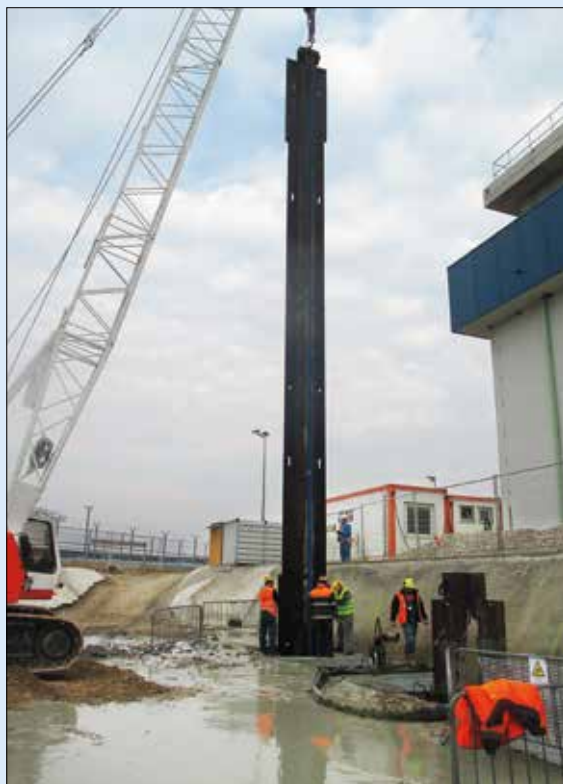
Osazování výpažnice tl. 1,4 m v severní stěně
