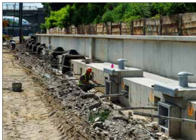
Dokončovací práce v horní části nábrežní zdi s již osazenými pacholaty a vybetonovanou navazující L zídkou
