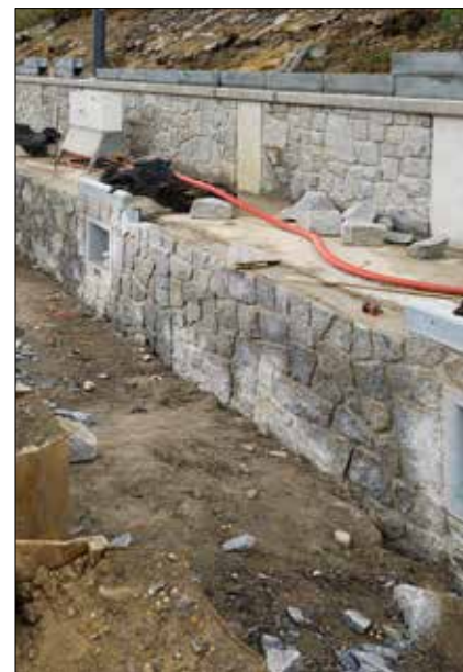
Vlevo rozepřená štětová jímka podél pilotové stěny, uprostřed realizace obkladu pilotové stěny pod ochranou štětové jímky, vpravo již zasypaná jímka s položeným kamenným obkladem v horní části pilotové stěny a na zadní L zídce
