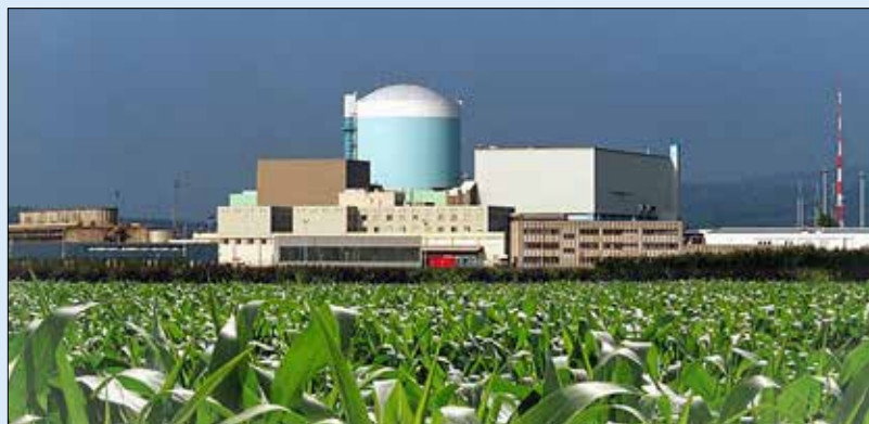
Obr. 3: Pohled na elektrárnu z JV strany
