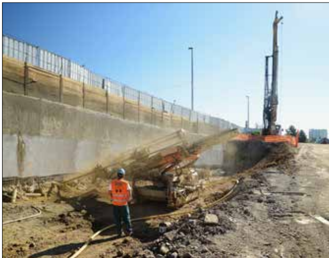
Provádění kotev 2. KÚ na pilotové stěně podél Evropské třídy
