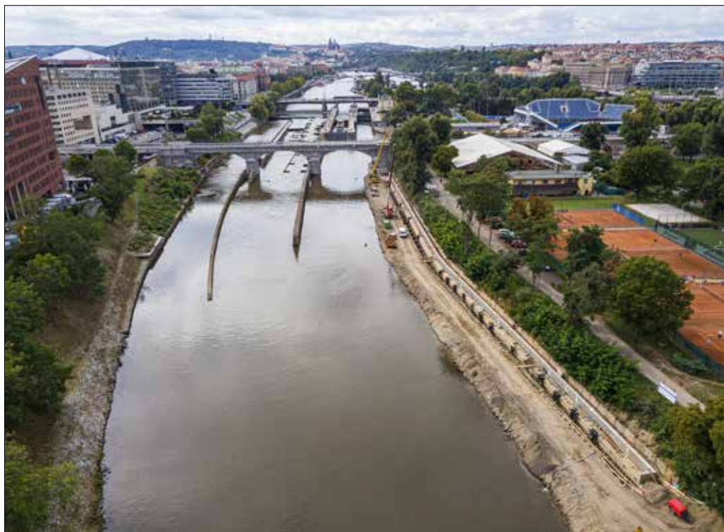
Celkový pohled na staveniště PK Štvanice, po pravé straně výstavba nové nábrežní zdi na dolní vodě
