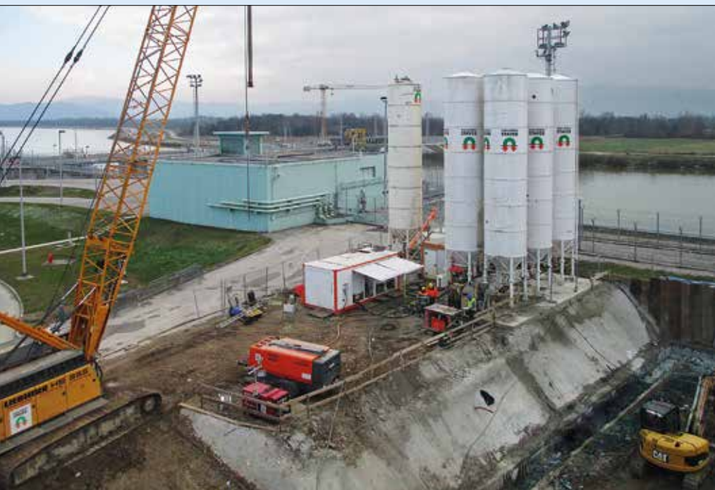
Zařízení staveniště uvnitř elektrárny
