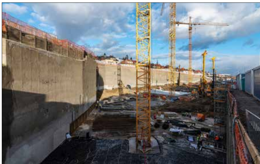
Celkový pohled na stavební jámu, paženou již téměř až na úroveň základové spáry, pohled k východu
