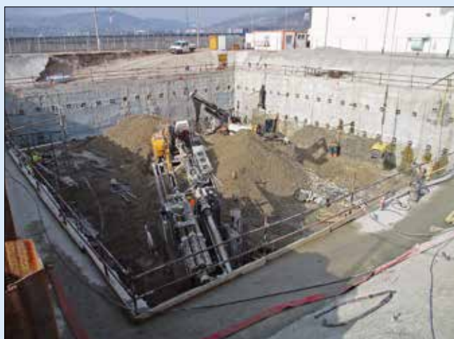
Výkop na 2. korevní úrovni
