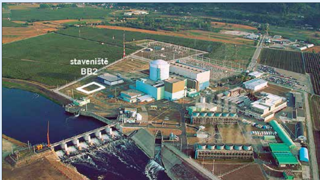
Obr. 4: Pohled na elektrárnu s vyznačenou polohou staveniště (foto před vzedmutím hladiny Sávy hydroelektrárnou Brežice)
