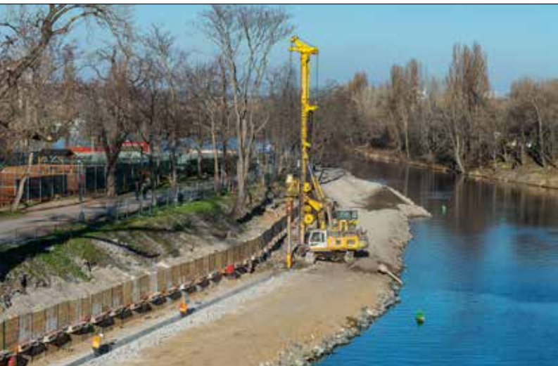
Vrtání velkopřůměrových pilot tvořících statickou část konstrukce nové nábrežní zdi na dolní vodě
