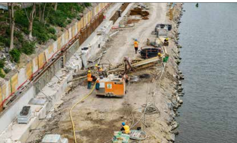
Vrtání kotev přes osazené průchodky v hlavovém trámu pilotové stěny
