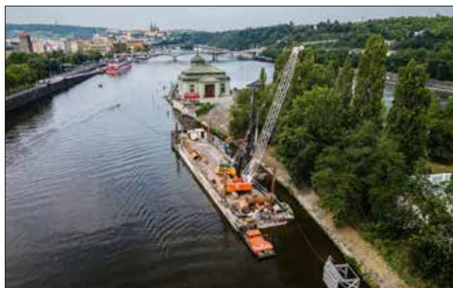
Provádění dalbových stání na horní vodě u břehu ostrova Štvanice
