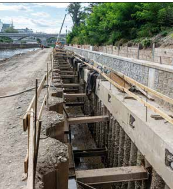
Vlevo rozepřená štětová jímka podél pilotové stěny, uprostřed realizace obkladu pilotové stěny pod ochranou štětové jímky, vpravo již zasypaná jímka s položeným kamenným obkladem v horní části pilotové stěny a na zadní L zídce
