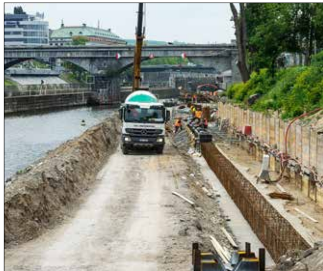
Nábrežní zeď ve fázi realizace hlavového trámu nad pilotovou stěnou
