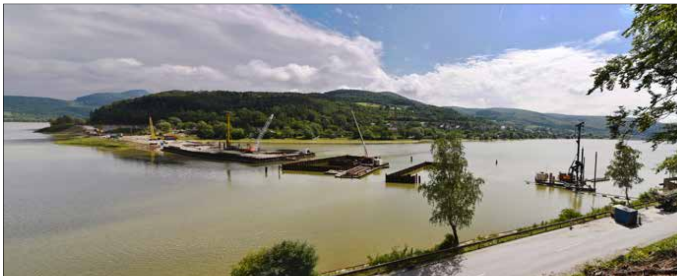
Súčasná prebiehajúca realizácia štetovnicových ohrádzok a pilótového založenia
