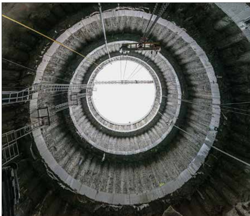
Dva pohledy na stavební jámu VO-OL z převrtávaných pilot rozpíraných hlavovým věncem a převážkami
