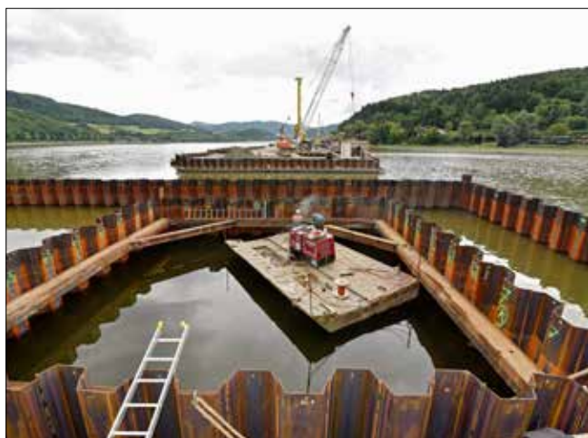
Detail ohrádzky P5 behom inštalácie horného rozperného rámu
