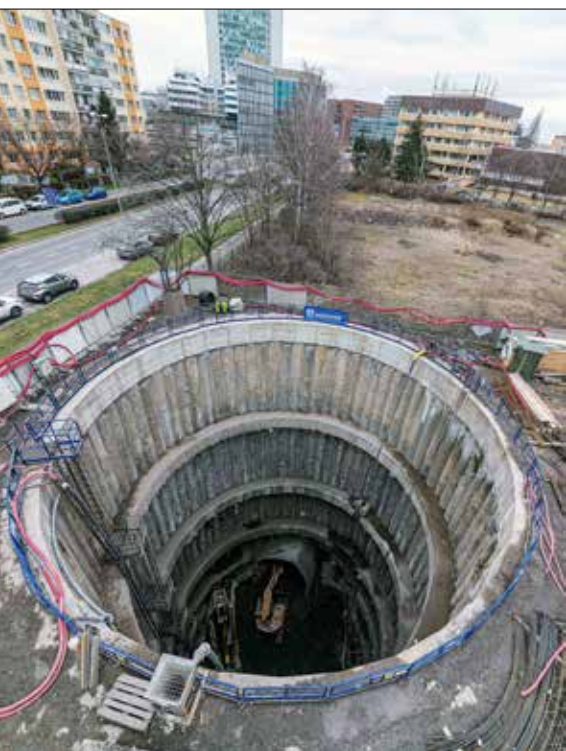
Dva pohledy na stavební jámu VO-OL z převrtávaných pilot rozpíraných hlavovým věncem a převážkami
