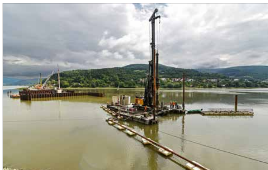
Pilotové založení piliera P3 z pontónovej plošiny, vľavo dole potrubie pre transport betónu na polystyrénových plaváčkach
