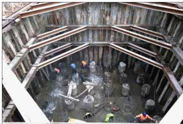
Ohrádzka P5 rozopretá v 3 úrovniach rozpernými rámmi, prebieha ťažba na základovú škáru a búranie prebetonávky hláv 30 ks pílôt
