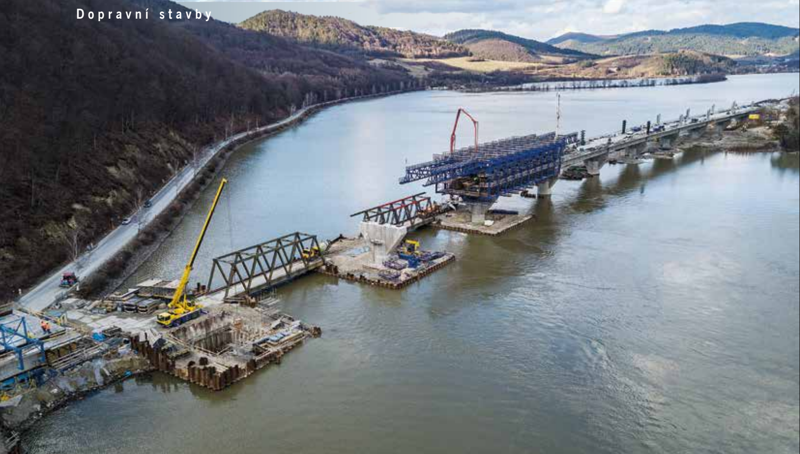
Vznikajúci železničný most cez Nosickú priehradu, zachytené sú ešte neodstránené štetovnicové ohrádzky pre založenie pilierov P3, P4, P5 (zľava)
