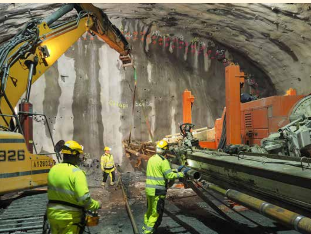
Obr. 15: Příprava na osazení výztužné trubky MP dešťníku za pomoci vrtné soupravy Casagrande PG 185
