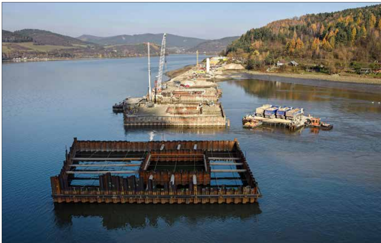
Pohľad na dvojitú rozoprenú ohrádzku pre pilier P4, prebiehajúce zásypy vonkajšieho obvodu ohrádzky ostrova
