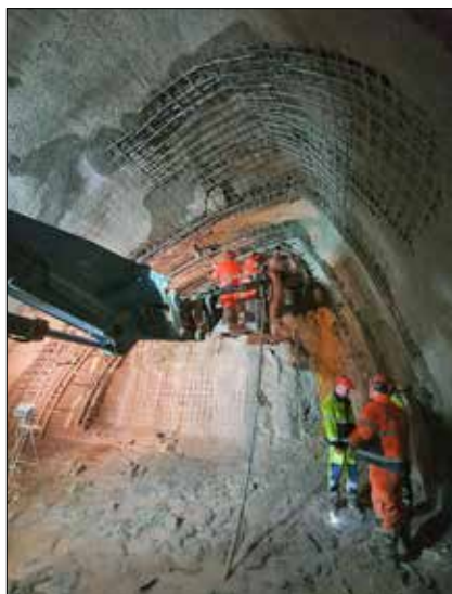
Zajištění kaloty průzkumného raženého tunelu ze šachty PAD4
