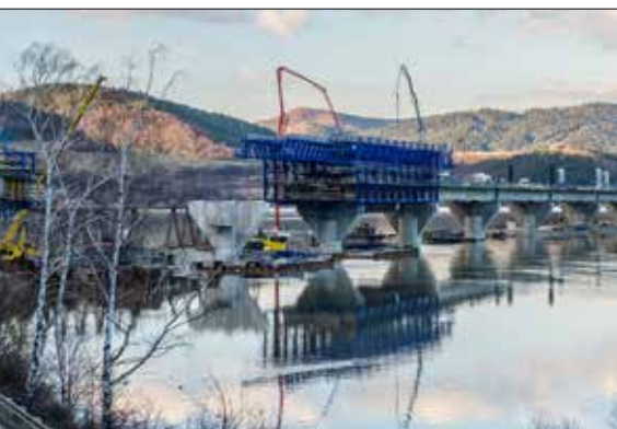
Betonáž mostovky medzi piliermi P5 a P6
