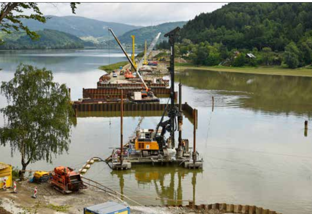
Pilotové založení piliera P3 z pontónovej plošiny, montáž rozperného rámu vnútornej jímky P5
