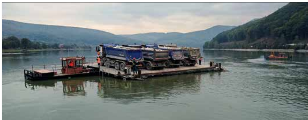
Ukladanie ťažkého kamenného obsypu okolo ostrovov P5 a P4 z pontónovej plošiny so štyrmi nákladnými automobilmi celkovej hmotnosti 160 t
