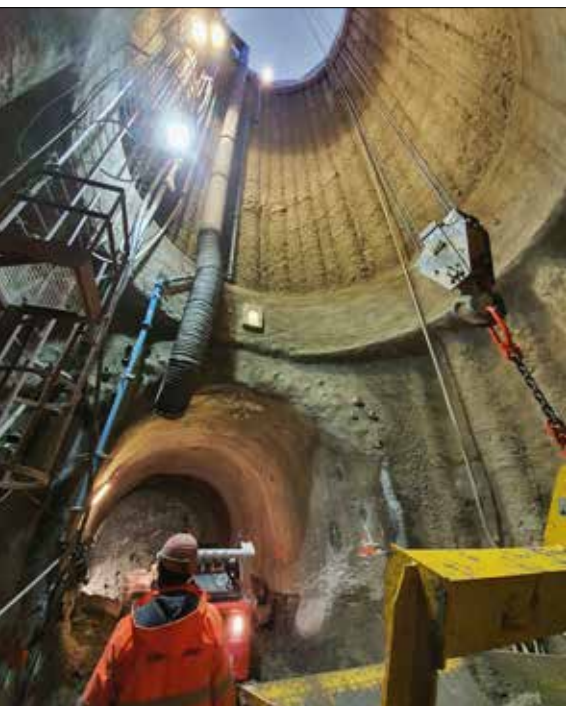
Šachta PAD4 a ražba navazujícího průzkumného tunelu
