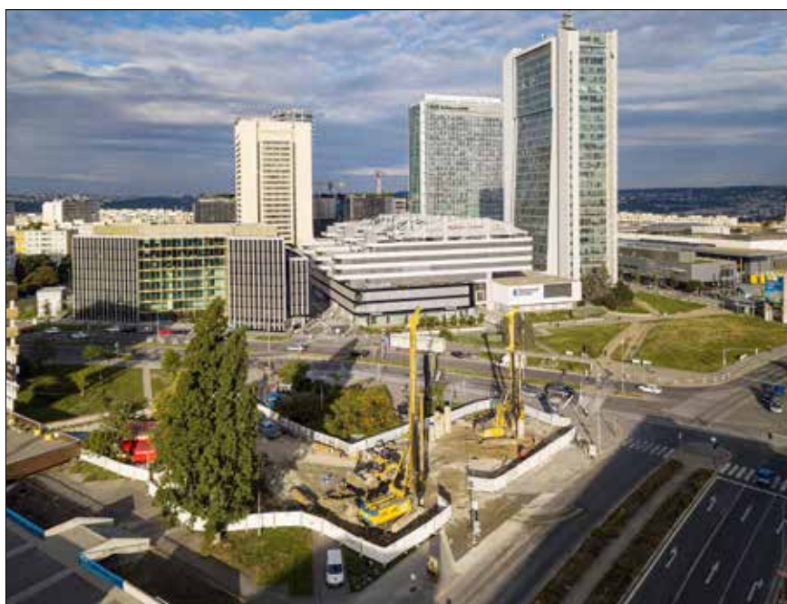
Provádění převrtávaných pilot pro šachtu PAD4
