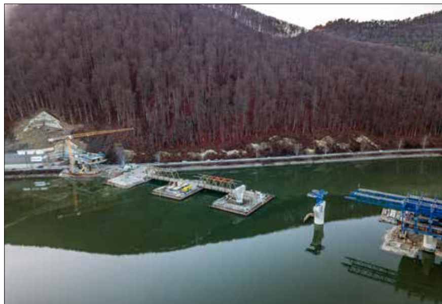
Postupná výstavba pilierov v ohrádzkach ostrovov P3, P4, P5, čiastočne odťažený polostrov P6, P7
