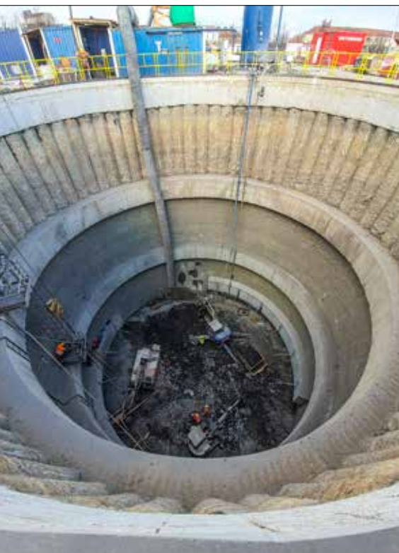
Stavební jáma PAD1b
