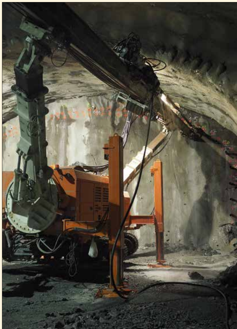
Obr. 16: Instalace trubky MP deštníku
