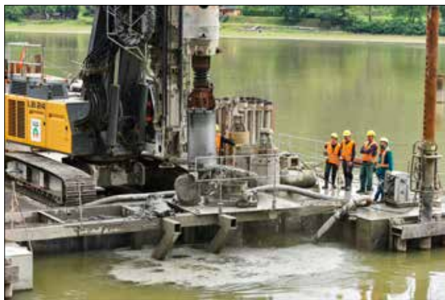
Dovŕanie pílôty, čistenie päty pílôty hrncom s plochým dnom za prítomnosti geologického dozoru
