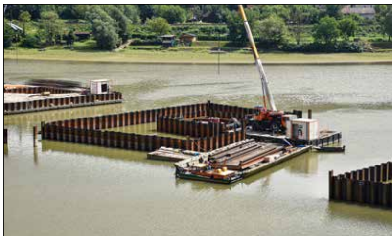
Inštalácia rozperného rámu štetovnicovej ohrádzky P5
