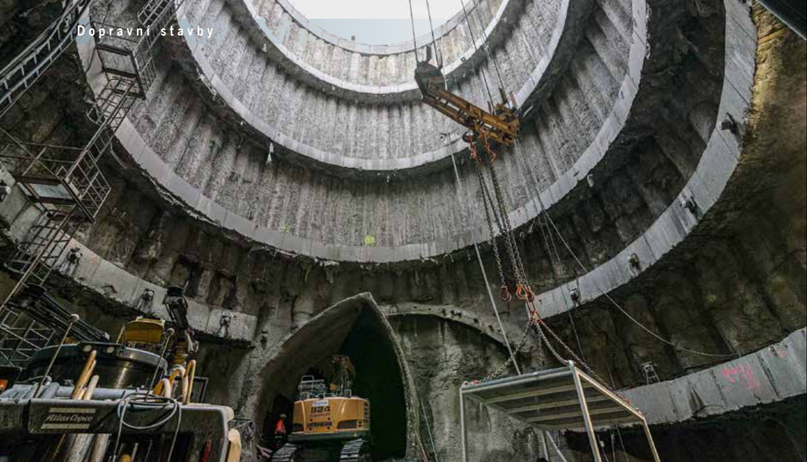
Šachta VO-OL pažená převrtávanou pilotovou stěnou po zahájení ražby průzkumného tunelu
