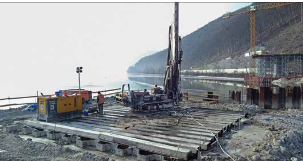
Realizácia tryskovej injektáže z masívnych nosníkov IPE 700 na vnútornej ohrádzke medzi pilótami piliera P5
