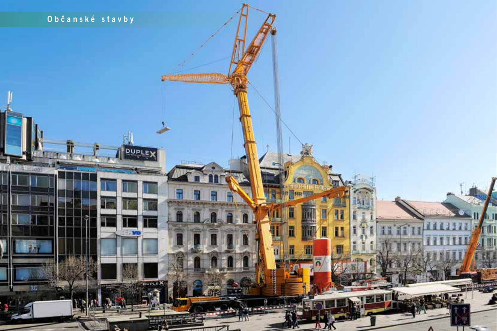
Instalace věžového jeřábu ve vnitrobloku pomocí mobilního jeřábu Liebherr LTM 1500 (nosnost 500 t) z Václavského náměstí
