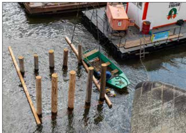
Montáž zavětrování ledolamu za pomoci potápěče
