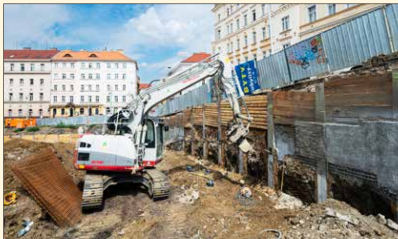
Strojní frézování horniny mezi záporami
