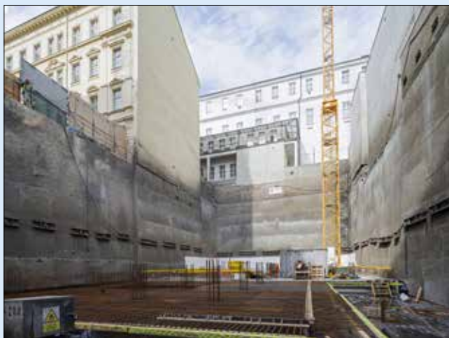
Zapažená stavební jáma na hloubku 12 m od původního terénu
