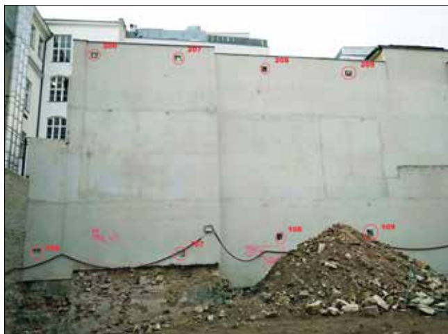
Obr. 2: Měřické body na fasádě objektu Nadace ABF (Václavské náměstí 833/31)
