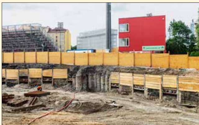
Část stěny pod patkou stožáru stadionu Viktoria Žižkov byla zajištěna kotvenými pažicemi pilotami.
