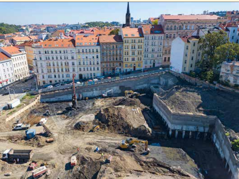
Zapažená stavební jáma, probíhá pilotové založení a zemní práce
