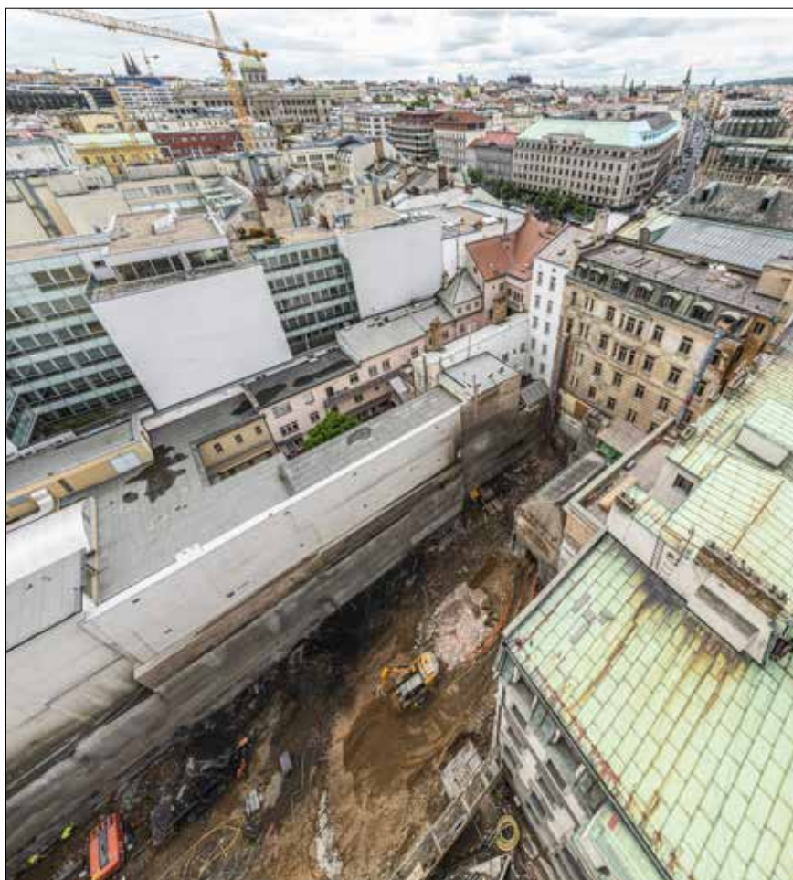
Pohled z věžového jeřábu přes stavební jámu směrem na horní část Václavského náměstí
