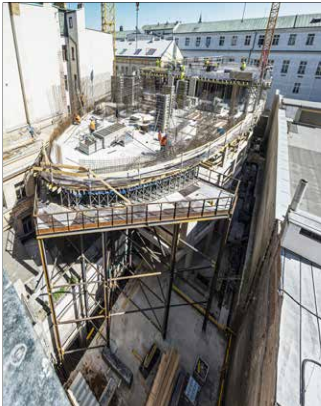
Ocelová konstrukce bednicí věže a bednění konzolové části stropu 3. NP
