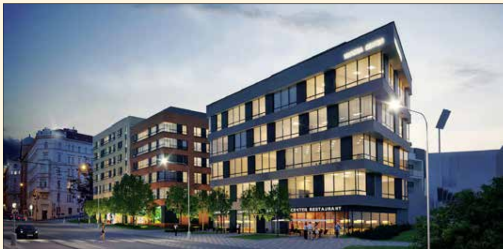
Budoucí podoba stavby, pohled ze Seifertovy ulice
