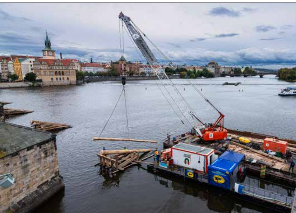
Osazování šikmé klády ledolamu
