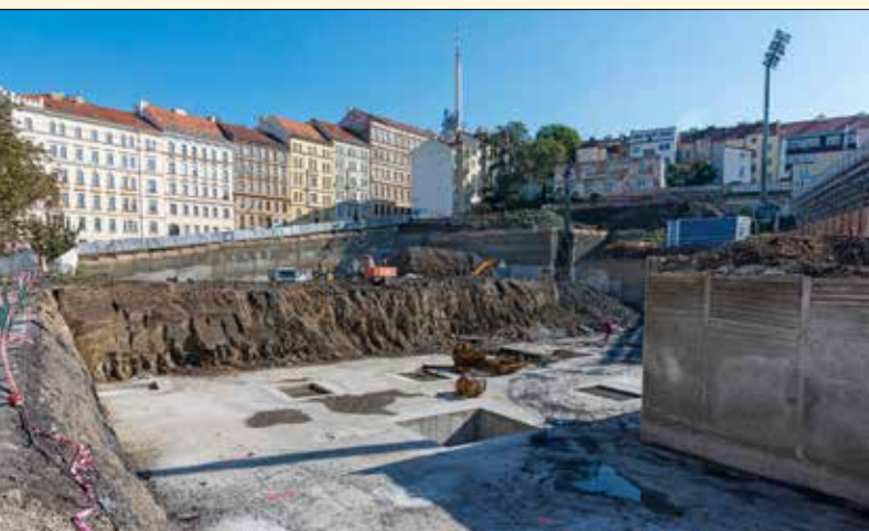
Zapažená stavební jáma s částečně zhotovenou základovou deskou a nosnými pilotami
