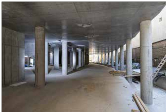
Železobetonové konstrukce přízemní části eliptické dostavby
