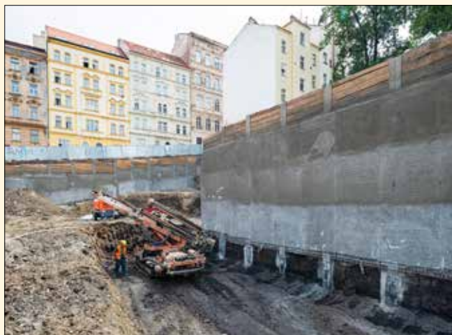
Hloubení vrtů pro kotvy v jižní části stavební jámy
