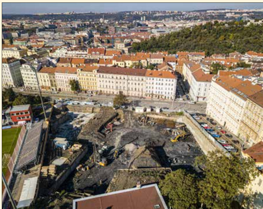
Pohled na staveniště směrem k severu
