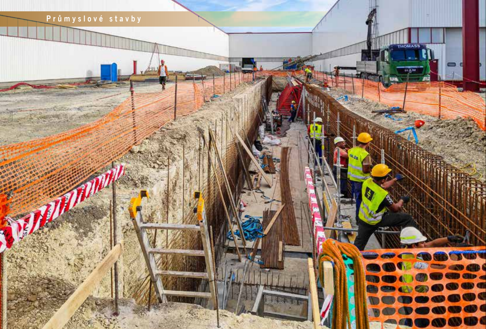
Odkopaná prerezávaná pilótová stena primárneho technologického kanála a nadväzujúce betonárske práce
