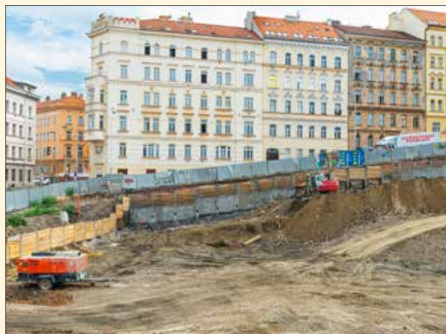
Kotvená záporová stěna pod ulicí Krásova
