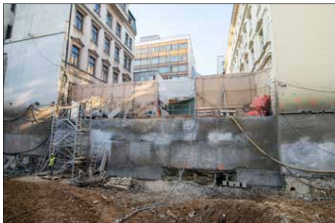
Část stavební jámy směrem do Jindřišské ulice zajištěná MZ pažením, viz řez 2
