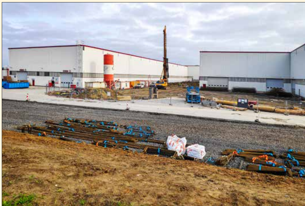
Realizácia prerezávaných pilót primárneho kanála a výroba zmesi pre tryskovú injektáž
