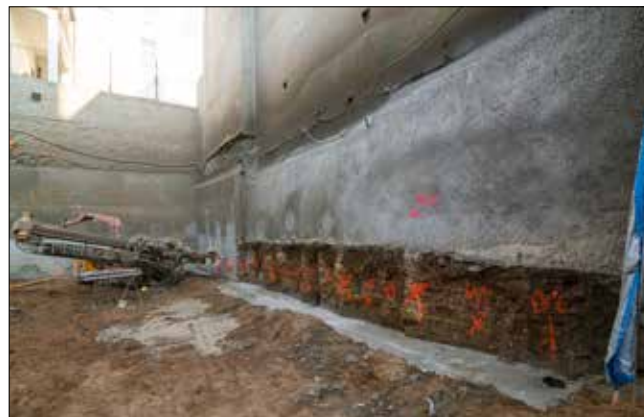
Hloubení vrtů pro osazení mikropilot pro osazení mikrozápor technologického kanálu
