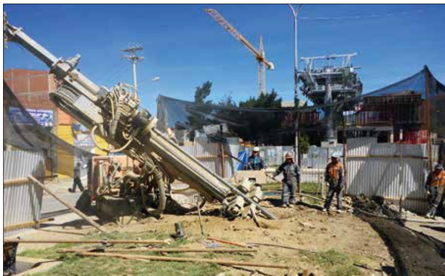
Hloubení vrtů pro mikropilotové založení pilíře lanové dráhy ve městě El Alto
