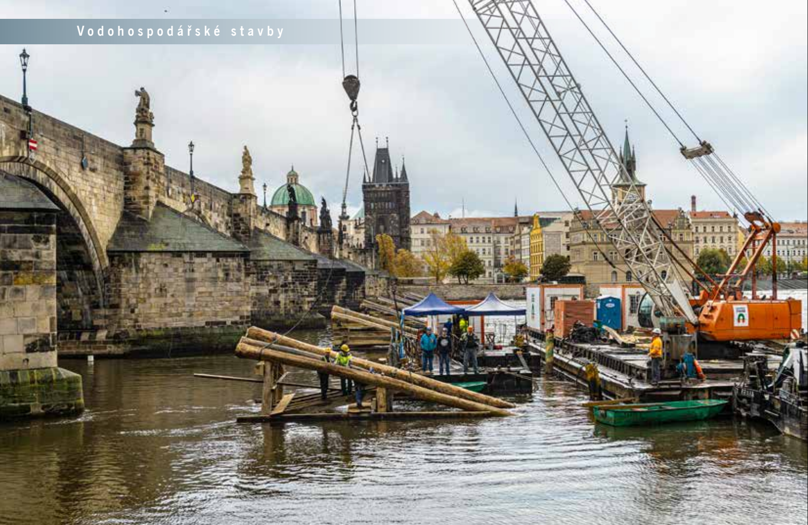
Osazování šikmé klády ledolamu před pilířem P9
