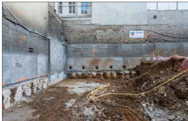
Částečně odtěžené stěny pažení TI
