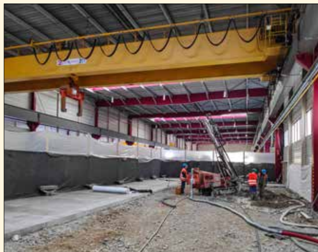
Realizácia tryskovej injektáže sekundárneho kanála v interiéri výrobnjej haly
