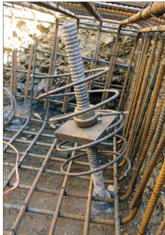
Zavázání hlavy mikropiloty do základové patky
