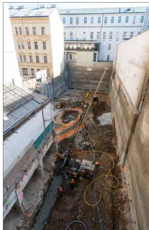
Provádění tryskové injektáže v západní části stavební jámy
