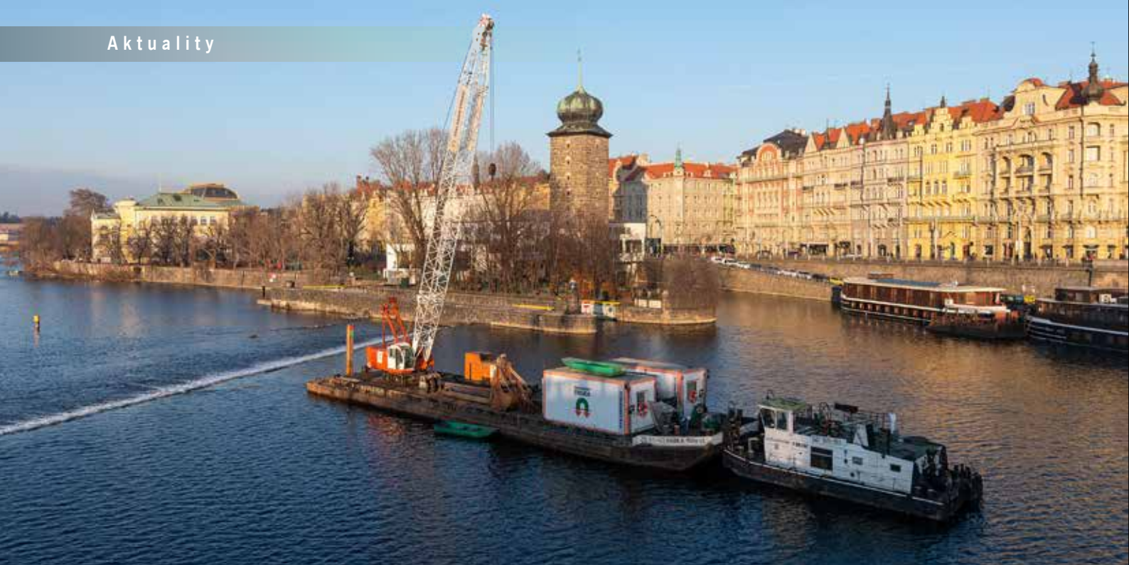
Provádění beranicích zkoušek nad Šítkovským jezem
