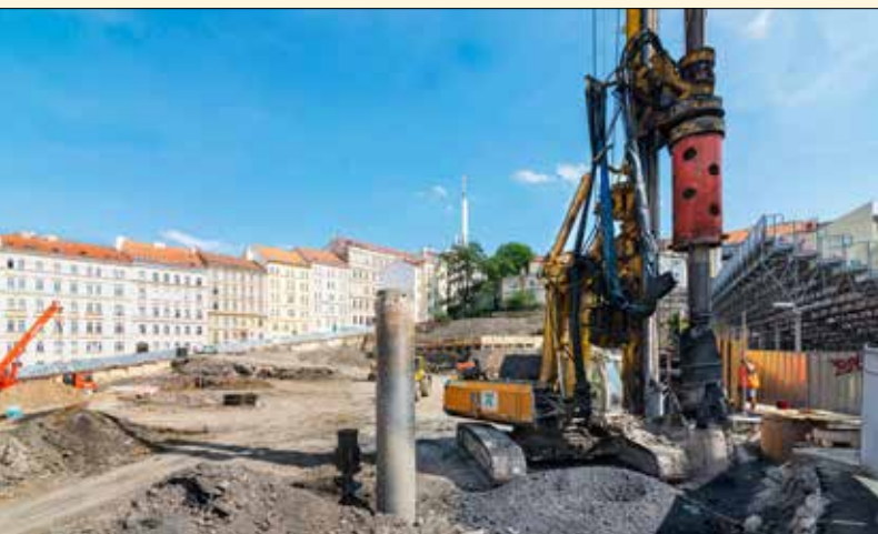
Hloubení vrtů pro zápor v blízkosti Seifertovy ulice
