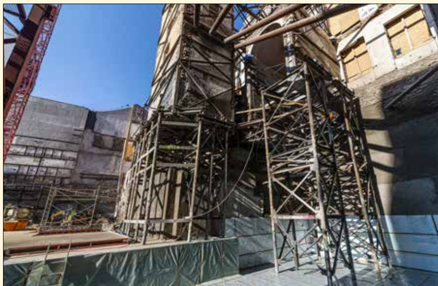
Pohled na MP bärky schodiště a průjezdu v době pokládky izolací
