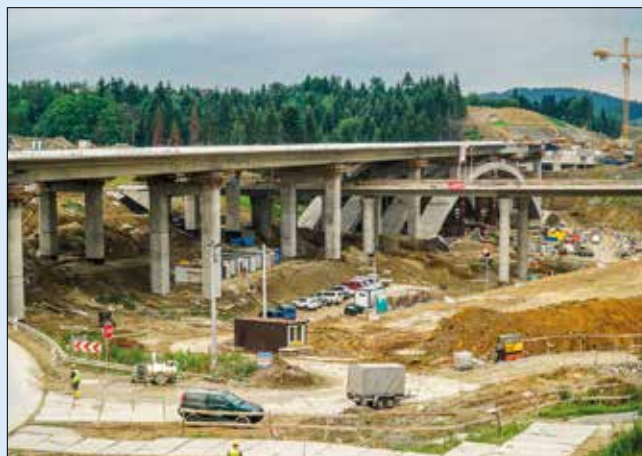
Mostní objekt č. 18
