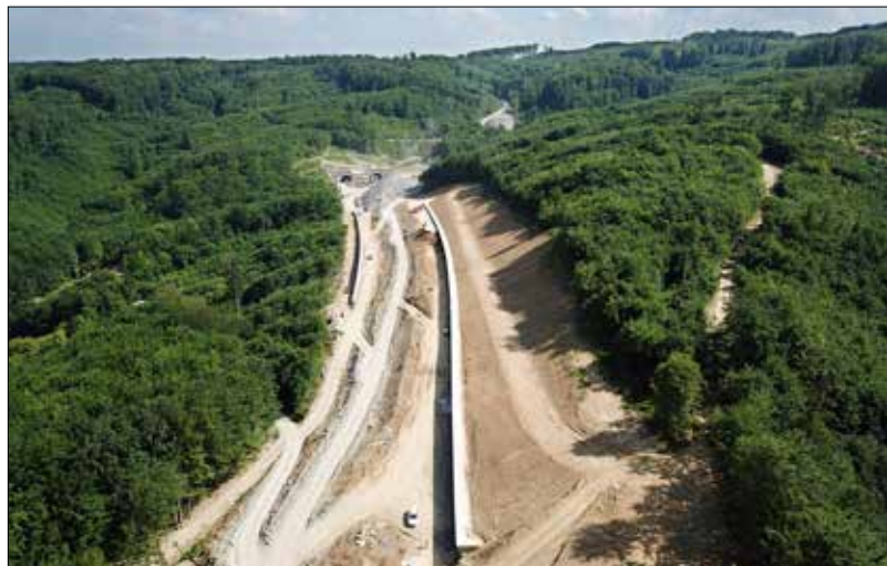
Fáze výstavby terénních zářezů před tunelem Prešov, vlevo na fotografii je zachyceno kotvení opěrné stěny SO 243
