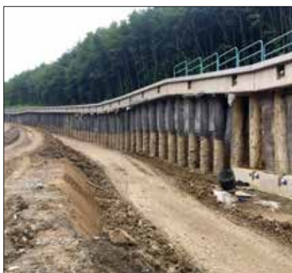
Pohled od západního portálu tunelu Prešov směrem k terénním zářezům a mostu SO 205, dole zárubní pilotová zeď obslužné komunikace tunelu SO 242
