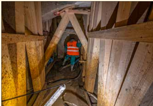
Podopření kleneb suterénu východního křídla
