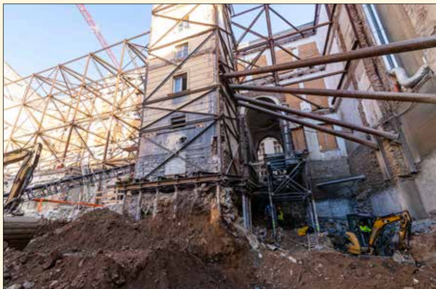
Těžba v prostoru MP bárek u průjezdu a schodišťové věže
