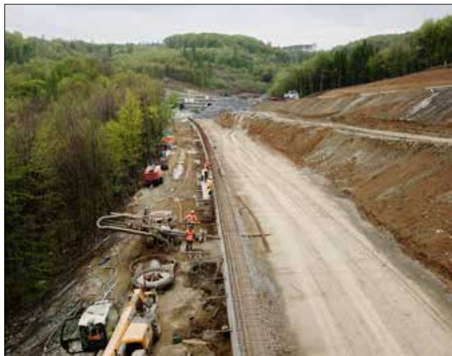
Fáze výstavby terénních zářezů před tunelem Prešov, vlevo na fotografii je zachyceno kotvení opěrné stěny SO 243
