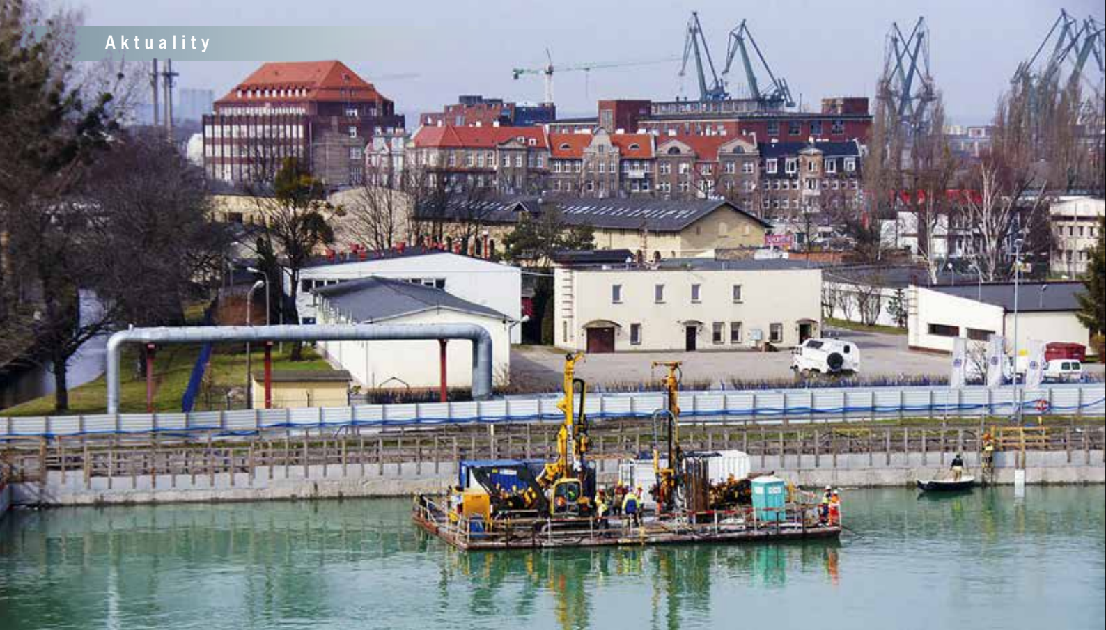
Vytěžená stavební jáma s pontony
