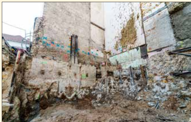
Pohled na žlb. zeď s ocelovým nosníkem podírajícím klenbový pas nunciatury
