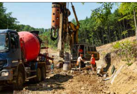
Fáze výstavby zárubní pažicí pilotové zdi objektu SO 242
