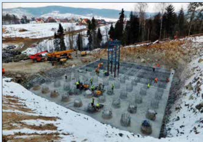
Pilotový základ pilíře č. 7L + 7P na mostě č. 21
