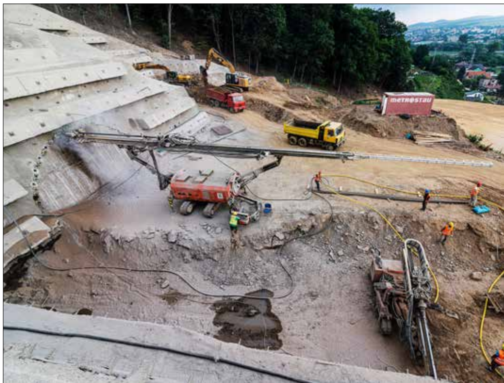
Provádění mikropilotového dešťníku na pravé tunelové troubě východního portálu tunelu Prešov
