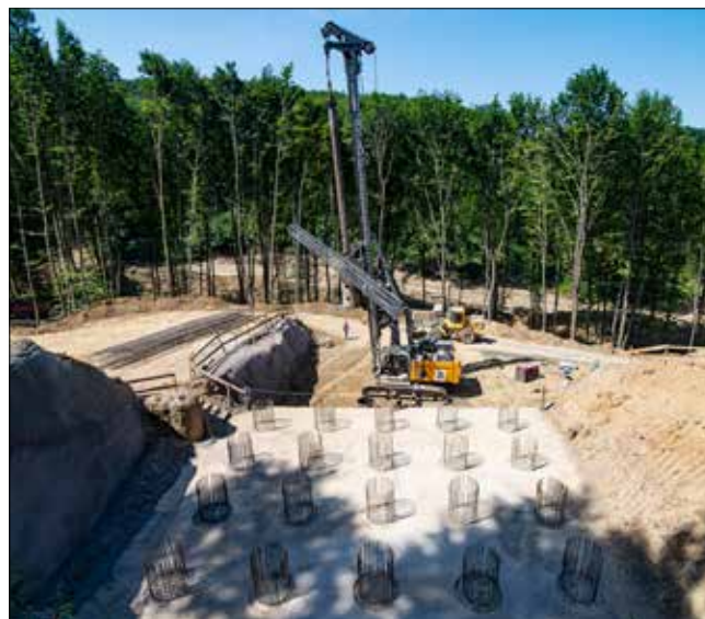
Provádění pilotového založení na jednom z pilířů mostu přes údolí Malkovského potoka (SO 203) vrtnou soupravou Liebherr LB24
