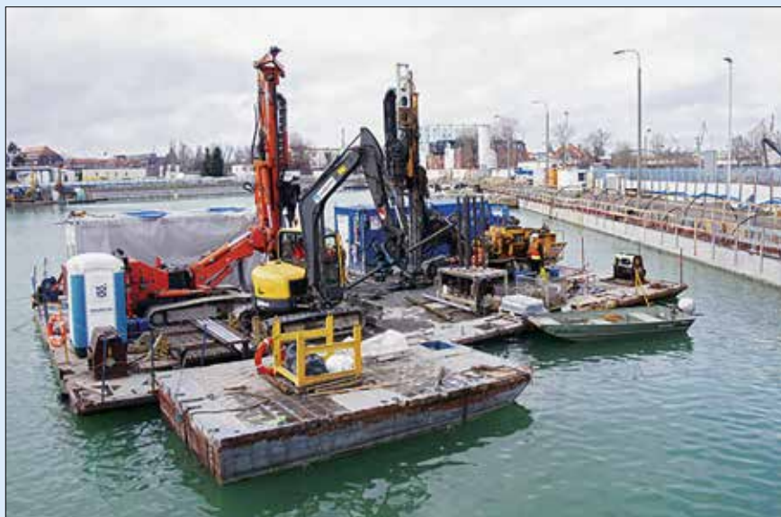
Ponton s kompletním zařízením pro instalaci mikropilot
