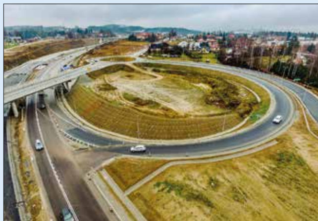
Terénní zářezy v blízkosti obce Rabka s pružným i pevným povrchem
