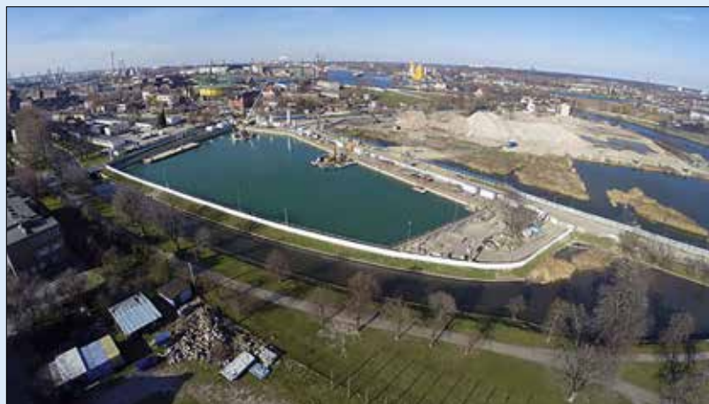
Letecký pohled na zatopené staveniště
