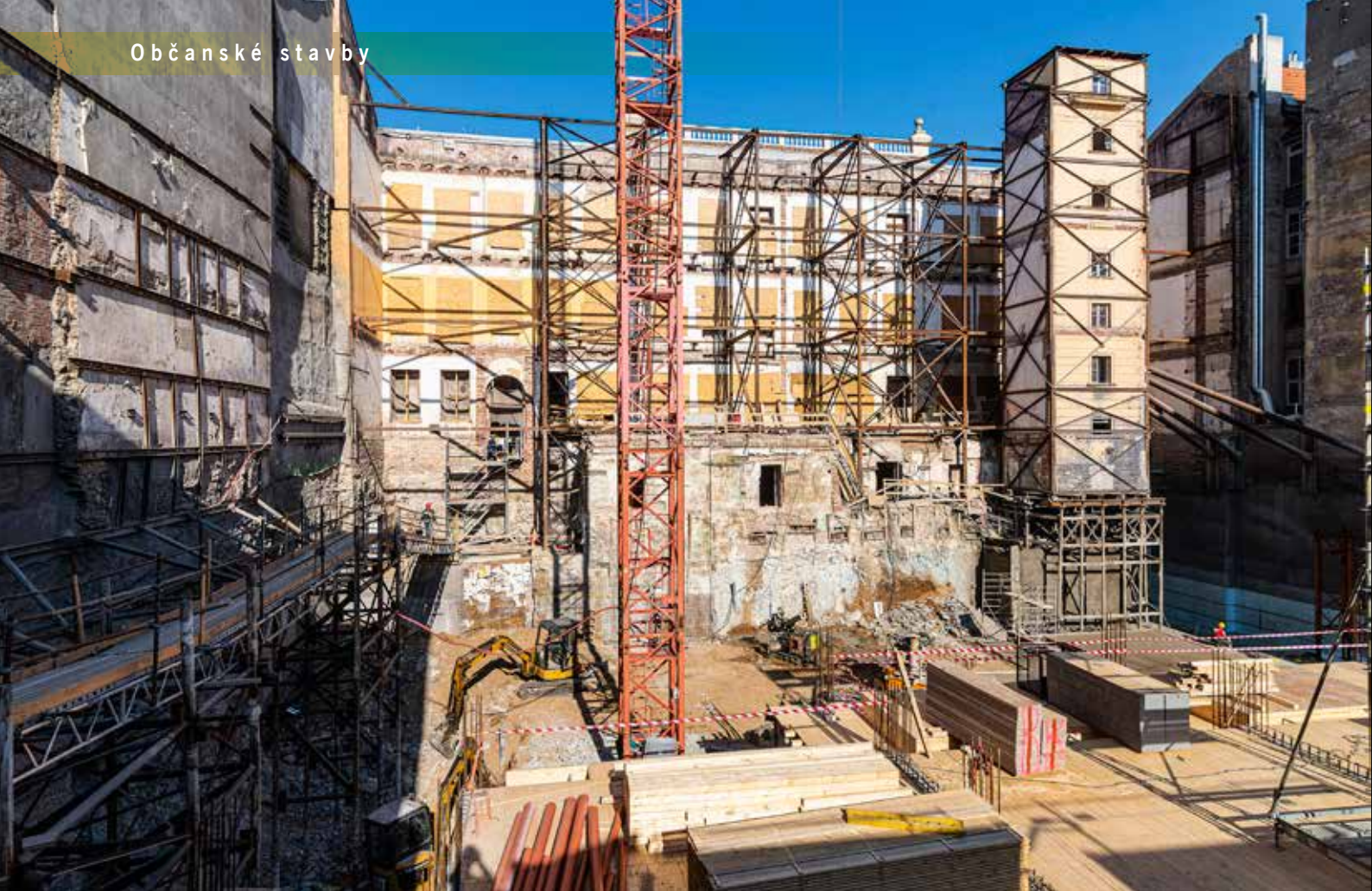
Celkový pohled do vytěžené a zapažené stavební jámy, fasáda do ulice Mikulandská je zajištěna ocelovými konstrukcemi
