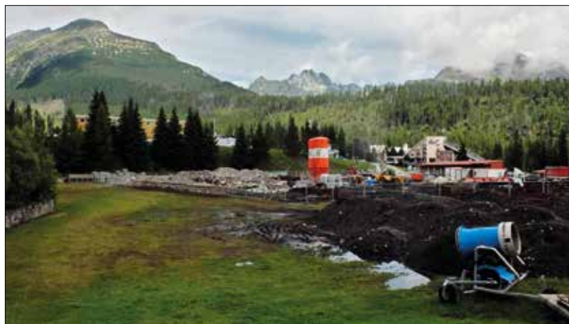
Celkový pohled na staveniště
