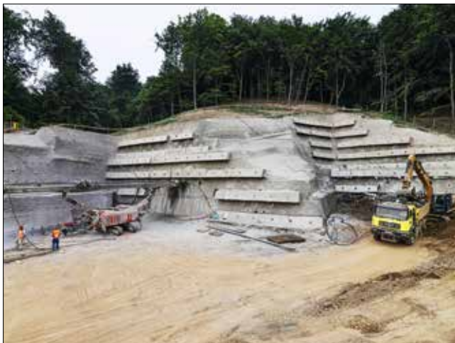
Provádění mikropilotového dešťníku a osazování hřebíků na východním portálu tunelu Prešov
