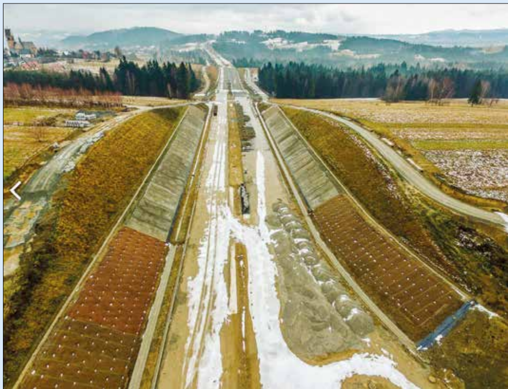
Terénní zářezy v blízkosti obce Rabka s pružným i pevným povrchem
