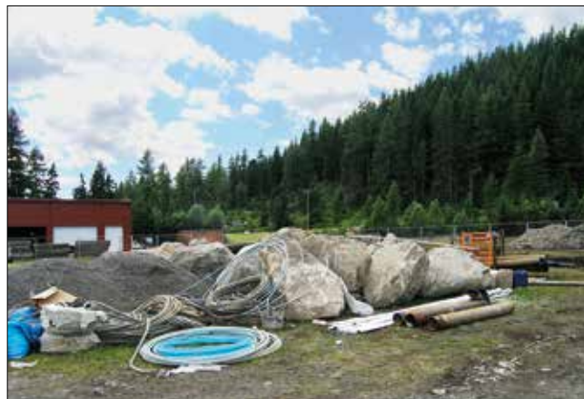
Balvany granodioritu, které byly vytěženy při snižování pracovní úrovně pro založení věže
