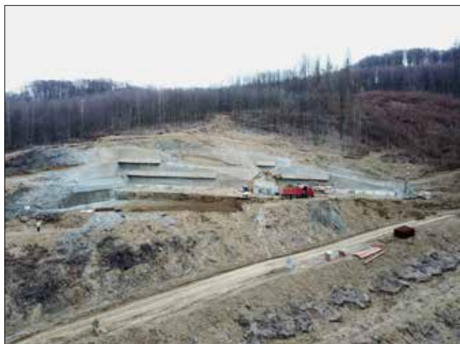
Fáze výstavby západního portálu tunelu Prešov
