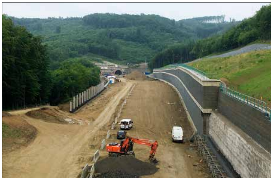
Opěrná stěna SO 243 (vlevo) a zárubní stěna SO 235 (vpravo), pohled směrem k tunelu Prešov
