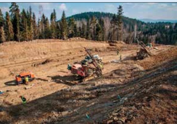
Zajišťování svahů s povrchem z pružných rohoží v blízkosti obce Rabka
