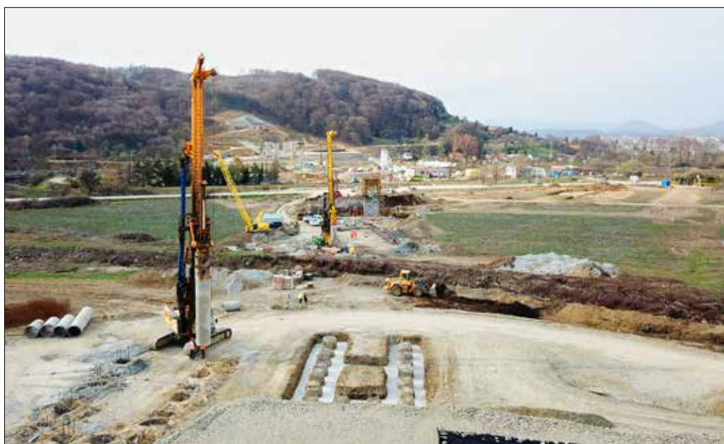
Pilotové zakládání mostu SO 206 navazujícího na jihu na východní portál tunelu Prešov (založení výroby mostovky)
