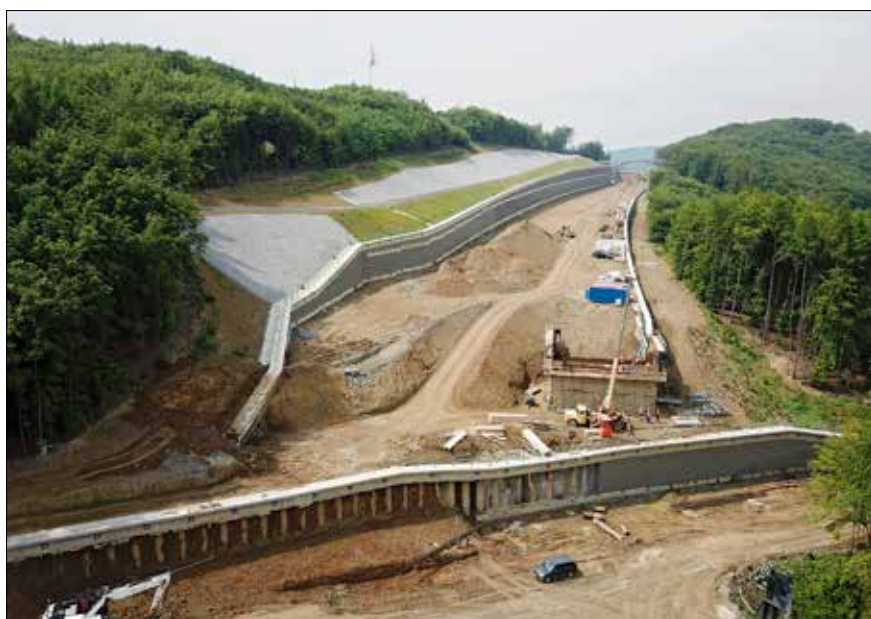
Pohled od západního portálu tunelu Prešov směrem k terénním zářezům a mostu SO 205, dole zárubní pilotová zeď obslužné komunikace tunelu SO 242
