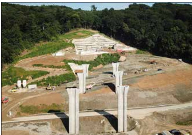
Východní portál tunelu Prešov s pilíři navazujícího mostu
