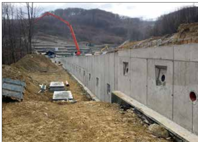
Kotvená žlb. stěna navazující na pilotovou stěnu před osazením a napnutím trvalých 5pramencových kotev, SO 243
