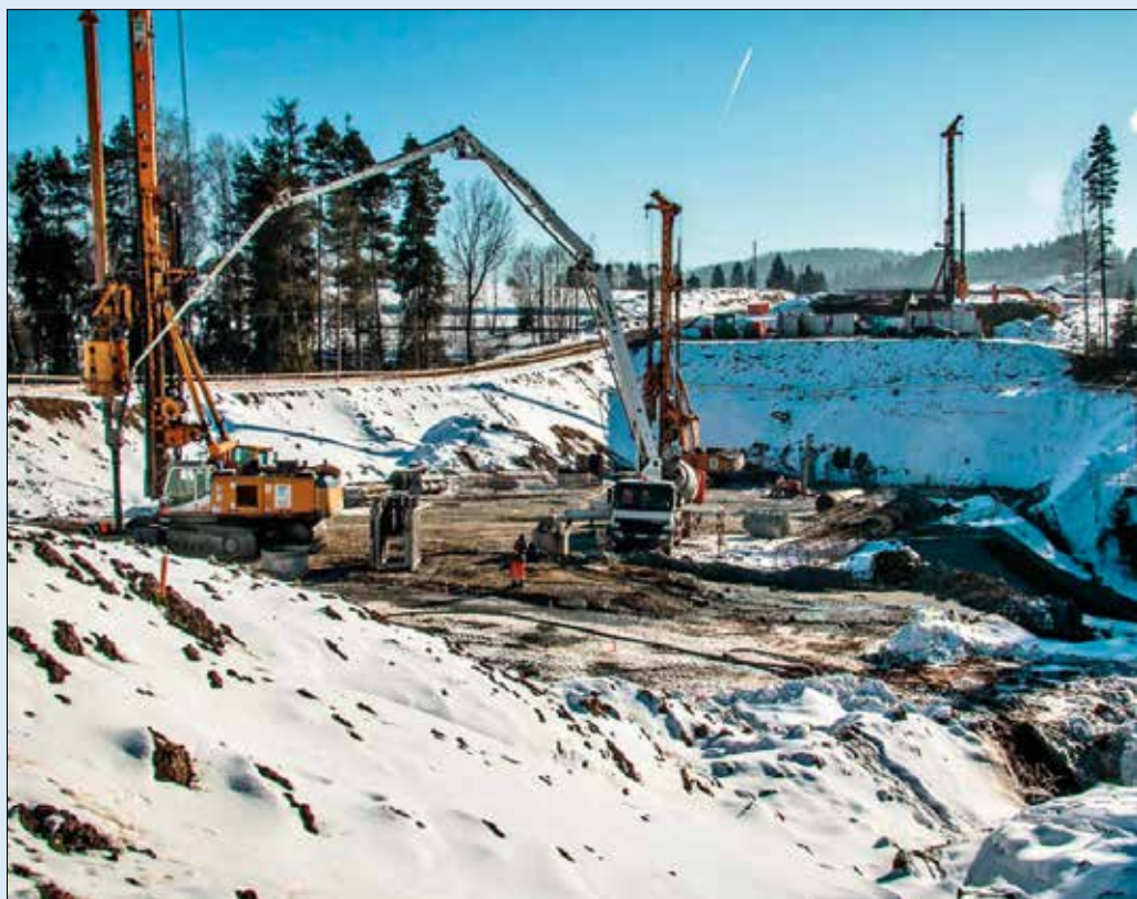
Pilotové zakládání pilířů č. 3L + 3P na objektu č. 21
