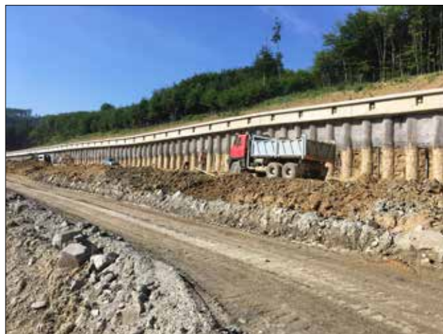
Zemní práce na lici zárubní zdi, SO 235
