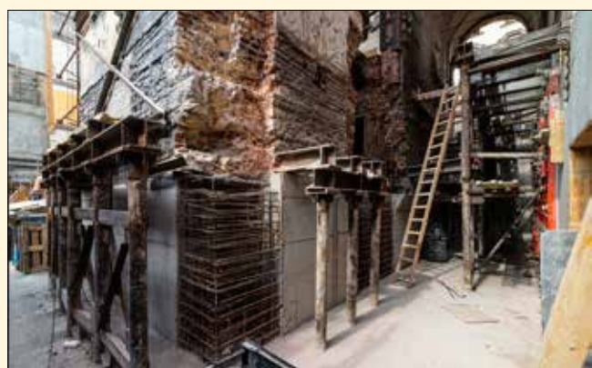
Nově podbetonovaná schodišťová šachta zvenčí a zevnitř
