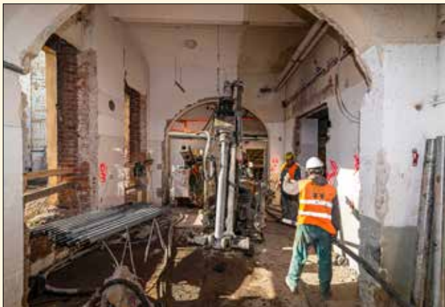
Provedení tryskové injektáže ve východním křídle
