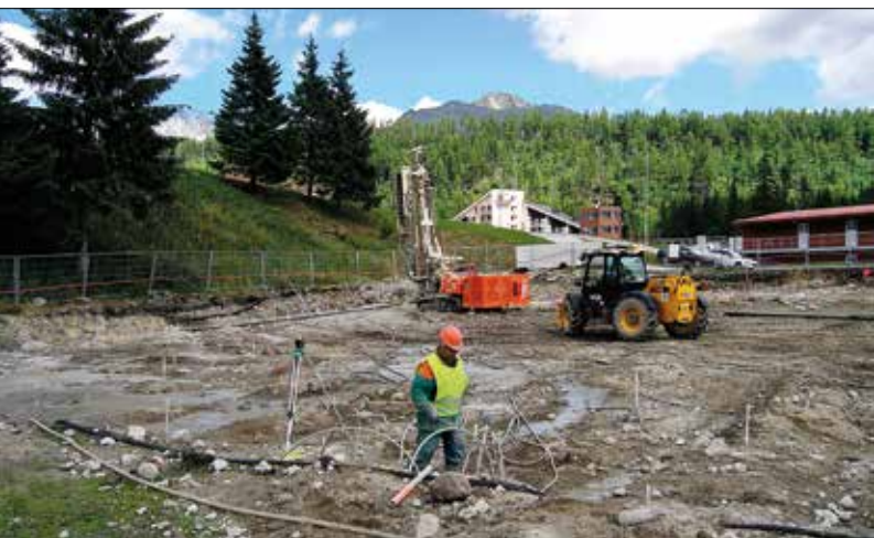
Realizace injekčních vrtů vrtnou soupravou Hütte HBR 610
