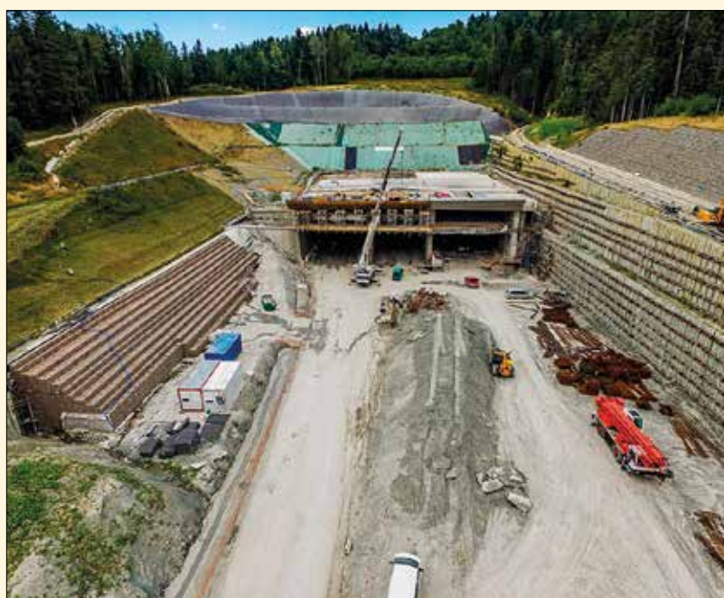
Jižní portál tunelu nově zajištěný monolitickou konstrukcí galerie
