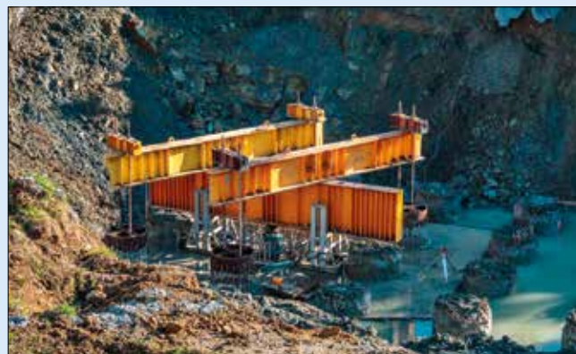
Zkouška pilot na jednom z pilířů zatěžovacím mostem
