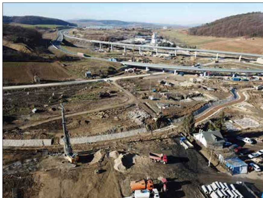
Křižovatka Vydumanec, probíhá pilotové zakládání třemi vrtnými soupravami, pohled k severovýchodu
