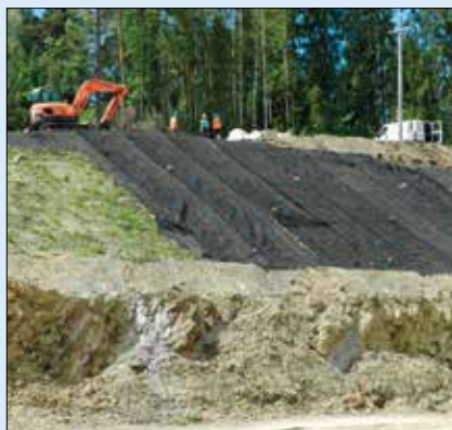
Zajišťování svahů s povrchem z pružných rohoží v blízkosti obce Rabka
