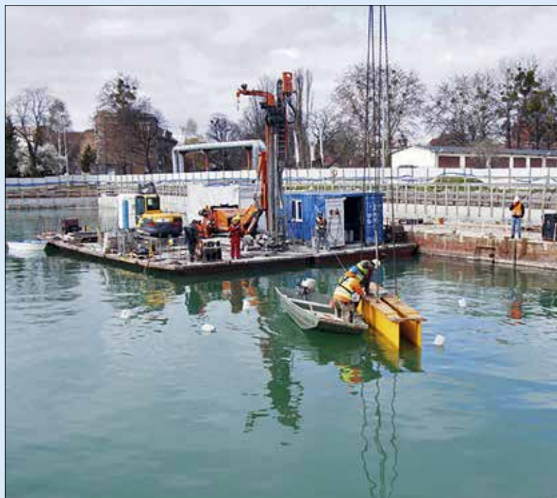
Spuštění ocelového reakčního rámu do vody
