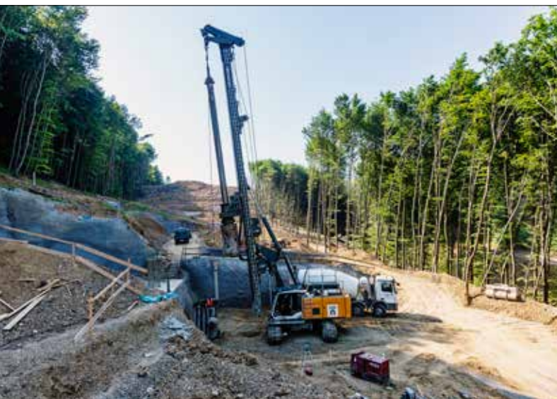
Provádění pilotového založení na jednom z pilířů mostu přes údolí Malkovského potoka (SO 203) vrtnou soupravou Liebherr LB24
