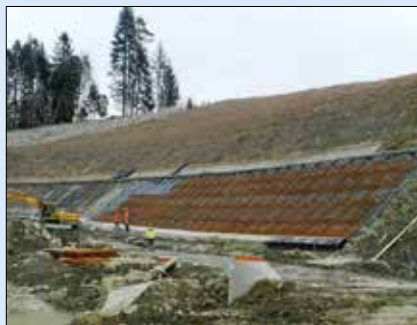
Postup prací při zajišťování svahů s pružným i pevným povrchem u obce Skomielna Biała
