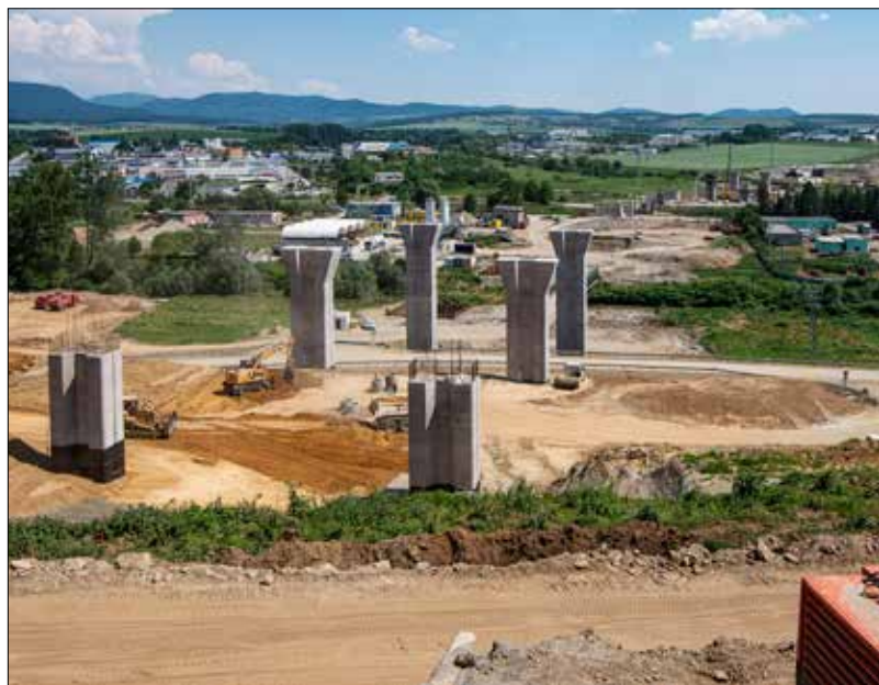
Dokončené pilíře mostu SO 206
