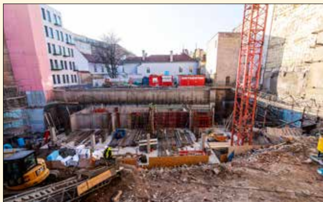
Pohled na objekt podzemních garáží s dočasně umístěným zařízením staveniště. V této části začaly práce na monolitech v předstihu.
