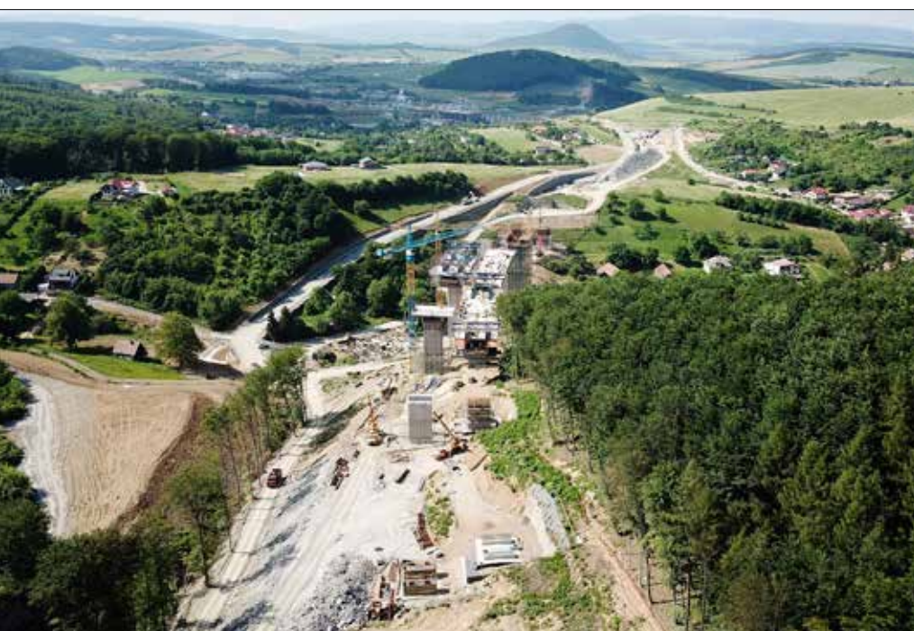
Výstavba pilířů a mostovky na mostě přes údolí Malkovského potoka, SO 203
