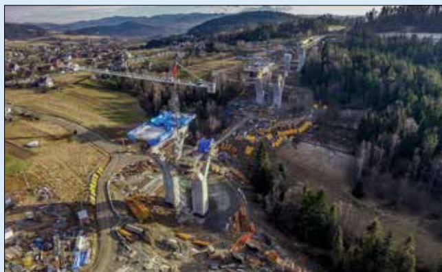
Objekt č. 21, zárodky pilířů pro letnou betonáž
