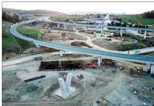
Dvě fáze výstavby křižovatky Vydumanec, vlevo je zachycena štětovicová jámka pro sružený základ pilíře č. 8 s celkem 60 ks pilot (SO 201).
