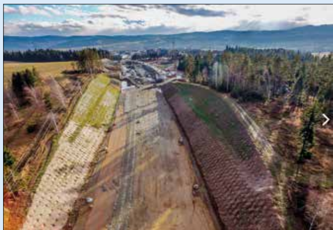
Terénní zářezy v blízkosti Chabówka s povrchem z pružných rohoží
