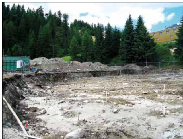
Snížená pracovní úroveň s probíhající stabilizační horninovou injektáží
