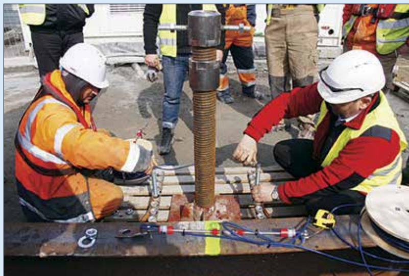
Trénink na suchu – sestavení zatěžovací zkoušky
