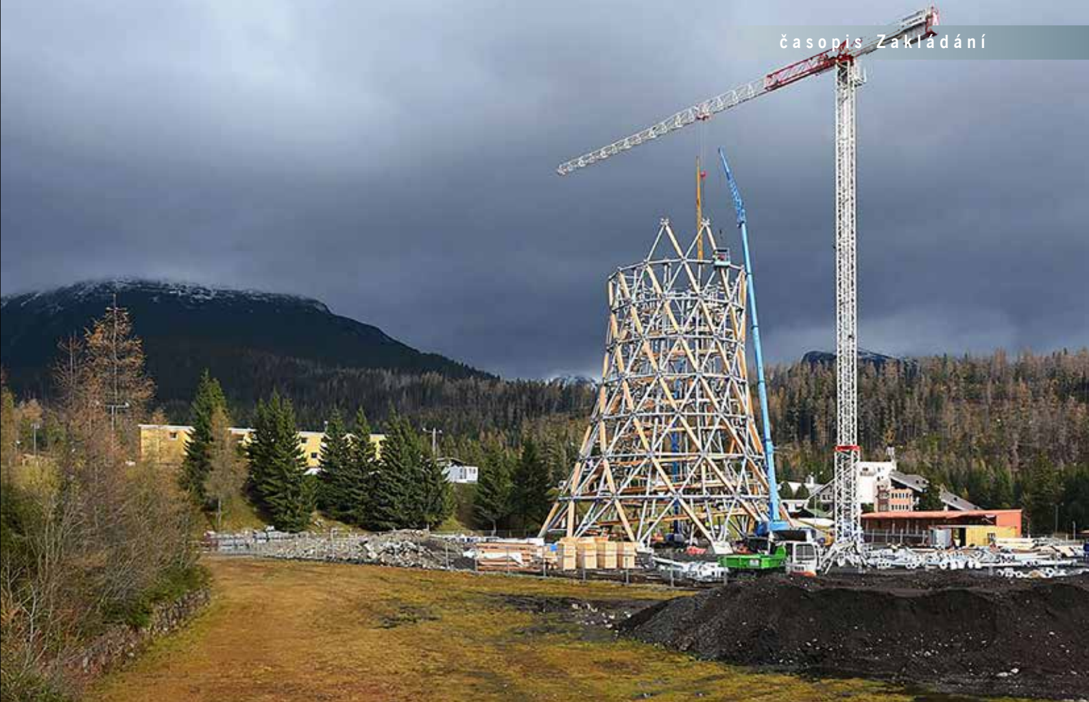
Pohled na výstavbu ocelové konstrukce věže
