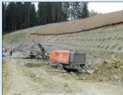
Postup prací při zajišťování svahů s pružným i pevným povrchem u obce Skomielna Biała
