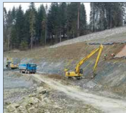
Zajišťování svahů s pružným i pevným povrchem u obce Skomielna Biała
