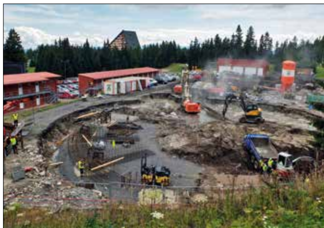
Realizace mikropilotového založení
