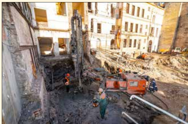
Práce na MP bárkách pro zajištění fasády objektu Drn
