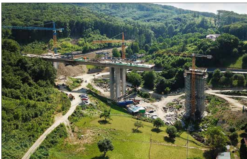
Most přes údolí Malkovského potoka v době výstavby mostovky, SO 203
