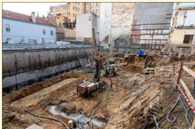
Realizace základových sloupů TI
