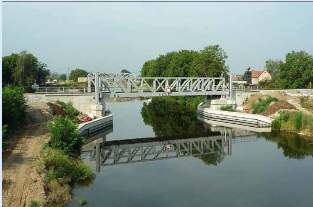
Železniční most v Lužci po dokončení
