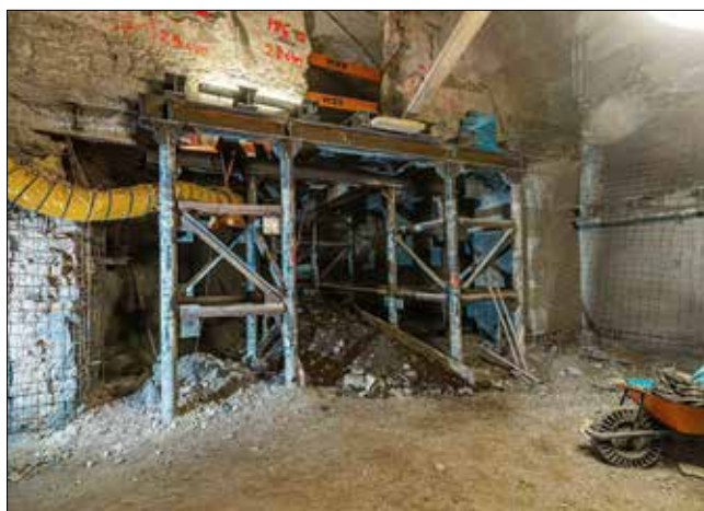
Mikropilotové bárky v objektu C1 na snímcích v časovém odstupu několika měsíců
