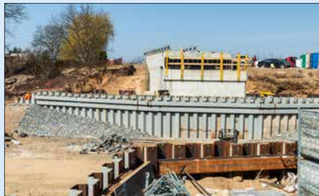
Železniční most v Lužci, úprava břehu kanálu pomocí trvalé štětové stěny v místě nových mostních opěr
