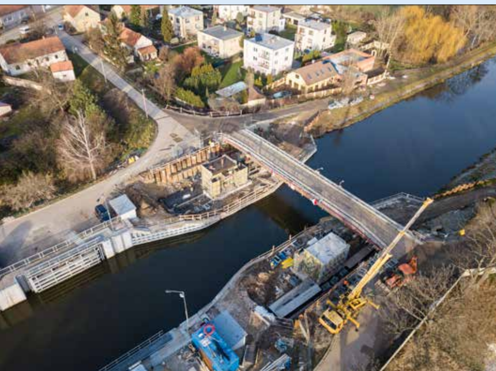
Silniční most ve Vraňanech, realizace nových opěr a provizorní přemostění
