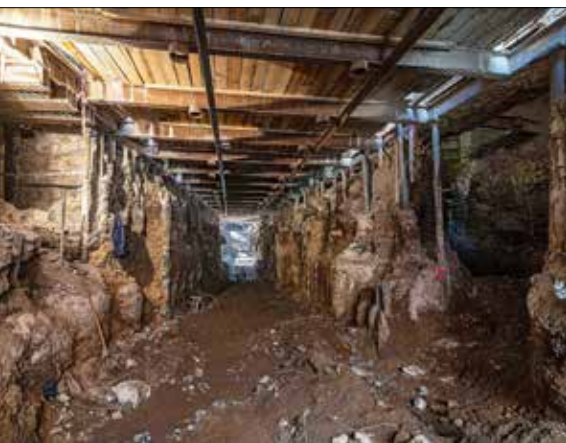
Postup zajištění výkopových prací technologiemi tryskové injektáže, mikropilot, kotev, rozpěr a stříkaného betonu v jižní části objektu Y
