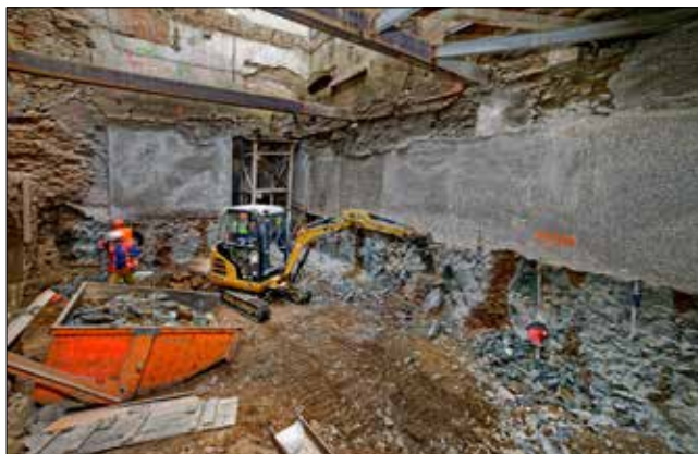
Úprava sloupů tryskové injektáže před realizací stříkaných betonů v objektu E
