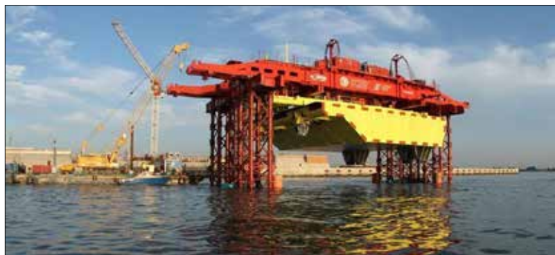
Plavidlo na přepravu a osazení pohyblivé části
