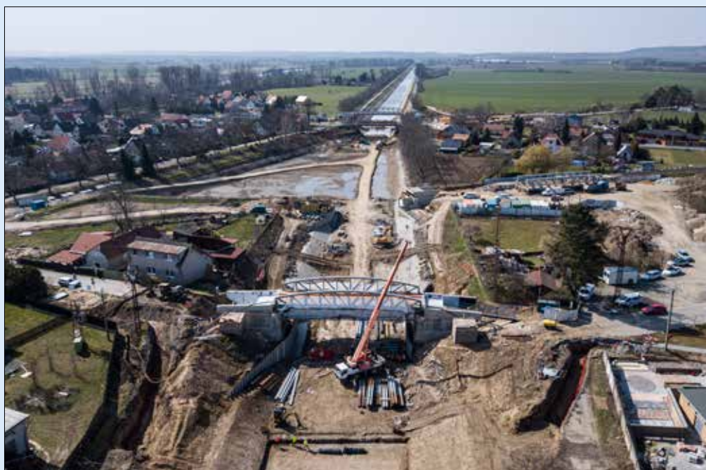
Silniční most v Lužci, beranění trvalých štětovnic
