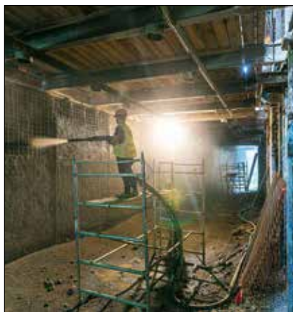
Postup zajištění výkopových prací technologiemi tryskové injektáže, mikropilot, kotev, rozpěr a stříkaného betonu v jižní části objektu Y
