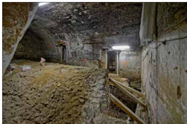
Historické sklepy v rekonstruovaném objektu E
