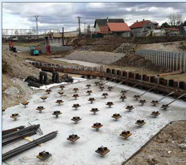
Železniční most v Lužci, mikropilotové založení nové opěry
