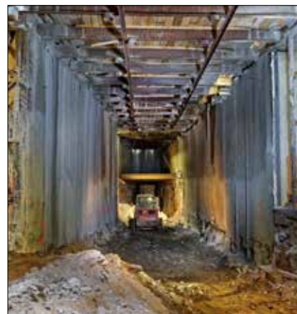
Postup zajištění výkopových prací technologiemi tryskové injektáže, mikropilot, kotev, rozpěr a stříkaného betonu v jižní části objektu Y
