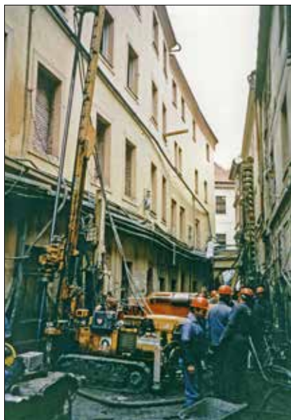
Provádění prací speciálního zakládání v objektu Y při zahájení rekonstrukce v 90. letech minulého století.
