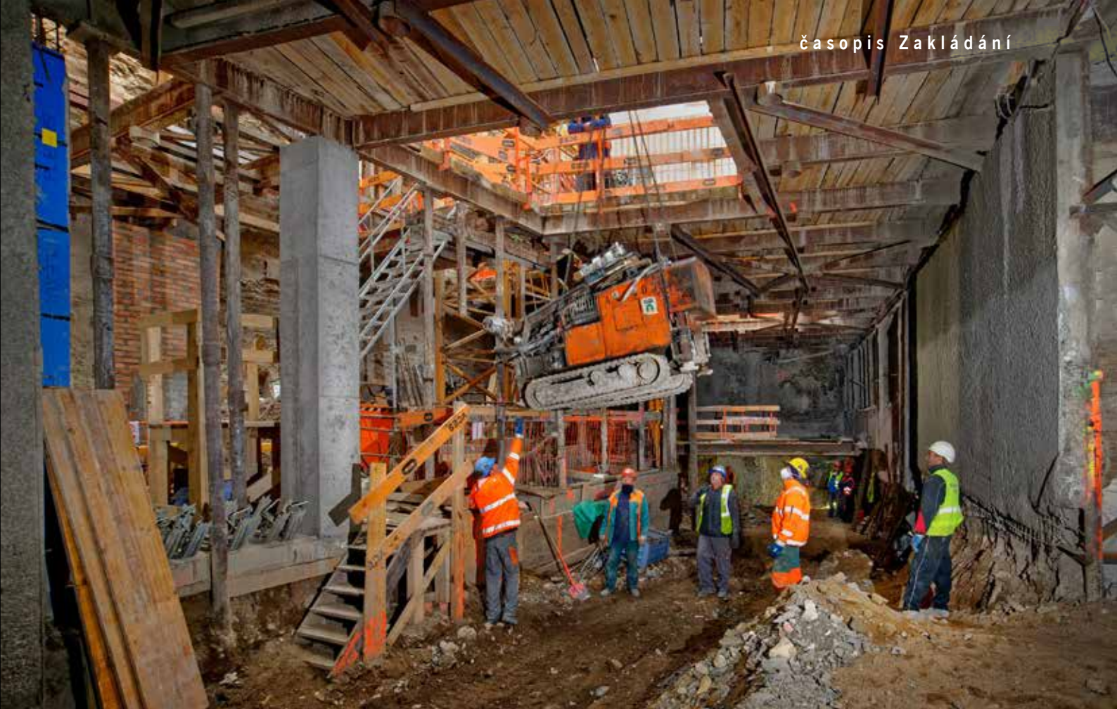
Spouštění vrtné soupravy stacionárním jeřábem J1 přes částečně rozebranou rozpěrnou pracovní plošinu v objektu Y
