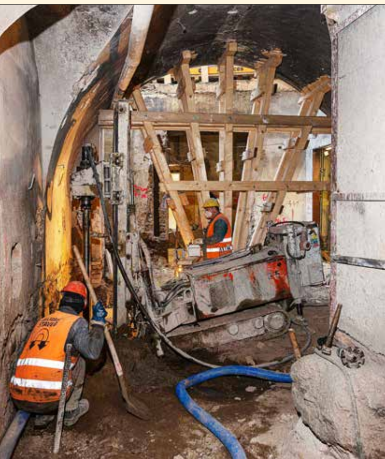
Realizace sloupů tryskové injektáže ve stísněných prostorech jednotlivých sekcí v budově B malou vrtanou soupravou
