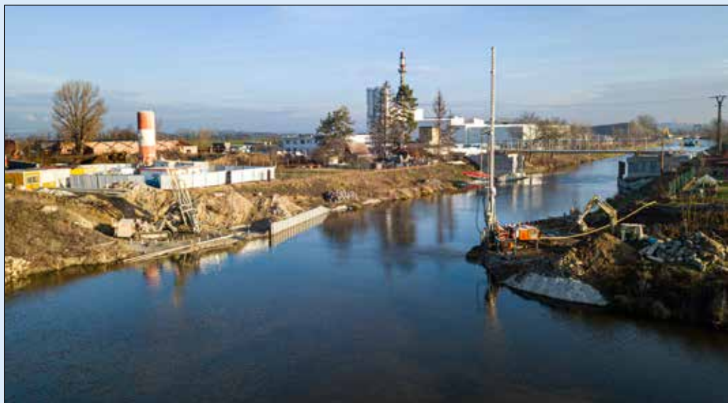
Železniční most v Lužci, oboustranné zakládání opěr mostu na sloupech tryskové injektáže s mikropilotami
