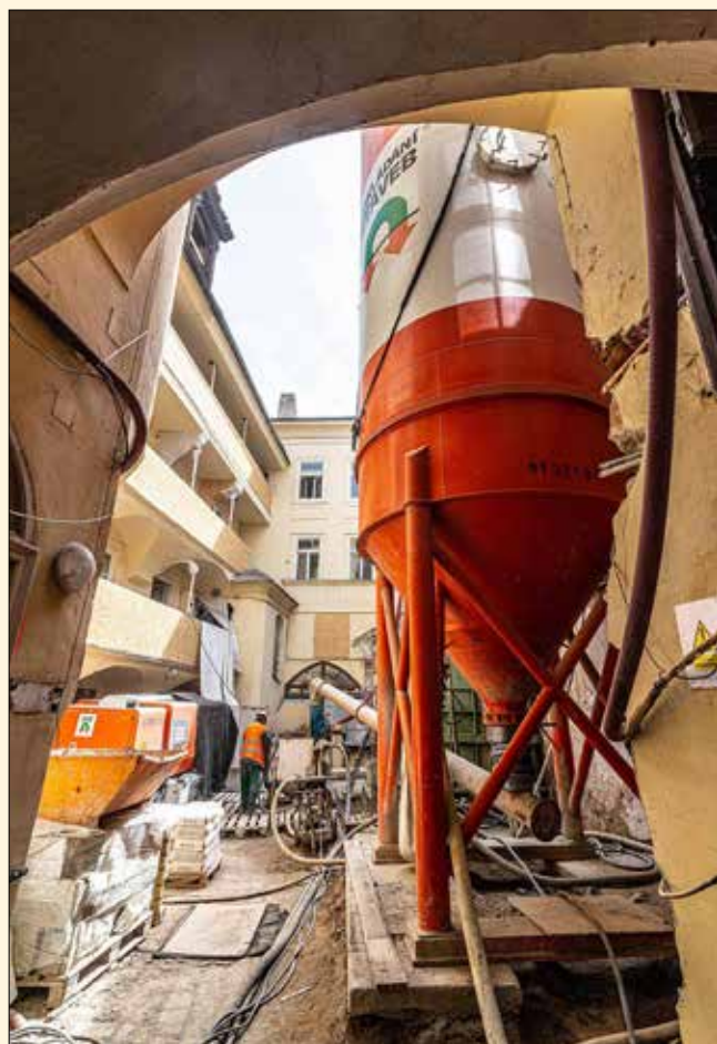
Zázemí pro druhou technologii tryskové injektáže se podařilo umístit do dvora jednoho ze sousedních domů
