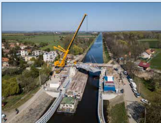
Silniční most ve Vraňanech, osazování nové ocelové konstrukce mostu
