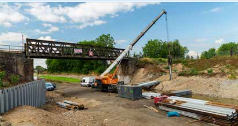
Železniční most v Lužci, beranění křídla štětové stěny
