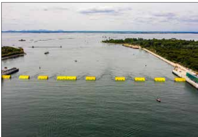
Postupné vztyčování bariéry při zkoušce
