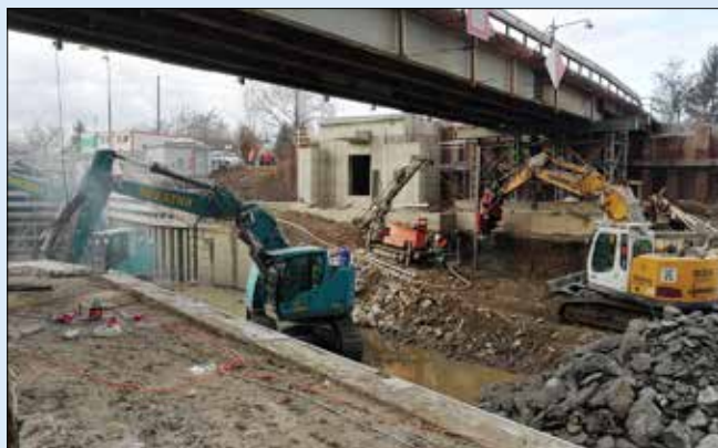
Silniční most ve Vraňanech, beranění mikrozápor beranidlem s bočním úchopem do předvrtů pod profilem mostního provizoria
