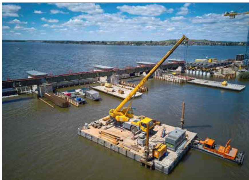
Přeprava stavební mechanizace na pontonové soupravě
