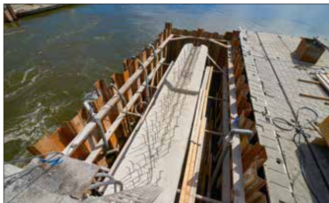
Příprava pilíře P3 pro armování úložného prahu
