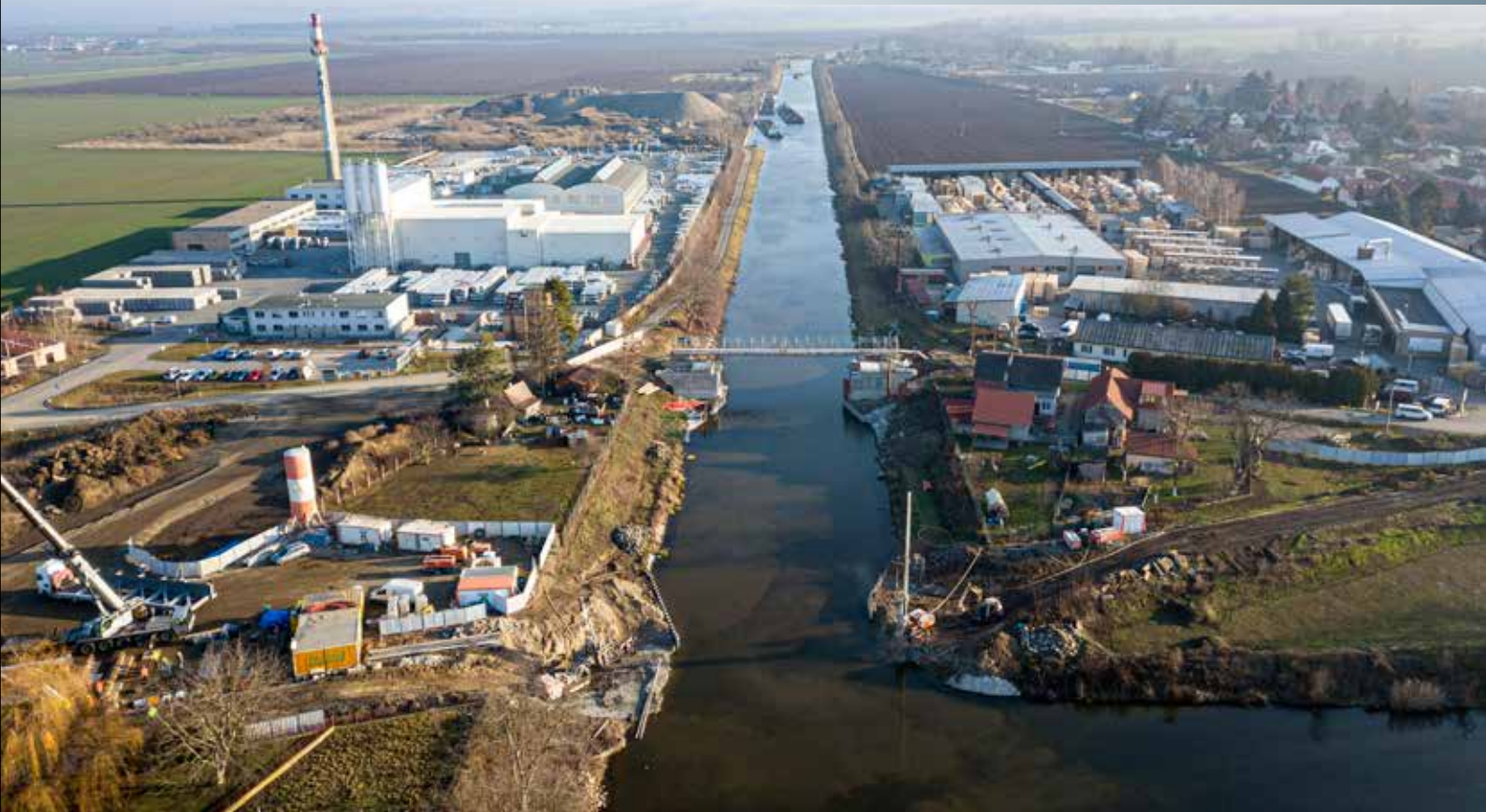
Pohled na plavební kanál v Lužci nad Vltavou směrem k Mělníku s probíhající rekonstrukcí silničního a železničního mostu (zcela dole)
