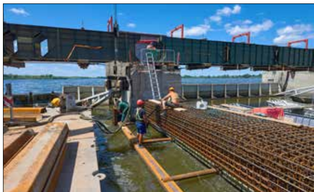
Armatura nového úložného prahu pilíře P2
