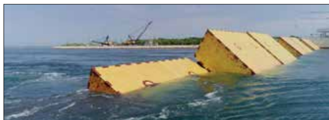
Vztyčování bariéry při zkoušce, detail
