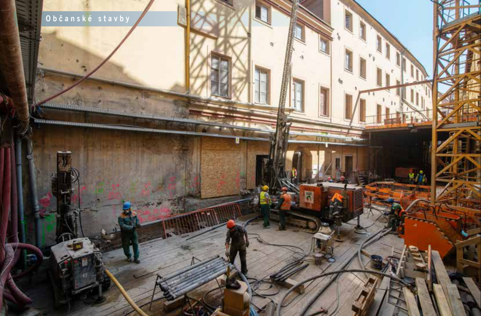
Realizace tryskové injektáže v objektu Y ze zesílené ocelové rozpěrné plošiny
