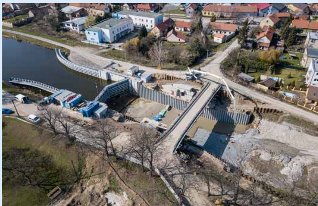
Silniční most ve Vraňanech, založení opěr a břehové úpravy před instalací nového zdvižného mostu
