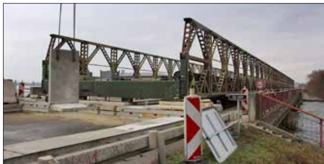
Mostní provizorium položené na původní most před zahájením rekonstrukce
