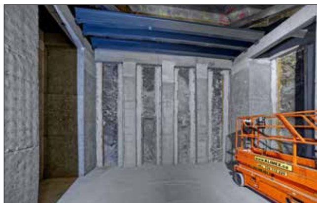
Závěrečná fáze výkopových prací a zajištění stěn stříkaným betonem
