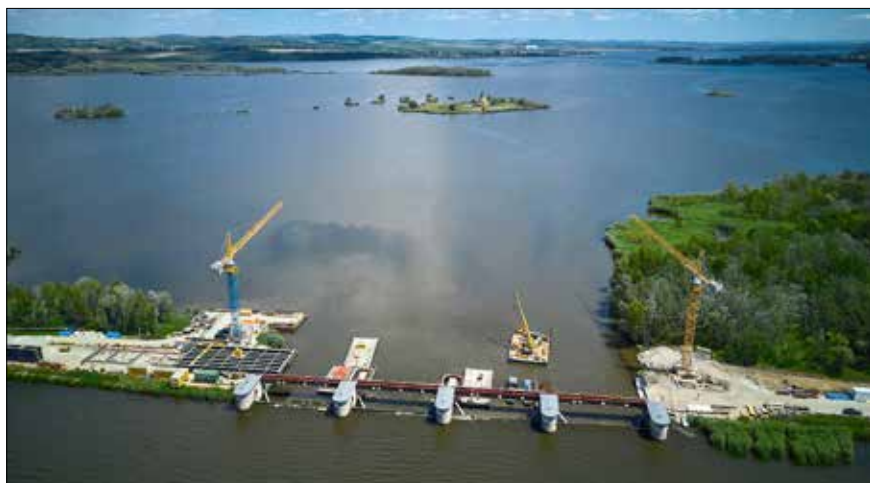
Pohled na střední nádrž s kostelem zatopené obce Mušov
