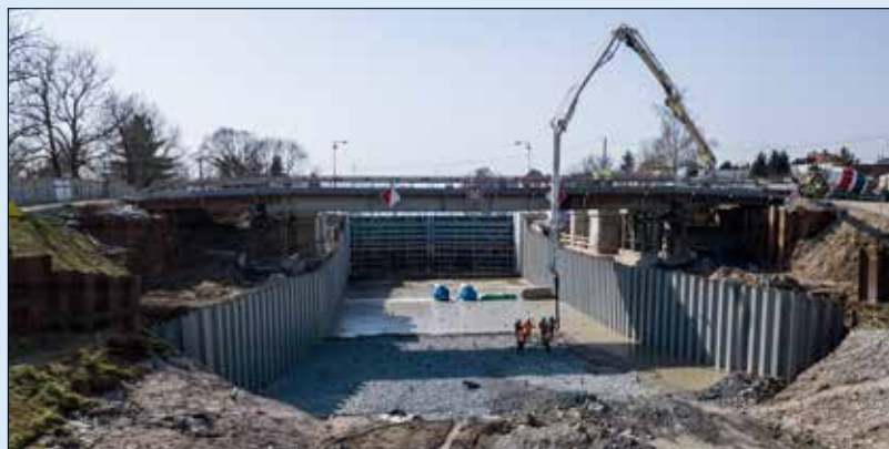
Silniční most ve Vraňanech, trvalé štětové stěny před instalací opeření během betonáže dna kanálu
