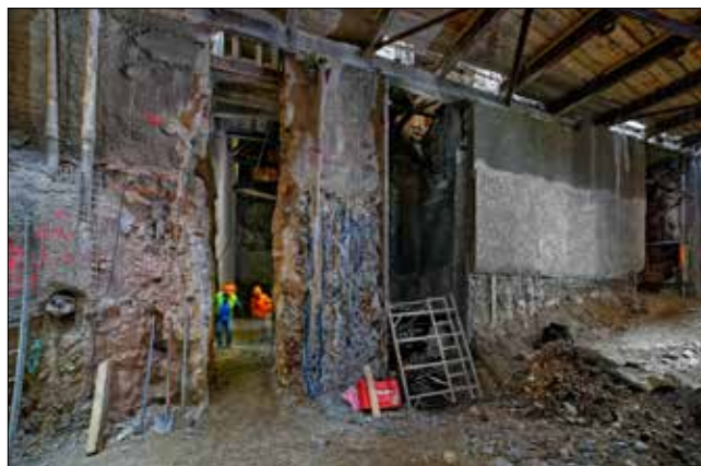
Postup zajištění výkopových prací technologiemi tryskové injektáže, mikropilot, kotev, rozpěr a stříkaného betonu v severní části objektu Y
