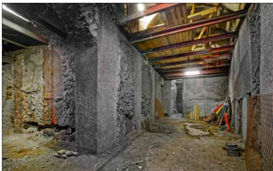
Dokončování stříkaných betonů na stěnách v dalších částech objektu B
