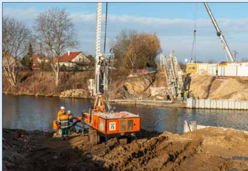
Železniční most v Lužci, zakládání opěr na sloupech tryskové injektáže s mikropilotami
