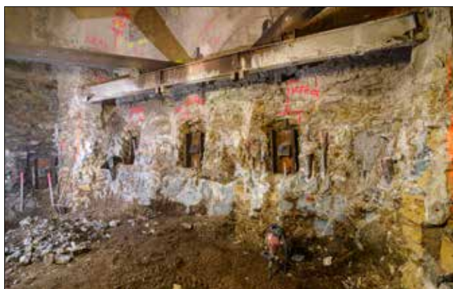
Zajištění výkopových prací v severní části objektu C
