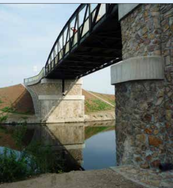
Nové opěry mostu v Chramostku zvýšené o 3,0 m oproti původnímu stavu
