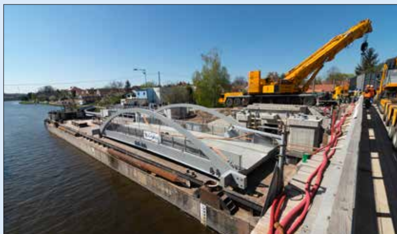
Silniční most ve Vraňanech, doprava ocelové konstrukce nového zdvižného mostu na tlačném člun Jantar 1000t f. Zakládání staveb
