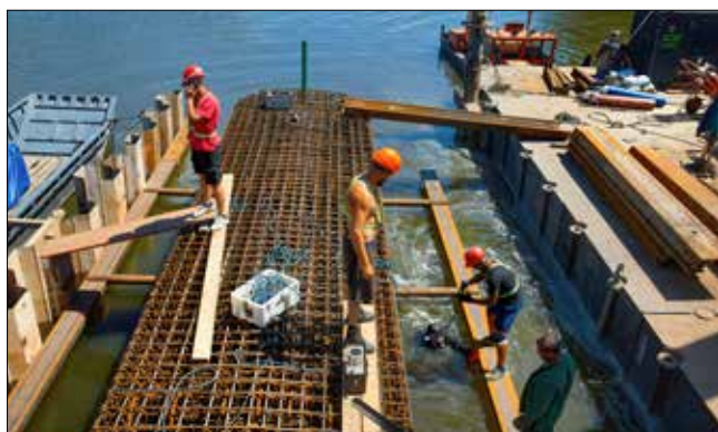
Práce při realizaci jímek za pomoci potápečů
