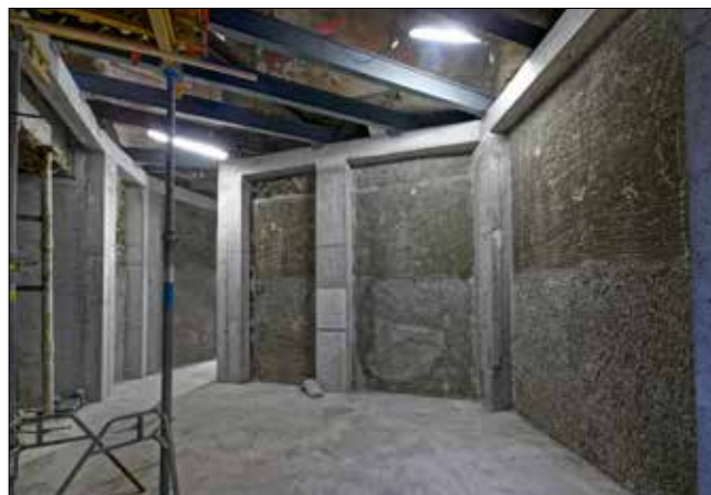
Závěrečná fáze výkopových prací a zajištění stěn stříkaným betonem
