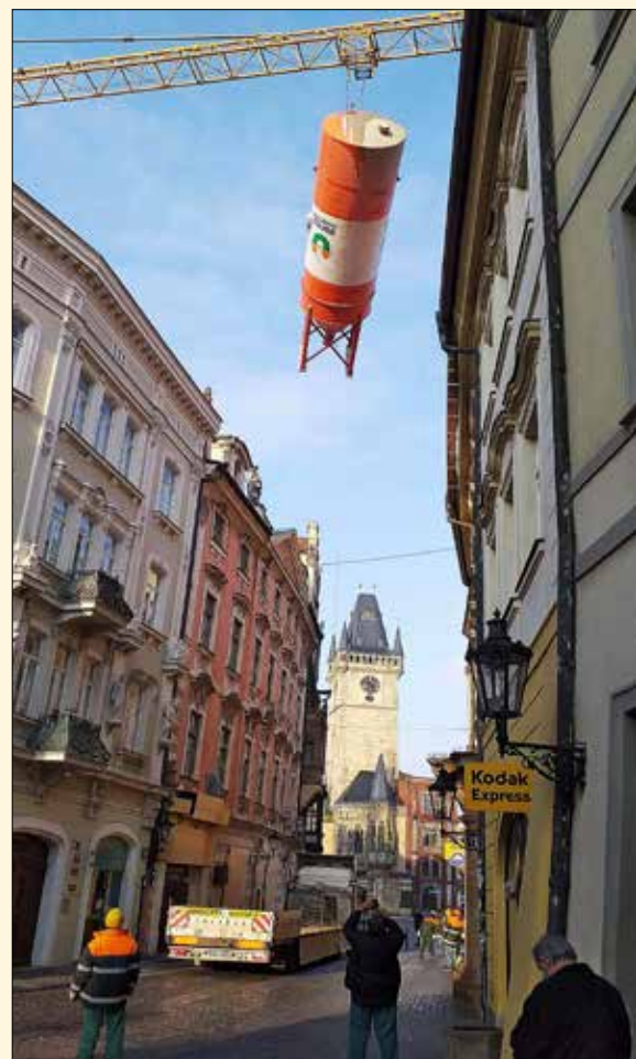
Transport 60t sila umožňujícího nasazení druhé technologie tryskové injektáže přes střechy staroměstských domů
