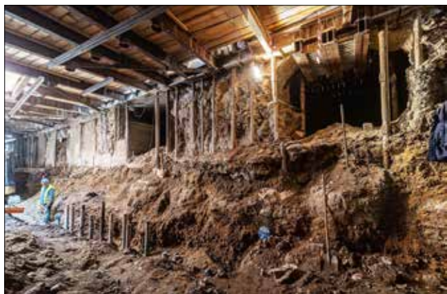
Postup zajištění výkopových prací technologiemi tryskové injektáže, mikropilot, kotev, rozpěr a stříkaného betonu v severní části objektu Y
