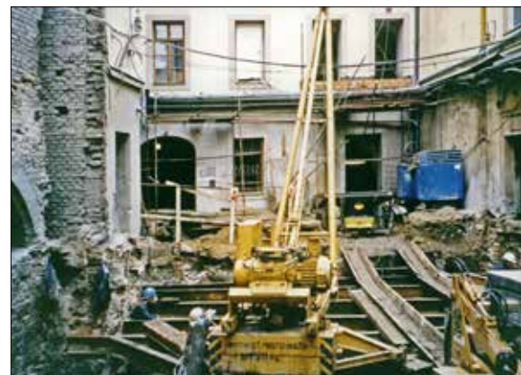
Provádění prací speciálního zakládání v objektu Y při zahájení rekonstrukce v 90. letech minulého století.
