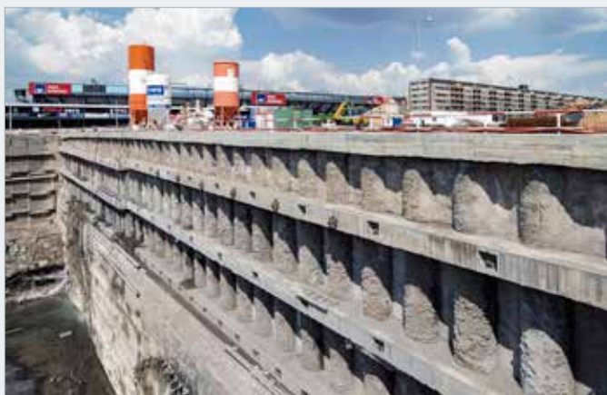
Portálová stěna tvořená vrtanými pilotami
