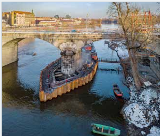
Sanační práce na pilíři P1
