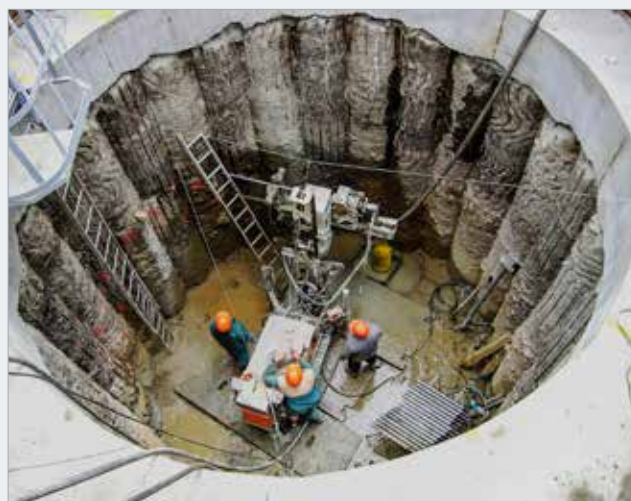
Provádění rozrážky z kruhové šachty z převrtávaných pilot
