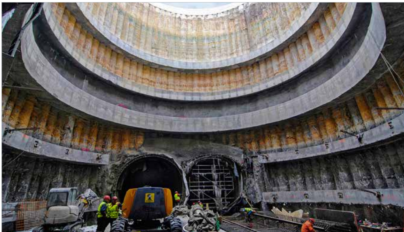
Montážní šachta z převrtávaných pilot, příprava na instalaci technologie TBM
