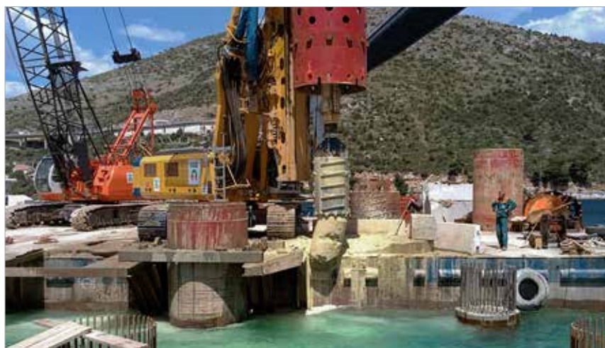
Vrtání dolomitu jádrovákem menšího průměru
