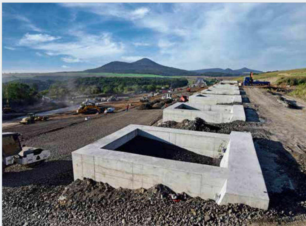
Ztužující věnce nad dokončenými statickými prvky
