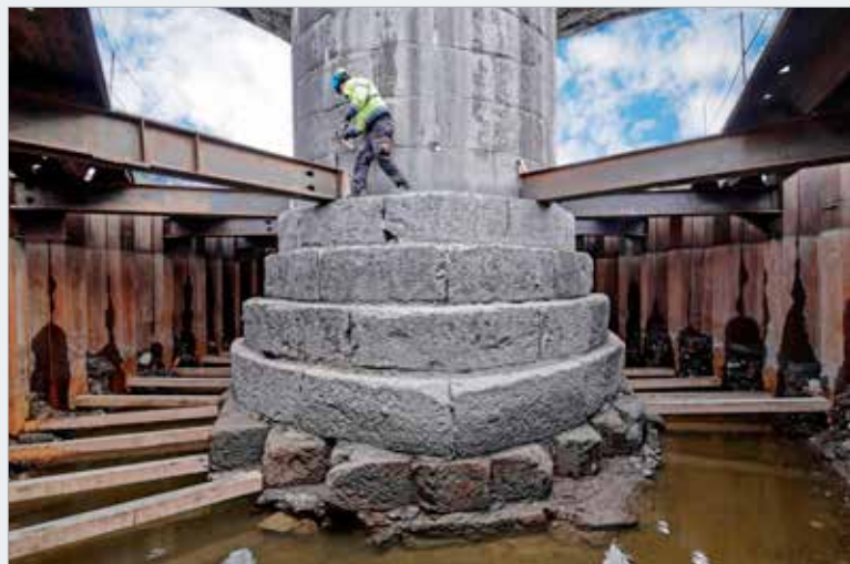
Obnažená základová konstrukce pilíře P2 uvnitř dvojité štětové jímky před zahájením sanačních prací
