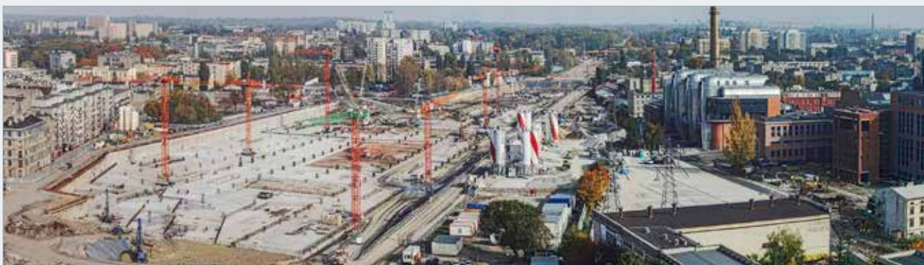
Pohled na dokončené podzemní konstrukce stanice a navazující úseky hloubených tunelů
