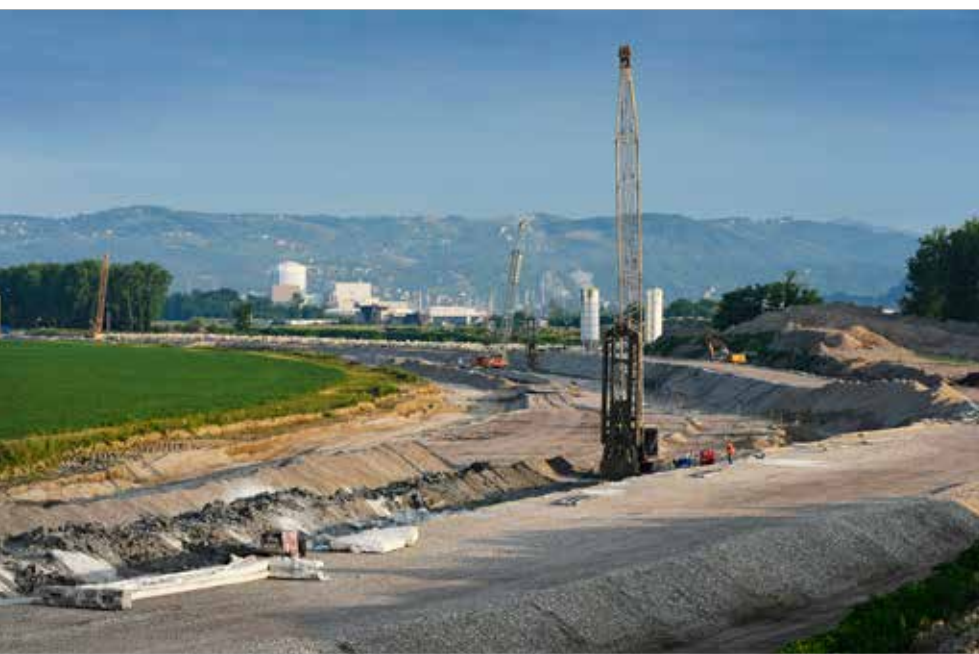
Střední úsek pravobřežní hráze pro HE Brežice s jadernou elektrárnou Krško v pozadí, práce na podzemní těsnicí jílocementové stěně
