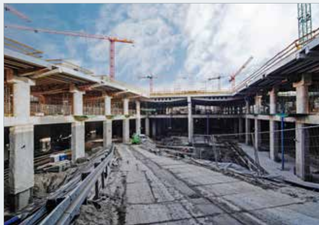
Centrální atrium: na konstrukce podzemních stěn navazuje výstavba dalšího podlaží
