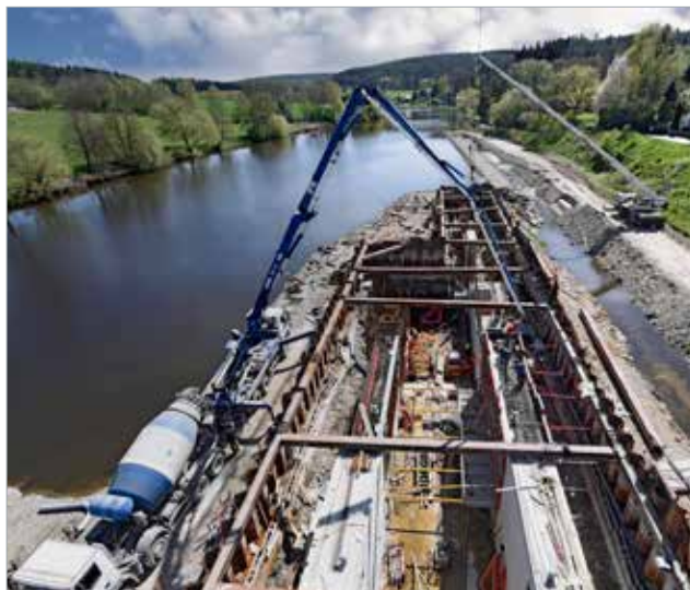
Betonáž vnitřních konstrukcí plavební komory na horní vodě v zajištěné jámě
