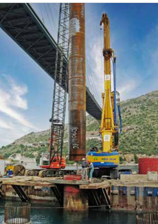
Osazování trvalé výpažnice prům. 1500 mm
