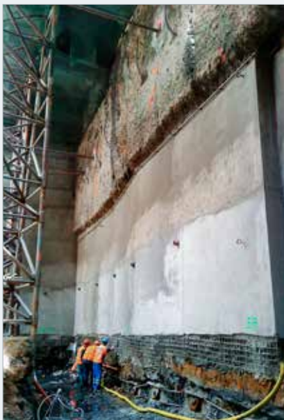
Dílčí výkop na 4. kotevní úrovni. Provádění opatření proti průsakům vody.
