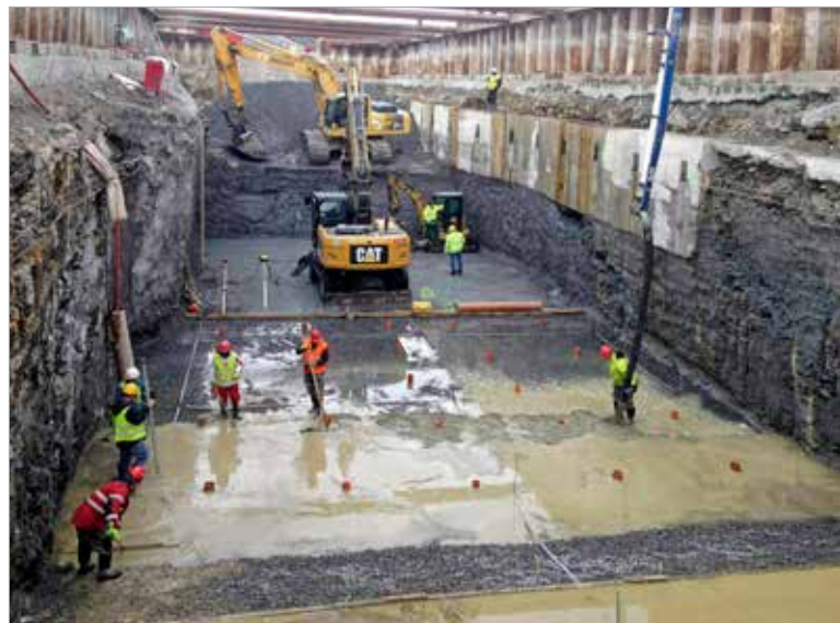
Betonáž základové desky v zajištěné stavební jámě
