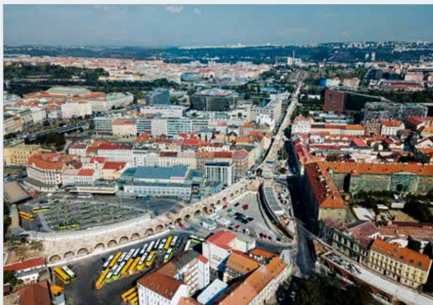
Negrelliho viadukt během rekonstrukce, na hlavní stavbu se zprava napojuje tzv. Karlínský spojovací viadukt
