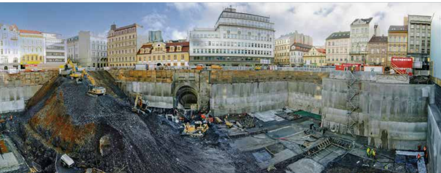
Celkový pohled na stavební jámu během odtěžování sjízdné rampy
