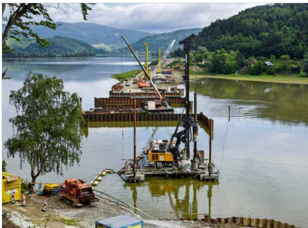
Pilotové založení pilíře P3 z pontonové plošiny, v pozadí montáž rozpěrného rámu vnitřní jímky P5
