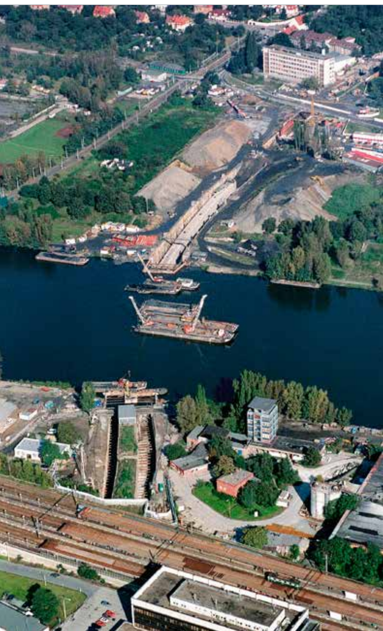
Pohled na stavbu směrem na trojskou stranu. Odshora dolů vidíme: suchý dok pro výstavbu tunelu, jímku Troja, těžbu v korytě řeky, jímku Holešovice, obrátové koleje metra s nově hloubenými úseky pro dva tubusy
