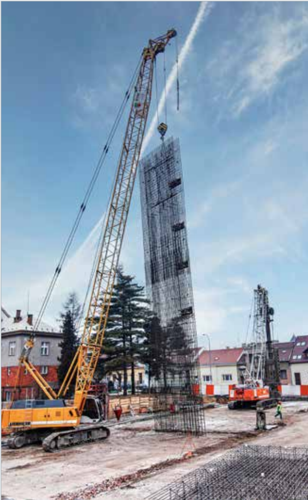
Provádění extrémně hlubokých podzemních stěn, osazování armokoše
