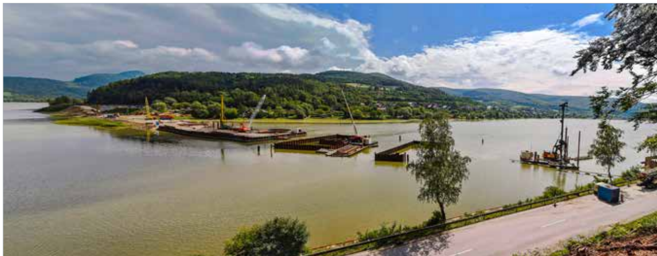
Současně prováděné štětové jímky a pilotové založení
