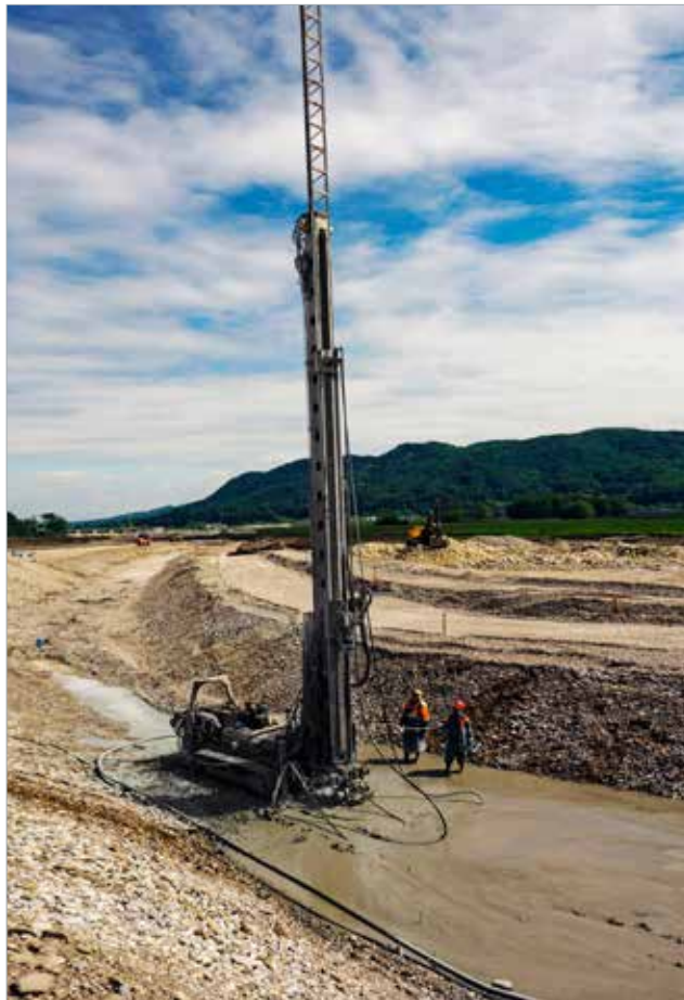
Provádění sanační tryskové injektáže
