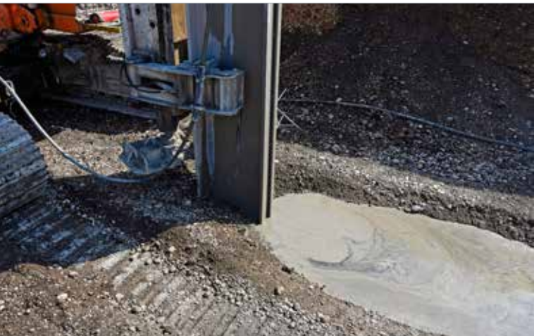
Vibrování I-profilu osazeného injekčními trubicami pro vytvoření tenké těsnicí podzemní stěny
