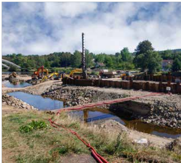
Provádění tryskové injektáže pod patou štětovnic
