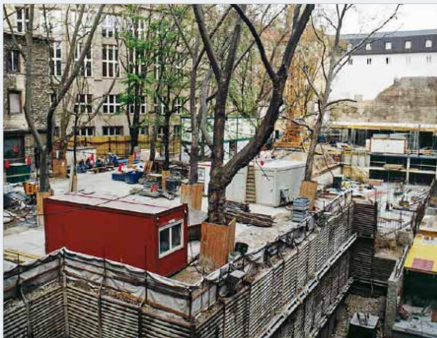
Pohled do vnitrobloku během výstavby železobetonových konstrukcí dvorních objektů
