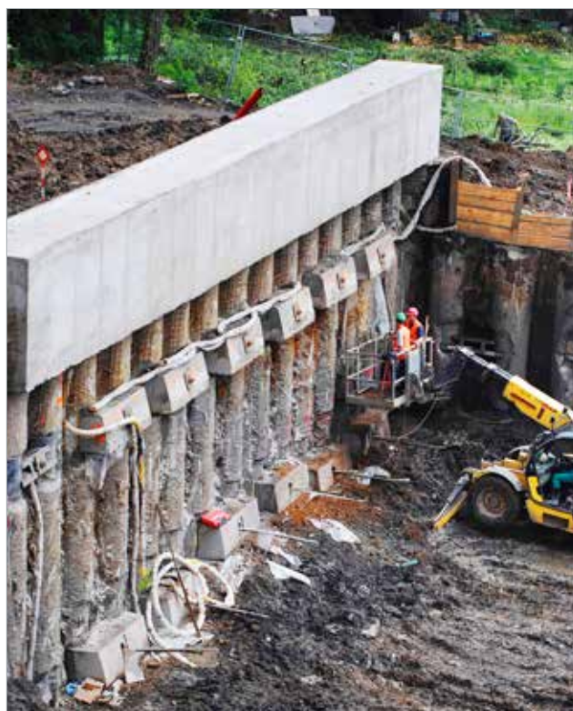
Napínání kotev na portálové stěně jámy
