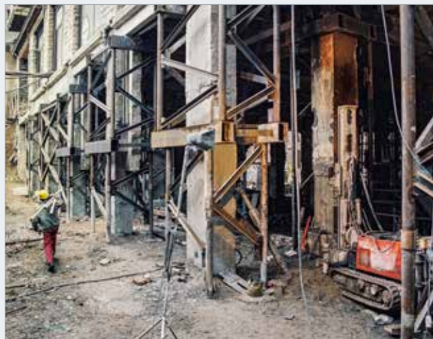
Souběžné provádění ocelových konstrukcí bárek a dokončování realizace mikropilotového podchycení
