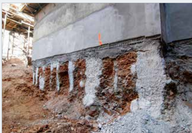
Dílčí výkopová úroveň a obnažené sloupky pažic T1
