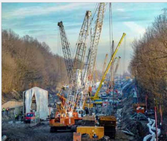
Nasazení čtyř bagrů a čtyř plazových jeřábů na výstavbě hloubeného tunelu (II. etapa)
