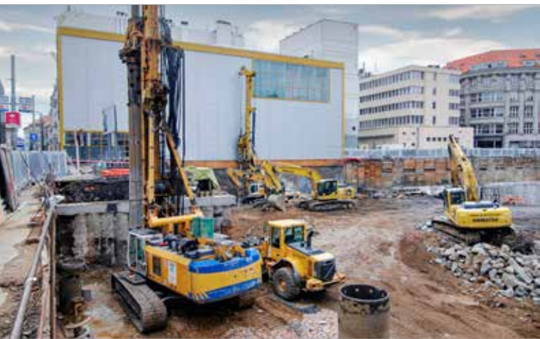
Provádění převrtávaných pilot u ulice Spálené
