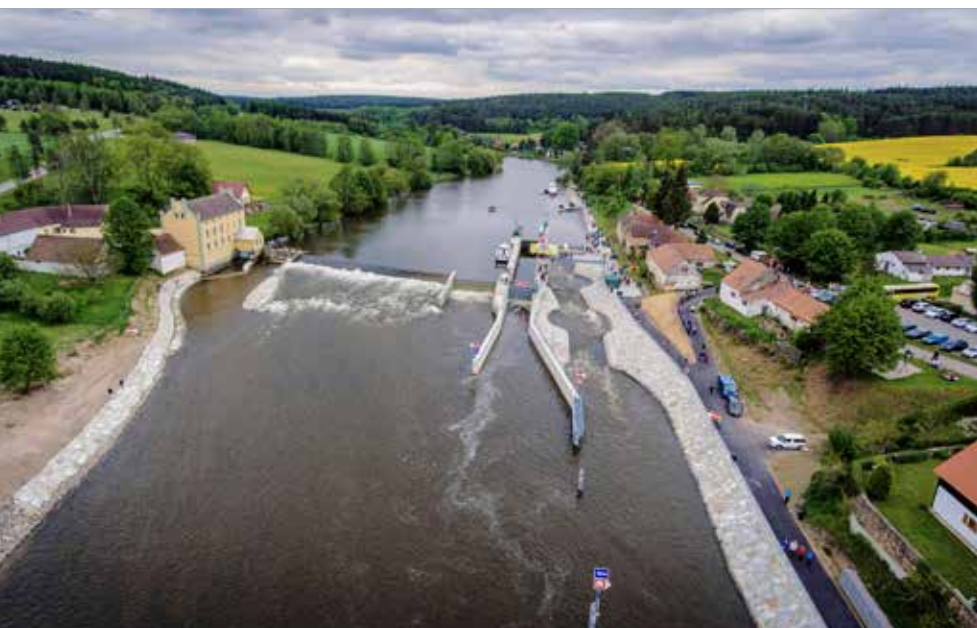
Celkový pohled na novou plavební komoru s přilehlým jezovým polem a levobřežním koridorem
