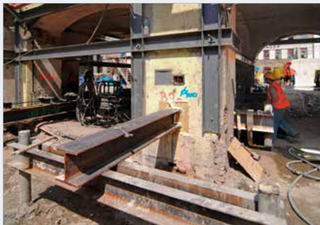
Dočasné podchytení ocelovou konstrukcí u jednoho z řady zděných pílířů
