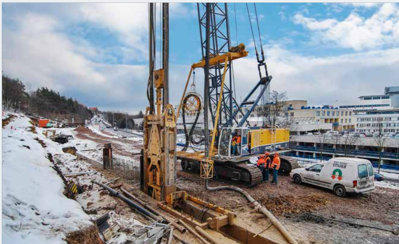
Těžba rýhy pro podzemní stěnu pomocí hydrofrézy v příkrém svahu nad ulicí Kukulovou
