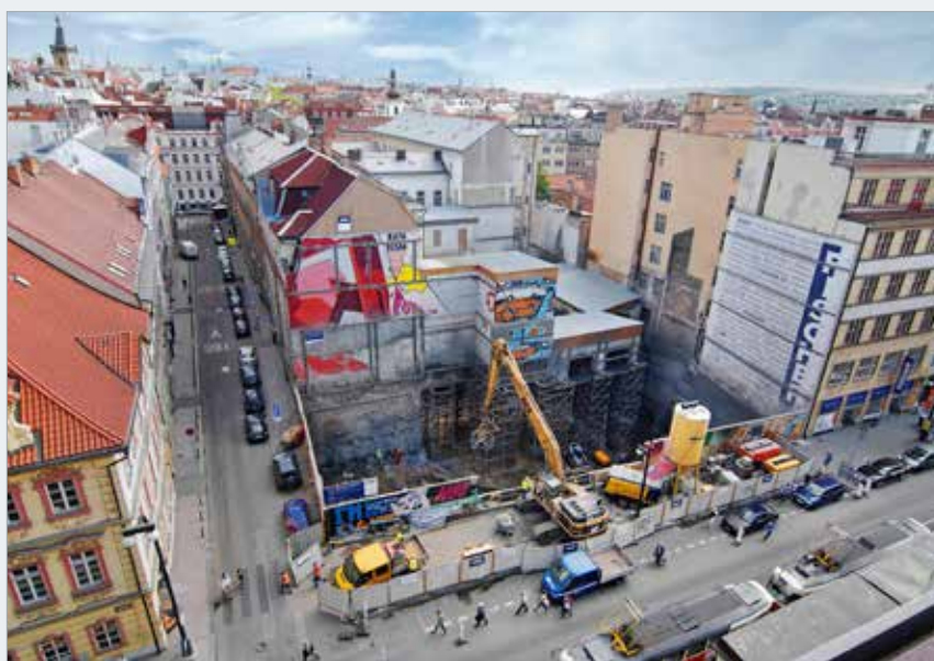
Celkový pohled na staveniště na rohu Národní třídy a Mikulandské ulice s podchycovanými dvorními křídly
