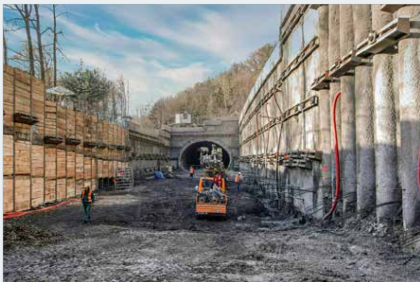
Hloubený tunel obrátových kolejí
