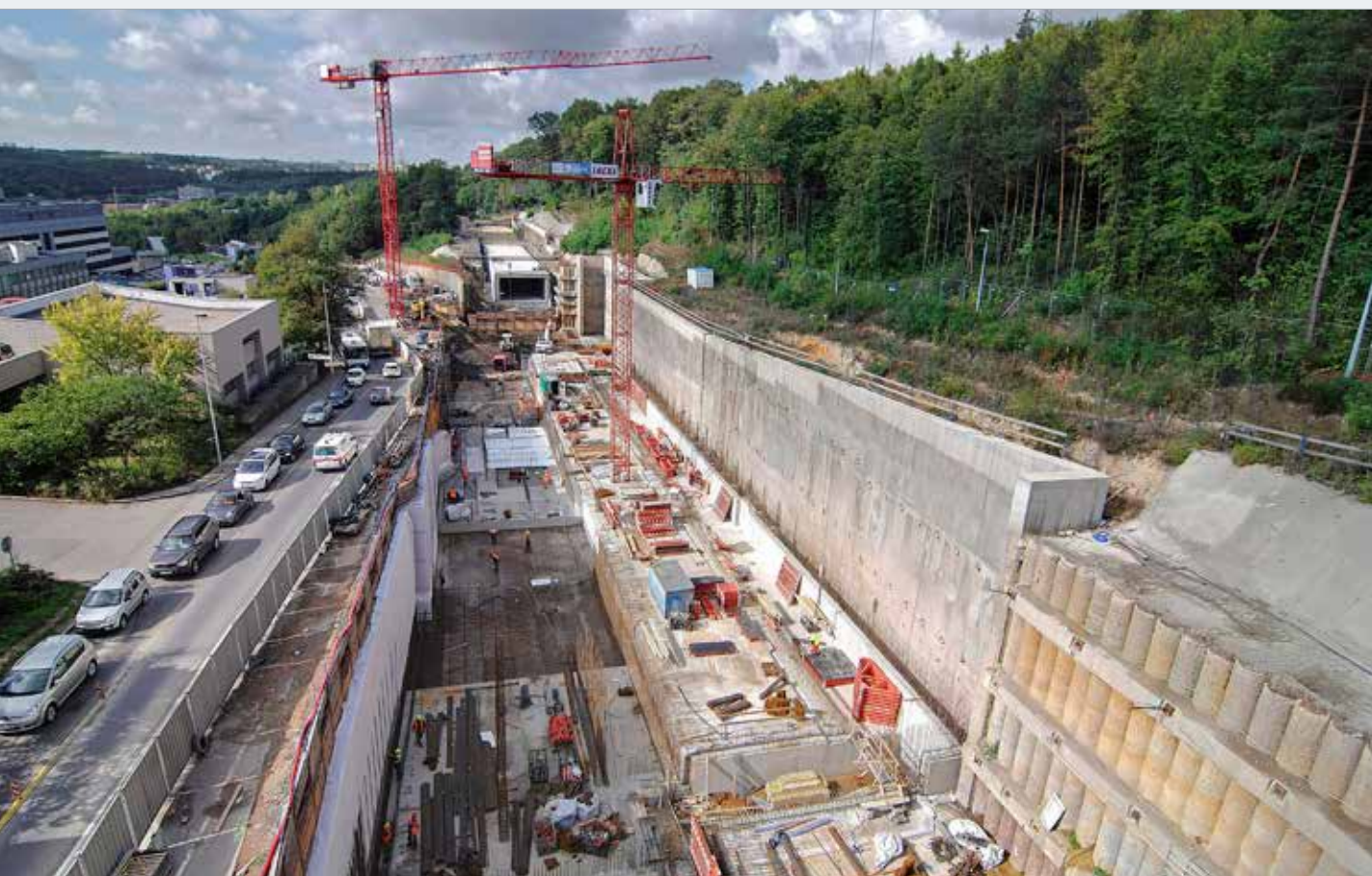
Stavební jáma stanice Motol během vestavby žlb. konstrukcí. Na stanici navazuje objekt obrátových kolejí s hlobeným a raženým úsekem.
