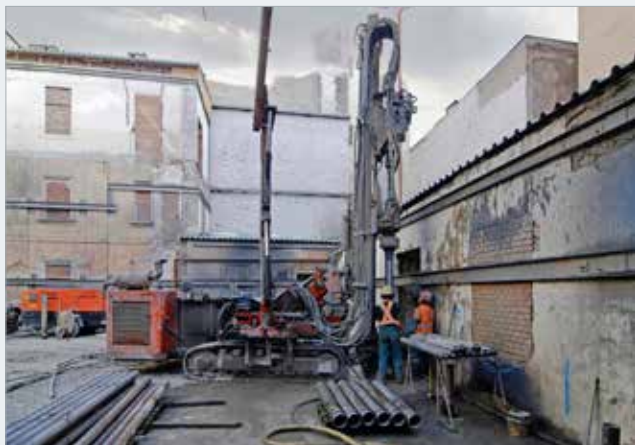
Zahájení stavby – provádění mikropilot pro vynesení památkově chráněných částí dvorní vestavby
