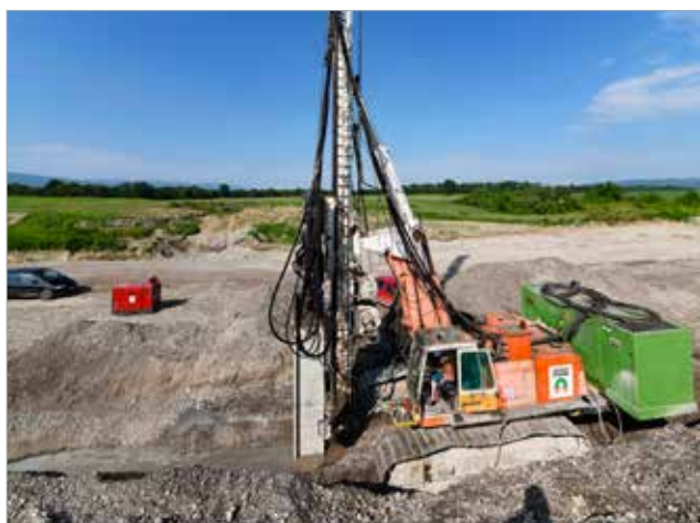
Těžba podzemní jílocementové stěny pro vytvoření těsnění spodní části hráze
