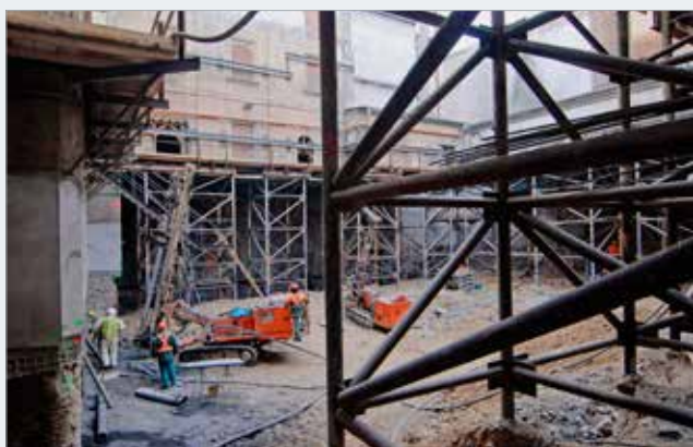
Provádění mikropilot pro pažení ve zvětralých vrstvách skalního podloží pod patou T1
