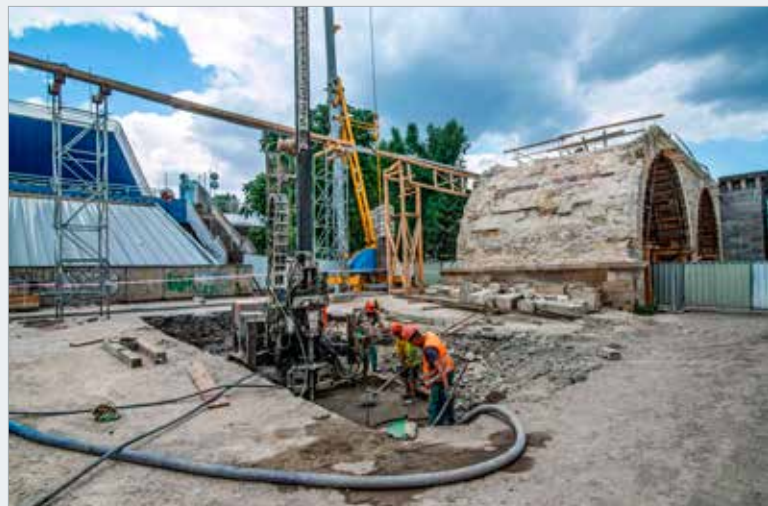
Provádění sloupů tryskové injektáže pro založení nově budovaných mostních pilířů a oblouků na ostrově Štvanice
