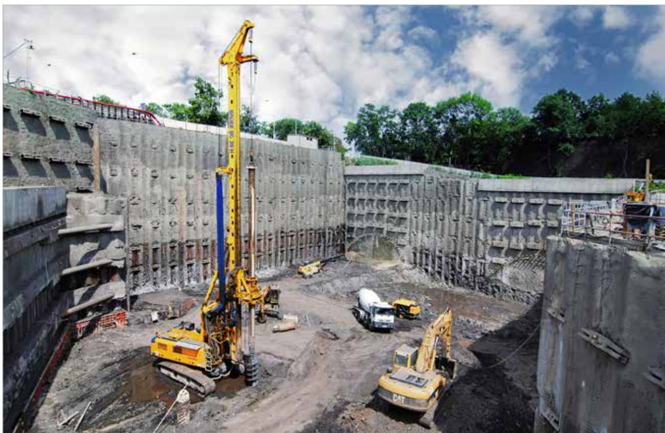
Pohled do částečně vytěžené stavební jámy směrem na severní a východní stěnu pažení
