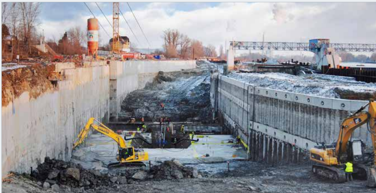
Betonáž základové desky strojovny MVE v nejhlubším místě stavební jámy, vlevo podzemní stěna, vpravo převrtávaná pilotová stěna
