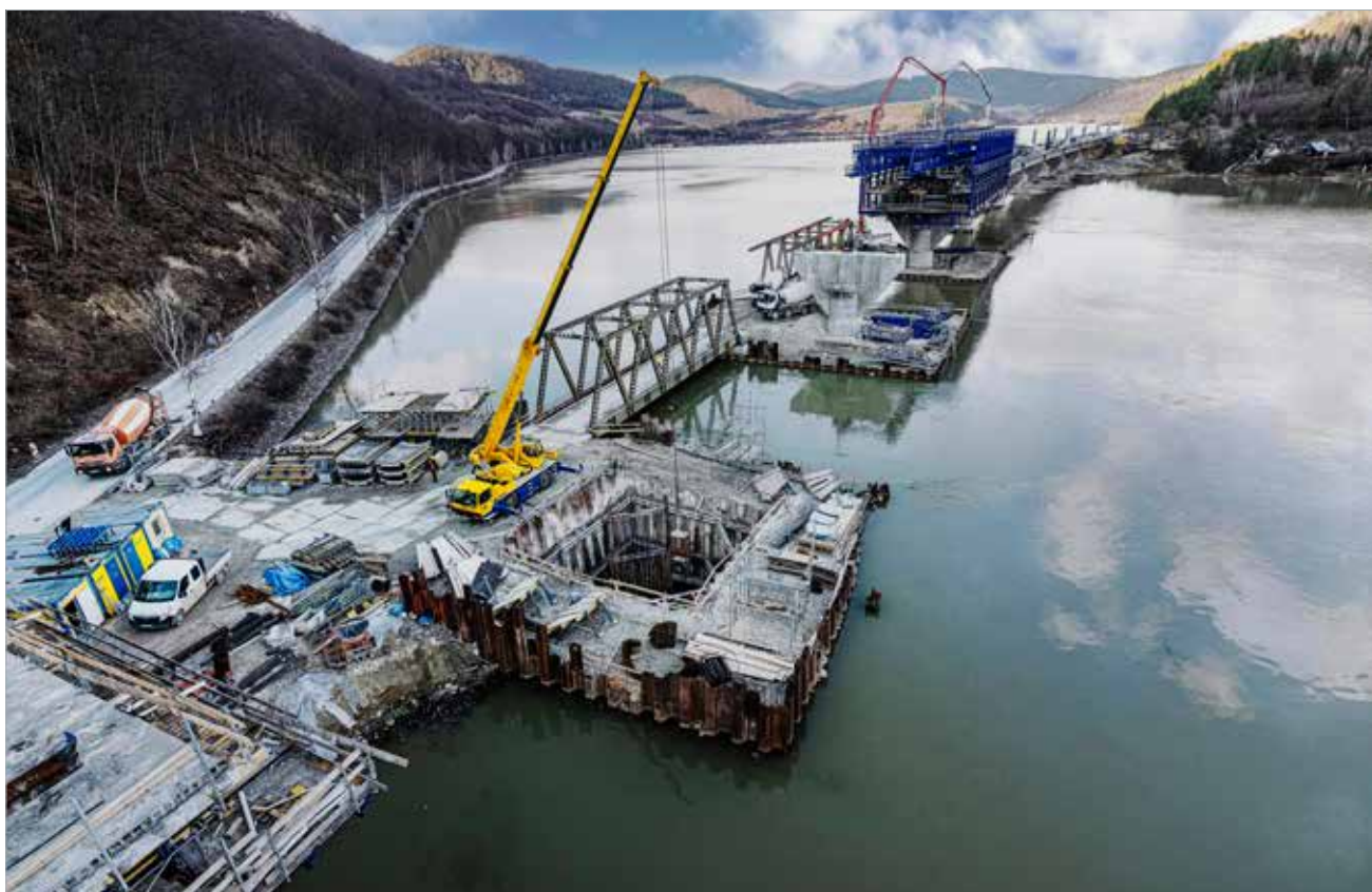
Armování dřívku pilíře P3 na pilotových základech pod ochranou dvojité štětové jímky, dále pak již dokončené pilíře P4 a P5
