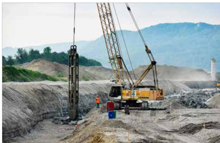
Realizace tenké těsnicí podzemní stěny
