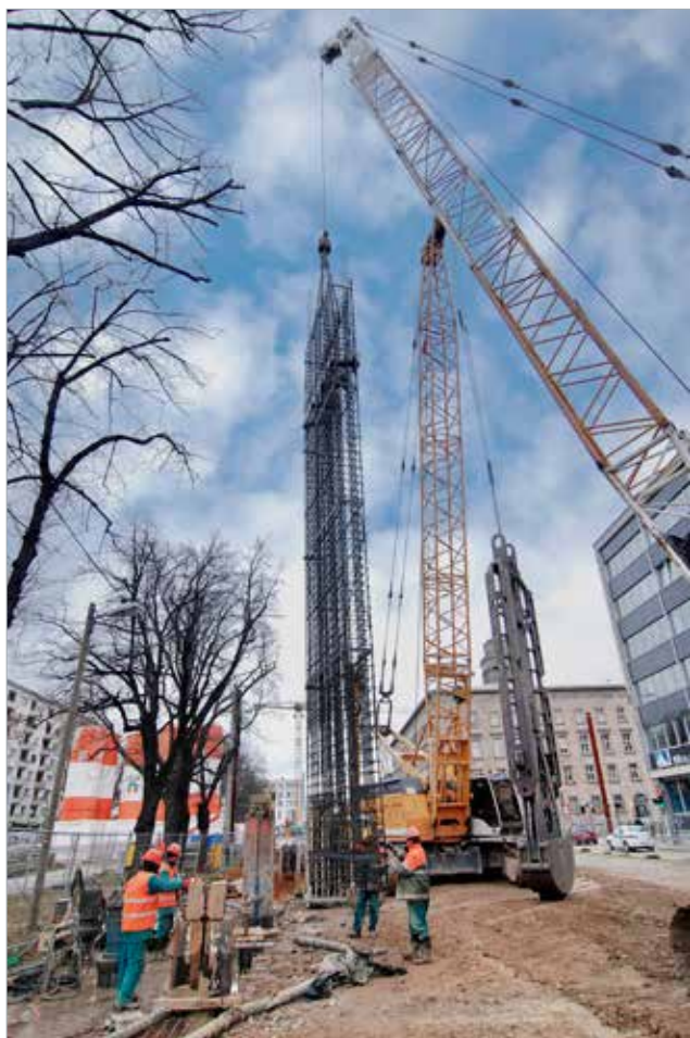
Osazování armokoše s kotevními průchodkami, Ettlinger Strasse
