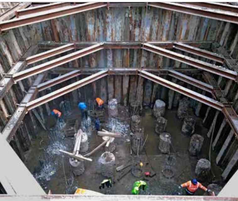
Jímka pro pilíř P5 rozepřená ve třech úrovních rozpěrnými rámy, probíhá těžba na základovou spáru a úprava výška 30 ks pilot
