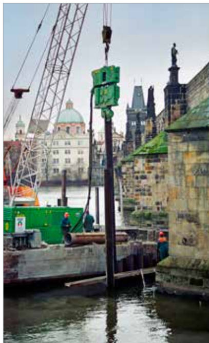
Vibrování štětovnic Larssen III n bezresonančním vibrátorem
