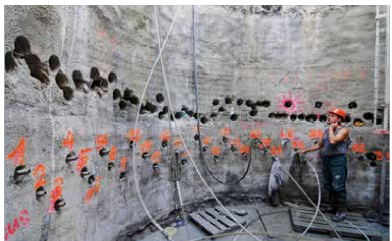
Pohled na injekční vrty pro kompenzační injecktáž s osazenými manžetovými trubkami a na výše položené návrtné body pro subhorizontální clonu z TI
