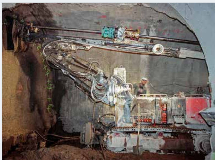
Provádění sanační obálky ze sloupů tryskové injektáže na hlavní trase kolektoru
