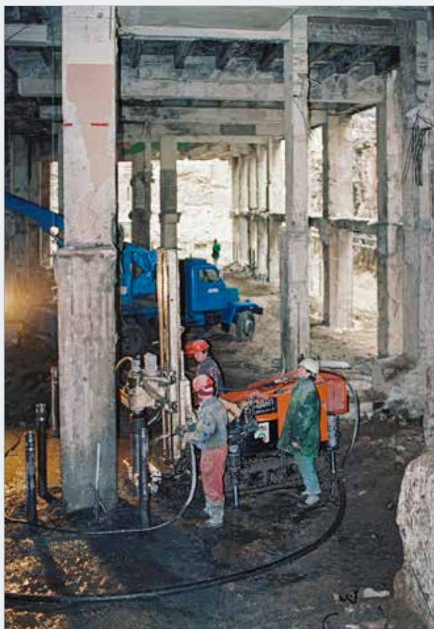
Provádění mikropilot pro vynesení sloupů původního skeletu budovy „A“
