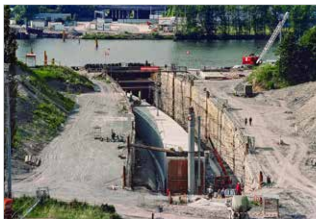
Tubus metra v suchém doku před zatažením do rýhy ve dně řeky
