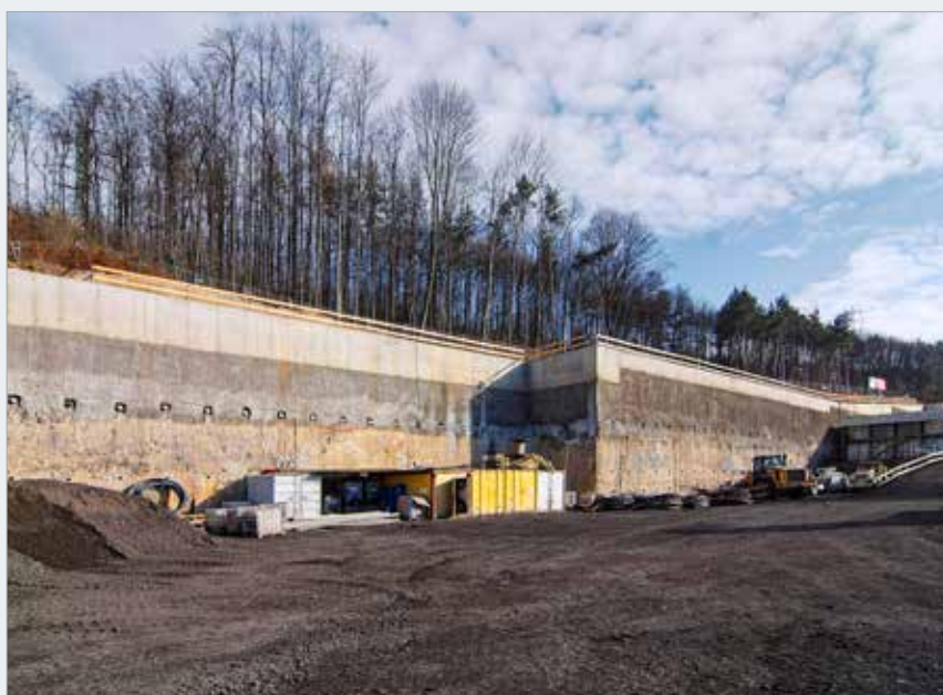
Trvale kotvená podzemní stěna
