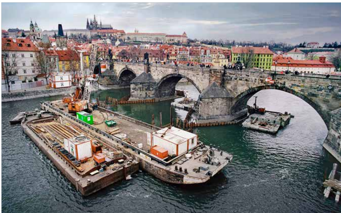
Práce na ochranných obálkách kolem pílířů č. 8 a 9
