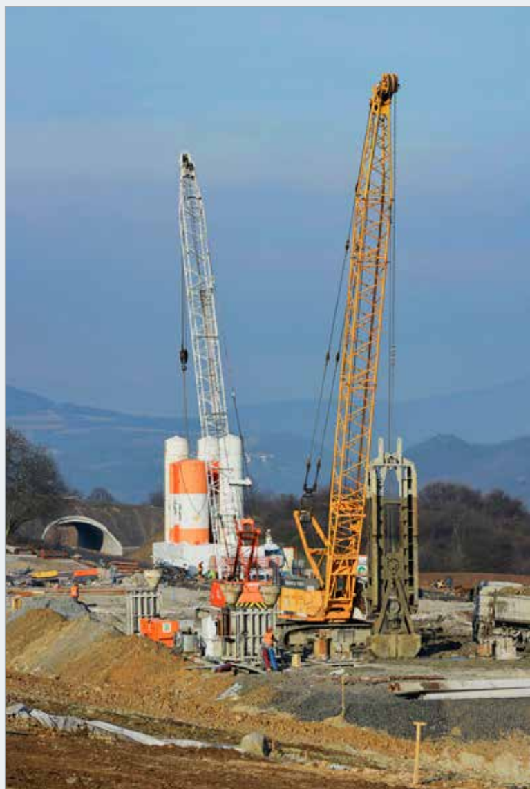
Těžba podzemních stěn jednoho ze 13 statických prvků
