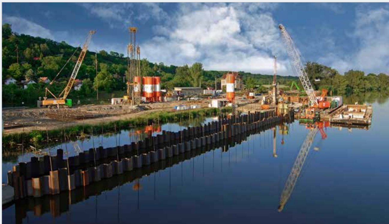
Současné provádění podzemních a štětových stěn
