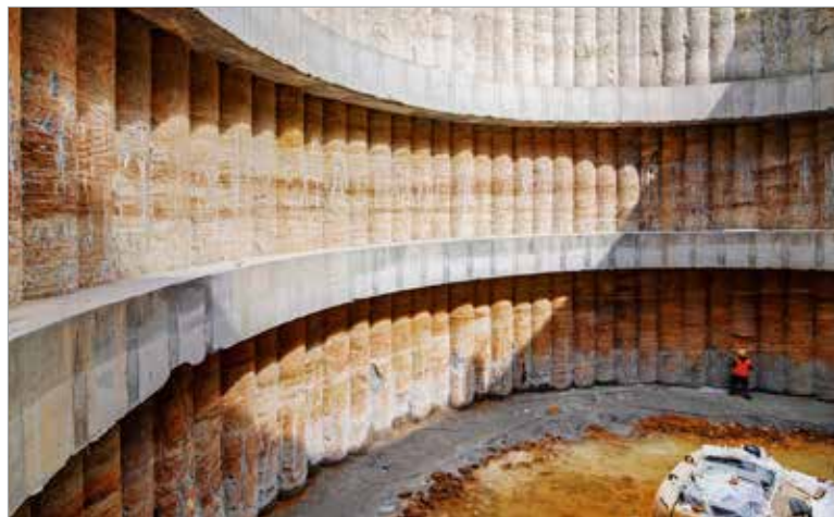
Odtěžená stěna montážní šachty na úrovni převázek T2 a T3
