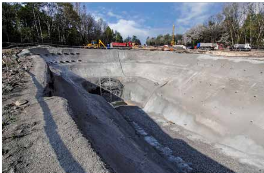
Zajištěná stavební jáma sjezdové rampy pro přístupovou štolu
