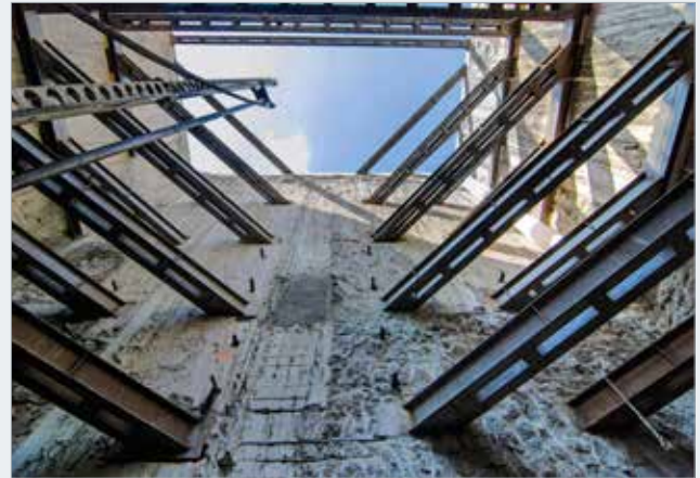
Rozpěry na severní straně stavební jámy nad tunelem I
