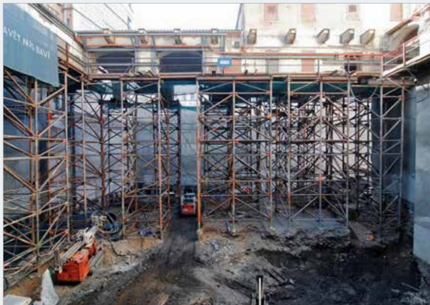
Vynášené dvorní křídlo během těžby na základovou spáru a provádění kotvení obvodu stavební jámy
