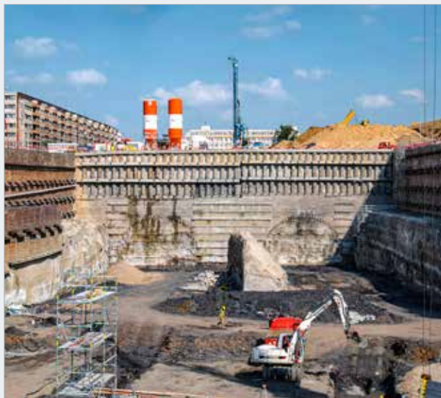
Portálová stěna zajištěná kotvenou pilotovou stěnou v kombinaci s kotvenými mikropilotami a stříkaným betonem
