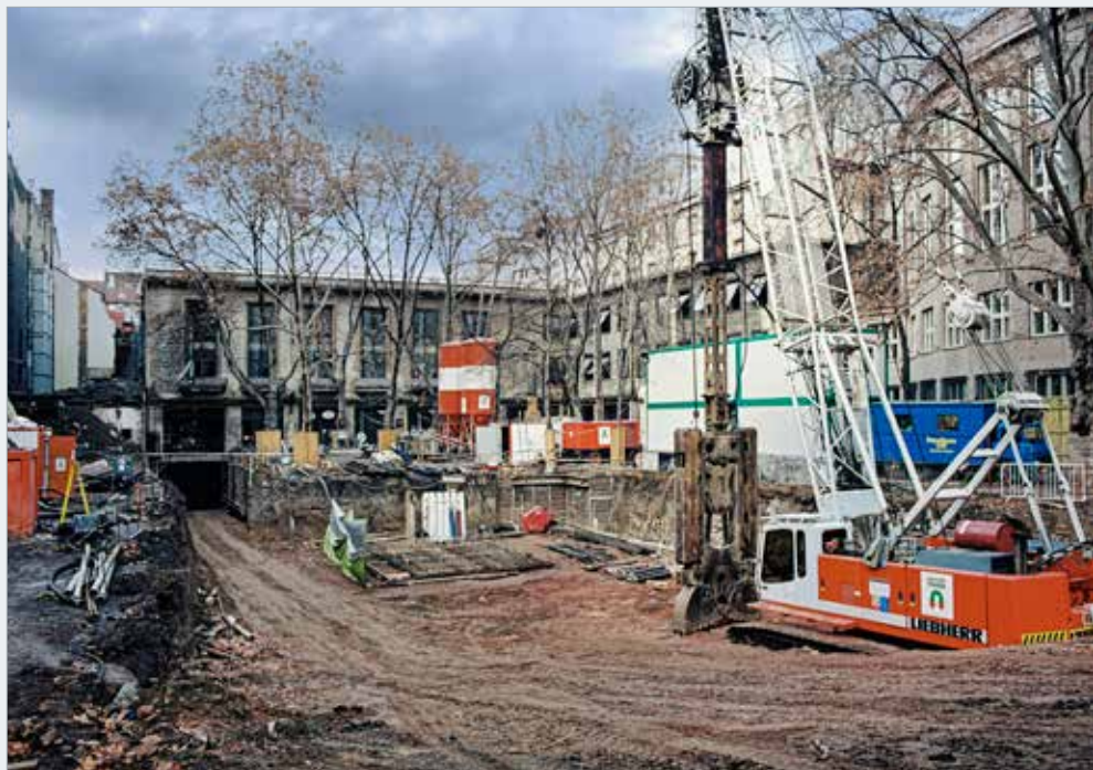
Realizace konstrukčních podzemních stěn pro nové objekty dvorní vestavby B, C, a E
