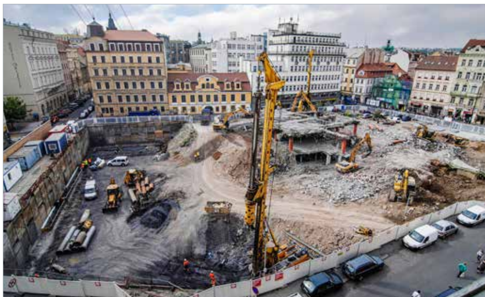
Stavební jáma zajištěná do úrovně předvýkopu, realizace převrtávané pilotové stěny a bourání starých konstrukcí metra původní stanice Národní třída
