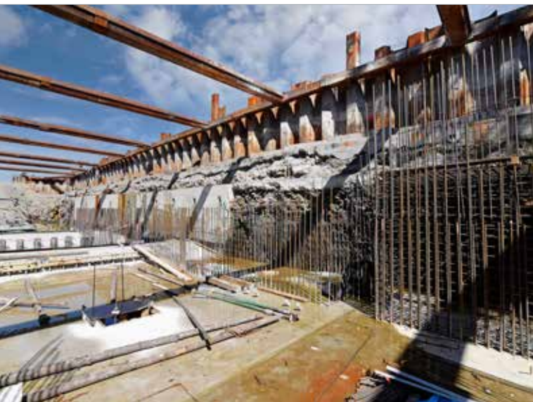
Vestavba betonových konstrukcí do zajištěné stavební jámy
