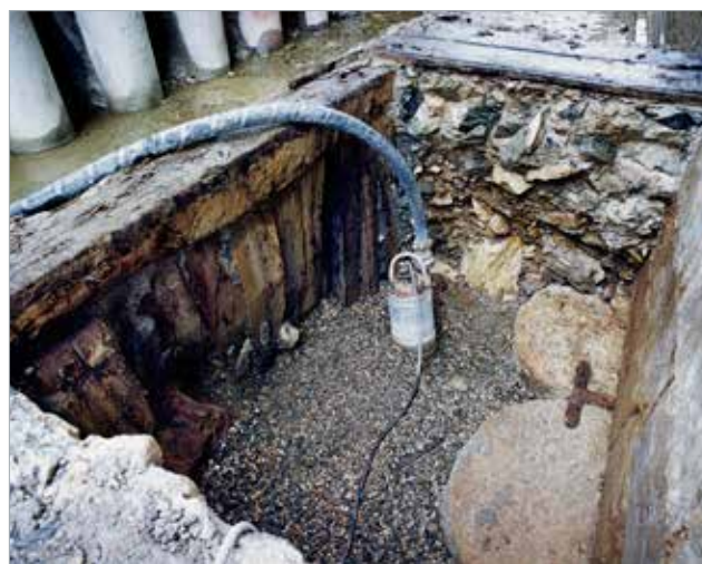
Kopaná archeologická sonda v zapažené jímce pro průzkum základů pilíře č. 9 s obnaženými základovými kameny
