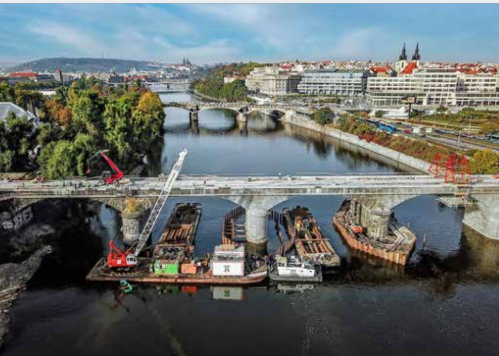
Probíhající sanační práce na pilíři P3 a rozebírání jímky na již sanovaném pilíři P2
