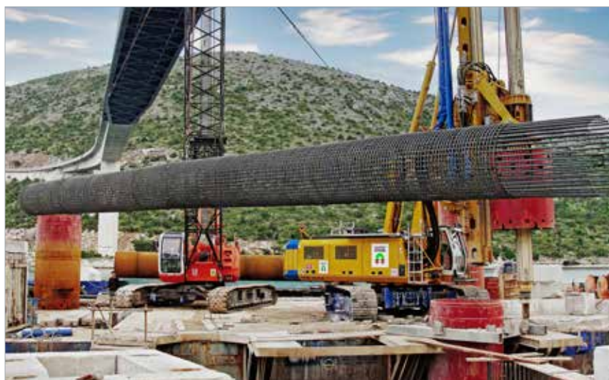
Přemisťování armokoše k ústí vrtu
