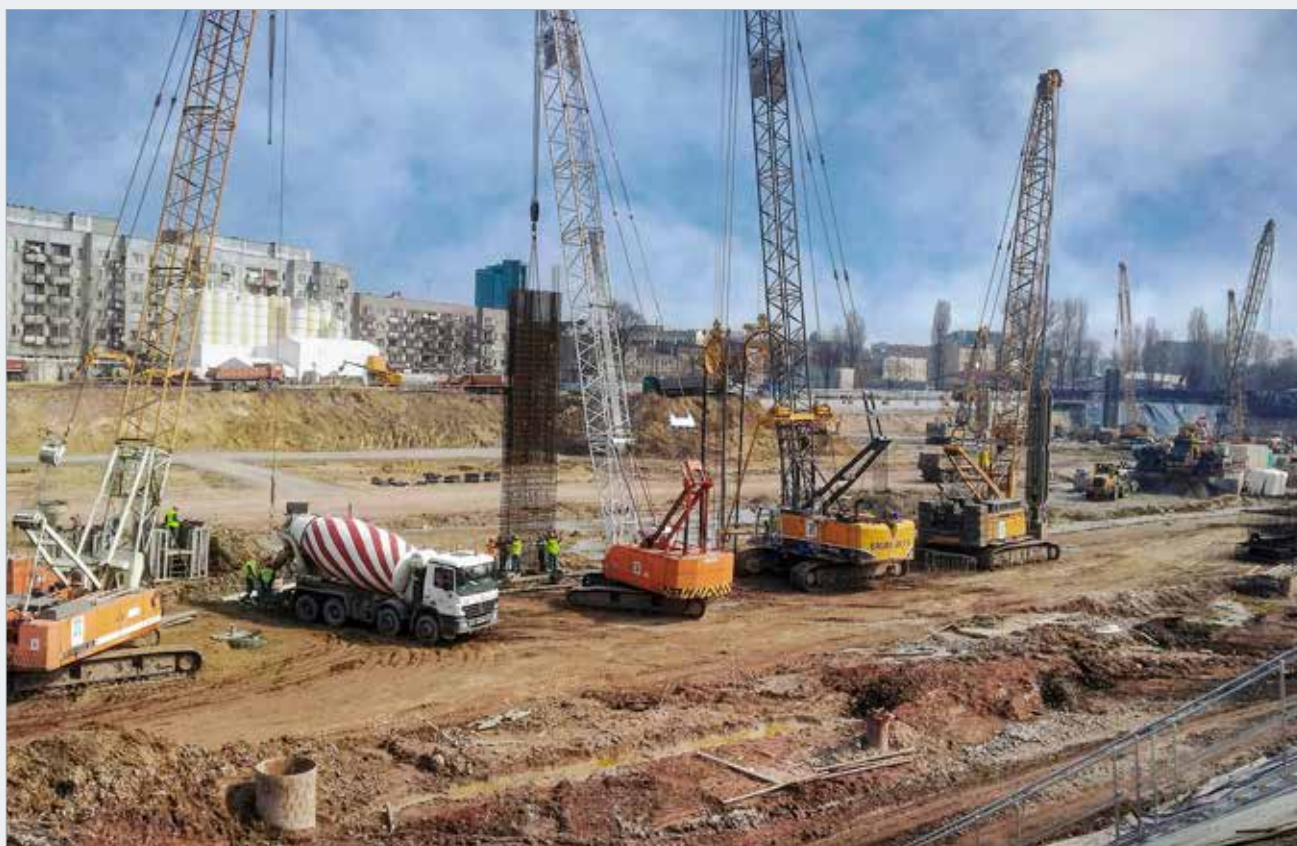
Provádění baretů v objektu stanice hloubky až 53 metrů
