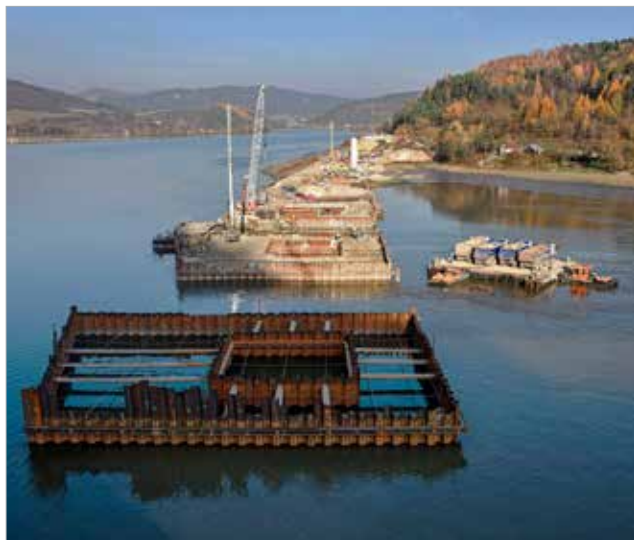
Pohled na dvojitou rozepřenou jímku pro pilíř P4, probíhají zásypy vnějšího obvodu jímky
