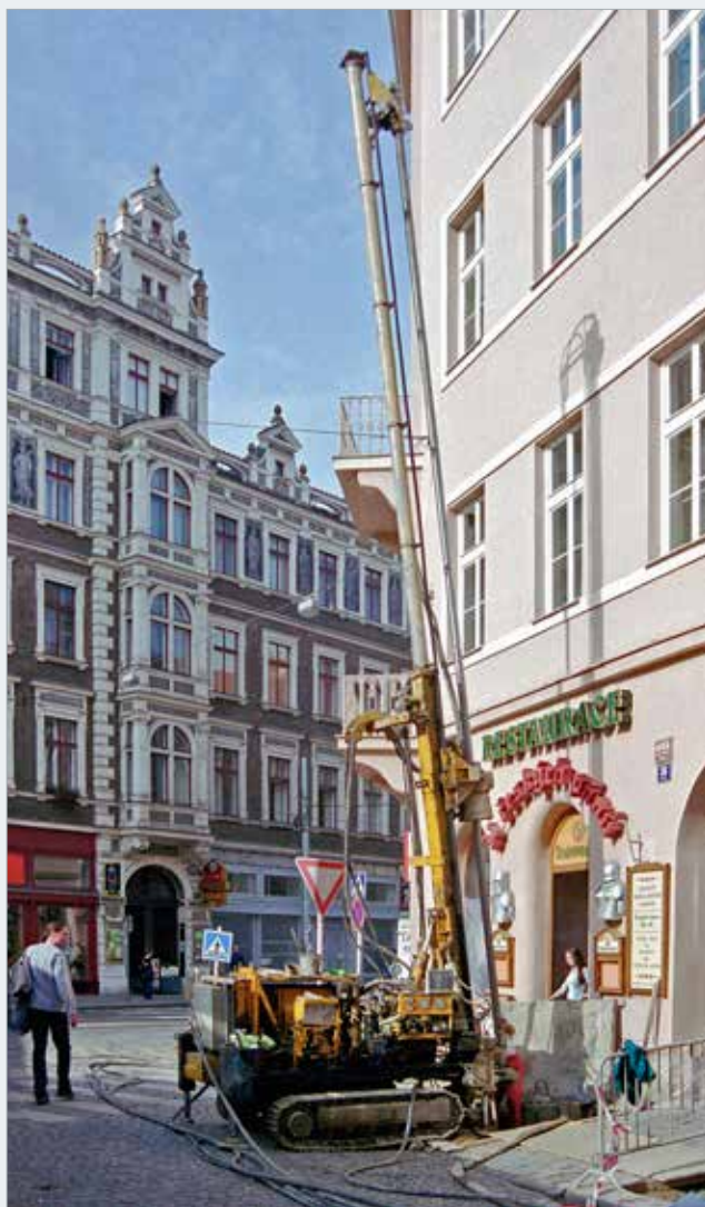
Podchycení objektů tryskovou injektáží na rohu ulic Vodňácká a Školská
