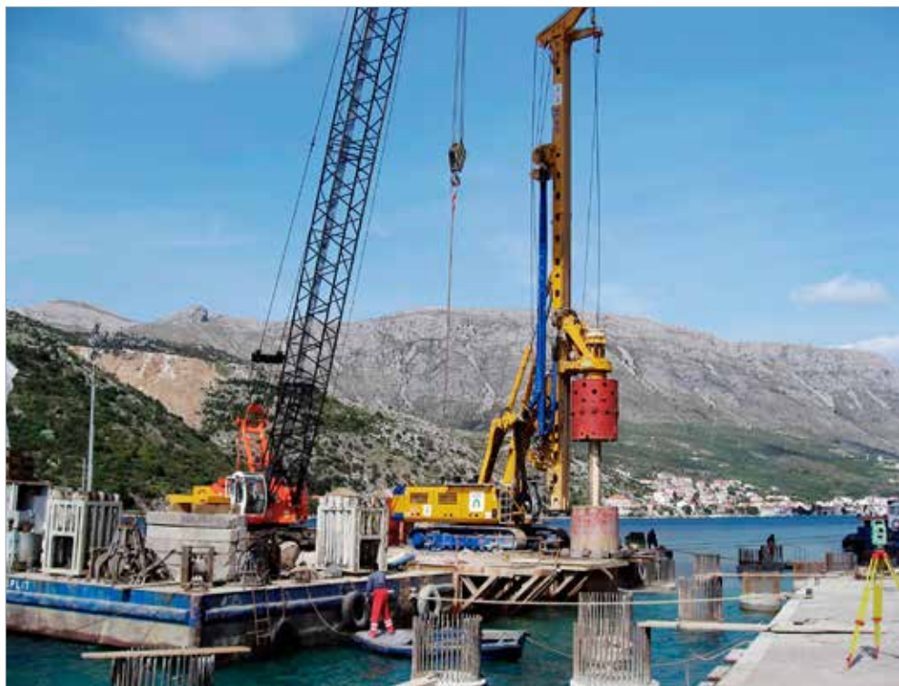
Vrtání skalním hrcem 1800 mm v pažnici 2000 mm
