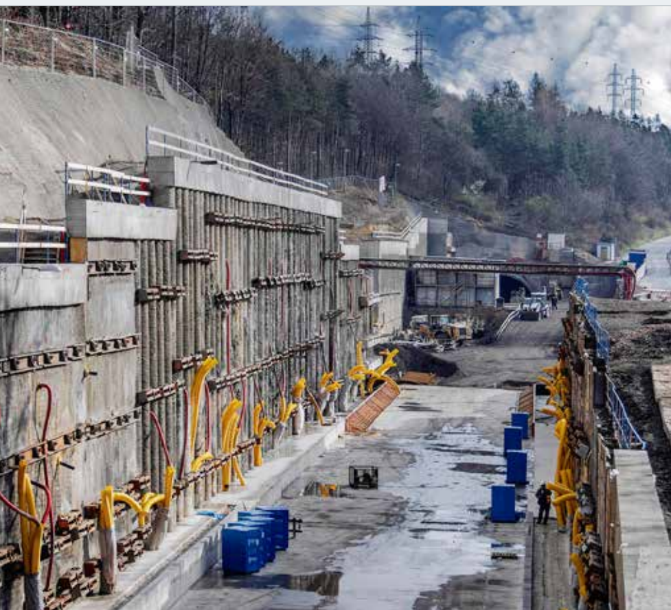
Zajištění stavební jámy hloubené části obrátových kolejí, pohled na severní kotvenou pilotovou a mikropilotovou stěnu
