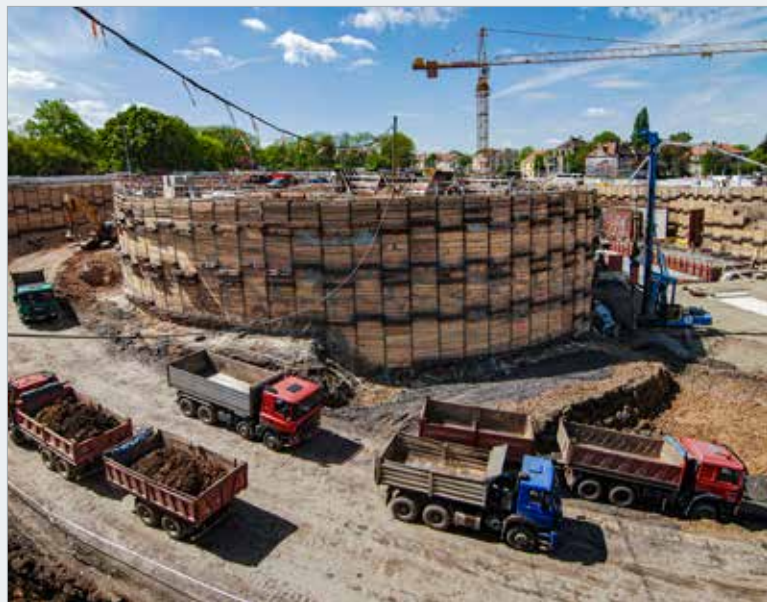
Záporové pažení vjezdové a výjezdové rampy
