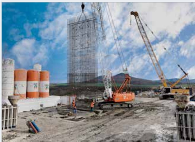
Spouštění prvního dílu armokoše do vytěžené rýhy pažené polymerovou suspenzí
