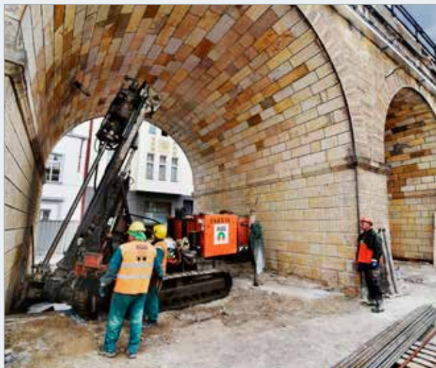
Realizace sloupů tryskové injektáže v podzákladí pilířů viaduktu
