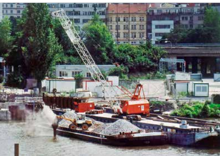
Obsypávání zataženého tubusu kamenivem pomocí násypky do hloubky 10–12 m
