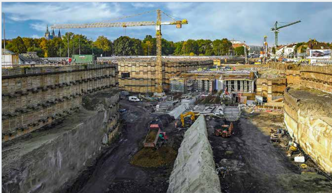
Pohled na zapaženou jámu k západu, kde probíhá výstavba žlb. tubusů
