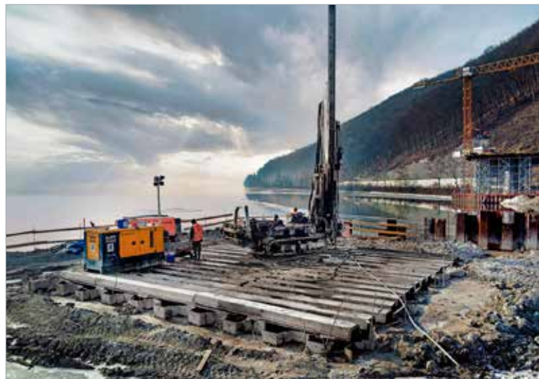
Provádění tryskové injektáže z nosníků IPE 700 na vnitřní jímce mezi pilotami, jímka pro pilíř P5
