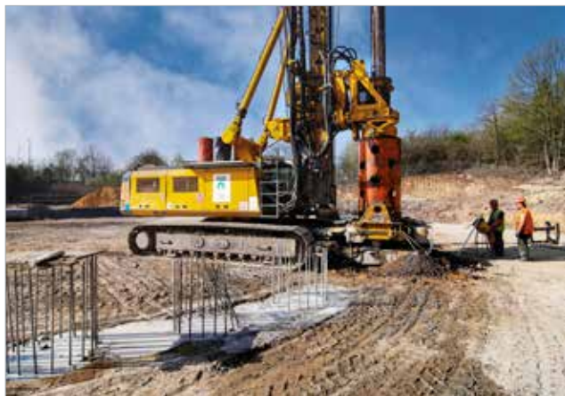
Vrtná souprava Bauer BG 25 s dopažovacím zařízením při provádění převrtávaných pilot
