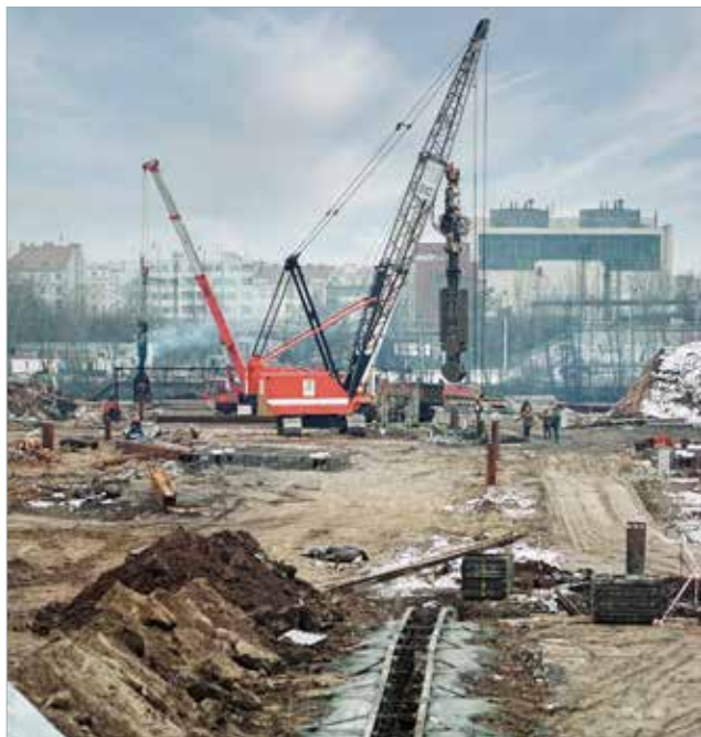
Realizace podzemních stěn na trojském břehu
