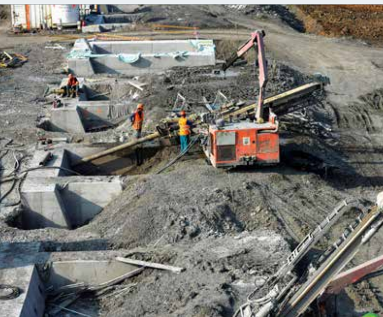
Vrtání pramencových kotev přes průchodky v monolitických věncích
