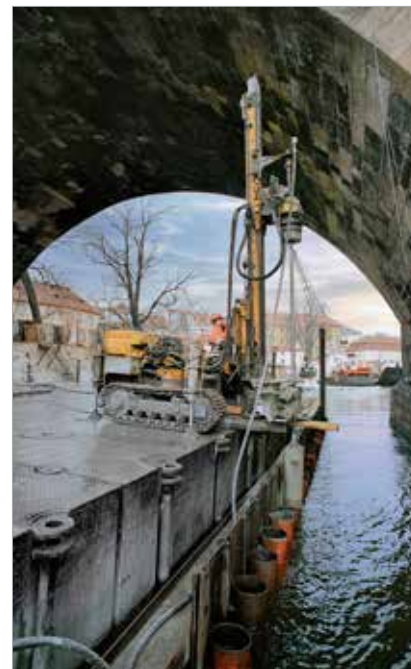
Provádění sloupů tryskové injektáže přes navažené průchodky na štětovnicích ARBED
