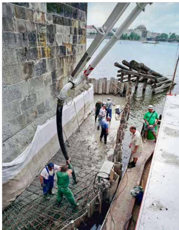
Betonáž žlb. věnce, který nově vybudovanou ochrannou obálku uzavřel shora
