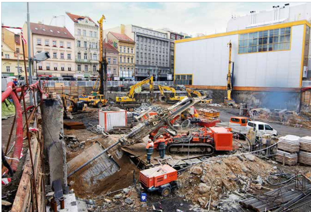
Zajišťování eskalátorového tunelu mikropilotovým deštíkem
