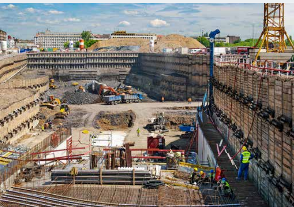
Pohled do zapažené stavební jámy od západu směrem k portálové stěně, v popředí výstavba žlb. konstrukcí tubusů
