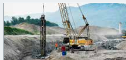
Těsnění podloží pravobřežní hráze při výstavbě přehradní nádrže pro vodní elektrárnu (HE) Brežice ve Slovinsku (2015–2016) 62
