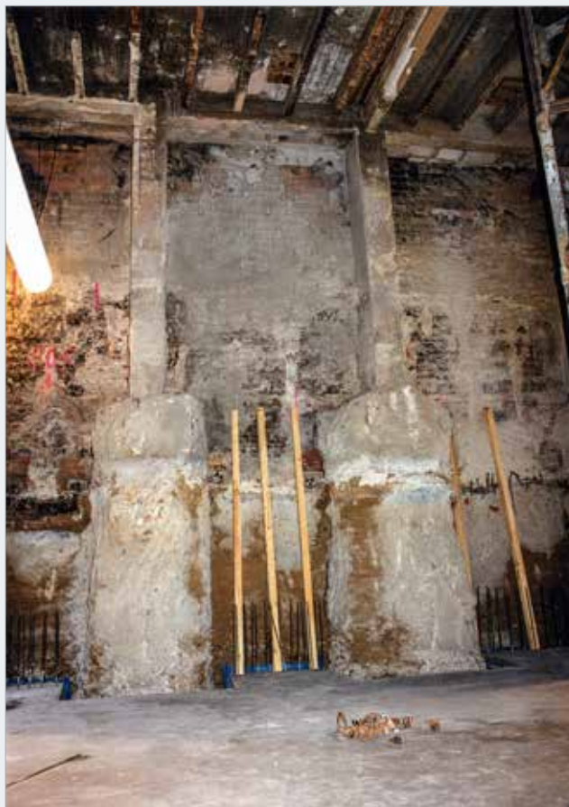
Sloupy tryskové injektáže podchycují obvodové sloupy skeletu u sousední ČNB
