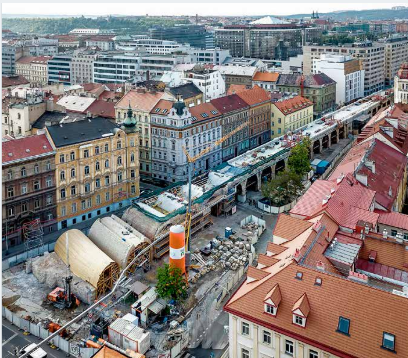
Negrelliho viadukt během rekonstrukce, mikropilotové zakládání nové opěry mostu přes Křížkovu ulici
