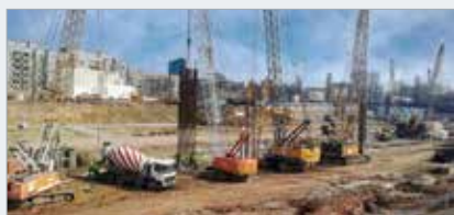
Zajištění stavební jámy objektu Quadria v centru Prahy (2012–2013) 36
