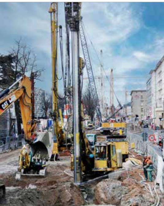
Těsnění dna stavební jámy hloubeného tunelu pomocí tryskové injektáže, Ettlinger Strasse
