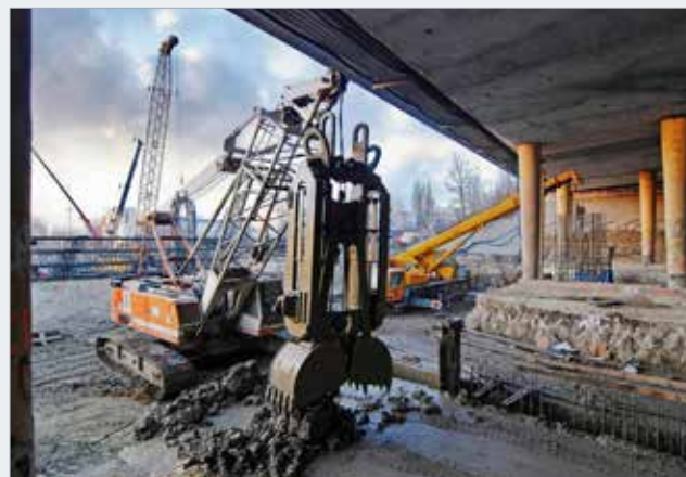
Nasazení bagru se zkráceným výložníkem pod viaduktem Kopciňského
