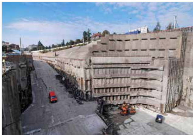
Sjízdňá rampa zajištěná ve své spodní části po obou stranách také kotvenými pilotovými stěnami a stříkaným betonem s výztužnou sítí
