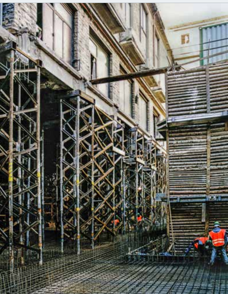
Zavětrované mikropilotové bárky vynášející dvorní objekt „A“
