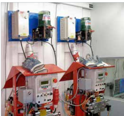
Injekční stanice Obermann, která flexibilně plnila požadavky na proměnná zadání injekčních parametrů
