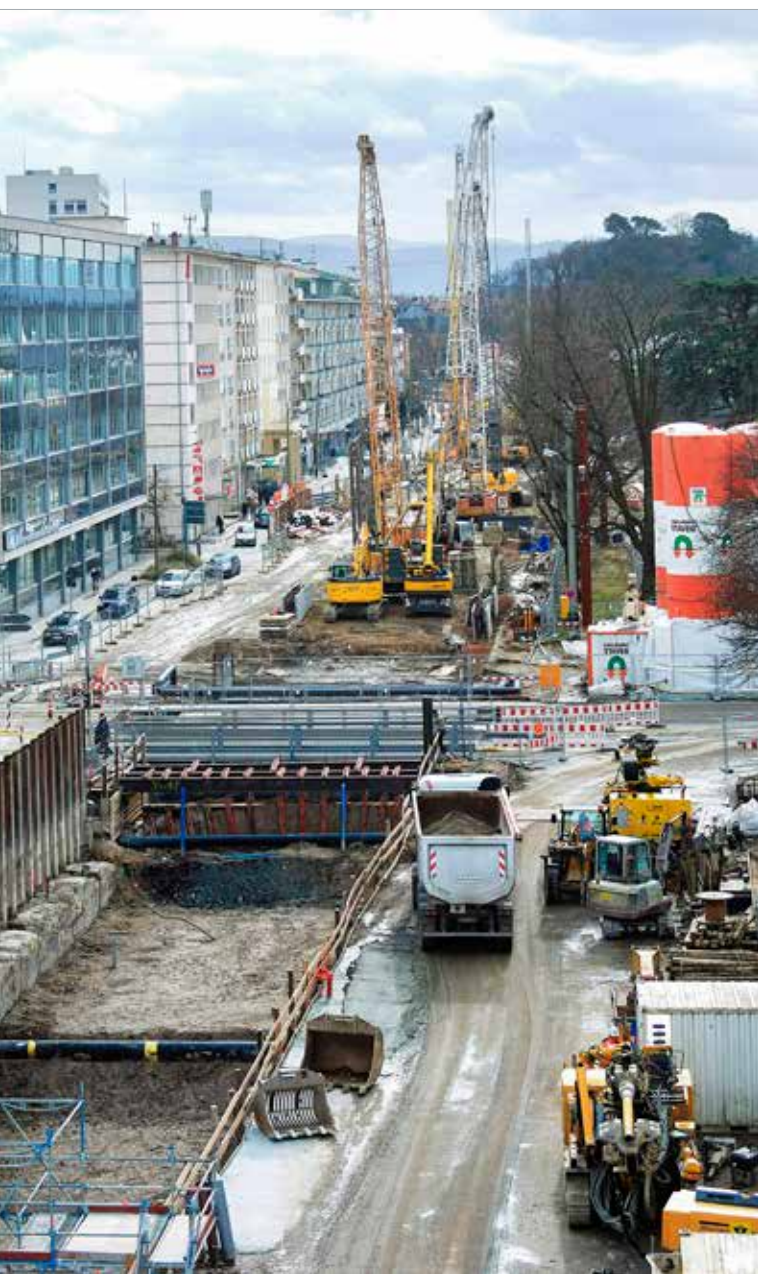
Pohled na Ettlenger Strasse během provádění podzemních stěn hloubeného tunelu
