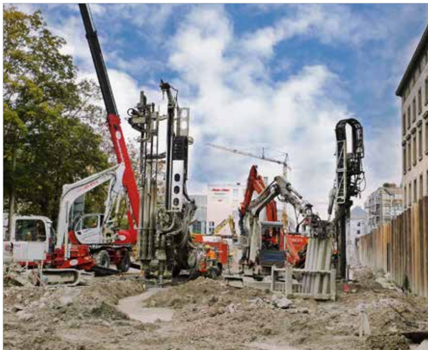
Provádění tahových GEWI tyčí na hloubeném úseku Ettlinger Strasse
