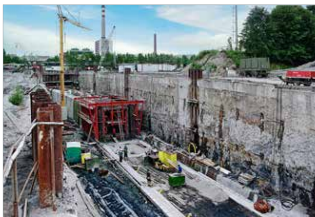
Budování tubusu metra pod ochranou podzemních stěn suchého doku
