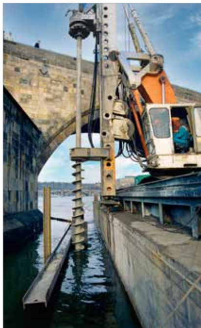
Předvrtávání otvorů průběžným šnekem pro následné vibrování štětovnic Larssen III n
