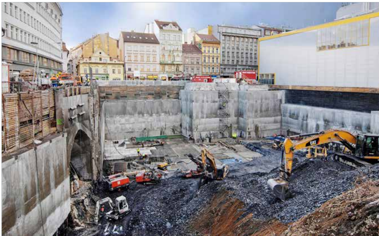
Pohled do hluboké stavební jámy zajištěné stěnou z převrtávaných pilot
