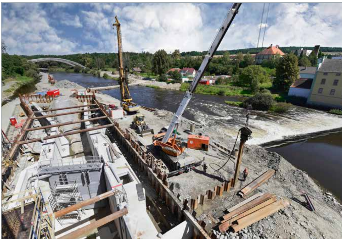
Beranění štětovic pro zajištění stavební jámy nového jezového pole, vlevo stavební jáma plavební komory s dokončovanými vnitřními konstrukcemi
