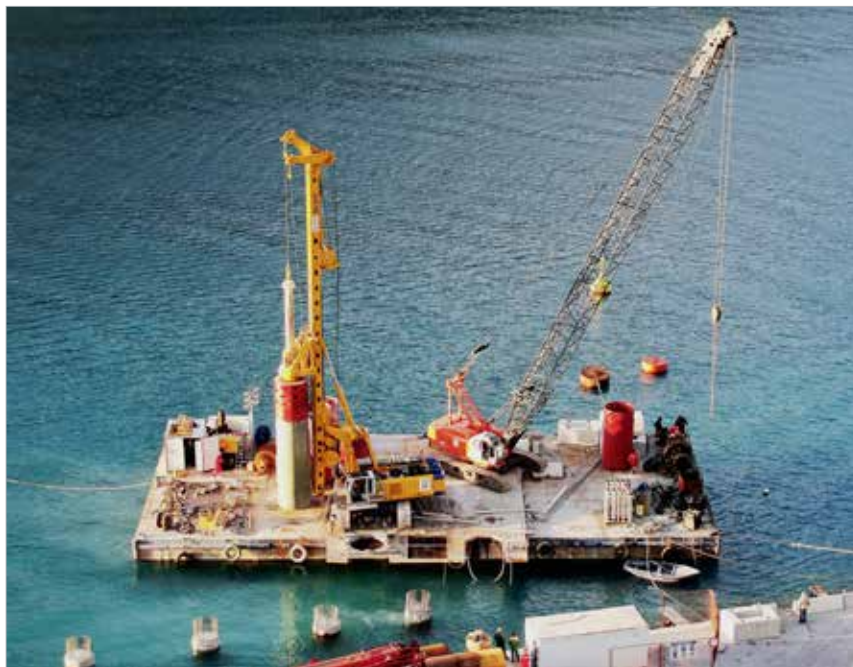
Ponton se strojní sestavou Bauer BG 36H a Kobelco EM700
