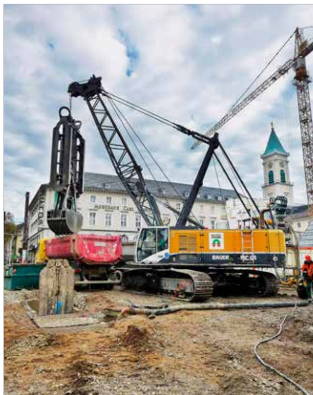
Těžba podzemních stěn, Ettlinger Strasse
