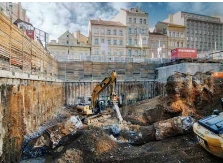
Bourací práce původních základových konstrukcí vestibulu metra
