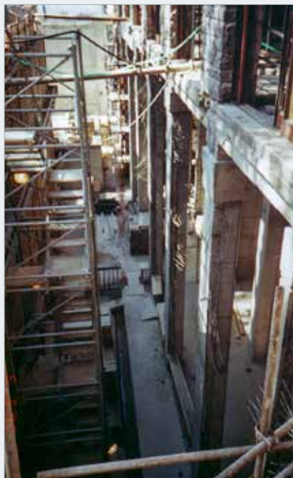
Nové žlb. sloupky s monolitickými hlavicemi po odstranění provizorních bárek z mikropilot
