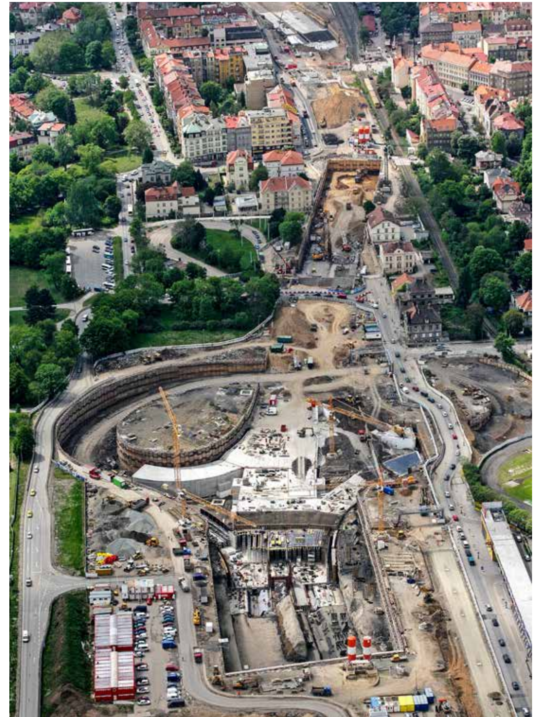
Tunel Blanka v Praze, stavební objekty na Letné
