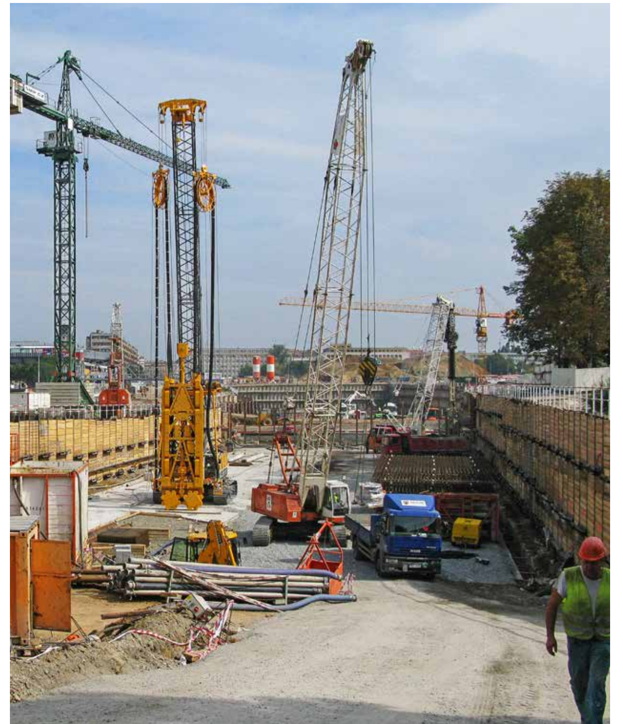
Tunel Blanka v Praze, zajištění stavebních jam v Troji a v ulici Milady Horákové
